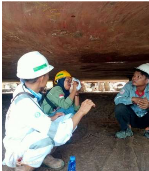
Gambar 2.24 UT Bottom KHB,Dredger
