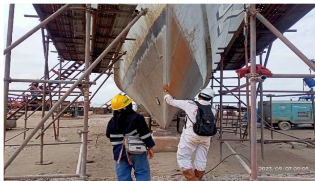
Gambar 2.53 Cek visual aft blasting Kapal KRI LEMADANG
