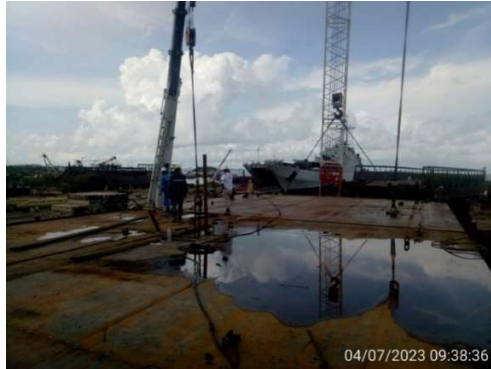
Gambar 2.2 Proses Pemasangan Kontruksi Main Deck Tongkang
