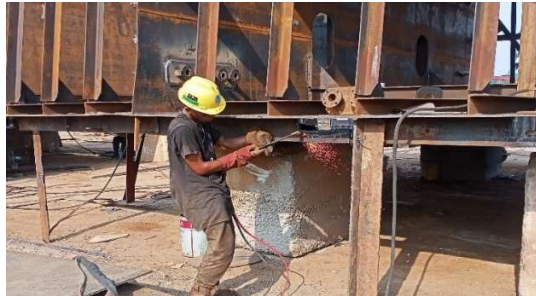
Gambar 2.55 Control pemasangan pipa kapal T.036 Louis Dolphin
