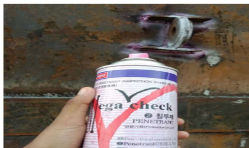
Gambar 2.10 kupingan blok side shell stbd bfr tongkang ( H.169 SORENTO BAY )
