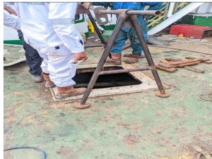
Gambar 3.1 18 penggantian bagian yang aus
