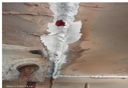
Gambar 2 15 proses penetrant Test pada tugboat tnt
