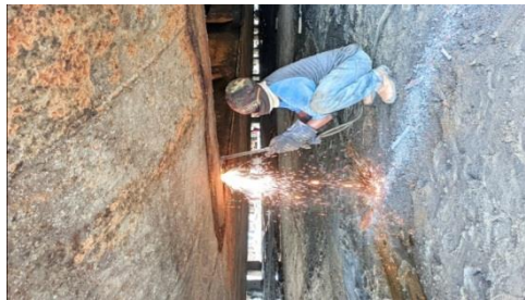
Gambar 2 16 dibawah ini adalah proses pengerjaan Fit up
