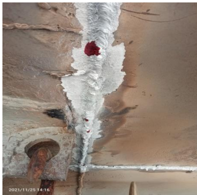
Gambar 2 4 proses penetrant Test pada tugboat tnt
