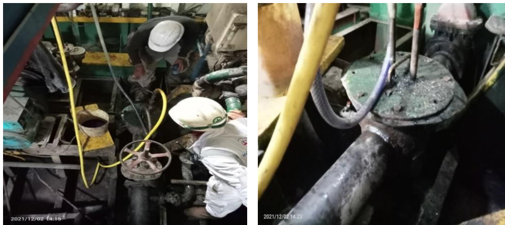
Gambar 2 21 proses Air Test pada pipa searches
