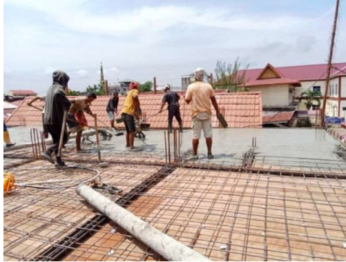
Gambar III.58 Pengecoran dengan Concrete Pump (Sumber: Dokumentasi Lapangan 2023)
