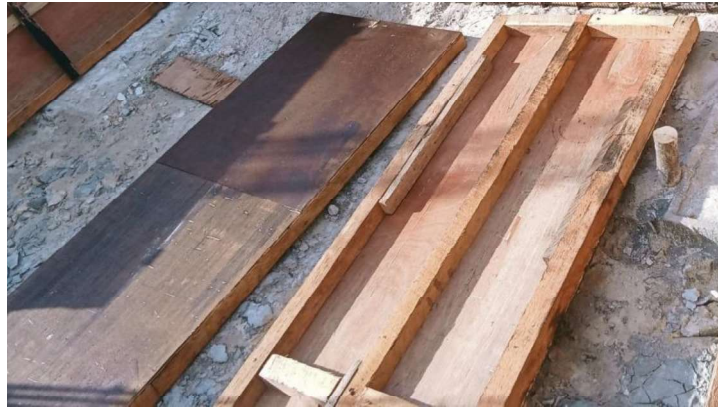
Gambar III.6 Bahan Bekisting Sloof (Sumber: Dokumentasi Lapangan 2023)
