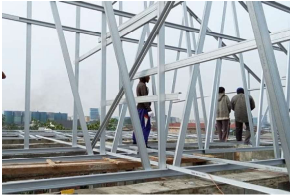
Gambar III.104 Pekerjaan Pemasangan Kuda-Kuda (Sumber: Dokumentasi Lapangan 2023)
