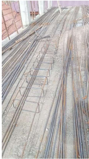
Gambar III.39 Tulangan Balok (Sumber: Dokumentasi Lapangan 2023)
