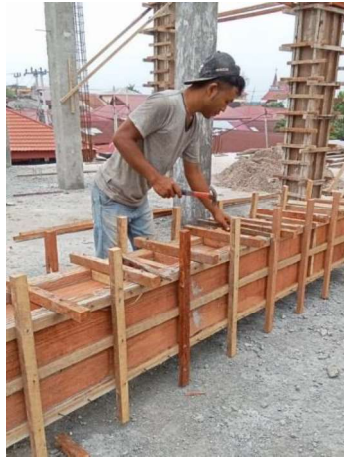
Gambar III.75 Pekerjaan Pembuatann Bekisting Kolom (Sumber: Dokumentasi Lapangan 2023)
