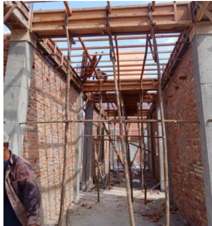
Gambar III.35 Pekerjaan Pemasangan Perancah Kayu Dolken (Sumber: Dokumentasi Lapangan 2023)
