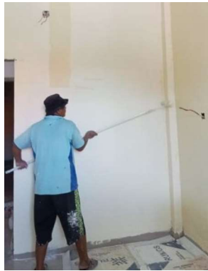
Gambar III.122 Pekerjaan Pengecatan Dinding (Sumber: Dokumentasi Lapangan 2023)
