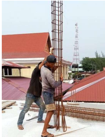
Gambar III.73 Penyambungan Tulangan Kolom (Sumber: Dokumentasi Lapangan 2023)
