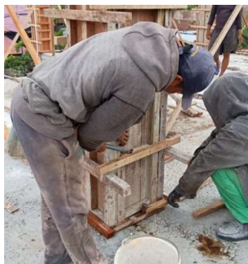
Gambar III.16 Pekerjaan Penentuan As Kolom (Sumber: Dokumentasi Lapangan 2023)
