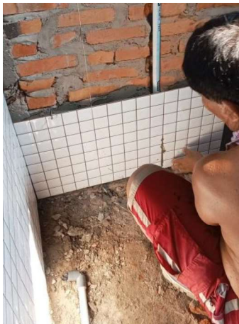
Gambar III.111 Pemasangan Dinding Keramik WC/Kamar Mandi (Sumber: Dokumentasi Lapangan 2023)
