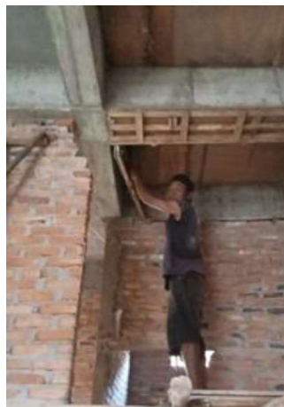
Gambar III.47 Pekerjaan Pembongkaran Bekisting Balok (Sumber: Dokumentasi Lapangan 2023)
