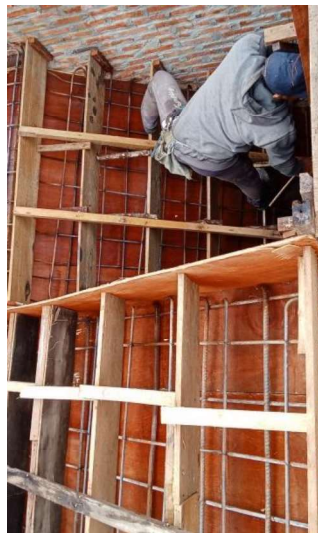
Gambar III.65 Pembesian Untuk Tangga (Sumber: Dokumentasi Lapangan 2023)
