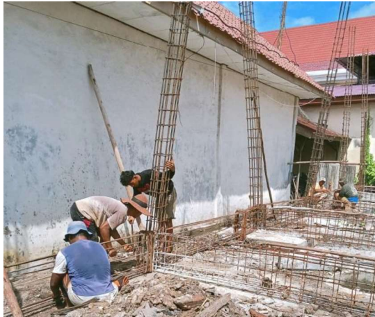
Gambar III.4 Pekerjaan Memasukkan Tulangan Sengkang (Sumber: Dokumentasi Lapangan 2023)
