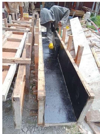
Gambar III.76 Pengecatan Bekisting Kolom (Sumber: Dokumentasi Lapangan 2023)
