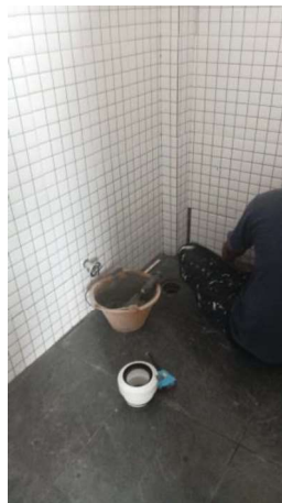
Gambar III.113 Grouting Keramik Kamar Mandi/WC (Sumber: Dokumentasi Lapangan 2023)
