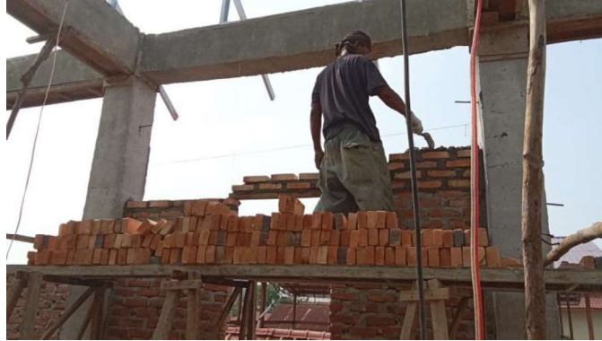
Gambar III.88 Meluruskan Batu Bata (Sumber: Dokumentasi Lapangan 2023)
