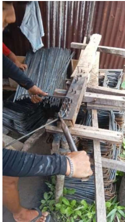
Gambar III.93 Pembengkokkan Tulangan Sengkang (Sumber: Dokumentasi Lapangan 2023)
