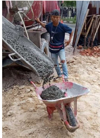
Gambar III.79 Pengambilan Sampel Beton (Sumber: Dokumentasi Lapangan 20233)
