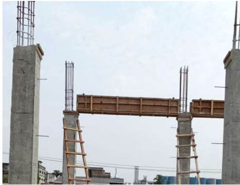
Gambar III.89 Pemasangan Penyangga untuk Ring Balok (Sumber: Dokumentasi Lapangan 2023)
