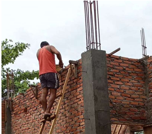
Gambar III.37 Pekerjaan pemasangan kayu skor (Sumber: Dokumentasi Lapangan 2023)
