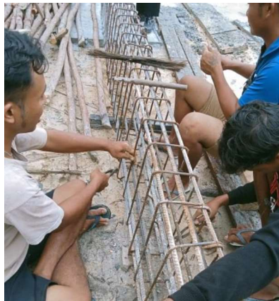
Gambar III.5 Pekerjaan Perakitan tulangan (Sumber: Dokumentasi Lapangan 2023)
