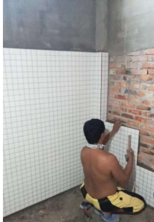
Gambar III.112 Merapikan Posisi Keramik Dinding Wc/Kamar Mandi (Sumber: Dokumentasi Lapangan 2023)
