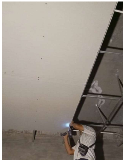
Gambar III.131 Pemasangan Baut pada plafon (Sumber: Dokumentasi Lapangan 2023)
