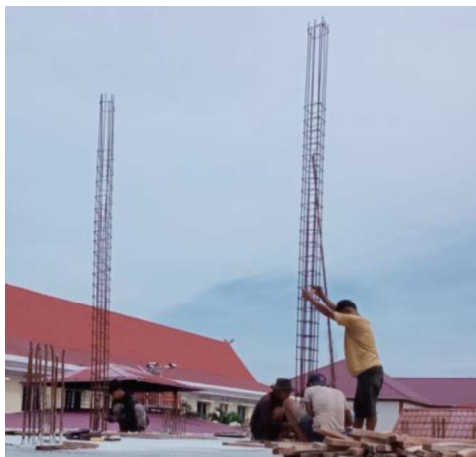
Gambar III.74 Pekerjaan Ikat Tulangan Dengan Kawat Bendrat (Sumber: Dokumentasi Lapangan 2023)
