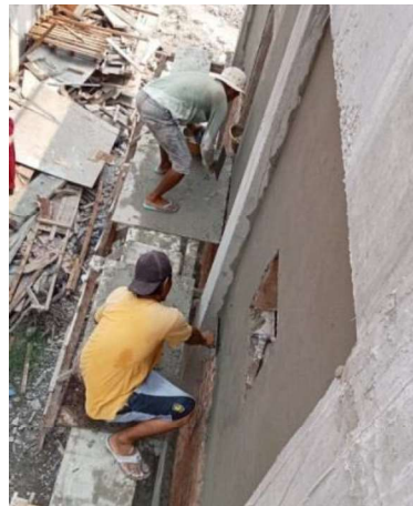
Gambar III.109 Pekerjaan Acian Dinding (Sumber: Dokumentasi Lapangan 2023)
