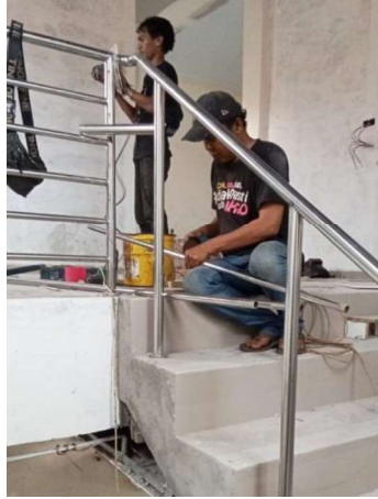
Gambar III.126 Pekerjaan Railing Horizontal Tangga (Sumber: Dokumentasi Lapangan 2023)
