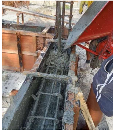
Gambar III.12 Pengecoran dengan menggunakan Gerobak Sorong (Sumber: Dokumentasi Lapangan 2023)
