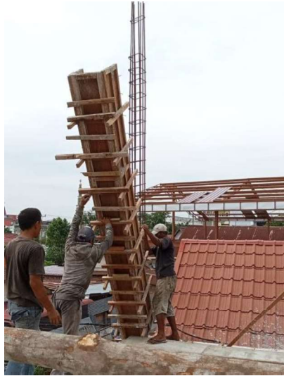
Gambar III.77 Pekerjaan Penentuan As Kolom (Sumber: Dokumentasi Lapangan 2023)
