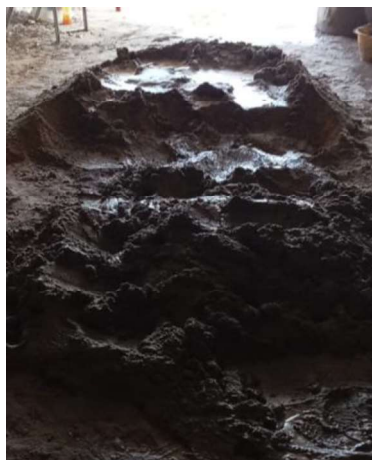
Gambar III.31 Adukan Spesi (Sumber: Dokumentasi Lapangan 2023)
