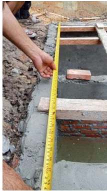
Gambar III.163 Meteran (Sumber: Dokumentasi Lapangan 2023)
