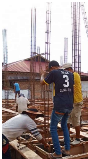
Gambar III.18 Pekerjaan Memasukkan Tulangan KP (Sumber: Dokumentasi Lapangan 2023)
