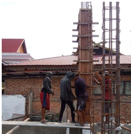
Gambar III.22 Pekerjaan Penentuan As Kolom (Sumber: Dokumentasi Lapangan 2023)
