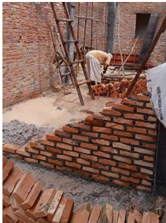
Gambar III.33 Pemasangan Batu Bata dengan spesi 2 cm (Sumber: Dokumentasi Lapangan 2023)
