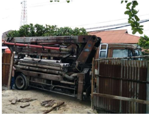
Gambar III.161 Concrete Pump (Sumber: Dokumentasi Lapangan 2023)
