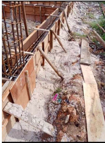
Gambar III.8 Pemasangan Kayu dolken sebagai sekor/pengunci (Sumber: Dokumentasi Lapangan 2023)
