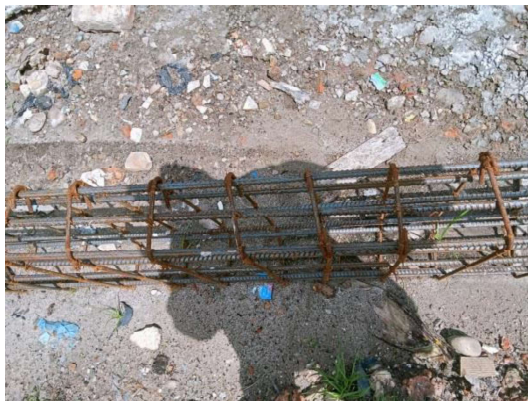
Gambar III.72 Tulangan kolom Besi D13 dan D8 (Sumber: Dokumentasi Lapangan 2023)
