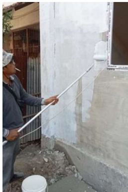
Gambar III.121 Pekerjaan Pengecatan Dasar Dinding (Sumber: Dokumentasi Lapangan 2023)
