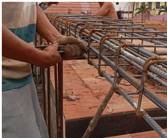
Gambar III.40 Perakitan tulangan Balok (Sumber: Dokumentasi Lapangan 2023)
