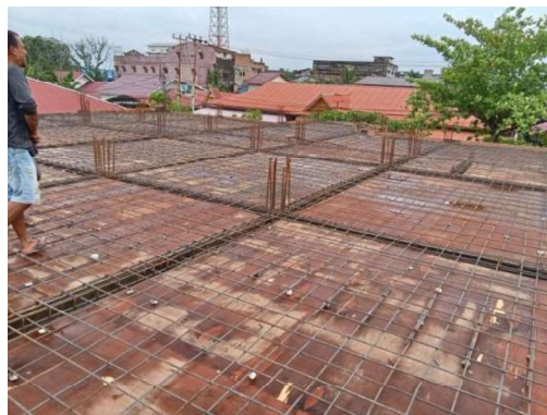
Gambar III.55 Pekerjaan Pemasangan Penulangan Plat Lantai (Sumber: Dokumentasi Lapangan 2023)
