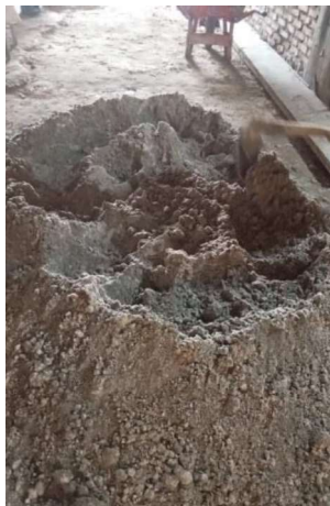
Gambar III.85 Adukan Spesi (Sumber: Dokumentasi Lapangan 2023)
