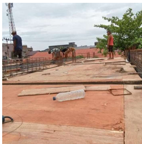
Gambar III.51 Pekerjaan Pemasangan Bekisting Plat Lantai (Sumber: Dokumentasi Lapangan 2023)
