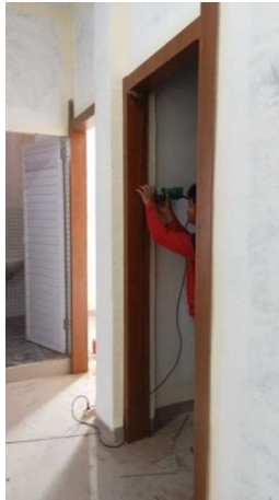
Gambar III.136 Pemasangan Triplek hpl (Sumber: Dokumentasi Lapangan 2023)
