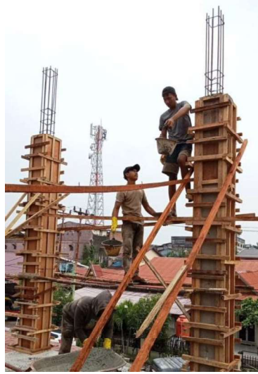
Gambar III.81 Pekerjaan Pengecoran Kolom (Sumber: Dokumentasi Lapangan 2023)
