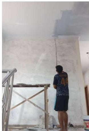
Gambar III.133 Pekerjaan Pengecatan Plafon/Gypsum (Sumber: Dokumentasi Lapangan 2023)
