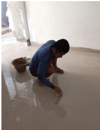
Gambar III.119 Pemasangan Tite Grout Pada Celah Keramik (Sumber: Dokumentasi Lapangan 2023)
