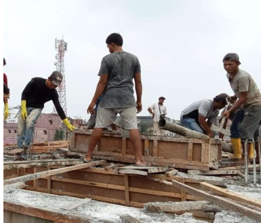
Gambar III.95 Wadah Persegi Untuk Menampung Beton (Sumber: Dokumentasi Lapangan 2023)
