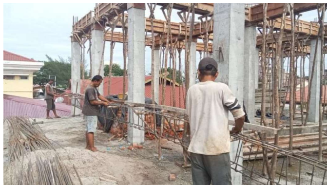
Gambar III.94 Pekerjaan Pembesian Ring Balok (Sumber: Dokumentasi Lapangan 2023)
