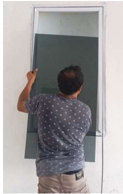
Gambar III.140 Pekerjaan Pemasangan Kaca Jendela (Sumber: Dokumentasi Lapangan 2023)
