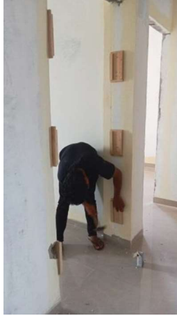
Gambar III.134 Pemasangan Penyangga kusen (Sumber: Dokumentasi Lapangan 2023)
