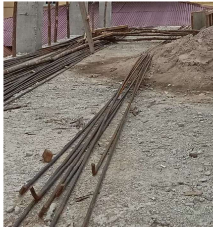
Gambar III.92 Tulangan Utama Ring Balok Besi D13 (Sumber: Dokumentasi Lapangan 2023)
