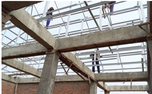
Gambar III.105 Pekerjaan Pemasangan Reng (Sumber: Dokumentasi Lapangan 2023)
