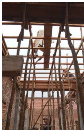
Gambar III.49 Pekerjaan Pemasangan Perancah Kayu Dolken (Sumber: Dokumentasi Lapangan 2023)
