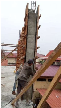
Gambar III.83 Pekerjaan Pembongkaran Bekisting Kolom lantai 2 (Sumber: Dokumentasi Lapangan 2023)
