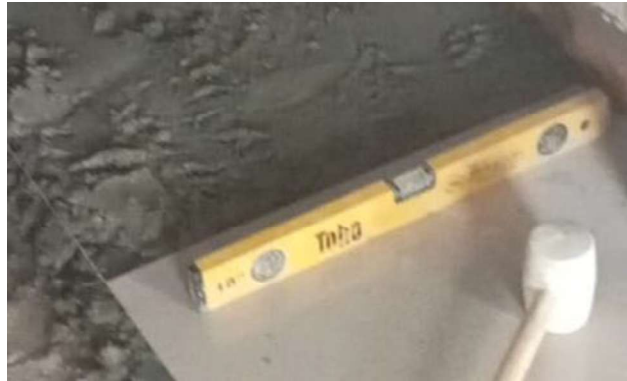
Gambar III.167 Waterpass (Sumber: Dokumentasi Lapangan 2023)
