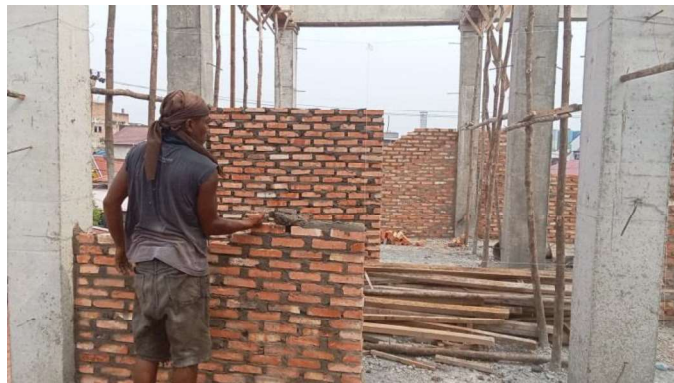
Gambar III.87 Pemasangan Batu Bata dengan spesi 2 cm (Sumber: Dokumentasi Lapangan 2023)
