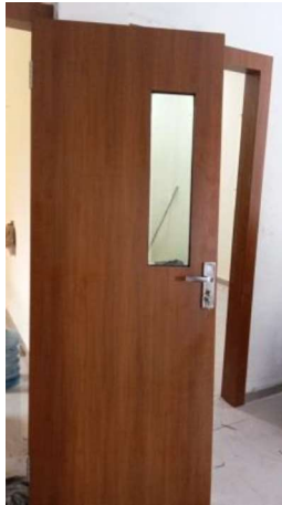
Gambar III.138 Pekerjaan Pemasangan Daun Pintu (Sumber: Dokumentasi Lapangan 2023)
