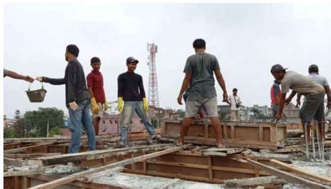
Gambar III.96 Pekerjaan Pengecoran Ring Balok (Sumber: Dokumentasi Lapangan 2023)
