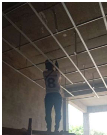
Gambar III.129 Pekerjaan Pemasangan Rangka utama (Sumber: Dokumentasi Lapangan 2023)
