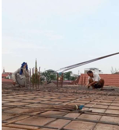
Gambar III.52 Pengikatan Tulangan plat lantai (Sumber: Dokumentasi Lapangan 2023)
