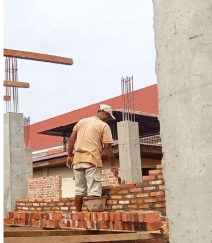
Gambar III.34 Meluruskan Batu Bata (Sumber: Dokumentasi Lapangan 2023)
