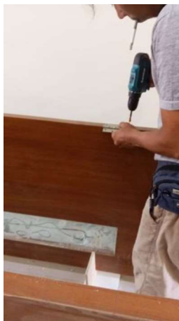
Gambar III.137 Pemasangan Engsel Pada Pintu (Sumber: Dokumentasi Lapangan 2023)
