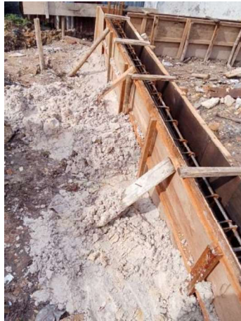
Gambar III.7 Penimbunan Pasir Urug (Sumber: Dokumentasi Lapangan 2023)
