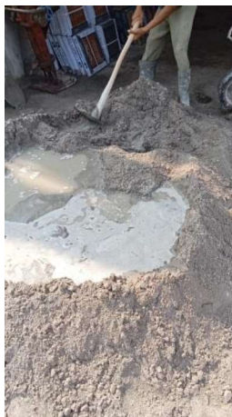
Gambar III.115 Adukan Spesi (Sumber: Dokumentasi Lapangan 2023)
