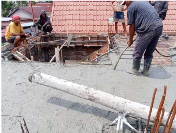
Gambar III.45 Alat penggetar Beton dengan Menggunakan Vibrator (Sumber: Dokumentasi Lapangan 2023)
