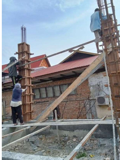
Gambar III.23 Penyetelan Bekisting Kolom (Sumber: Dokumentasi Lapangan 2023)
