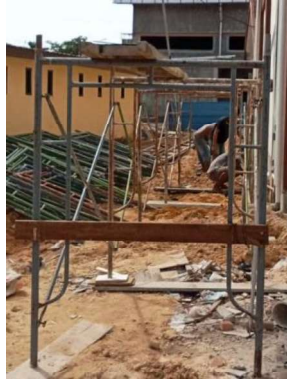
Gambar III.169 Scaffolding (Sumber: Dokumentasi Lapangan 2023)
