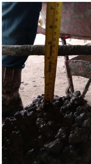
Gambar III.42 Hasil Uji Slump 10,5 cm (Sumber: Dokumentasi Lapangan 2023)
