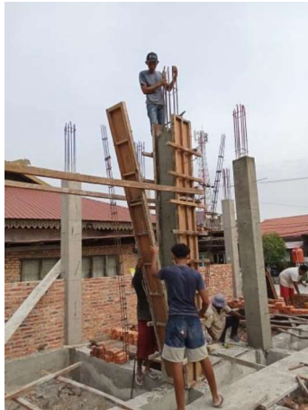
Gambar III.29 Pekerjaan Pembongkaran Bekisting Kolom (Sumber: Dokumentasi Lapangan 2023)
