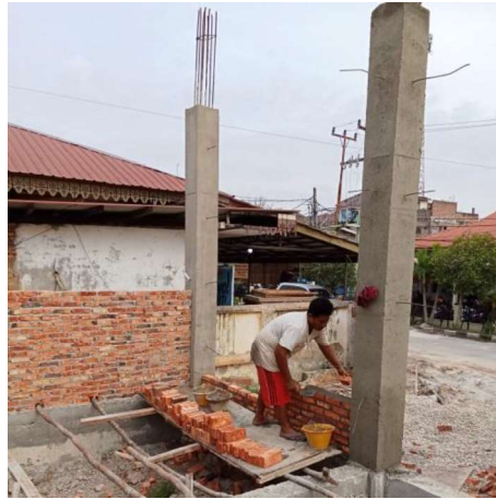
Gambar III.32 Pemasangan Batu Bata (Sumber: Dokumentasi Lapangan 2023)
