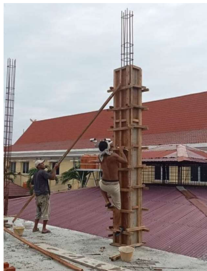
Gambar III.78 Penyetelan Bekisting Kolom (Sumber: Dokumentasi Lapangan 2023)
