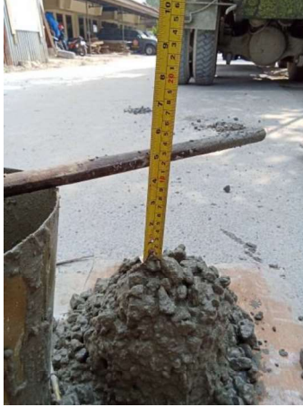
Gambar III.25 Hasil Uji Slump 12 cm (Sumber: Dokumentasi Lapangan 2023)
