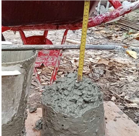
Gambar III.10 Hasil Uji Slump 10,5 cm (Sumber: Dokumentasi Lapangan 2023)
