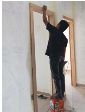
Gambar III.135 Pemasangan Kusen Pintu (Sumber: Dokumentasi Lapangan 2023)
