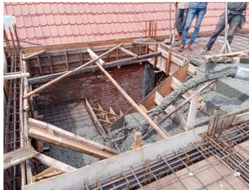
Gambar III.69 Pengecoran Dengan Concrete Pump (Sumber: Dokumentasi Lapangan 2023)
