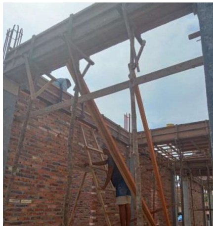
Gambar III.38 Pekerjaan Pemasangan Bekisting Balok (Sumber: Dokumentasi Lapangan 2023)
