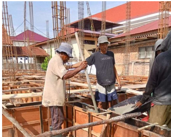
Gambar III.13 Tusukan Beton Dengan Menggunakan Tongkat Kayu (Sumber: Dokumentasi Lapangan 2023)
