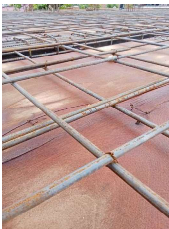
Gambar III.53 Tulangan Plat Lantai (Sumber: Dokumentasi Lapangan 2023)
