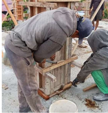
Gambar III.71 Pekerjaan Penentuan As Kolom (Sumber: Dokumentasi Lapangan 2023)
