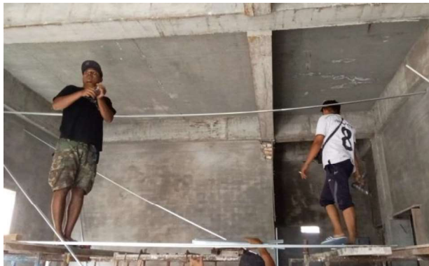
Gambar III.127 Pengukuran Ketinggian Plafonn (Sumber: Dokumentasi Lapangan 2023)
