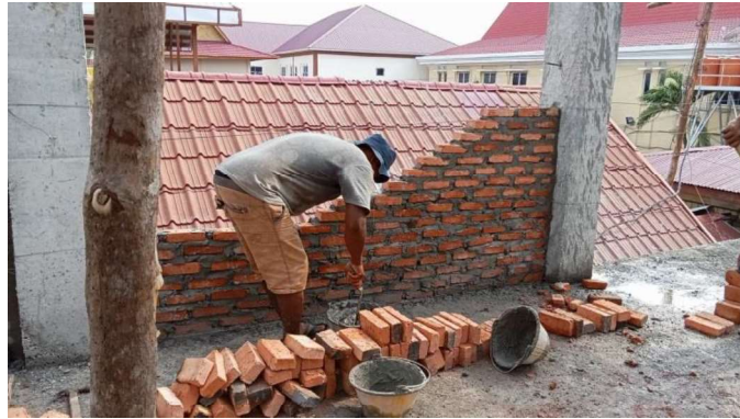
Gambar III.86 Pemasangan Batu Bata (Sumber: Dokumentasi Lapangan 2023)
