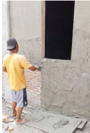
Gambar III.108 Pekerjaan Plasteran Dinding (Sumber: Dokumentasi Lapangan 2023)
