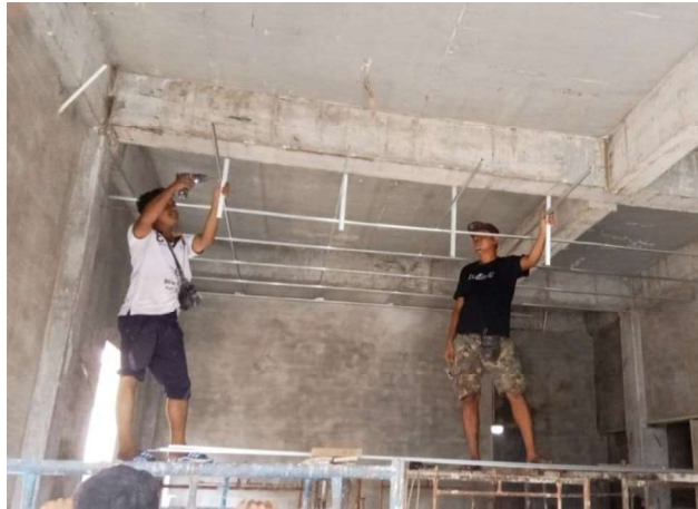
Gambar III.128 Pemasangan Rangka Penggantung (Sumber: Dokumentasi Lapangan 2023)
