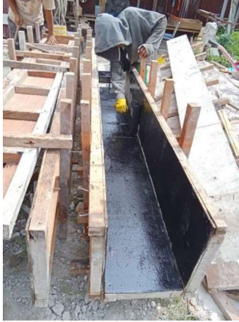
Gambar III.21 Pengecatan Bekisting Kolom (Sumber: Dokumentasi Lapangan 2023)
