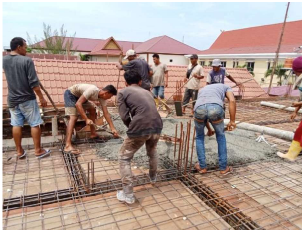
Gambar III.59 Perataan beton (Sumber: Dokumentasi Lapangan 2023)
