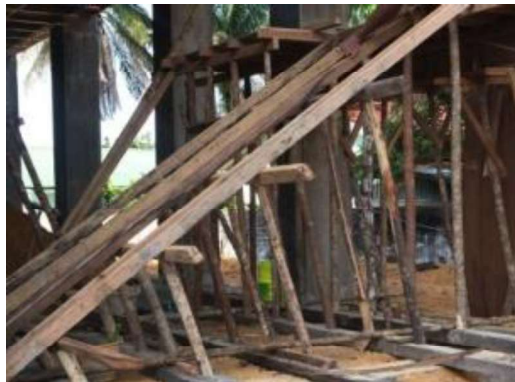
Gambar III.63 Perancah Untuk Menahan Beban Bekisting Tangga (Sumber: Dokumentasi Lapangan 2023)
