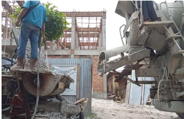
Gambar III.141 Beton Ready Mix (Sumber: Dokumentasi Lapangan 2023)
