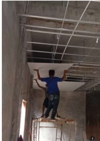
Gambar III.130 Pemasangan Plafon/Gypsum (Sumber: Dokumentasi Lapangan 2023)
