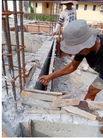
Gambar III.15 Pekerjaan Pembongkaran Sloof (Sumber: Dokumentasi Lapangan 2023)
