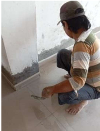
Gambar III.120 Pembersihan Sisa Tite Grout (Sumber: Dokumentasi Lapangan 2023)
