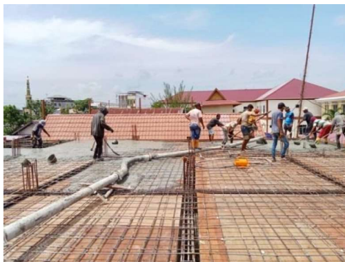
Gambar III.44 Pekerjaan Pengecoran Balok (Sumber: Dokumentasi Lapangan 2023)
