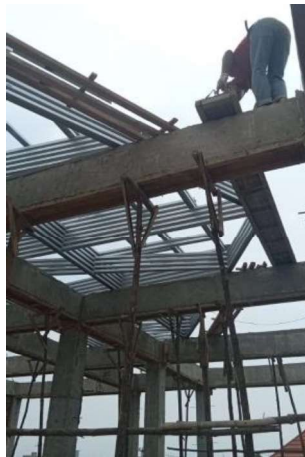
Gambar III.103 Pekerjaan Penyusunan Rangka Atap (Sumber: Dokumentasi Lapangan 2023)
