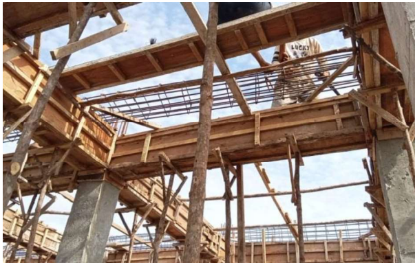
Gambar III.90 Pekerjaan Pemasangan Bekisting Ring Balok (Sumber: Dokumentasi Lapangan 2023)
