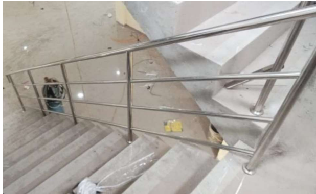
Gambar III.125 Tiang Railing (Sumber: Dokumentasi Lapangan 2023)
