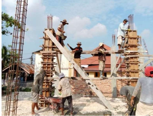
Gambar III.27 Pekerjaan Pengecoran Kolom (Sumber: Dokumentasi Lapangan 2023)
