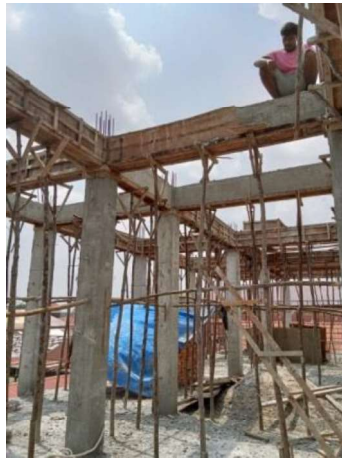
Gambar III.100 Pekerjaan Pembongkaran Bekisting Ring Balok (Sumber: Dokumentasi Lapangan 2023)
