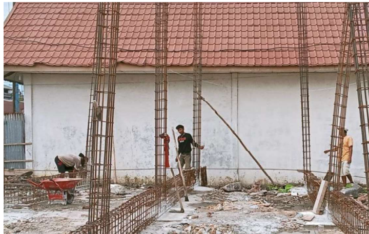
Gambar III.3 Pekerjaan Memasukkan Tulangan Utama (Sumber: Dokumentasi Lapangan 2023)
