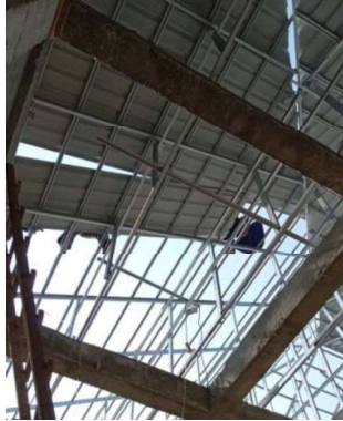
Gambar III.106 Pekerjaan Pemasangan Atap (Sumber: Dokumentasi Lapangan 2023)
