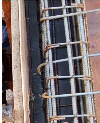
Gambar III.54 Tulangan Dibengkokkan 90^\circ (Sumber: Dokumentasi Lapangan 2023)
