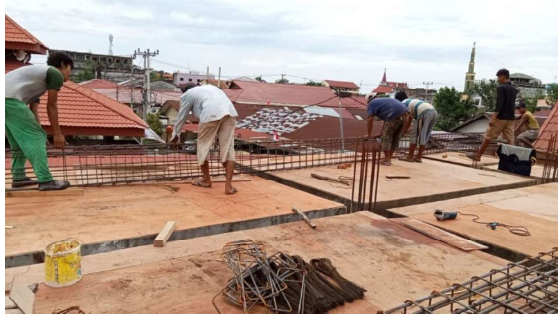
Gambar III.41 Pekerjaan Pemasangan Tulangan Balok (Sumber: Dokumentasi Lapangan 2023)
