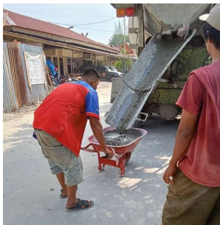
Gambar III.24 Pengambilan Sampel Beton (Sumber: Dokumentasi Lapangan 2023)
