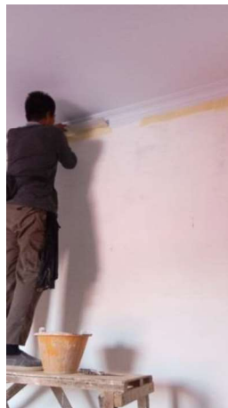
Gambar III.123 Pekerjaan Pengecatan Tepi Dinding (Sumber: Dokumentasi Lapangan 2023)
