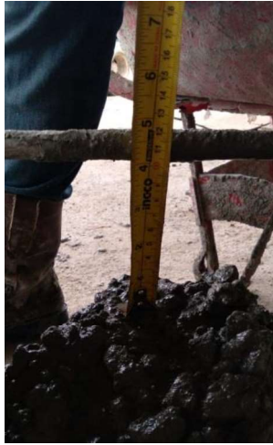
Gambar III.56 Hasil Uji Slump 10,5cm (Sumber: Dokumentasi Lapangan 2023)
