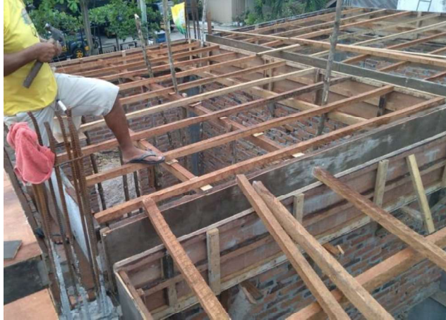
Gambar III.50 Pemasangan Gelagar (Sumber: Dokumentasi Lapangan 2023)
