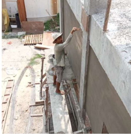
Gambar III.110 Merapikan Acian Dengan Menggunakan Kuas (Sumber: Dokumentasi Lapangan 2023)
