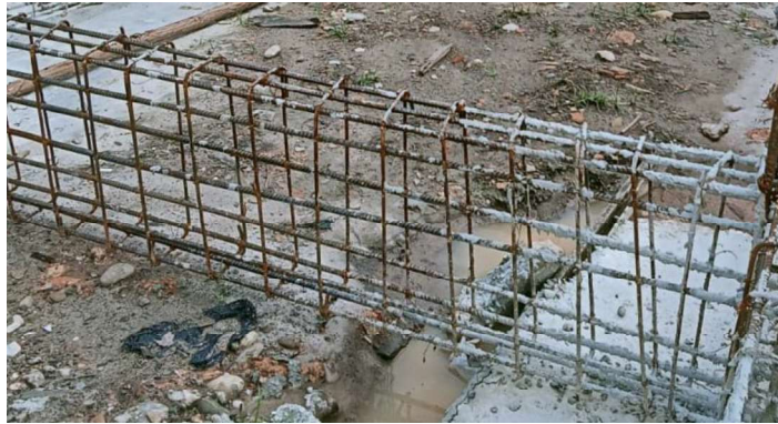
Gambar III.2 Tulangan Balok Sloof (Sumber: Dokumentasi Lapangan 2023)
