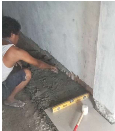
Gambar III.117 Menaburkan Semen diatas Spesi (Sumber: Dokumentasi Lapangan 2023)
