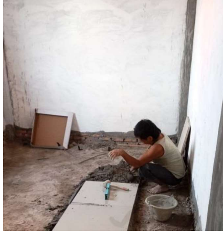
Gambar III.116 Perletakan Spesi setebal \pm 4-5 cm, (Sumber: Dokumentasi Lapangan 2023)
