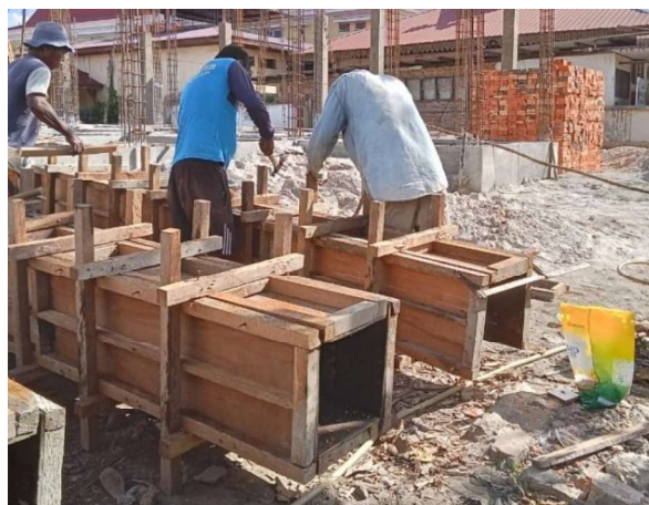
Gambar III.20 Pekerjaan Pembuatann Bekisting Kolom (Sumber: Dokumentasi Lapangan 2023)
