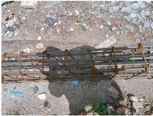
Gambar III.17 Tulalangan kolom Besi D13 dan D8 (Sumber: Dokumentasi Lapangan 2023)
