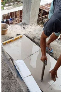
Gambar III.118 Pekerjaan Pemasangan Lantai Granite (Sumber: Dokumentasi Lapangan 2023)
