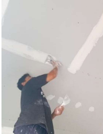
Gambar III.132 Pekerjaan Pemasangan Dempul pada Gypsum (Sumber: Dokumentasi Lapangan 2023)
