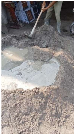
Gambar III.107 Perbandingan Untuk Plasteran 1pc:4ps (Sumber: Dokumentasi Lapangan 2023)
