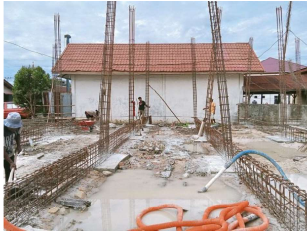
Gambar III.19 Tulangan Kolom (Sumber: Dokumentasi Lapangan 2023)
