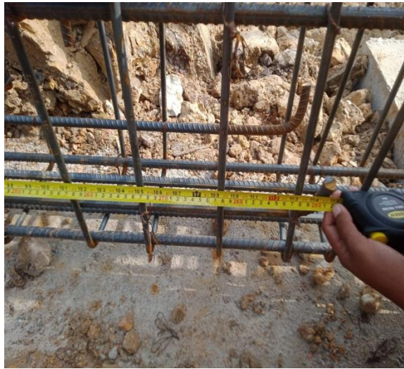
Gambar 3.22 pengukuran tulangan tumpuan lapangan Sumber:(Dokumentasi lapangan,2023)
