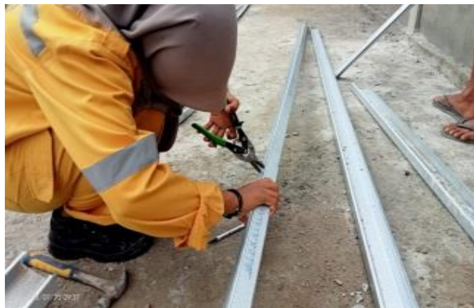
Gambar 3.4 penyambungan kaki kerangka atap Sumber:(Dokumentasi lapangan,2023)
