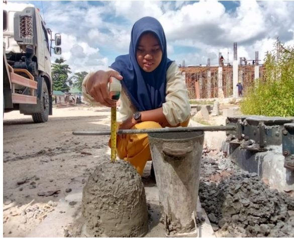
Gambar 3.24 penguji slump Sumber:(Dokumentasi lapangan,2023)
