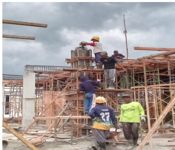
Gambar 3.29 pengecoran kolom lantai 2 Sumber:(Dokumentasi lapangan,2023)
