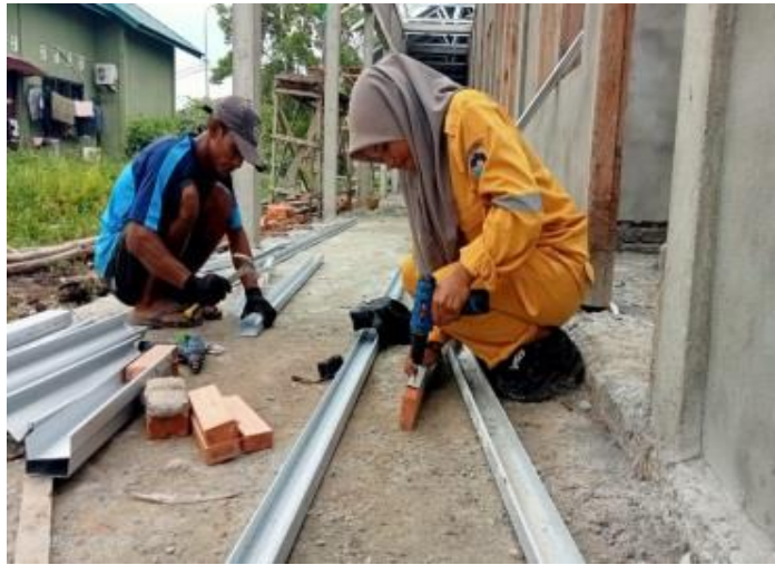
Gambar 3.5 penyambungan kaki kerangka atap Sumber:(Dokumentasi lapangan,2023)
