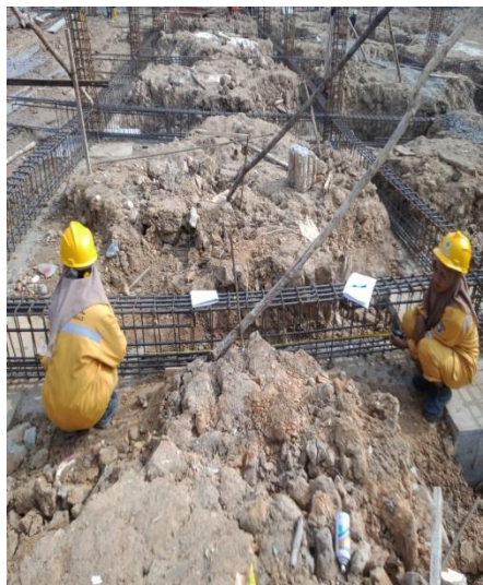
Gambar 3.15 pengukuran tie beam Sumber:(Dokumentasi lapangan,2023)
