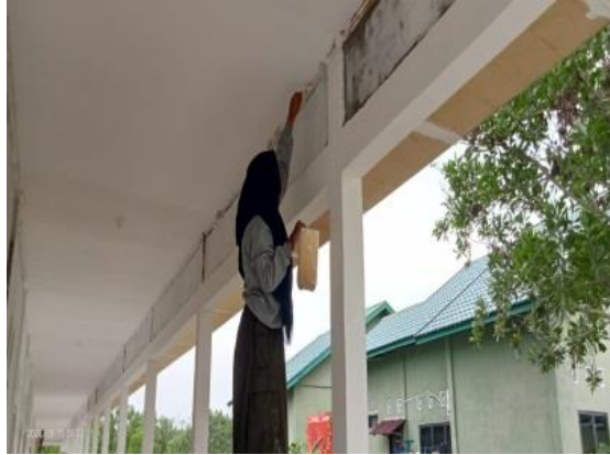
Gambar 3.14 pengecatan Sumber:(Dokumentasi lapangan,2023)
