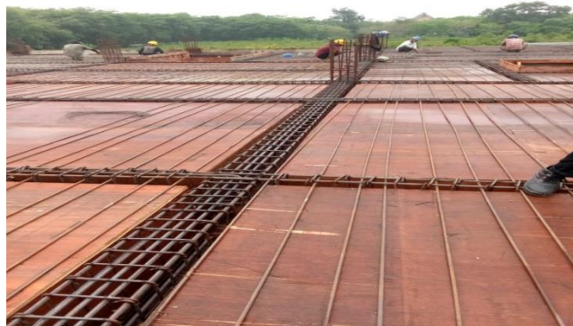
Gambar 3.31 pembesian plat lantai 2 Sumber:(Dokumentasi lapangan,2023)
