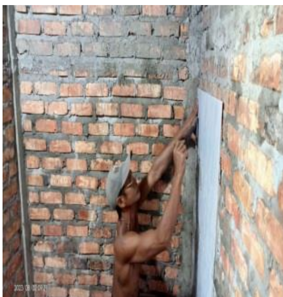
Gambar 3.9 pekerjaan pemasangan keramik Sumber:(Dokumentasi lapangan,2023)
