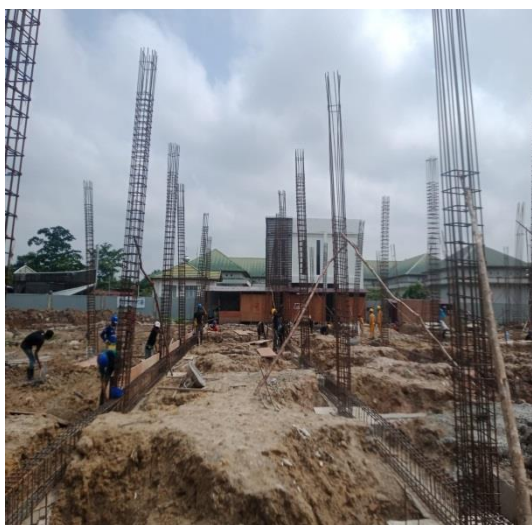
Gambar 3.21 pekerjaan tulangan tumpuan lapangan Sumber:(Dokumentasi lapangan,2023)
