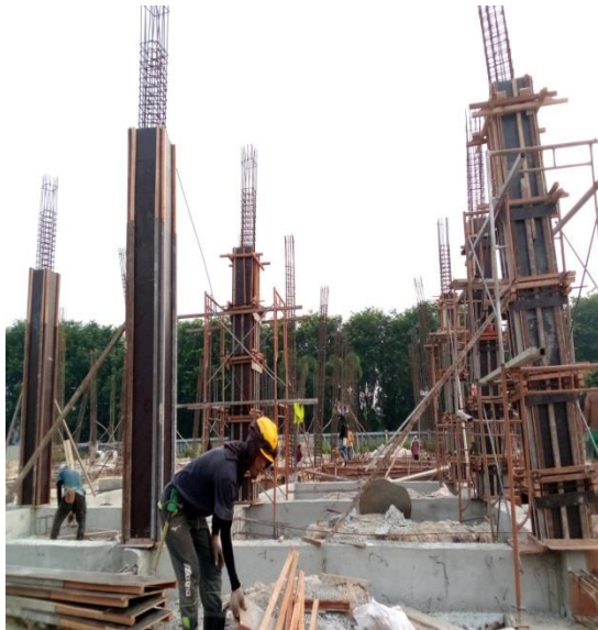
Gambar 3.27 bekisting kolom Sumber:(Dokumentasi lapangan,2023)
