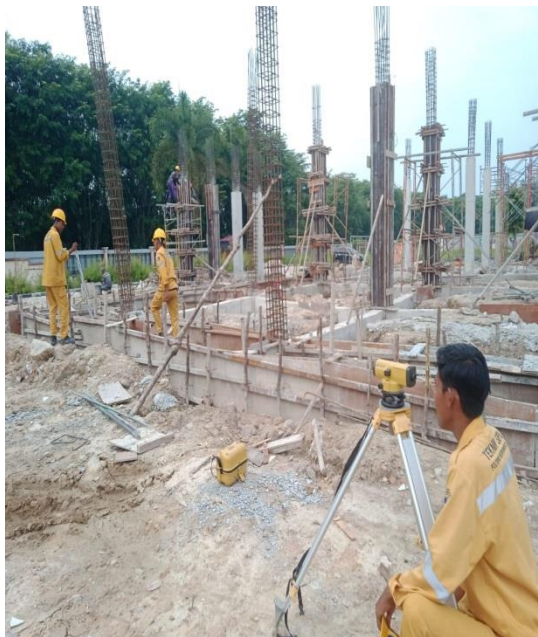
Gambar 3.19 pengukuran menentukan elevasi Sumber:(Dokumentasi lapangan,2023)
