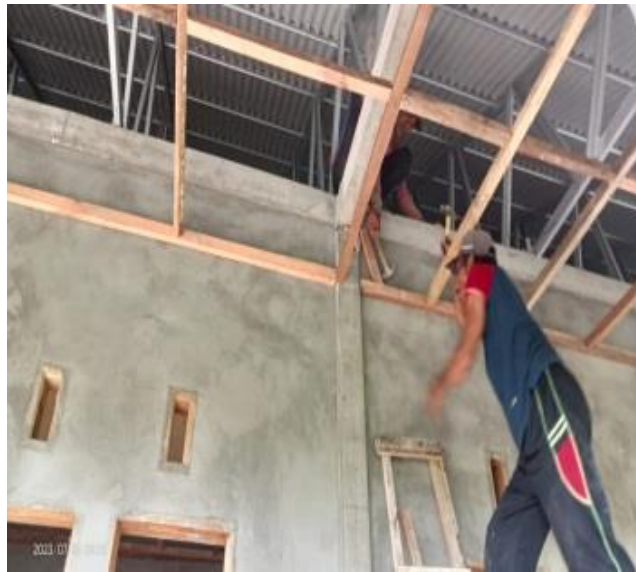
Gambar 3.6 perkerjaan pemasangan plafon Sumber:(Dokumentasi lapangan,2023)
