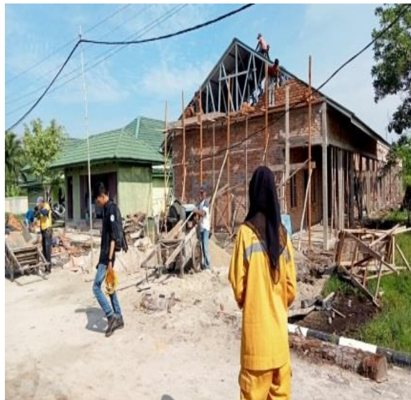
Gambar 3.1 pekerjaan pasangan bata Sumber: (Dokumentasi lapangan, 2023)
