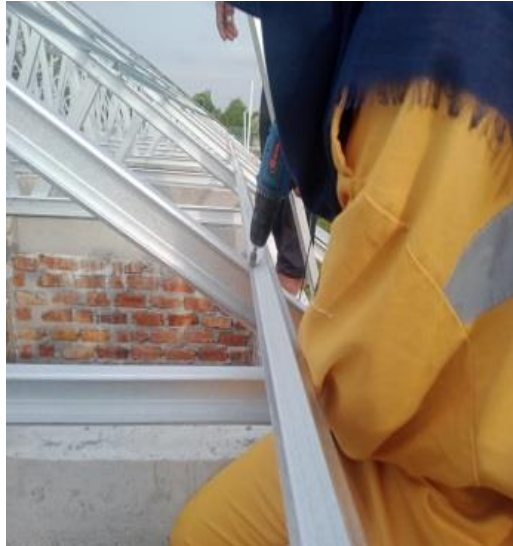
Gambar 3.3 pemasangan kerangka atap Sumber:(Dokumentasi lapangan,2023)
