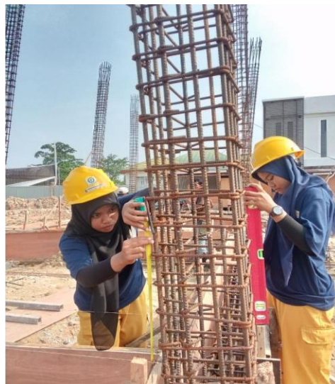
Gambar 3.17 pengukuran tie beam Sumber:(Dokumentasi lapangan,2023)
