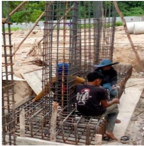
Gambar 3.14 Tulangan pile cap Sumber:(Dokumentasi lapangan,2023)
