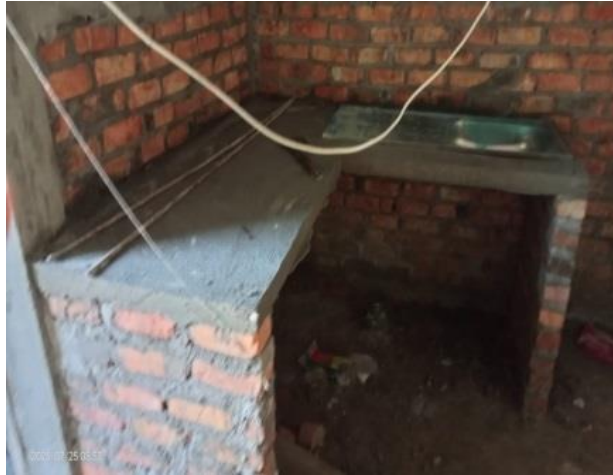
Gambar 3.12 pemasangan wastafel Sumber:(Dokumentasi lapangan,2023)
