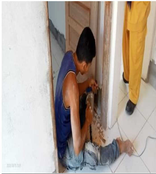
Gambar 3.10 pemasangan kusen pintu dan jendela Sumber:(Dokumentasi lapangan,2023)
