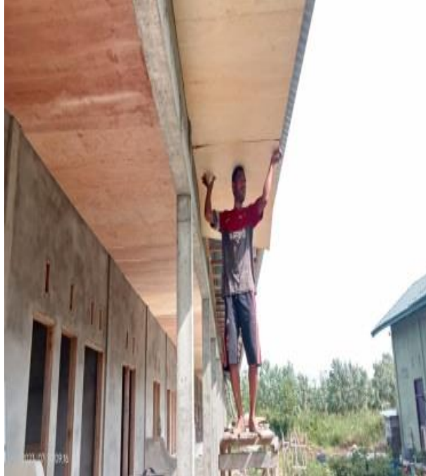
Gambar 3.7 pekerjaan pemasangan plafon Sumber:(Dokumentasi lapangan,2023)
