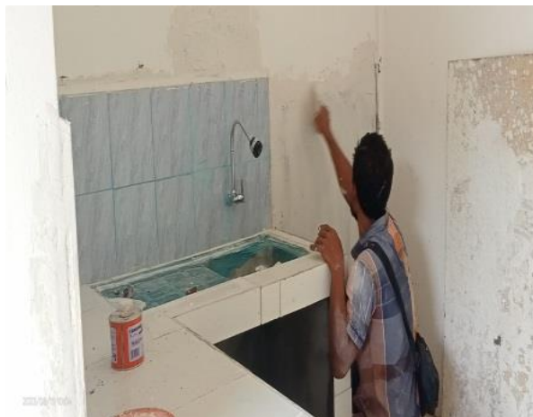
Gambar 3.13 pemasangan wastafel Sumber:(Dokumentasi lapangan,2023)
