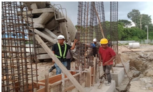
Gambar 3.25 pengecoran tie beam Sumber:(Dokumentasi lapangan,2023)
