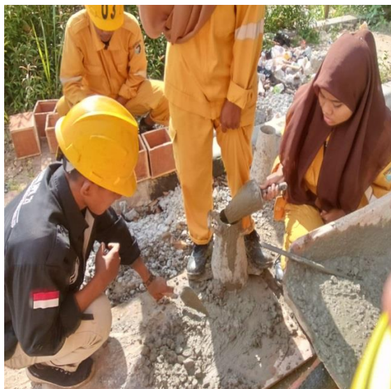
Gambar 3.23 penguji slump Sumber:(Dokumentasi lapangan,2023)
