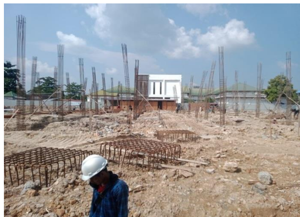
Gambar 3.13 Tulangan pile cap Sumber:(Dokumentasi lapangan,2023)
