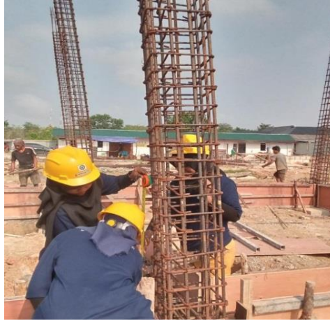
Gambar 3.16 pengukuran tie beam Sumber:(Dokumentasi lapangan,2023)
