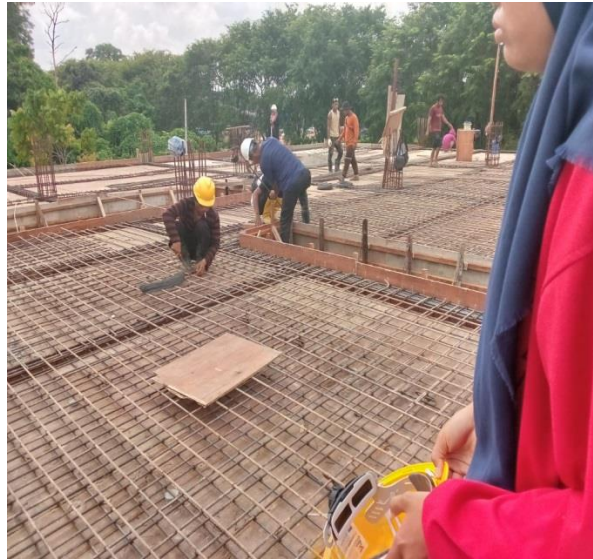
Gambar 3.32 pembesian plat lantai Sumber:(Dokumentasi lapangan,2023)
