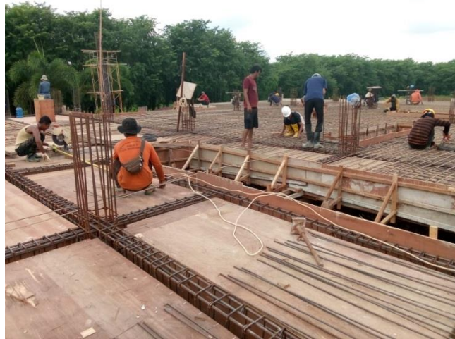
Gambar 3.30 pembesian plat lantai 2 Sumber:(Dokumentasi lapangan,2023)
