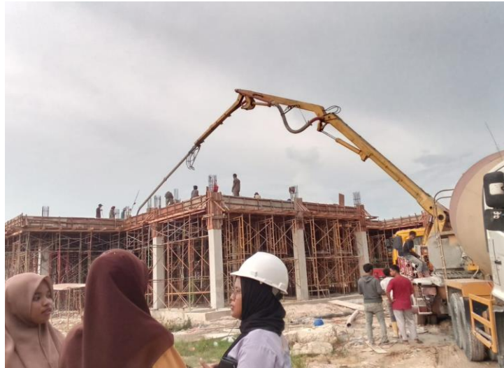
Gambar 3.33 pengecoran plat lantai 2 Sumber: (Dokumentasi lapangan, 2023)
