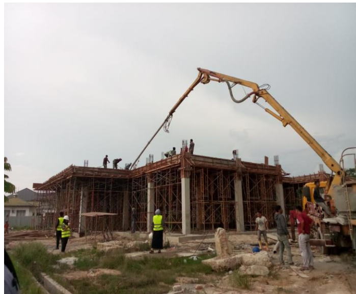
Gambar 3.34 pengecoran plat lantai 2 Sumber: (Dokumentasi lapangan, 2023)
