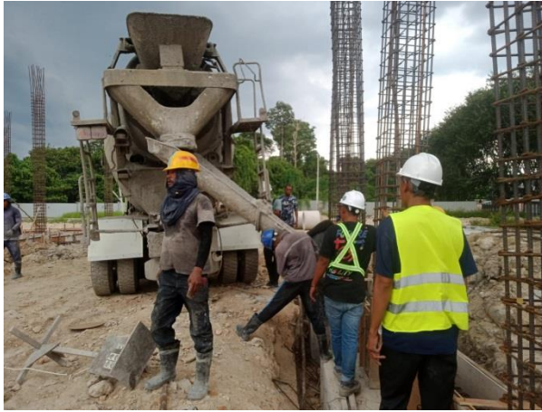
Gambar 3.26 pengecoran tie beam Sumber:(Dokumentasi lapangan,2023)
