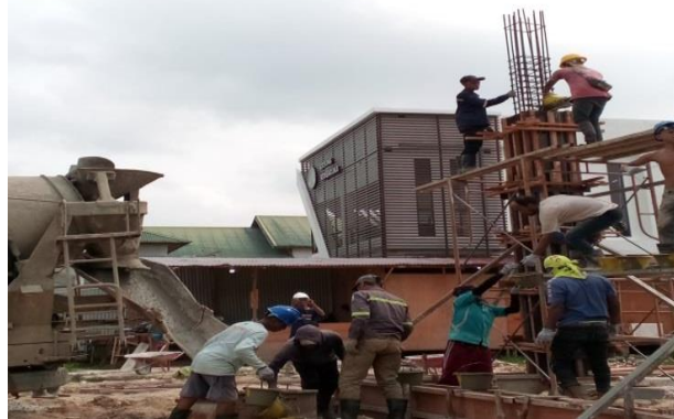
Gambar 3.28 pengecoran kolom Sumber:(Dokumentasi lapangan,2023)
