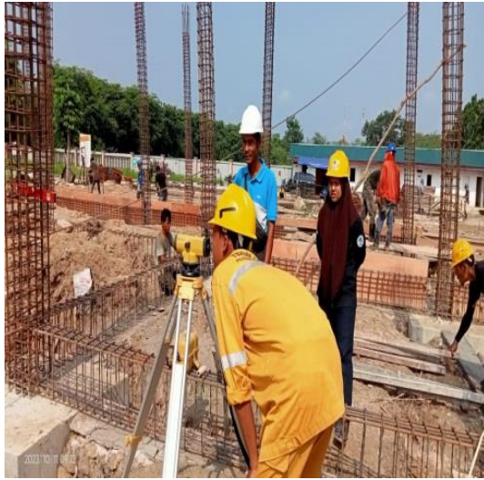
Gambar 3.18 pengukuran menentukan elevasi Sumber:(Dokumentasi lapangan,2023)
