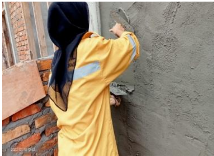
Gambar 3.2 pekerjaan plesteran Sumber: (Dokumentasi lapangan, 2023)
