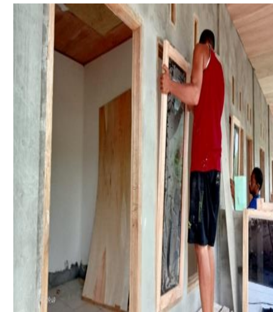
Gambar 3.11 pemasangan kusen pintu dan jendela Sumber:(Dokumentasi lapangan,2023)
