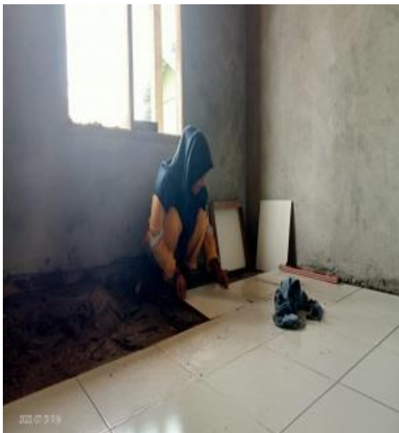
Gambar 3.8 pekerjaan pemasangan keramik Sumber:(Dokumentasi lapangan,2023)
