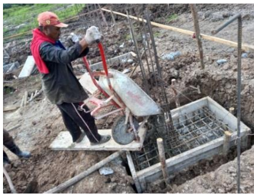
Gambar 3.17 Pengecoran pondasi pile cap Sumber : Dokumentasi lapangan
