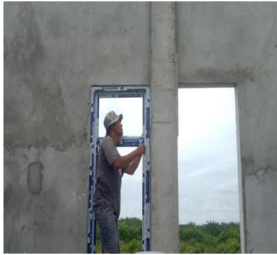
Gambar 3.36 Pemasangan kusen jendela Sumber : Dokumentasi lapangan
