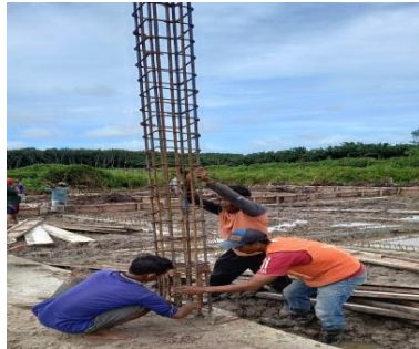
Gambar 3.19 Proses pemasangan penulangan kolom Sumber : Dokumentasi lapangan
