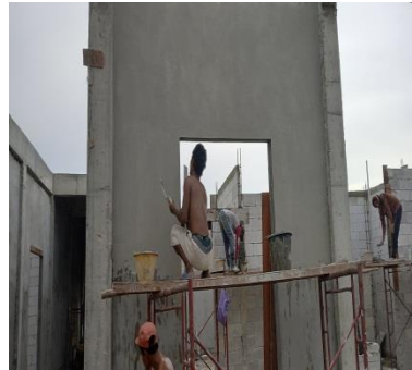
Gambar 3.35 Pekerjaan acian Sumber : Dokumentasi lapangan
