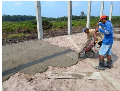
Gambar 3.14 Pekerjaan lantai kerja Sumber : Dokumentasi lapangan
