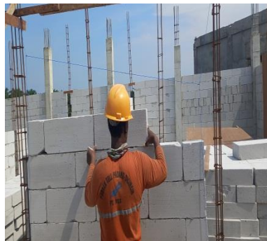
Gambar 3.33 Pekerjaan pemasangan dinding bata Sumber : Dokumentasi lapangan
