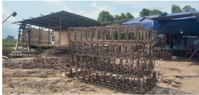
Gambar 3.16 Fabrikasi Pembesian/penulangan di lokasi proyek Sumber : Dokumentasi lapangan
