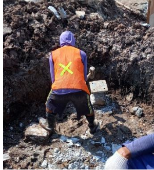
Gambar 3.12 Pemecahan kepala tiang pancang Sumber : Dokumentasi lapangan
