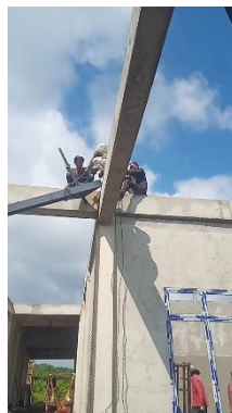
Gambar 3.32 Pekerjaan erection rangka baja Sumber : Dokumentasi lapangan
