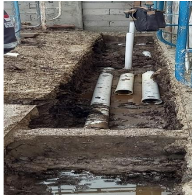
Gambar 3.38 Pekerjaan pemasangan pipa saluran air Sumber : Dokumentasi lapangan
