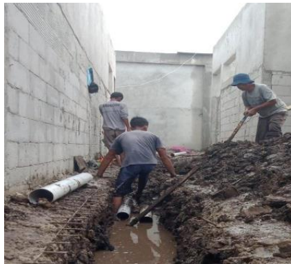
Gambar 3.37 Pekerjaan pemasangan pipa saluran air Sumber : Dokumentasi lapangan
