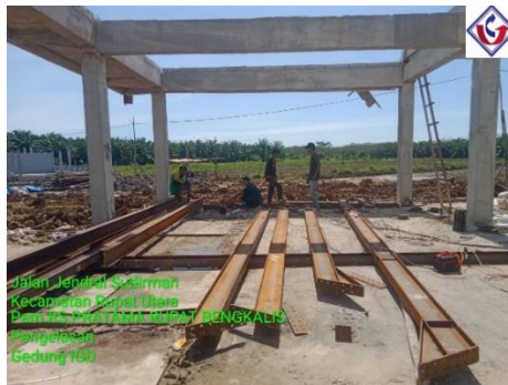
Gambar 3.30 Pekerjaan pengelasan sambungan baja Sumber : Dokumentasi lapangan
