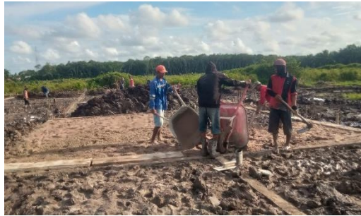
Gambar 3.13 Pekerjaan Urugan Pasir Sumber : Dokumentasi lapangan
