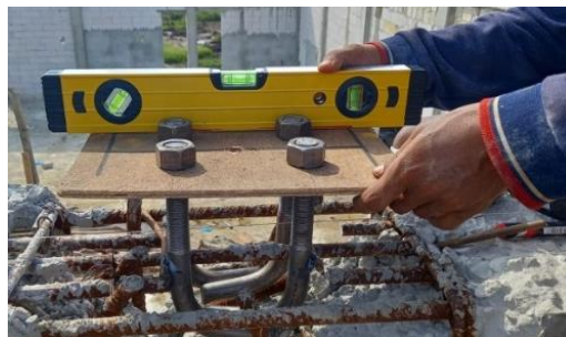
Gambar 3.29 Pekerjaan koreksi pemasangan anker Sumber : Dokumentasi lapangan
