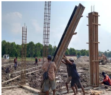
Gambar 3.20 Proses pemasangan bekisting kolom Sumber : Dokumentasi lapangan
