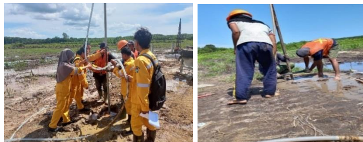
Gambar 3.7 Pengeboran strous pile Sumber : Dokumentasi Proyek
