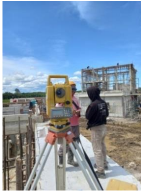
Gambar 3.28 Pembidikan perletakkan anker baja Sumber : Dokumentasi lapangan
