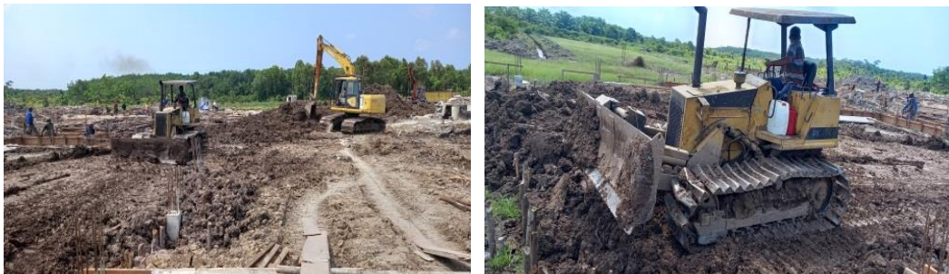
Gambar 3.2 Proses pemerataan jalan. Sumber : Dokumentasi lapangan
