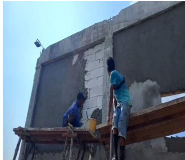
Gambar 3.34 Pekerjaan plesteran dinding Sumber : Dokumentasi lapangan
