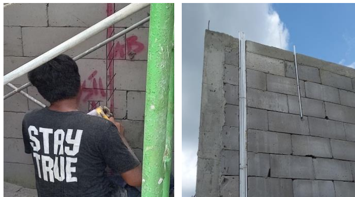
Gambar 3.39 Pekerjaan pembobokan & pemasangann pipa listrik Sumber : Dokumentasi lapangan
