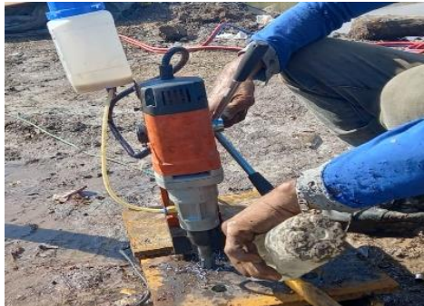
Gambar 3.31 Pekerjaan pembuatan sambungan baut pengikat Sumber : Dokumentasi lapangan///
