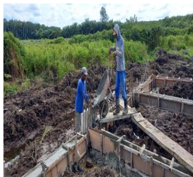
Gambar 3.18 Proses pekerjaan balok sloof Sumber : Dokumentasi lapangan
