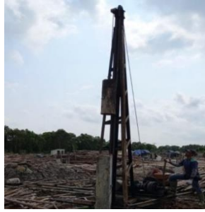
Gambar 3.10 Pekerjaan pemancangan tiang pancang
