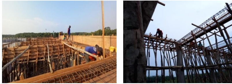
Gambar 3.22 Pekerjaan ring balok Sumber : Dokumentasi lapangan
