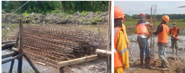
Gambar 3.9 masukan tulangan ke dalam pondasi Sumber : Dokumentasi Proyek
