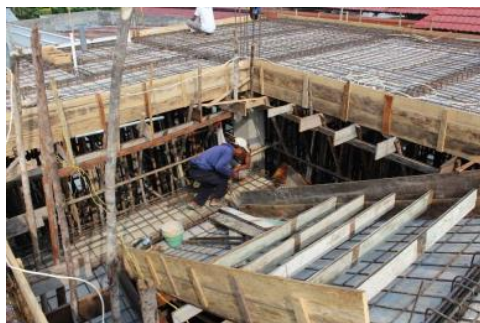
Gambar 3.26 Pekerjaan perakitan tulangan & bekisting tangga Sumber : Dokumentasi lapangan
