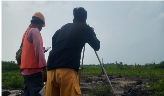
Gambar 3.3 Survey Pemasangan Bouwplank
