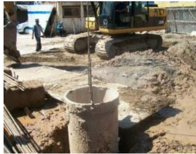
Gambar 3.6 Casing temporary Sumber : Dokumentasi Proyek
