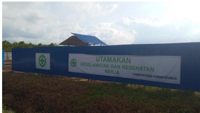
Gambar 3.5 Pemasangan pagar pengaman proyek Sumber : Dokumentasi Lapangan
