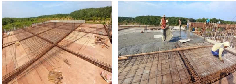
Gambar 3.23 Pekerjaan perakitan tulangan & pengecoran plat lantai Sumber : Dokumentasi lapangan
