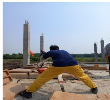
Gambar 3.15 Pembidikan elevasi lantai kerja dengan waterpass Sumber : Dokumentasi lapangan
