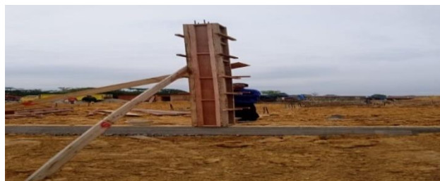
Gambar 3. 3 Tulangan dan beekisting
