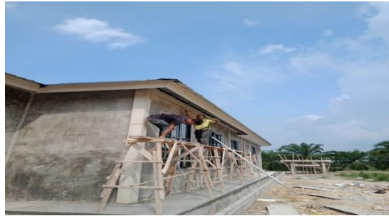
Gambar 3. 17 Pemaangan rangka piri-piri GRC
