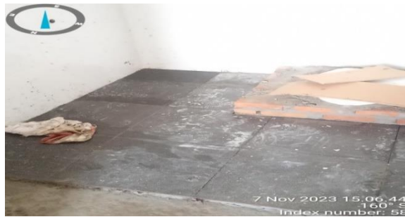
Gambar 3. 23 Pemasangan keramis toilet 40x40cm
