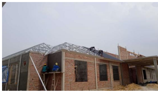
Gambar 3. 14 Pemasangan atap spandek
