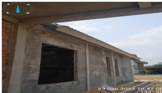
Gambar 3. 15 Pemasangan Listplank GRC
