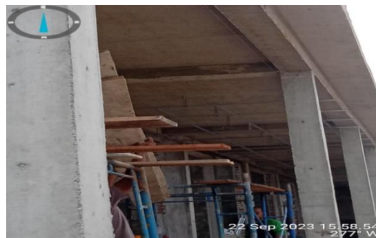
Gambar 3. 8 Pembongkaraan dak beton teras dalam
