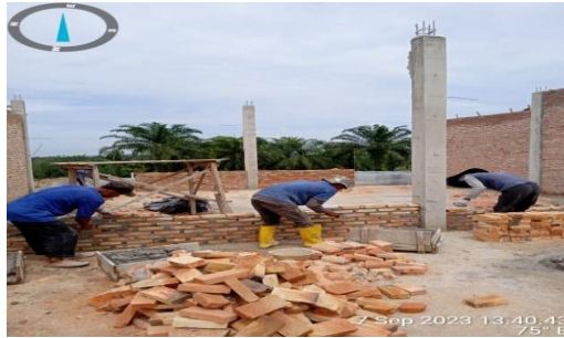
Gambar 3. 9 Pemasangan batu bata
