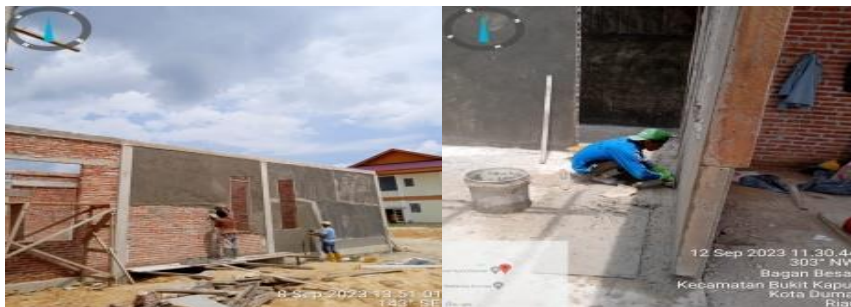
Gambar 3. 10 Plasteraan dan acian dinding
