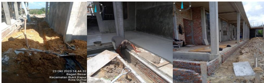
Gambar 3. 30 Pekerjaan rabat dan drainase
