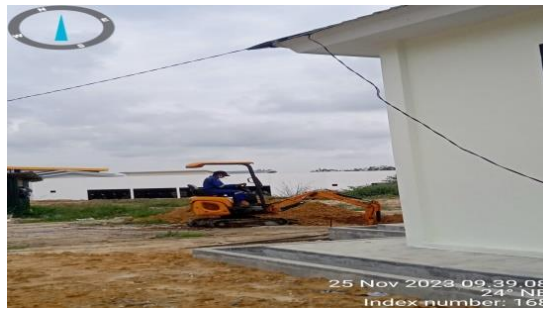
Gambar 3. 36 Pekerjaan sumur bor
