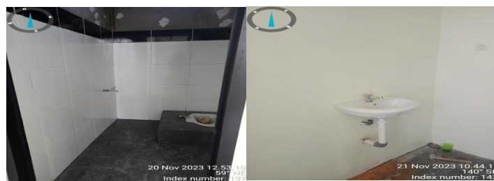
Gambar 3. 28 Pekerjaan pemasangan kloset dan washtafel
