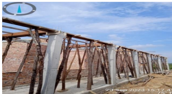
Gambar 3. 11 Bekisting dak beton teras dalam
