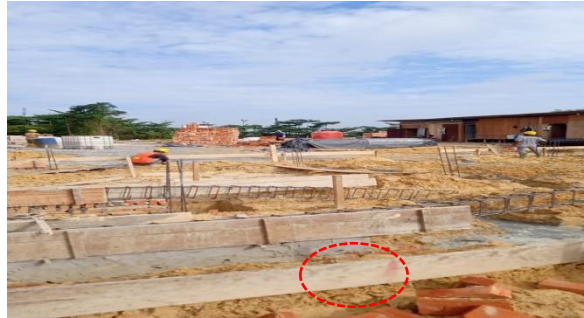
Gambar 3. 1 Pemasangan tulangan dan bekisting
