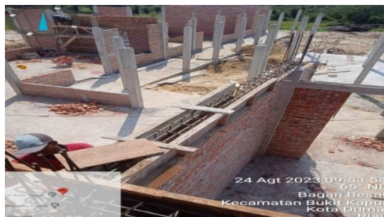
Gambar 3. 4 Tulangan dan bekisting ring balok bekisting
