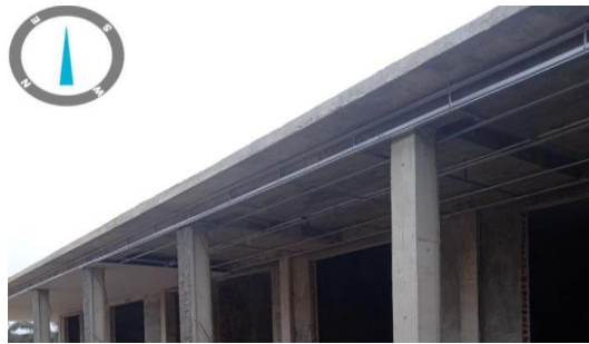
Gambar 3. 16 Pemaangan plafond Gypsum
