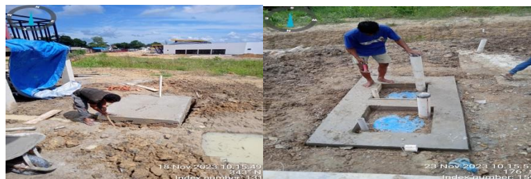
Gambar 3. 29 Pekerjaan saptictank
