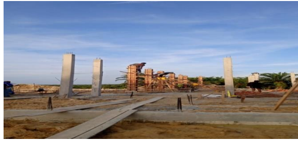
Gambar 3. 1 Pengecoran dan pembongkaran
