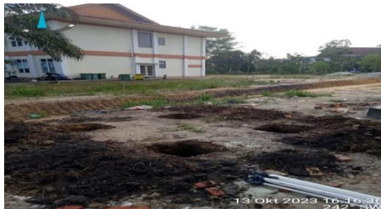
Gambar 3. 31 Pekerjaan galian tanah manara air
