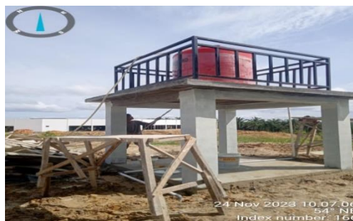
Gambar 3. 34 Pekerjaan pengecatan manara air
