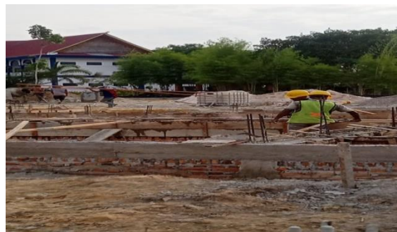
Gambar 3. 2 Pengecoran sloof
