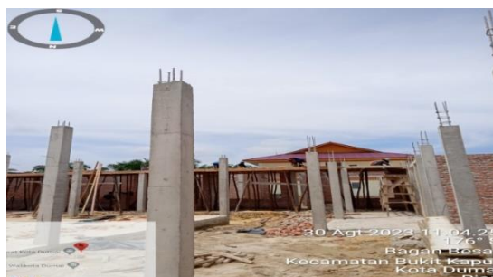
Gambar 3. 5 Pengecoran dan pembongkaran bekisting ring balok
