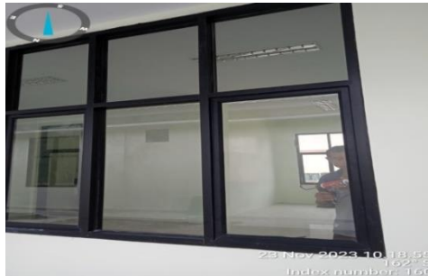
Gambar 3. 19 Pemaangan kaca jendela, pintu, dan vantilasi
