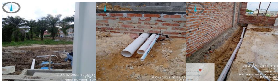
Gambar 3. 27 Pekerjaan pemasangan pipa
