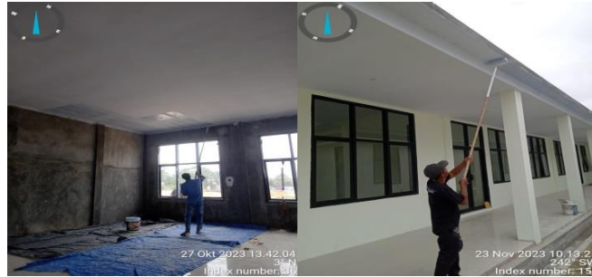
Gambar 3. 25 Pengecatan dinding dan plafond
