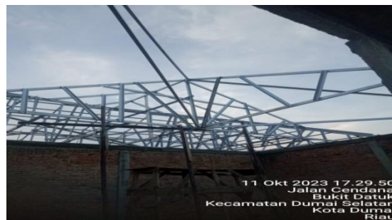
Gambar 3. 13 Rangka kuda-kuda baja ringan
