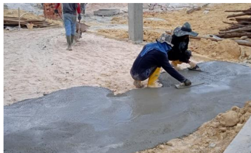
Gambar 3. 21 Pasir bawah lantai dan pengecoran lantai
