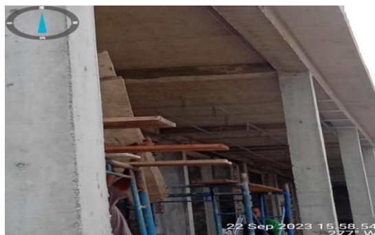
Gambar 3. 12 Pembongkaraan dak beton teras dalam
