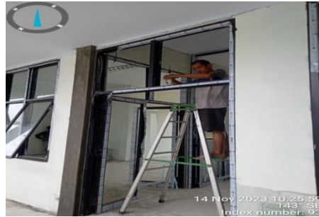
Gambar 3. 18 Pemasangan usen pintu, jendela dan ventilasi
