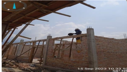
Gambar 3. 6 Pengecoran dan pembongkaran bekisting balok latei
