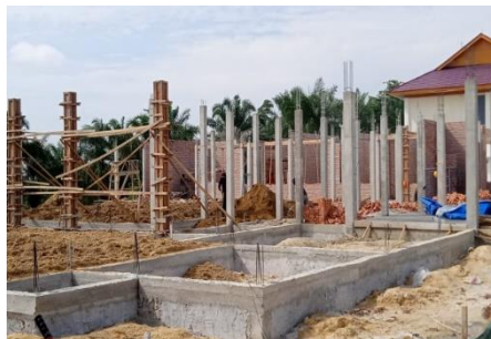
Gambar 3. 20 Urungan tanah bawah lantai
