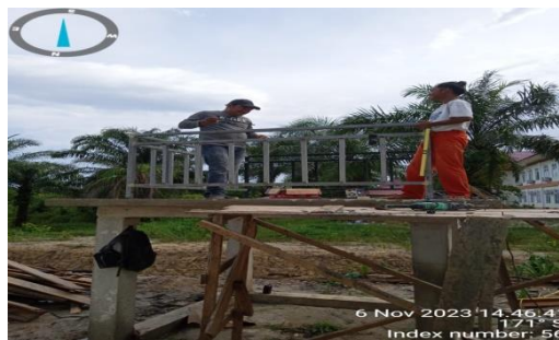
Gambar 3. 33 Pekerjaan pagar besi hollow pembatas
