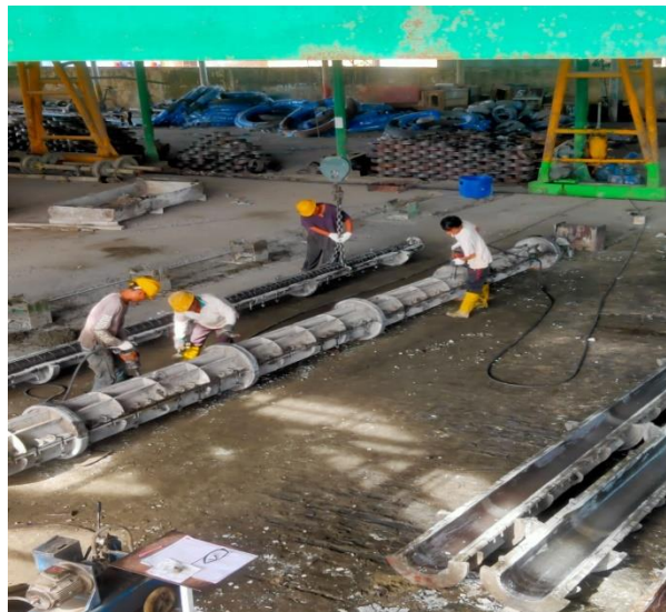
Gambar 3.22 Pemasangan tutup moulding
