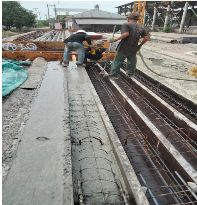
Gambar : 3.27 Tahap pengecoran squar pile
