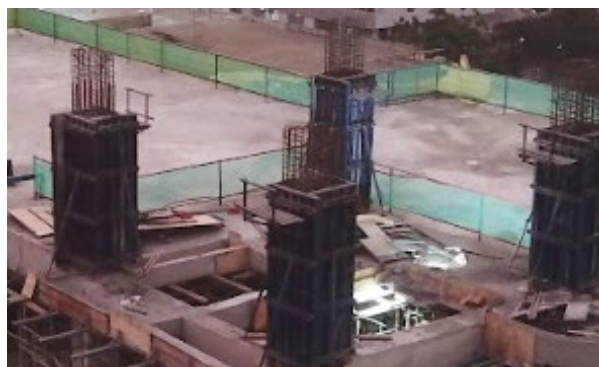
Gambar 3. 14 Pemasangan Bekisting Sumber : Dokumentasi Mingguan 2023
