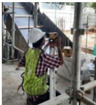
Gambar 3. 31 Waterpass Sumber : Dokumentasi Lapangan 2023
