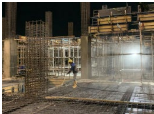
Gambar 3. 7 Proses Pembersihan Area Sumber : Dokumentasi Lapangan 2023
