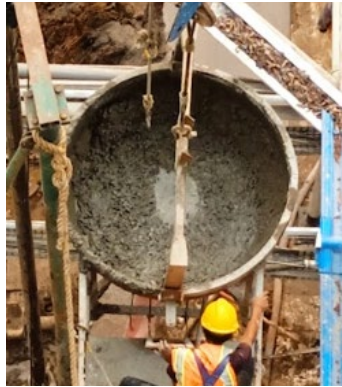
Gambar 3. 27 Concrete bucket Sumber : Dokumentasi Lapangan 2023
