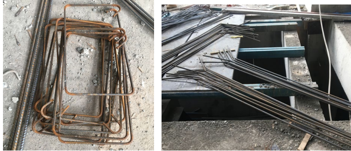
Gambar 3. 17 Pembesian Tangga Sumber : Dokumentasi Lapangan 2023
