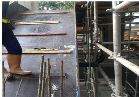
Gambar 3. 18 Bekisting Tangga Sumber : Dokumentasi Lapangan
