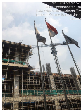
Gambar 3. 26 Scaffolding Sumber : Dokumentasi Lapangan 2023
