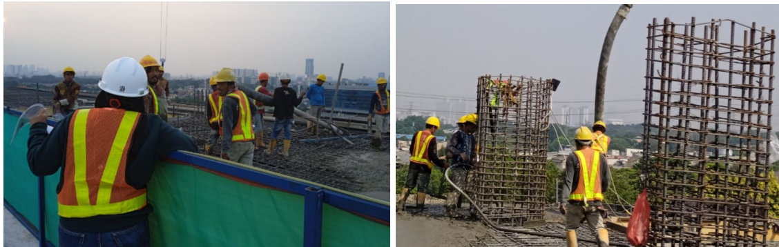
Gambar 3. 8 Proses Monitoring Pengecoran Sumber : Dokumentasi Lapangan 2023
