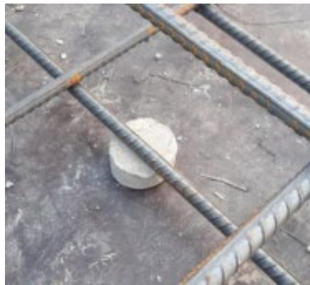
Gambar 3. 33 Tahu beton
