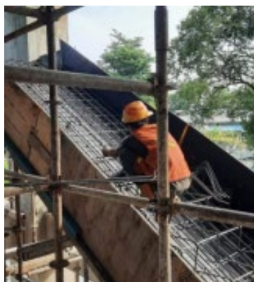
Gambar 3. 20 Proses Pemsangan Tulangan Sumber : Dokumentasi Lapangan 2023
