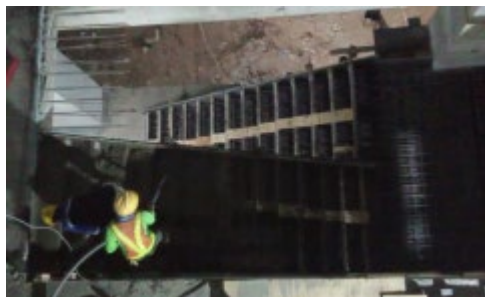
Gambar 3. 21 Pengecoran Tangga Sumber : Dokumentasi Lapangan 2023
