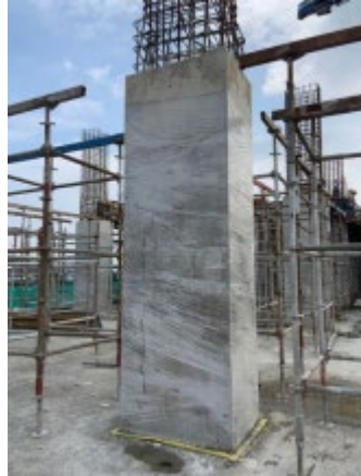
Gambar 3. 16 Perawatan Kolom Sumber : Dokumentasi Lapangan 2023
