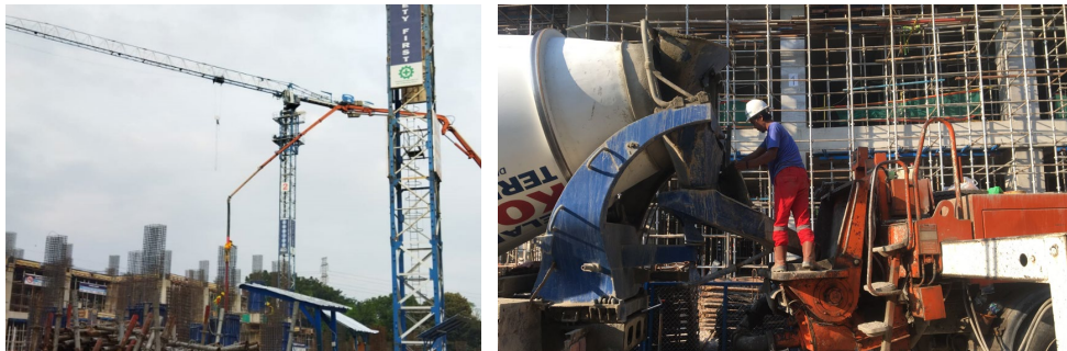
Gambar 3. 15 Proses Pengecoran Kolom Sumber : Dokumentasi Lapangan 2023
