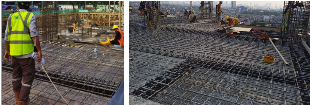
Gambar 3. 6 Proses Pemasangan Pembesian dan Elevasi Sumber : Dokumentasi Lapangan 2023
