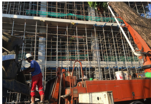
Gambar 3. 25 Concrete pump Sumber : Dokumentasi Lapangan 2023
