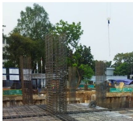
Gambar 3.12 Proses Pemasangan Tulangan Kolom Sumber : Dokumentasi Lapangan 2023
