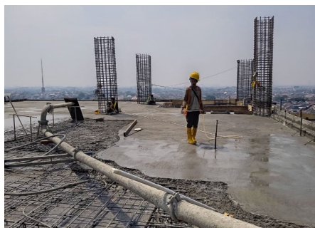
Gambar 3. 9 Perawatai Pelat Lantai Sumber : Dokumentasi Lapangan 2023
