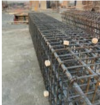
Gambar 3. 13 Pemasangan Tahu Beton Sumber : Dokumentasi Lapangan 2023
