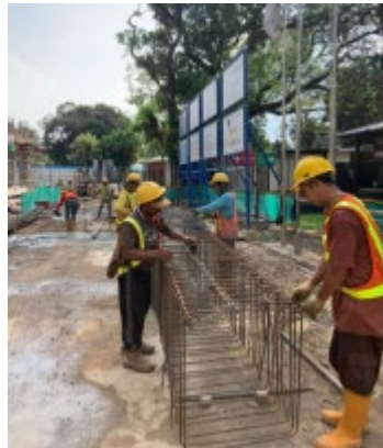
Gambar 3.11 Proses Pembesian Kolom Sumber : Dokumentasi Lapangan 2023
