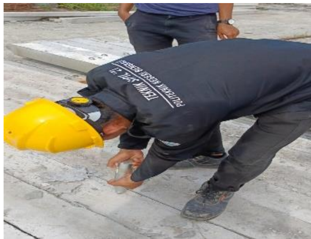
Gambar 3.16 Pengujian hammer test Sumber : Dokumen Lapangan, 2023
