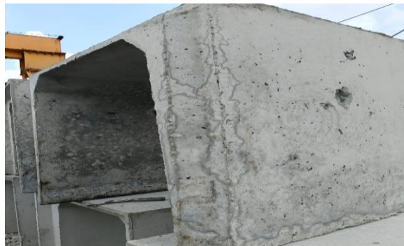
Gambar 3.21 Pembongkaran dari cetakan Sumber :Dokumen lapangan, 2023
