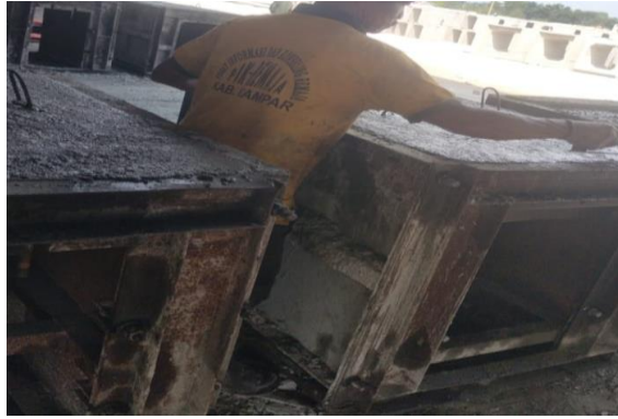
Gambar 3.20 Pengecoran U-dict Sumber :Dokumen lapangan, 2023
