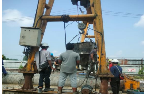
Gambar 3.26 Pengecoran mini pile Sumber :Dokumen lapangan, 2023
