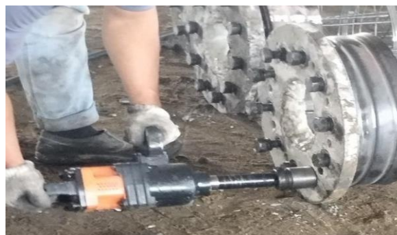
Gambar 3.42 setting tulangan spun pile Sumber : Dokumentasi lapangan,2023
