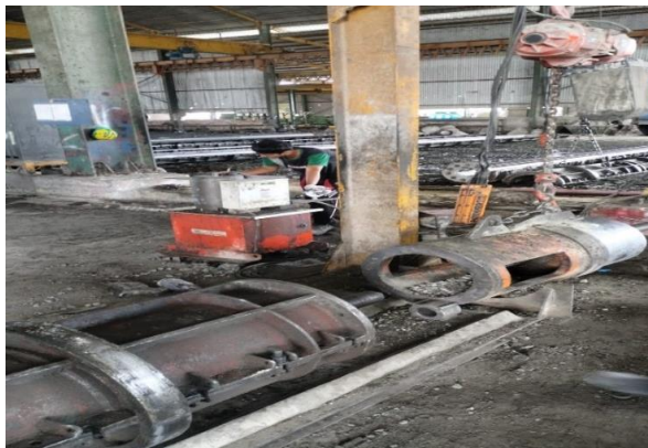
Gambar 3.46 Tahapan stressing spun pile Sumber : Dokumentasi lapangan, 2023
