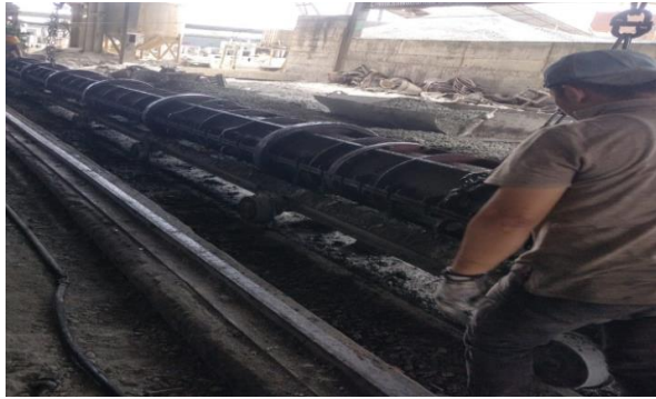
Gambar 3.45 Pemasangan tutup moulding Sumber : Dokumentasi lapangan, 2023
