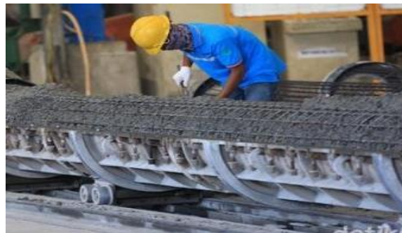
Gambar 3.44 Pengecoran spun pile Sumber : Dokumen lapangan, 2023
