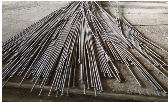
Gambar 3.24 Pematangan tulangan mini pile Sumber :Dokumen lapangan, 2023
