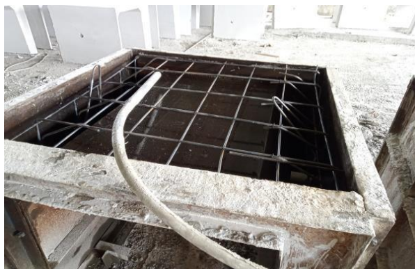
Gambar 3.19 memasukkan rangkaian ke cetakan Sumber :Dokumen lapangan, 2023
