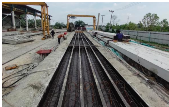
Gambar 3.25 Peletakan tulangan ke cetakan Sumber :Dokumen lapangan, 2023
