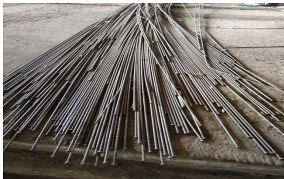
Gambar 3.30 Pemotongan besi tiang listrik Sumber :Dokumen lapangan, 2023
