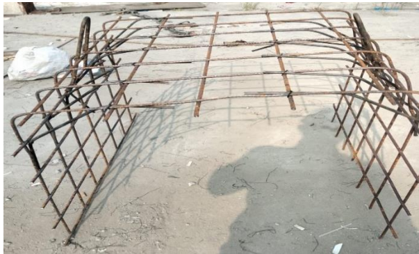
Gambar 3.18 Rangkaian tulangan U-dict Sumber :Dokumen lapangan, 2023
