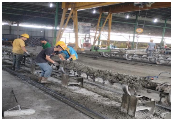
Gambar 3.32 Pengecoran tiang listrik Sumber :Dokumen lapangan, 2023
