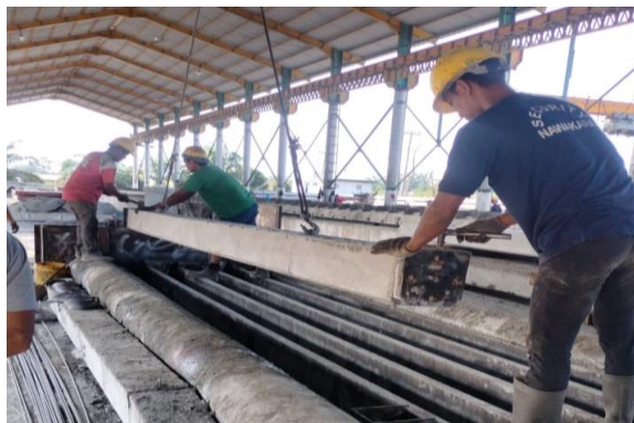
Gambar 3.27 Pembongkaran dari cetakan Sumber :Dokumen lapangan, 2023
