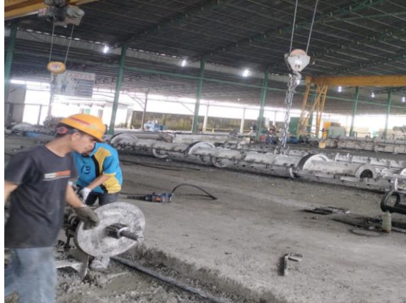
Gambar 3.33 Pemasangan tutup cetakan Sumber :Dokumen lapangan, 2023
