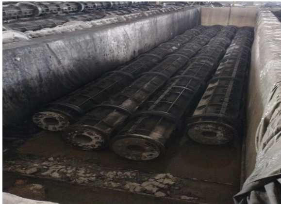
Gambar 3.36 Tahap Steam Curing Sumber :Dokumen lapangan, 2023
