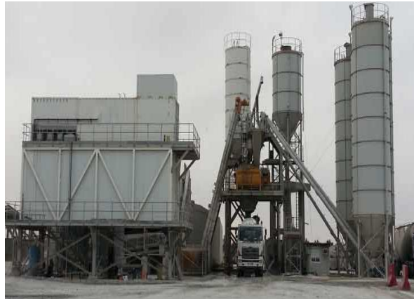
Gambar 3.51 Batching plant Sumber : Dokumentasi lapangan, 2023
