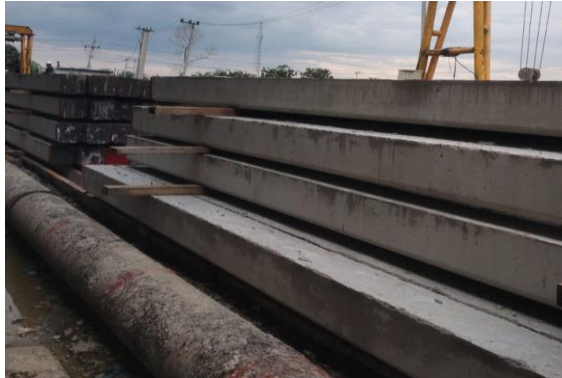
Gambar 3.29 Pengangkutan ke area stok mini pile Sumber :Dokumen lapangan, 2023
