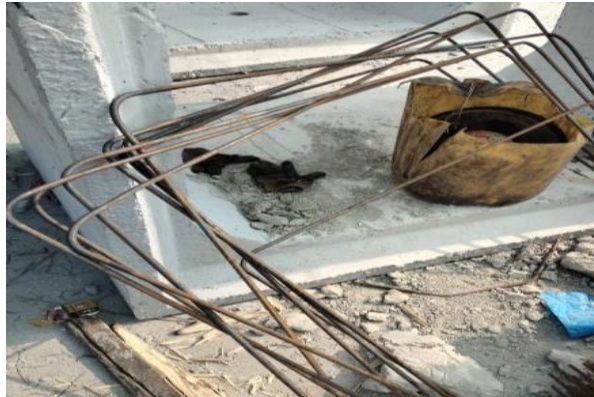
Gambar 3.17 Pemotongan tulangan U- dict Sumber :Dokumen lapangan, 2023
