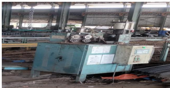
Gambar 3.40 Mesin Hidding Sumber : Dokumen lapangan, 2023
