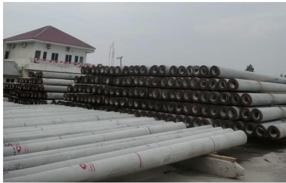
Gambar 3.50 Area stok spun pile Sumber : Dokumentasi lapangan, 2023
