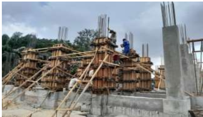
Gambar 3. 48 Pengecoran Kolom ( Sumber : Dokumentasi Lapangan 2023)
