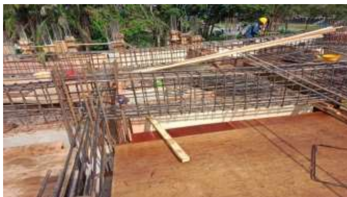
Gambar 3. 53 Pekerjaan Pembesian ( Sumber : Dokumentasi Lapangan 2023)
