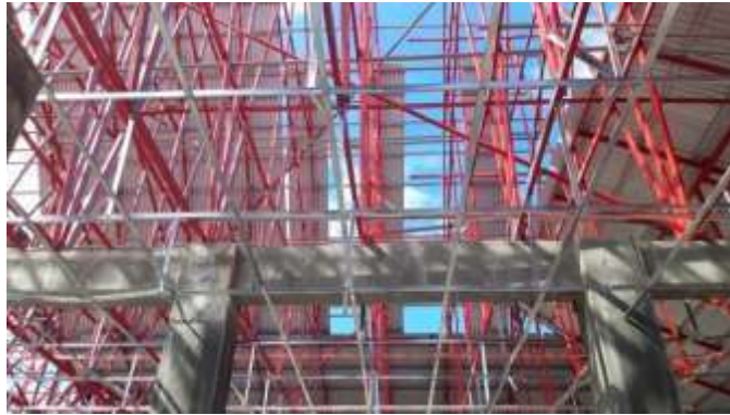
Gambar 3. 81 Pemasangan Atap ( Sumber : Dokumentasi Lapangan 2023)
