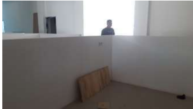
Gambar 3. 75 Pemasangan Dinding Partisi ( Sumber : Dokumentasi Lapangan 2023)
