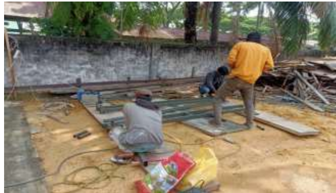
Gambar 3. 89 Pembuatan Rangka ACP ( Sumber : Dokumentasi Lapangan 2023)
