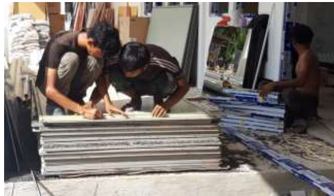
Gambar 3. 92 Pembuatan ACP ( Sumber : Dokumentasi Lapangan 2023)
