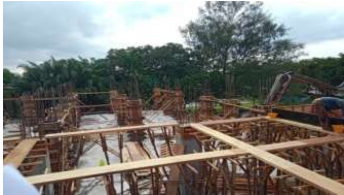
Gambar 3. 52 Pemasangan Bekisting Balok ( Sumber : Dokumentasi Lapangan 2023)
