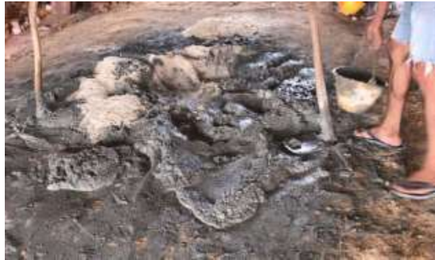
Gambar 3. 36 Proses Pembuatan Mortar ( Sumber : Dokumentasi Lapangan 2023)
