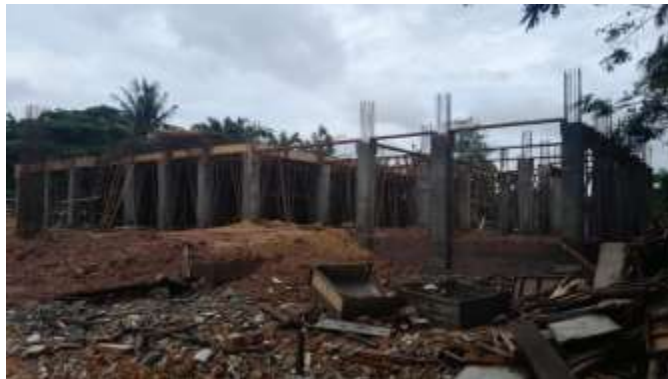
Gambar 3. 55 Pembongkaran Bekisting ( Sumber : Dokumentasi Lapangan 2023)
