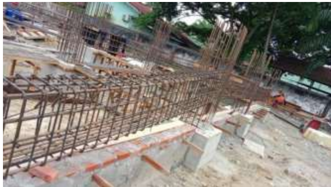
Gambar 3. 40 Pembesian Sloof ( Sumber : Dokumentasi Lapangan 2023)
