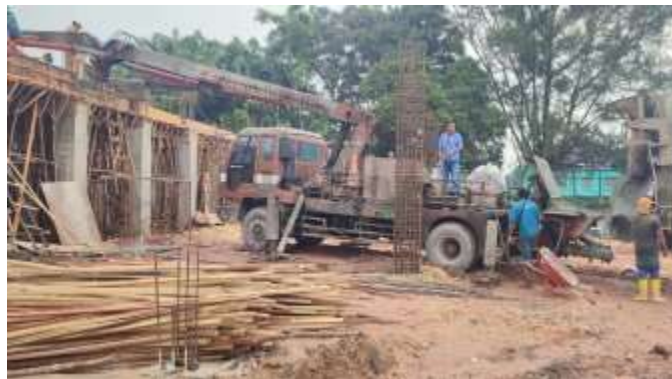
Gambar 3. 131 Concrete Pump ( Sumber : Dokumentasi Lapangan 2023)
