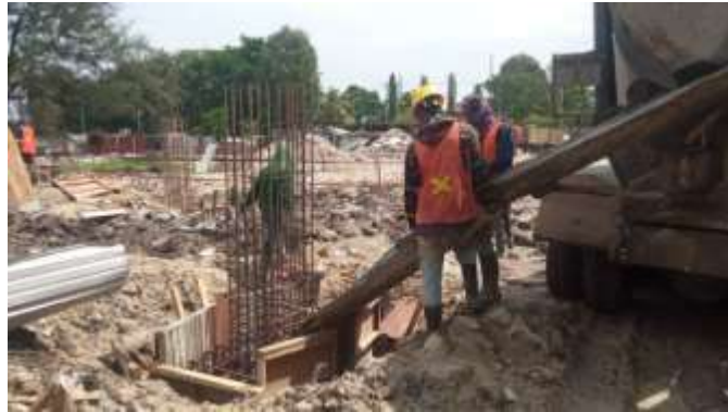
Gambar 3. 22 Proses Pengecoran ( Sumber : Dokumentasi Lapangan 2023)
