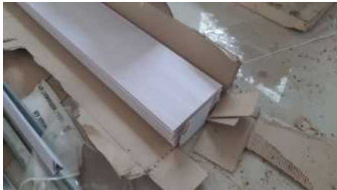
Gambar 3. 113 Plafond PVC ( Sumber : Dokumentasi Lapangan 2023)
