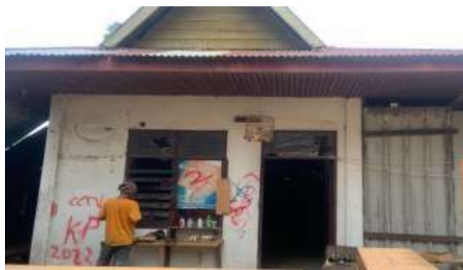
Gambar 3. 147 Direksi Keet ( Sumber : Dokumentasi Lapangan 2023)
