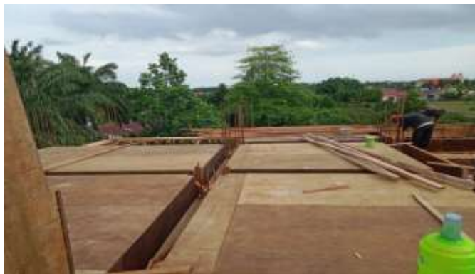
Gambar 3. 57 Pekerjaan Bekisting ( Sumber : Dokumentasi Lapangan 2023)
