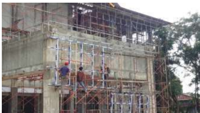
Gambar 3. 95 Pekerjaan rangka Curtainwall ( Sumber : Dokumentasi Lapangan 2023 )
