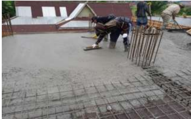
Gambar 3. 59 Pengecoran Plat Lantai ( Sumber : Dokumentasi Lapangan 2023)
