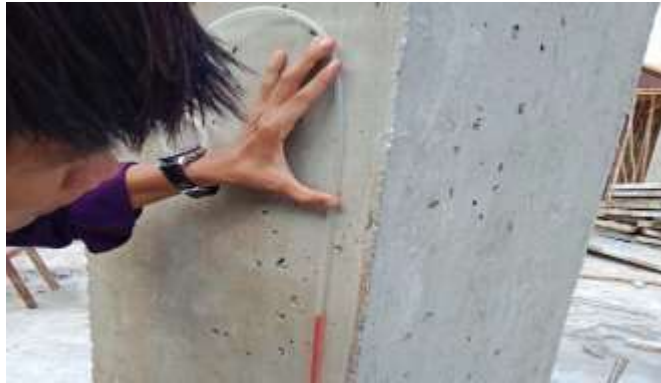
Gambar 3. 50 Proses Pengukuran ( Sumber : Dokumentasi Lapangan 2023)
