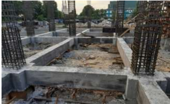
Gambar 3. 44 Pembongkaran Bekisting ( Sumber : Dokumentasi Lapangan 2023)
