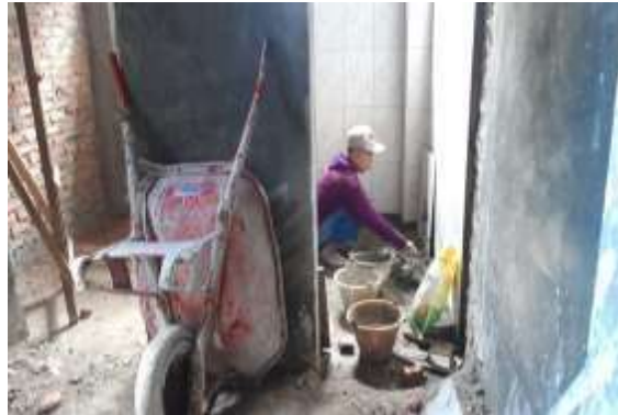
Gambar 3. 73 Pemasangan dinding Keramik ( Sumber : Dokumentasi Lapangan 2023)
