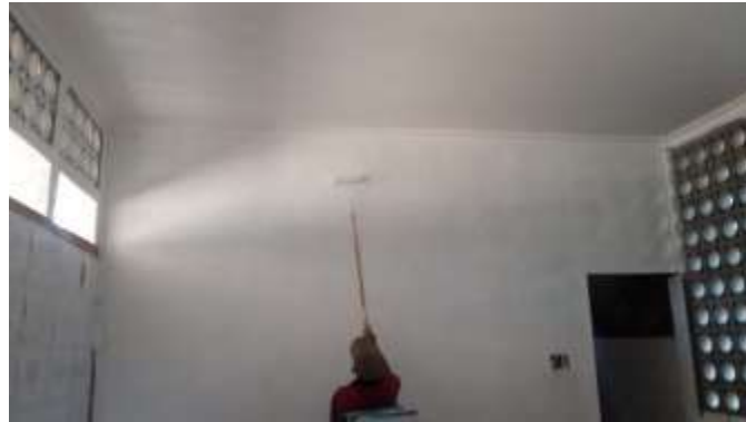
Gambar 3. 74 Pekerjaan Pengecatan ( Sumber : Dokumentasi Lapangan 2023)
