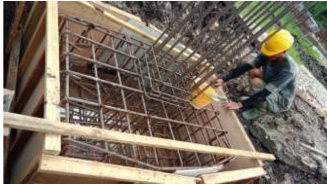
Gambar 3. 21 Proses Pamasangan Bekisting ( Sumber : Dokumentasi Lapangan 2023)
