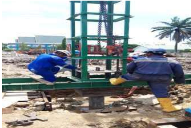
Gambar 3. 26 Proses Uji PDA Test (Sumber : Dokumentasi Lapangan 2023)
