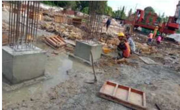
Gambar 3. 35 Proses Pembongkaran Bekisting ( Sumber : Dokumentasi Lapangan 2023)
