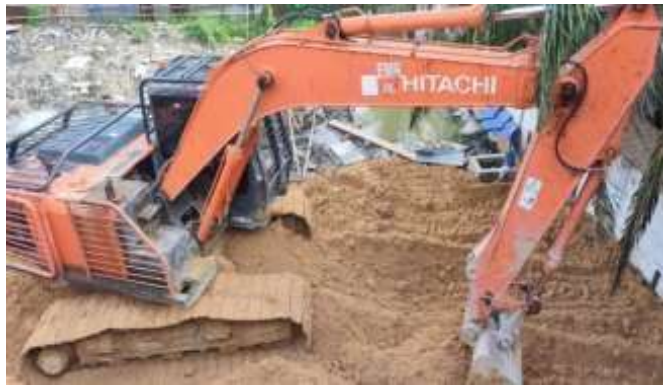
Gambar 3. 126 Excavator ( Sumber : Dokumentasi Lapangan 2023)
