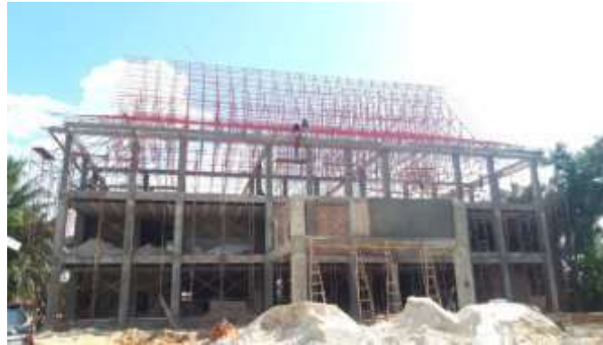
Gambar 3. 80 Pemasangan Reng Atap ( Sumber : Dokumentasi Lapangan 2023)
