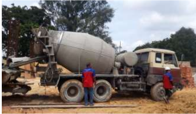
Gambar 3. 130 Truck Mixer ( Sumber : Dokumentasi Lapangan 2023)
