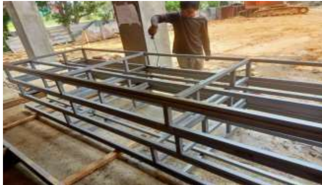
Gambar 3. 90 Pekerjaan Pengecetan ( Sumber : Dokumentasi Lapangan 2023)
