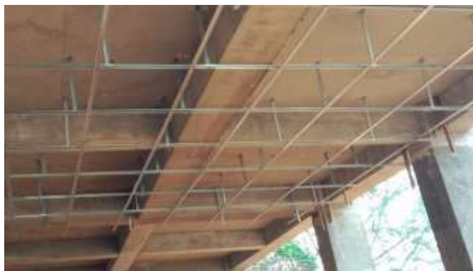
Gambar 3. 83 Pola Rangka Plafond ( Sumber : Dokumentasi Lapangan 2023)
