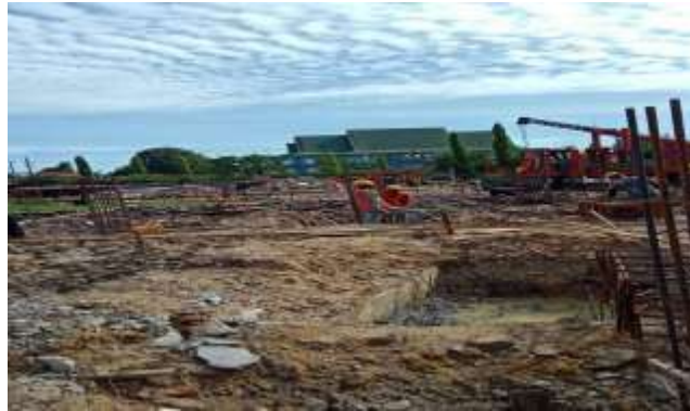
Gambar 3. 16 Proses Penggalian ( Sumber : Dokumentasi Lapangan 2023)
