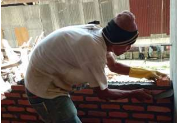
Gambar 3. 70 Pemasangan Batu Bata ( Sumber : Dokumentasi Lapangan 2023)
