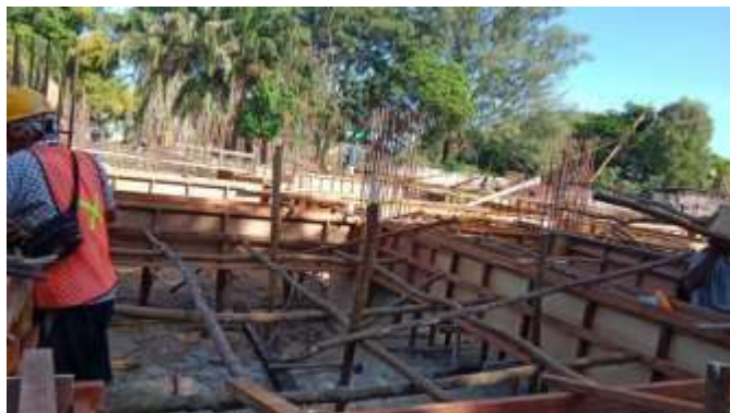
Gambar 3. 42 Pemasangan Bekisting ( Sumber : Dokumentasi Lapangan 2023)
