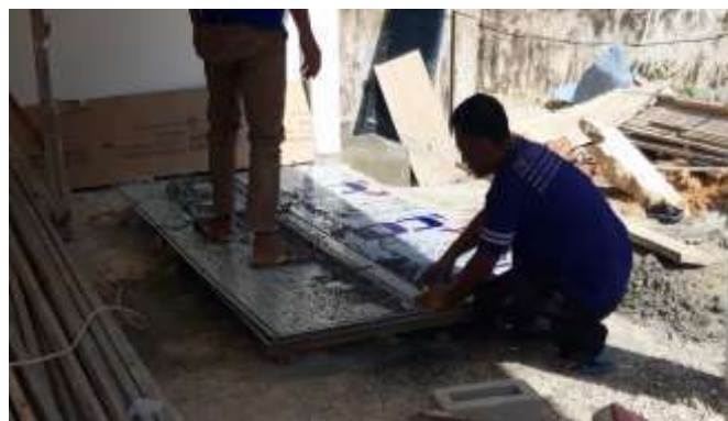
Gambar 3. 93 Pembuatan Pola pada ACP ( Sumber : Dokumentasi Lapangan 2023)
