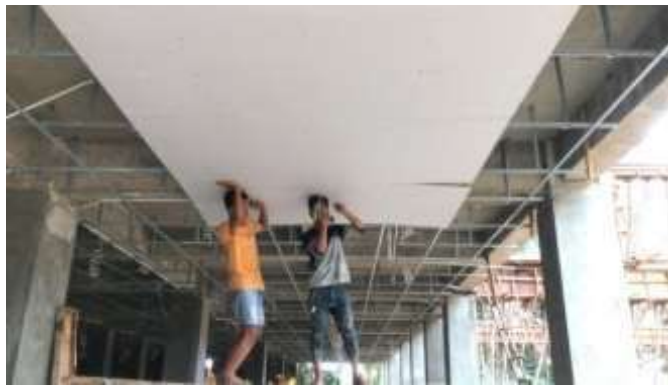
Gambar 3. 84 Pemasangan Plafond ( Sumber : Dokumentasi Lapangan 2023)
