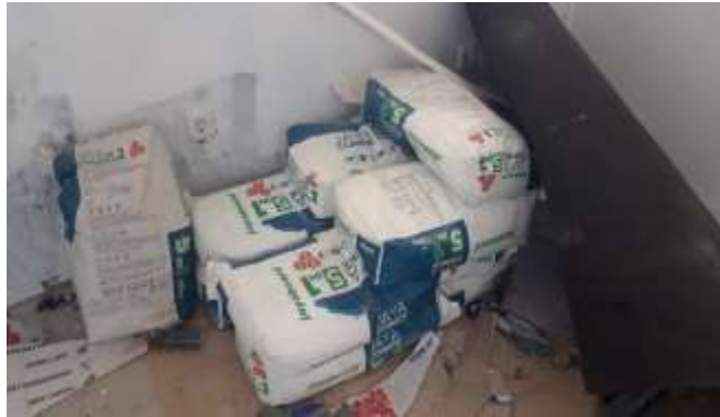
Gambar 3. 120 Compound Gypsum ( Sumber : Dokumentasi Lapangan 2023)
