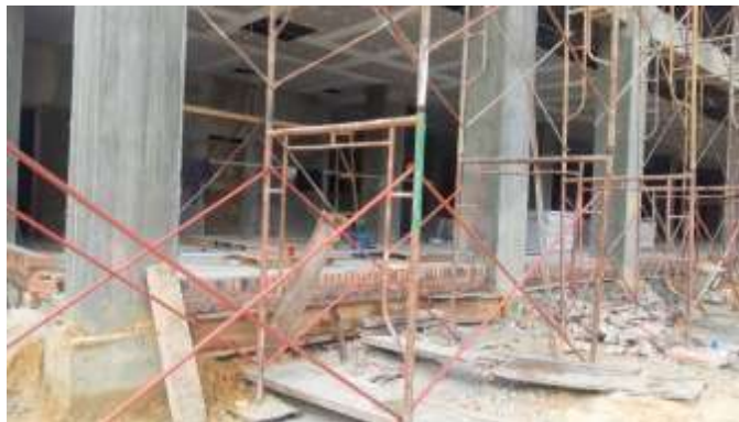
Gambar 3. 129 Scaffolding ( Sumber : Dokumentasi Lapangan 2023)
