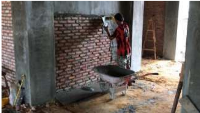
Gambar 3. 71 Pekerjaan Plasteran dinding ( Sumber : Dokumentasi Lapangan 2023)
