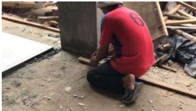
Gambar 3. 86 Pekerjaan Elevasi ( Sumber : Dokumentasi Lapangan 2023)
