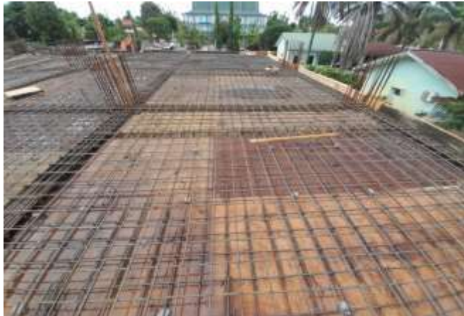
Gambar 3. 58 Penulangan Plat Lantai ( Sumber : Dokumentasi Lapangan 2023)
