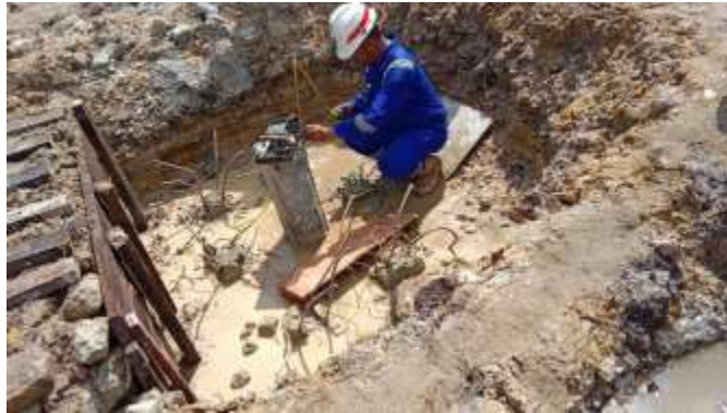
Gambar 3. 27 Proses Pengambilan Data Uji PDA Test ( Sumber : Dokumentasi Lapangan 2023)
