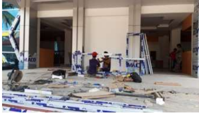
Gambar 3. 97 Perakitan Kusen Pintu ( Sumber : Dokumentasi Lapangan 2023)
