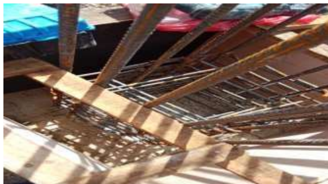
Gambar 3. 31 Tampak Pembesian Kolom Pedestal ( Sumber : Dokumentasi Lapangan 2023)
