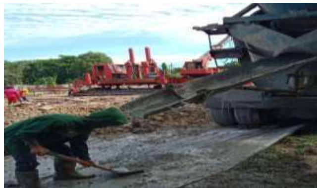
Gambar 3. 34 Proses Pengecoran Kolom Pedestal ( Sumber : Dokumentasi Lapangan 2023)
