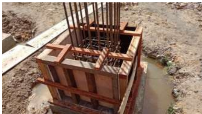
Gambar 3. 33 Tampak bekisting Kolom Pedestal ( Sumber : Dokumentasi Lapangan 2023)
