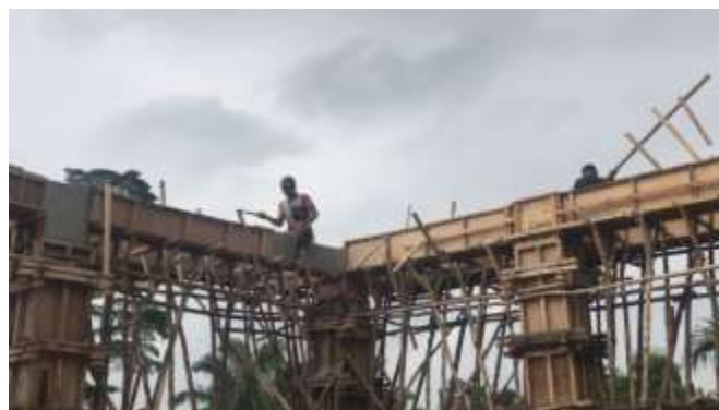
Gambar 3. 64 Pembongkaran Bekisting ( Sumber : Dokumentasi Lapangan 2023)
