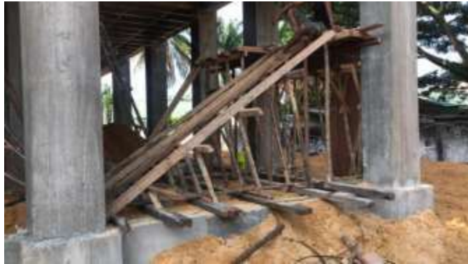
Gambar 3. 65 Pemasangan Bekisting Tangga ( Sumber : Dokumentasi Lapangan 2023)
