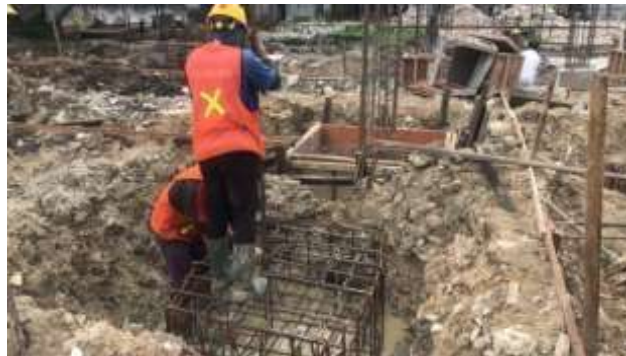
Gambar 3. 30 Proses Pembesian Kolom Pedestal ( Sumber : Dokumentasi Lapangan 2023)
