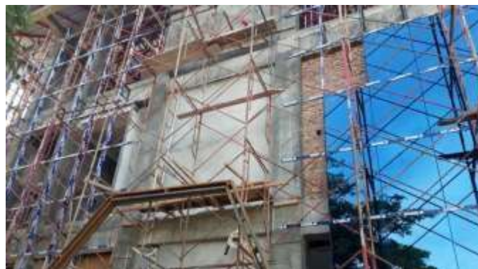
Gambar 3. 96 Pemasangan Kaca Oneway ( Sumber : Dokumentasi Lapangan 2023)
