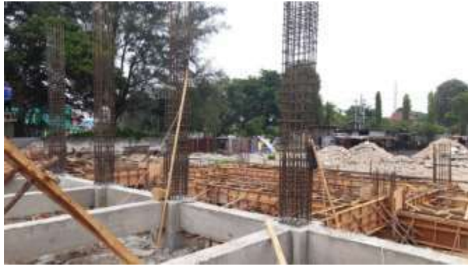
Gambar 3. 46 Proses Penulangan Kolom ( Sumber : Dokumentasi Lapangan 2023)
