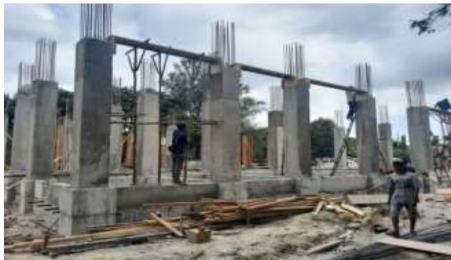
Gambar 3. 49 Pembongkaran Bekisting Kolom ( Sumber : Dokumentasi Lapangan 2023)
