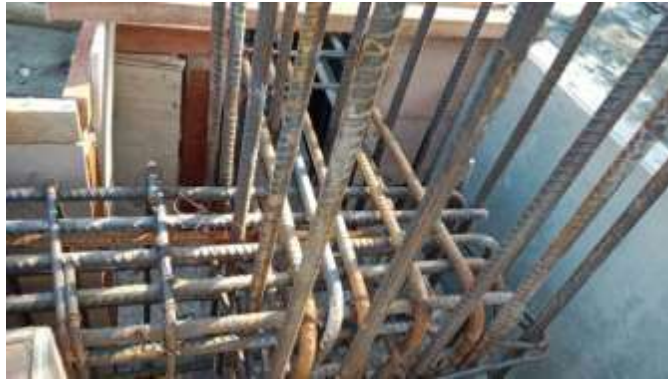
Gambar 3. 41 Detail Tulangan Balok sloof ( Sumber : Dokumentasi Lapangan 2023)
