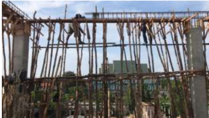
Gambar 3. 61 Pemasangan Bekisting ( Sumber : Dokumentasi Lapangan 2023)
