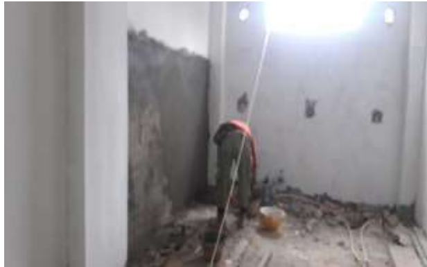
Gambar 3. 72 Pekerjaan Acian ( Sumber : Dokumentasi Lapangan 2023)
