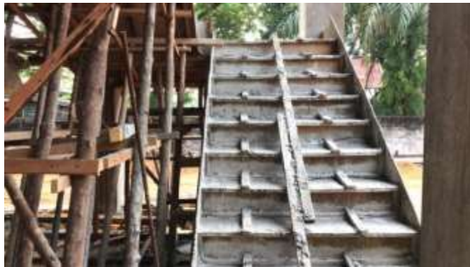
Gambar 3. 67 Hasil Pengecoran ( Sumber : Dokumentasi Lapangan 2023)
