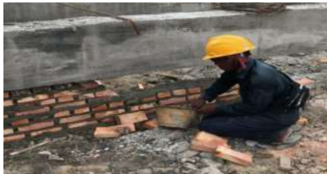
Gambar 3. 37 Pemasangan Batu bata ( Sumber : Dokumentasi Lapangan 2023)
