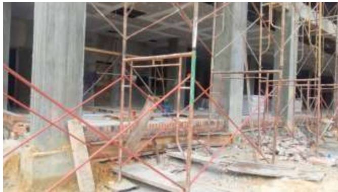
Gambar 3. 91 Pemasangan Scaffolding ( Sumber : Dokumentasi Lapangan 2023)
