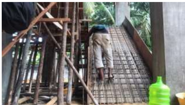
Gambar 3. 66 Pekerjaan Pembesian ( Sumber : Dokumentasi Lapangan 2023)
