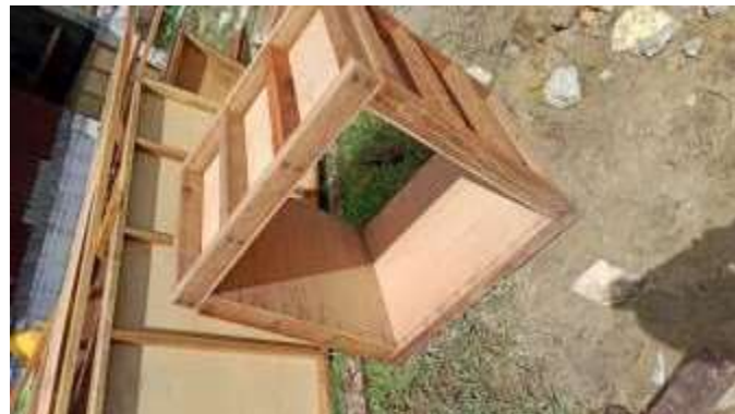
Gambar 3. 20 Bentuk Bekisting Pile Cap ( Sumber : Dokumentasi Lapangan 2023
