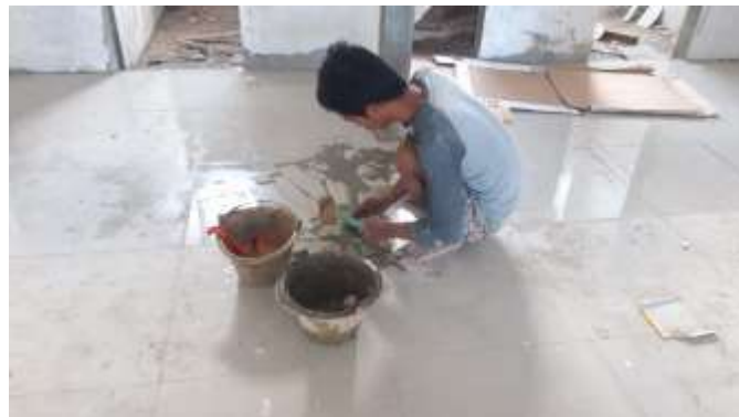
Gambar 3. 88 Pekerjaan Penyelesaian ( Sumber : Dokumentasi Lapangan 2023)
