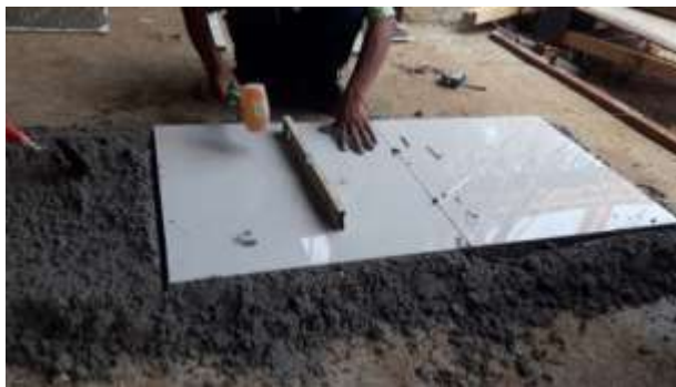
Gambar 3. 87 Pemasangan Granit ( Sumber : Dokumentasi Lapangan 2023)
