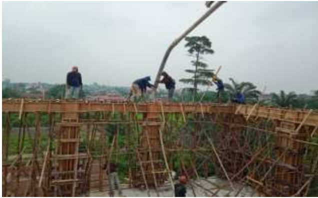
Gambar 3. 63 Pengecoran Reng Balok ( Sumber : Dokumentasi Lapangan 2023)
