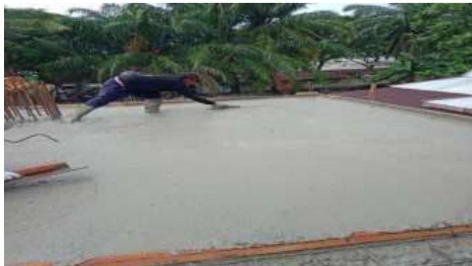
Gambar 3. 54 Pengecoran Balok ( Sumber : Dokumentasi Lapangan 2023)
