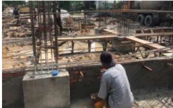
Gambar 3. 38 Pekerjaan Plasteran ( Sumber : Dokumentasi Lapangan 2023)
