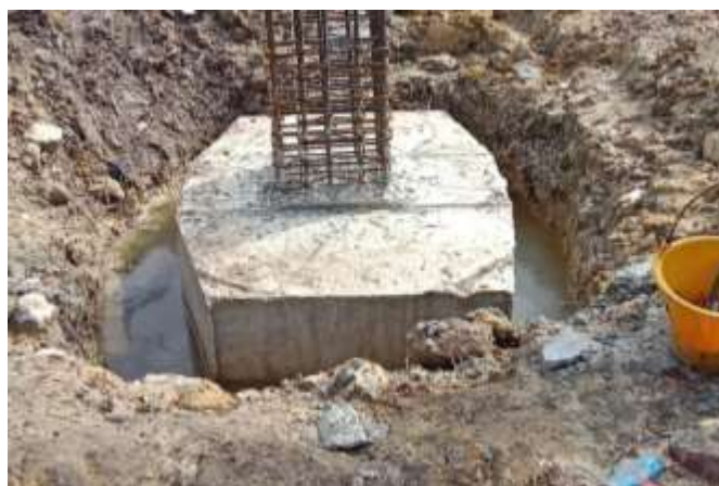
Gambar 3. 23 Pembongkaran Bekisting ( Sumber : Dokumentasi Lapangan 2023)
