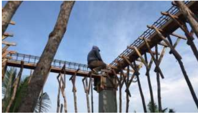
Gambar 3. 62 Pekerjaan Pembesian ( Sumber : Dokumentasi Lapangan 2023)
