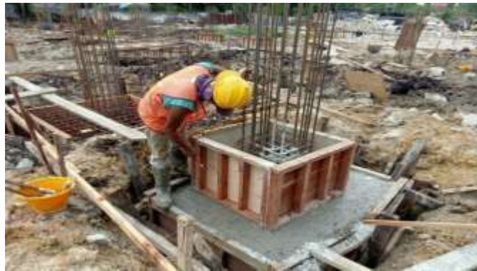
Gambar 3. 32 Pemasangan Bekisting ( Sumber : Dokumentasi Lapangan 2023)
