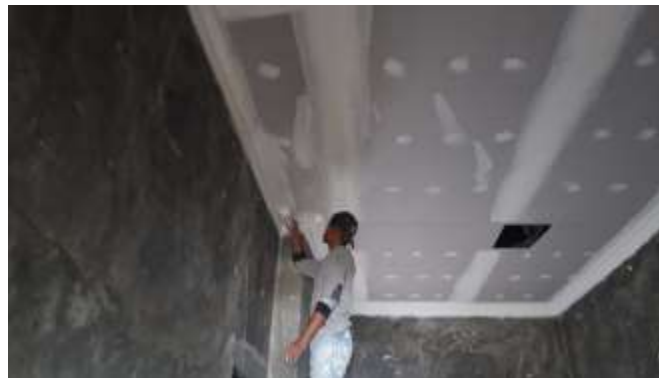
Gambar 3. 85 Pekerjaan Finishing ( Sumber : Dokumentasi Lapangan 2023)
