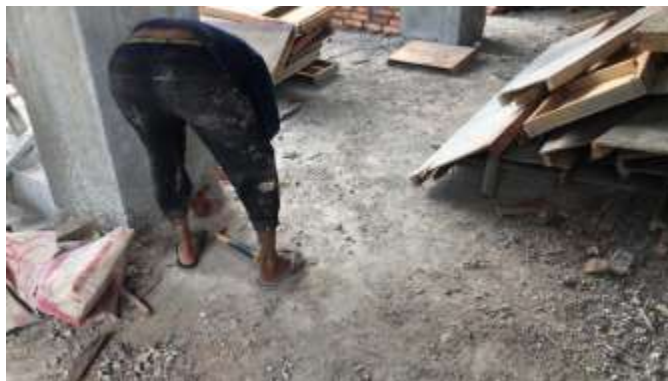
Gambar 3. 69 Pekerjaan Marking ( Sumber : Dokumentasi Lapangan 2023)
