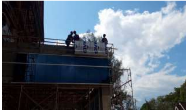
Gambar 3. 94 Pemasangan ACP ( Sumber : Dokumentasi Lapangan 2023)
