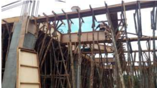
Gambar 3. 51 Pemasangan Perancah ( Sumber : Dokumentasi Lapangan 2023)
