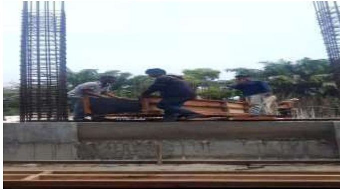
Gambar 3. 47 Pemasangan Beksiting kolom ( Sumber : Dokumentasi Lapangan 2023)
