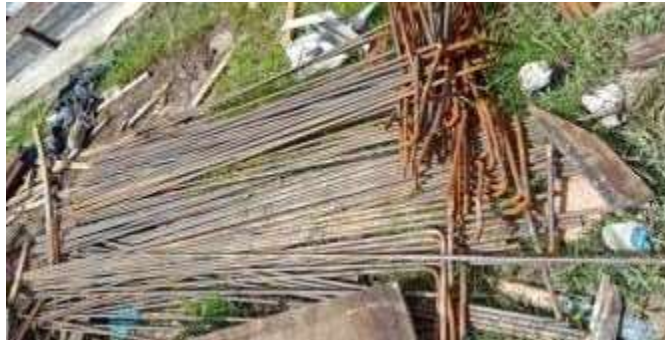
Gambar 3. 18 Besi Ulir ( Sumber : Dokumentasi Lapangan 2023)
