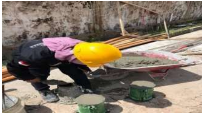
Gambar 3. 24 Proses Uji Slump ( Sumber : Dokumentasi Lapangan 2023)
