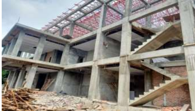
Gambar 3. 68 Hasil Pembongkaran Bekisting Tangga ( Sumber : Dokumentasi Lapangan 2023)
