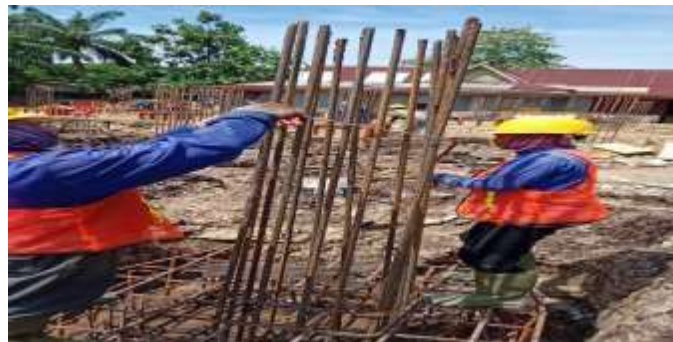
Gambar 3. 19 Proses Pemasangan tulangan Pile Cap ( Sumber : Dokumentasi Lapangan 2023)
