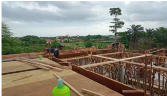
Gambar 3. 56 Pemasangan Perancah ( Sumber : Dokumentasi Lapangan 2023)
