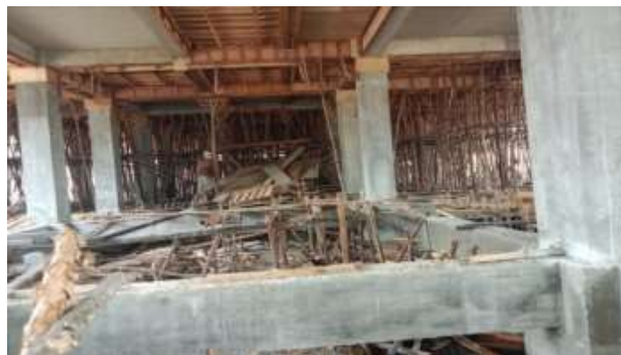
Gambar 3. 60 Pembongkaran Bekisting ( Sumber : Dokumentasi Lapangan 2023)
