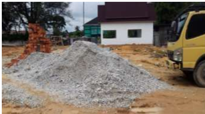
Gambar 3. 101 Material Agregat Kasar ( Sumber : Dokumentasi Lapangan 2023)
