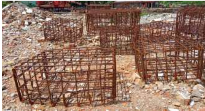
Gambar 3. 17 Bentuk Tulangan Pila Cap ( Sumber : Dokumentasi Lapangan 2023)
