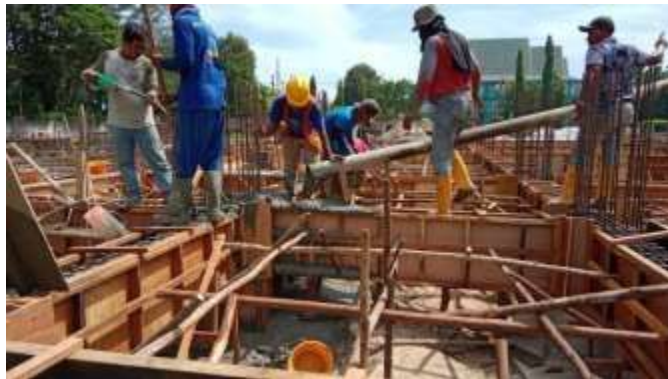
Gambar 3. 43 Proses Pengecoran Balok Sloof ( Sumber : Dokumentasi Lapangan 2023)
