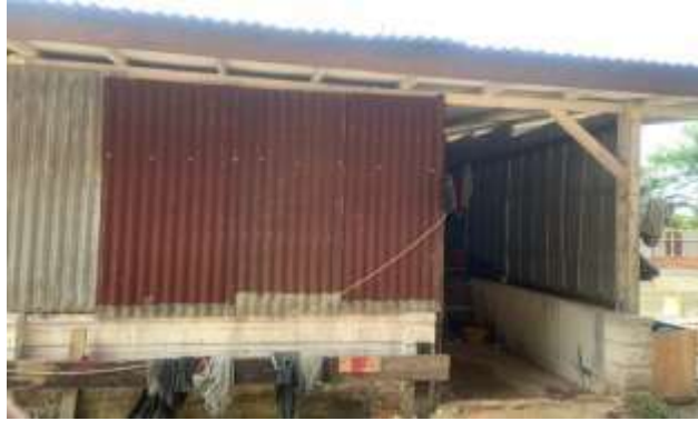
Gambar 3. 148 Kamar Pekerja ( Sumber : Dokumentasi Lapangan 2023)
