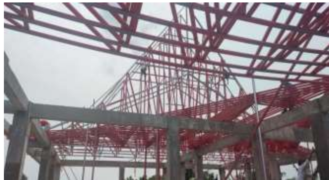
Gambar 3. 79 Pemasangan Kuda-Kuda Atap ( Sumber : Dokumentasi Lapangan 2023)
