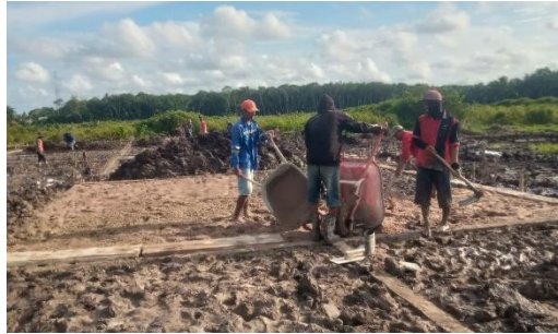
Gambar 3.16 Pekerjaan Urugan Pasir Sumber : Dokumentasi lapangan
