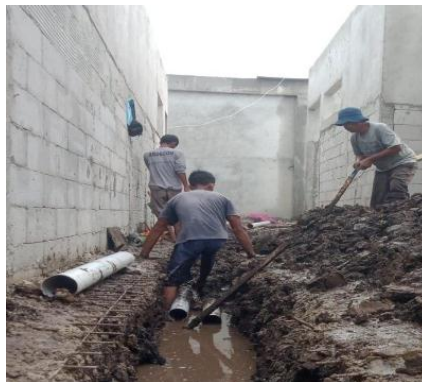
Gambar 3.40 Pekerjaan pemasangan pipa saluran air Sumber : Dokumentasi lapangan
