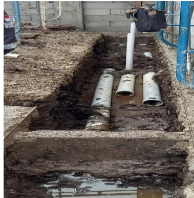
Gambar 3.41 Pekerjaan pemasangan pipa saluran air Sumber : Dokumentasi lapangan
