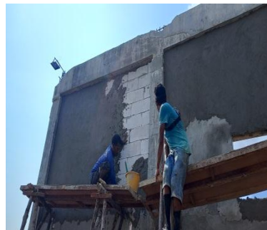
Gambar 3.37 Pekerjaan plesteran dinding Sumber : Dokumentasi lapangan
