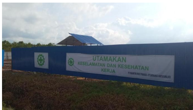
Gambar 3.8 Pemasangan pagar pengaman proyek Sumber : Dokumentasi Lapangan
