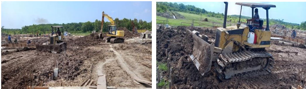
Gambar 3.5 Proses perataan jalan.
