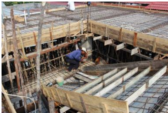
Gambar 3.29 Pekerjaan perakitan tulangan & bekisting tangga
