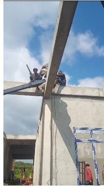
Gambar 3.35 Pekerjaan erection rangka baja Sumber : Dokumentasi lapangan
