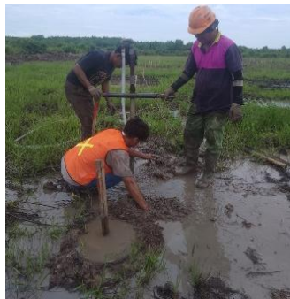
Gambar 3.11 Cleaning Sumber : Dokumentasi Proyek
