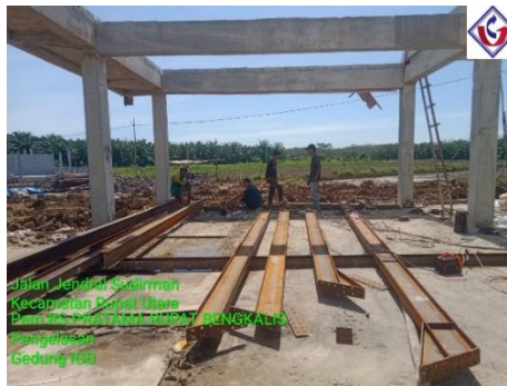
Gambar 3.33 Pekerjaan pengelasan sambungan baja Sumber : Dokumentasi lapangan
