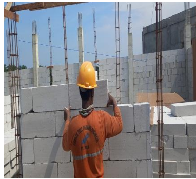
Gambar 3.36 Pekerjaan pemasangan dinding bata
