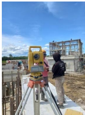
Gambar 3.31 Pembedikan perletakkan anker baja Sumber : Dokumentasi lapangan
