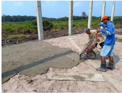
Gambar 3.17 Pekerjaan lantai kerja Sumber : Dokumentasi lapangan
