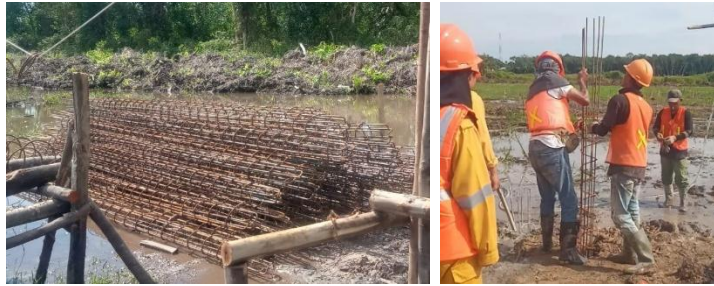
Gambar 3.12 Pemasangan Penulangan Strouss Pile Sumber : Dokumentasi Proyek
