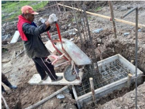
Gambar 3.20 Pengecoran pondasi pile cap
