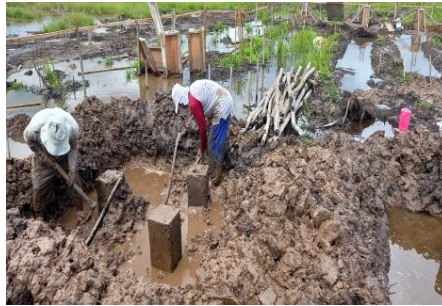
Gambar 3.14 Galian tapak pilecap Sumber : Dokumentasi lapangan
