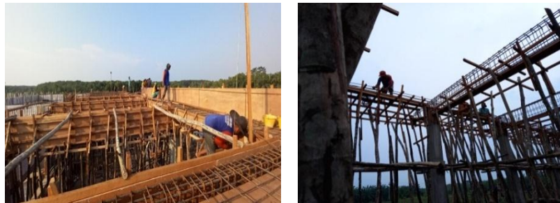
Gambar 3.25 Pekerjaan ring balok Sumber : Dokumentasi lapangan
