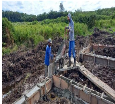
Gambar 3.21 Proses pekerjaan balok sloof Sumber : Dokumentasi lapangan
