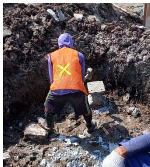
Gambar 3.15 Pemecahan kepala tiang pancang Sumber : Dokumentasi lapangan
