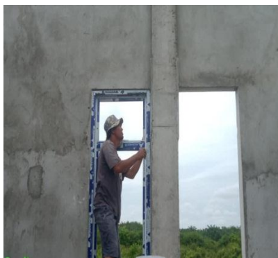
Gambar 3.39 Pemasangan kusen jendela Sumber : Dokumentasi lapangan
