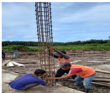
Gambar 3.22 Proses pemasangan penulangan kolom Sumber : Dokumentasi lapangan
