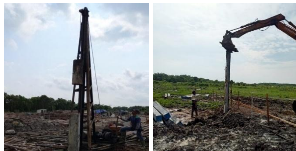
Gambar 3.13 Pekerjaan pemancangan tiang pancang Sumber : Dokumentasi lapangan
