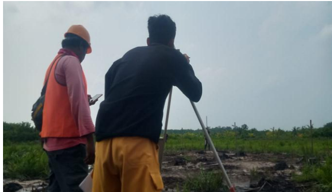
Gambar 3.6 Survey Pemasangan Bouwplank Sumber : Dokumentasi lapangan
