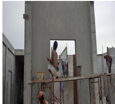
Gambar 3.38 Pekerjaan acian Sumber : Dokumentasi lapangan
