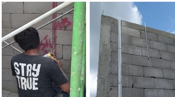
Gambar 3.42 Pekerjaan pembobokan & pemasangan pipa listrik Sumber : Dokumentasi lapangan
