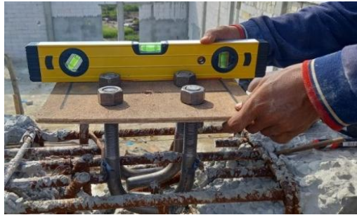
Gambar 3.32 Pekerjaan koreksi pemasangan anker Sumber : Dokumentasi lapangan
