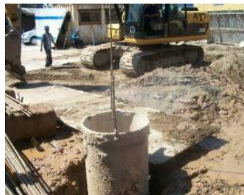
Gambar 3.9 Casing temporary Sumber : Dokumentasi Proyek
