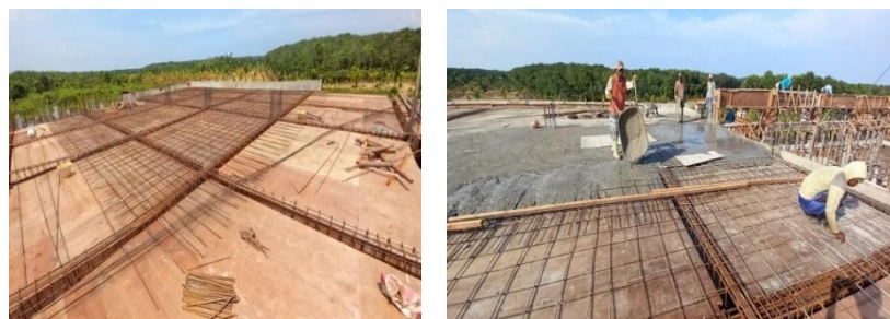
Gambar 3.26 Pekerjaan perakitan tulangan & pengecoran plat lantai Sumber : Dokumentasi lapangan
