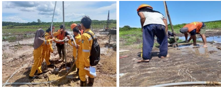
Gambar 3.10 Pengeboran Sumber : Dokumentasi Proyek
