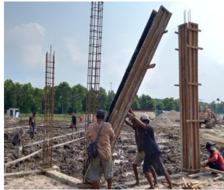
Gambar 3.23 Proses pemasangan bekisting kolom Sumber : Dokumentasi lapangan
