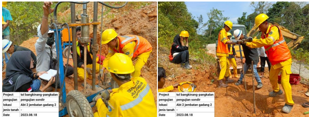
Gambar 3.9 Pengujian Sondir Dilapangan Sumber: Dokumentasi Kerja Praktek 2023
