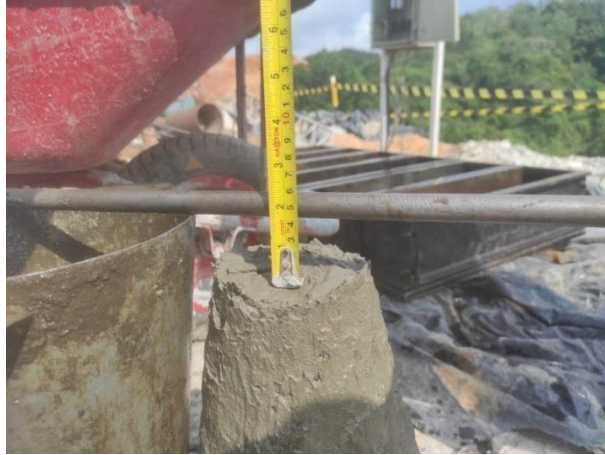
Gambar 3.13 Pengujian Slump Test Sumber: Dokumentasi Kerja Praktek 2023
