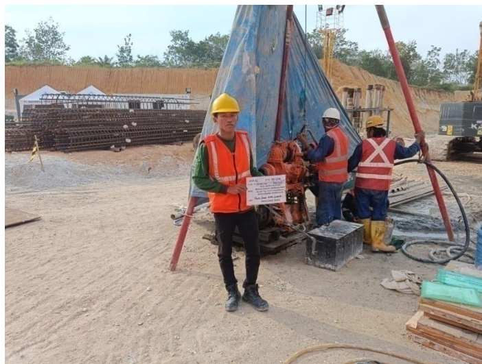
Gambar 3.8 pengujian boring test dilapangan Sumber: dokumentasi kerja praktek 2023
