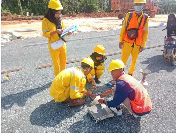
Gambar 3.7 Pengujian Sand Cone Lapangan Sumber: Dokumentasi Kerja Praktek 2023
