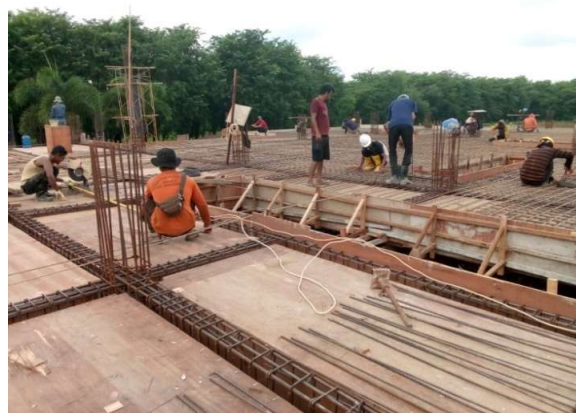
Gambar 3.30 pembesian plat lantai 2 Sumber: (Dokumentasi lapangan, 2023)
