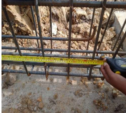
Gambar 3.22 pengukuran tulangan tumpuan lapangan Sumber:(Dokumentasi lapangan,2023)
