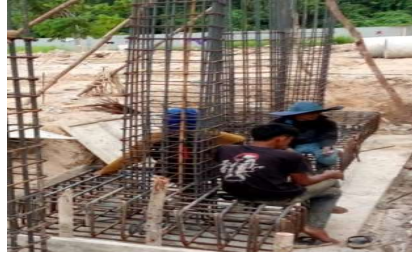
Gambar 3.14 Tulangan pile cap Sumber:(Dokumentasi lapangan,2023)
