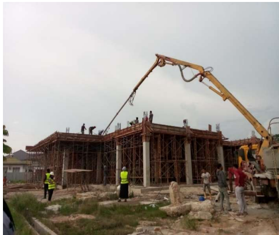
Gambar 3.34 pengecoran plat lantai 2 Sumber: (Dokumentasi lapangan, 2023)
