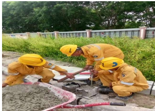
Gambar 3.23 penguji slump Sumber:(Dokumentasi lapangan,2023)
