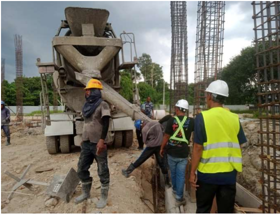
Gambar 3.26 pengecoran tie beam Sumber: (Dokumentasi lapangan, 2023)
