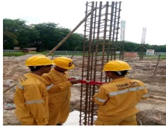
Gambar 3.17 pengukuran tie beam Sumber: (Dokumentasi lapangan, 2023)
