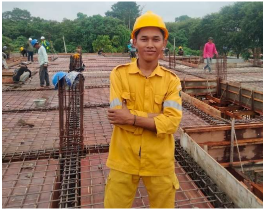
Gambar 3.32 pembesian plat lantai Sumber: (Dokumentasi lapangan, 2023)
