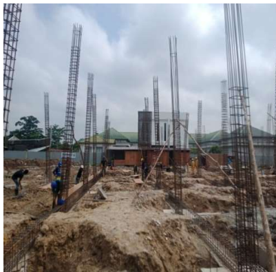
Gambar 3.21 pekerjaan tulangan tumpuan lapangan Sumber: (Dokumentasi lapangan, 2023)
