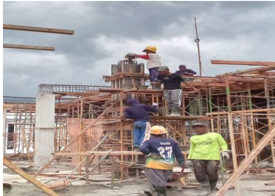
Gambar 3.29 pengecoran kolom lantai 2 Sumber: (Dokumentasi lapangan, 2023)
