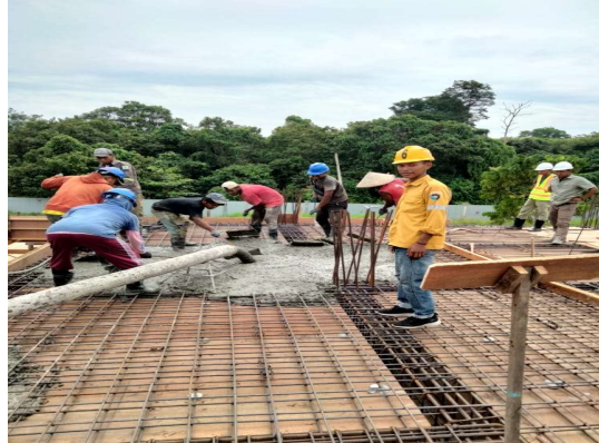
Gambar 3.33 pengecoran plat lantai 2 Sumber: (Dokumentasi lapangan, 2023)
