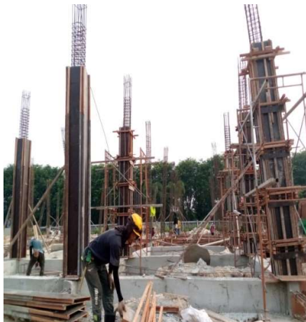
Gambar 3.27 bekisting kolom Sumber: (Dokumentasi lapangan, 2023)
