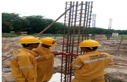
Gambar 3.16 pengukuran tie beam Sumber:(Dokumentasi lapangan,2023)
