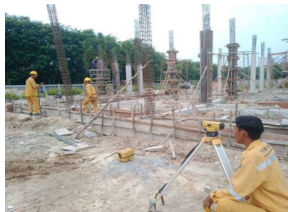
Gambar 3.19 pengukuran menentukan elevasi Sumber: (Dokumentasi lapangan, 2023)
