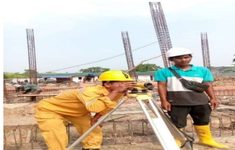
Gambar 3.18 pengukuran menentukan elevasi Sumber: (Dokumentasi lapangan, 2023)
