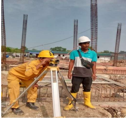
Gambar 3.20 pengukuran menentukan elevasi Sumber: (Dokumentasi lapangan, 2023)
