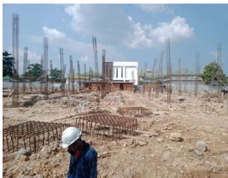
Gambar 3.13 Tulangan pile cap Sumber: (Dokumentasi lapangan, 2023)
