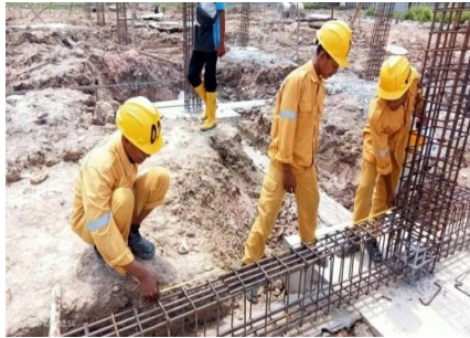
Gambar 3.15 pengukuran tie beam Sumber:(Dokumentasi lapangan,2023)
