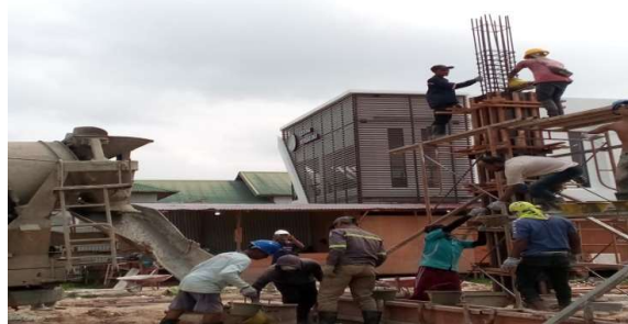
Gambar 3.28 pengecoran kolom Sumber: (Dokumentasi lapangan, 2023)
