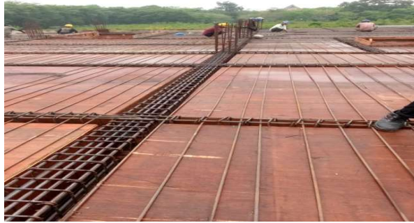
Gambar 3.31 pembesian plat lantai 2 Sumber: (Dokumentasi lapangan, 2023)
