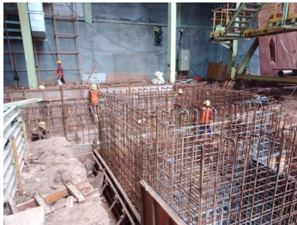
Gambar 2.3 Pemasangan tulangan pile cap elevator Sumber : Dokumentasi lapangan, 2023
