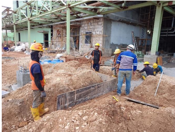
Gambar 2.8 Penimbunan Pondasi Slag Silo Sumber : Dokumentasi lapangan, 2023
