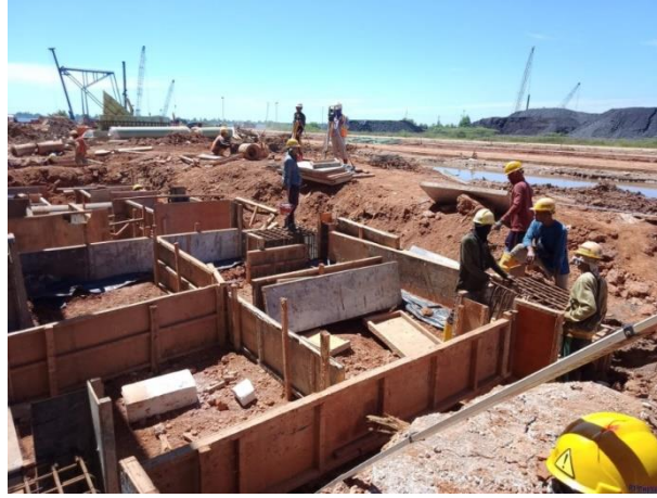
Gambar 2.6 Pemasangan Bekisting Pondasi Slag Silo Sumber : Dokumentasi lapangan, 2023
