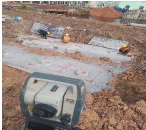
Gambar 3.10 Marking as pilecap dan kolom pedestal Sumber : Dokumentasi Proyek, 2023
