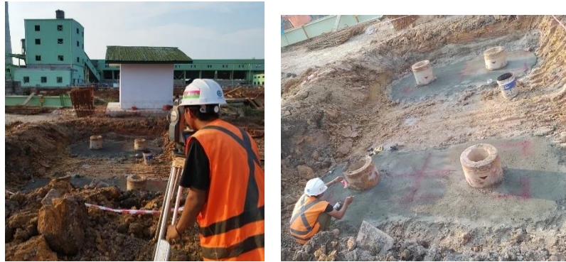
Gambar 3.9 Marking land concrete Sumber : Dokumentasi Proyek, 2023
