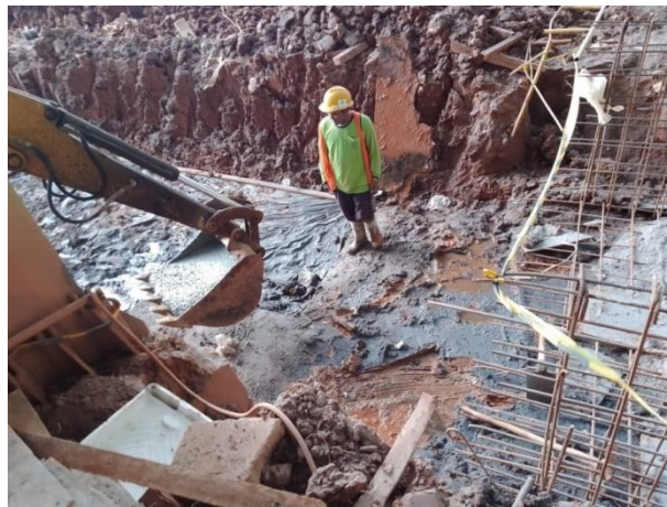
Gambar 2.7 Pengecoran Slab Slag Ditch Sumber : Dokumentasi lapangan, 2023
