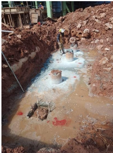
Gambar 2.17 Pemotongan Tiang Pancang Id Fan Of Boiler#2 Sumber : Dokumentasi lapangan, 2023
