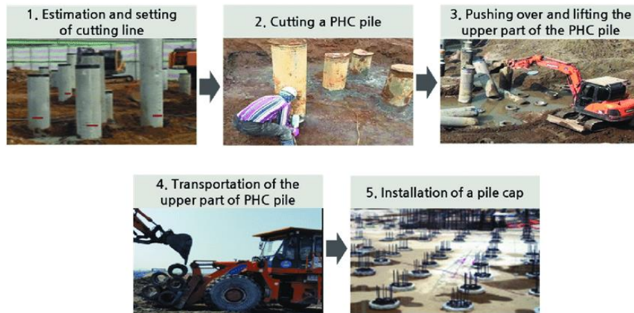
Gambar 3.8 Proses pemasangan tiang pancang Sumber : Google, 2023
