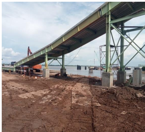
Gambar 3.20 MI trastle yang telah jadi Sumber : Dokumentasi Proyek, 2023
