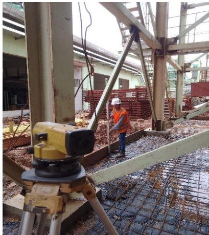
Gambar 2.11 Marking Top Cor Lantai ESP#2 Sumber : Dokumentasi lapangan, 2023
