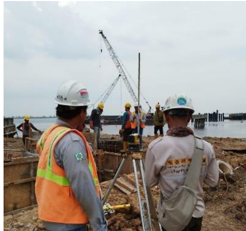
Gambar 3.11 Marking top cor dan pengecoran kolom pedestal Sumber : Dokumentasi Proyek, 2023
