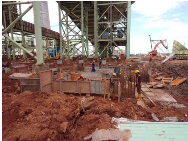
Gambar 2.5 Pemasangn bekisting slag transmission station Sumber : Dokumentasi lapangan, 2023
