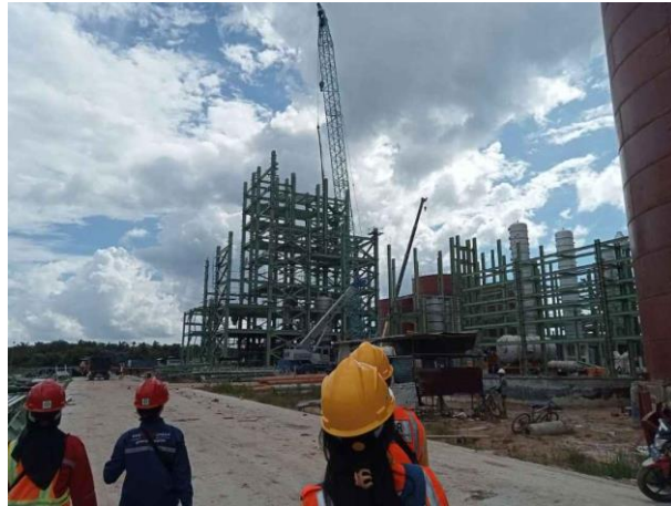
Gambar 3.6 Inspeksi area proyek Sumber : Dokumentasi Proyek, 2023
