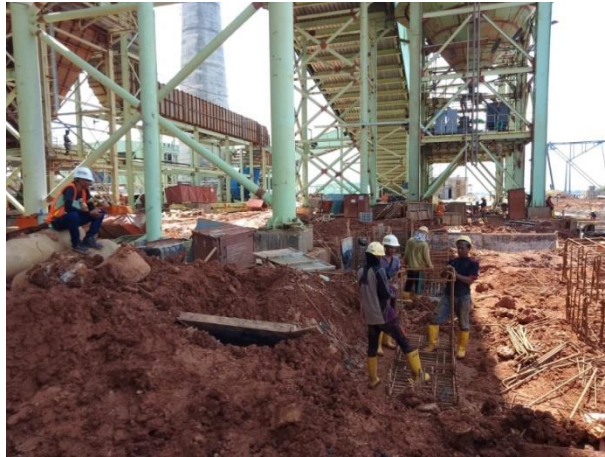
Gambar 2.4 Pemasangan tulangan pedestal slag transmission station Sumber : Dokumentasi lapangan, 2023
