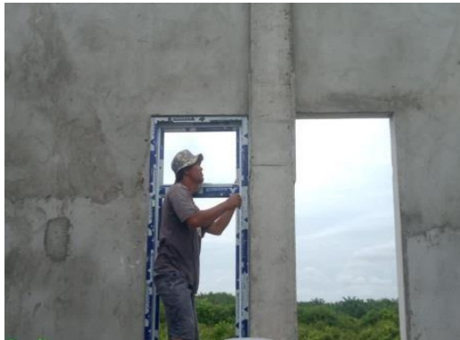
Gambar 3. 43 pemasangan kusen jendela (Sumber): Dokumentasi Lapangan 2023
