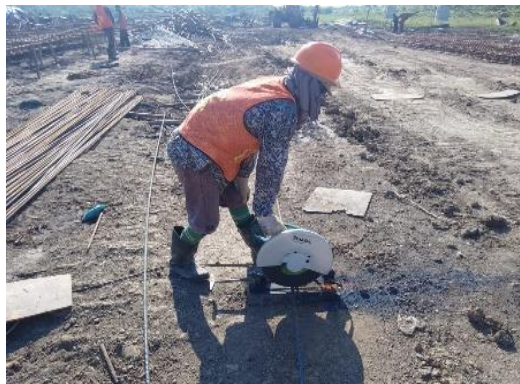
Gambar 3. 5 Pekerja Memotong Tulangan Utama (Sumber): Dokumentasi Lapangan 2023
