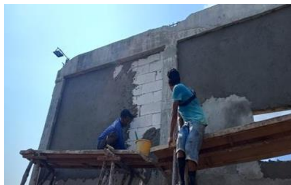
Gambar 3. 44 pelasteran dinding (Sumber): Dokumentasi Lapangan 2023
