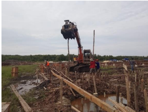
Gambar 3. 20 Excavator sedang menanamkan cerocok (Sumber): Dokumentasi Lapangan 2023
