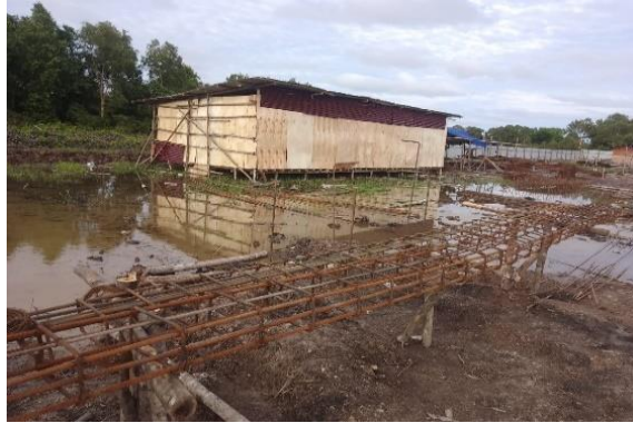
Gambar 3. 23 Tulangan Sloof (Sumber): Dokumentasi Lapangan 2023
