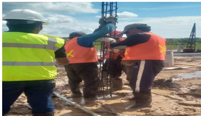
Gambar 3. 10 Proses Pemasukan Tulangan (Sumber): Dokumentasi Lapangan 2023
