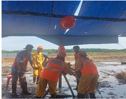
Gambar 3. 6 Pembuatan Tulangan Spiral (Sumber): Dokumentasi Lapangan 2023
