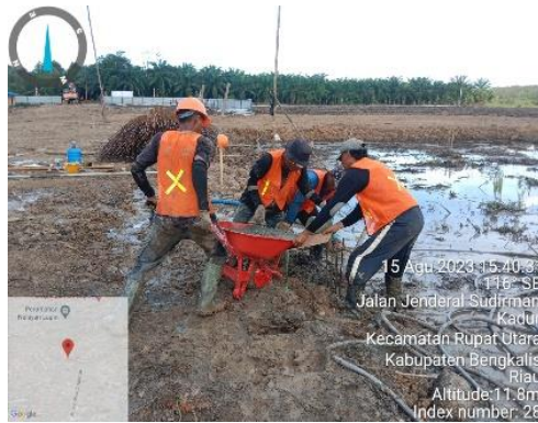
Gambar 3. 11 Pengecoran Strauss Pile (Sumber): Dokumentasi Lapangan 2023
