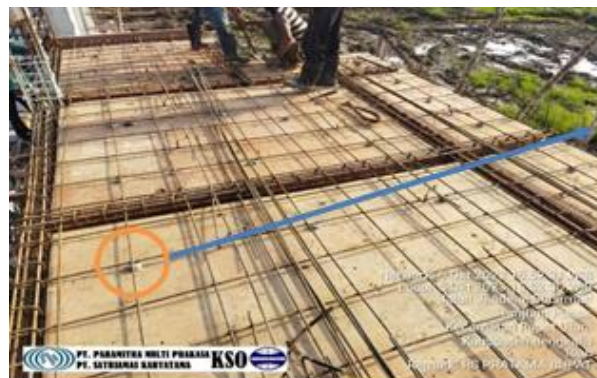
Gambar 3. 41 tulangan plat lantai (Sumber): Dokumentasi Lapangan 2023
