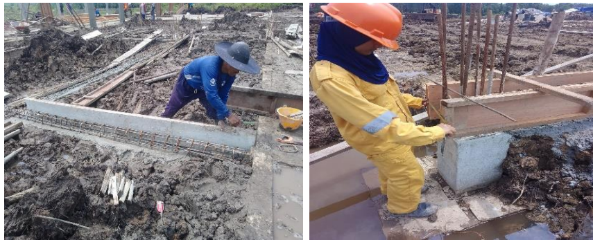
Gambar 3. 25 pemasangan bekisting (Sumber): Dokumentasi Lapangan 2023
