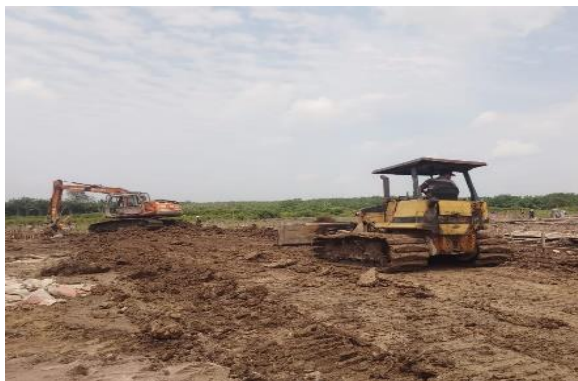
Gambar 3. 3 Membuat Akses Jalan (Sumber): Dokumentasi Lapangan 2023
