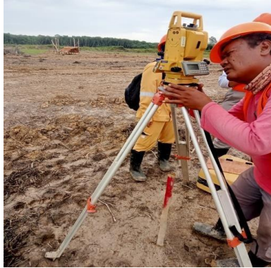
Gambar 3. 34 proses marking (Sumber): Dokumentasi Lapangan 2023
