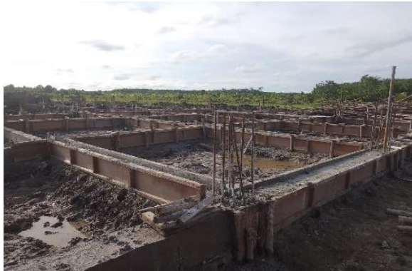
Gambar 3. 26 Hasil Pengecoran sloof (Sumber): Dokumentasi Lapangan 2023
