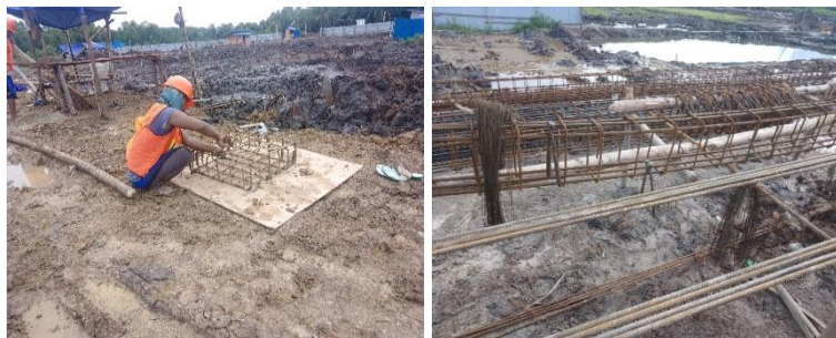
Gambar 3. 15 Penulangan Pile Cap dan Kolom Pedestal (Sumber): Dokumentasi Lapangan 2023
