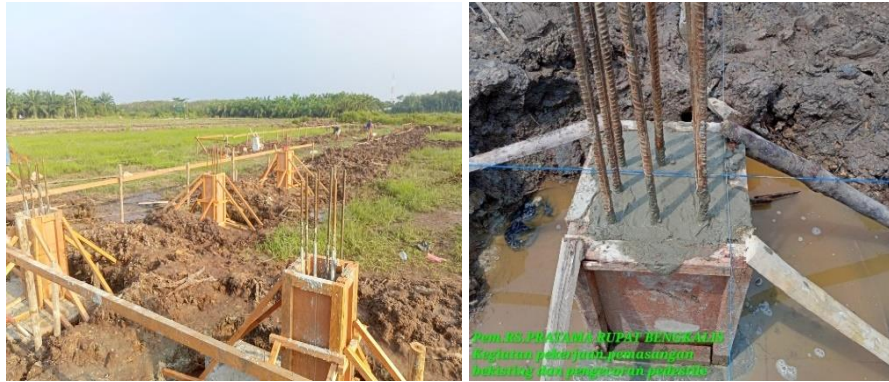
Gambar 3. 19 pengecoran kolom pedesatal (Sumber): Dokumentasi Lapangan 2023
