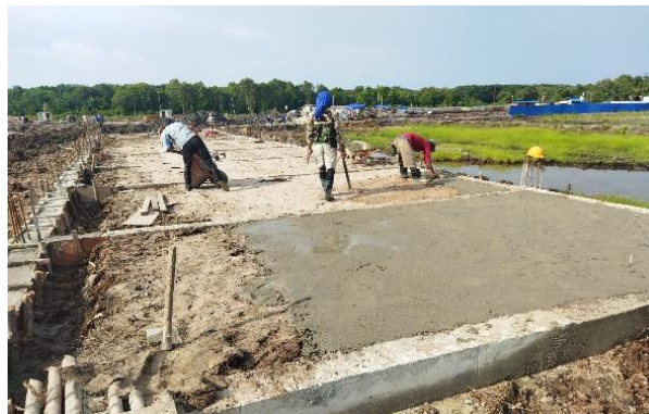
Gambar 3. 29 Pengecoran Lantai Kerja (Sumber): Dokumentasi Lapangan 2023
