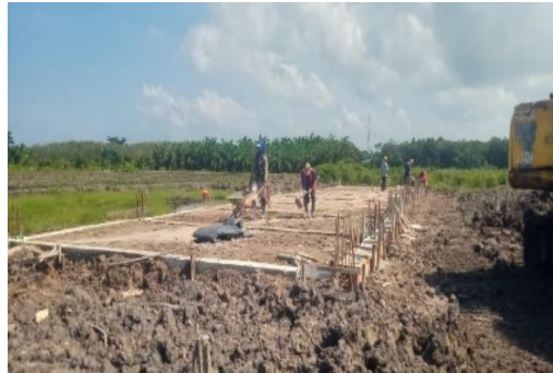
Gambar 3. 28 pengurugan pasir (Sumber): Dokumentasi Lapangan 2023
