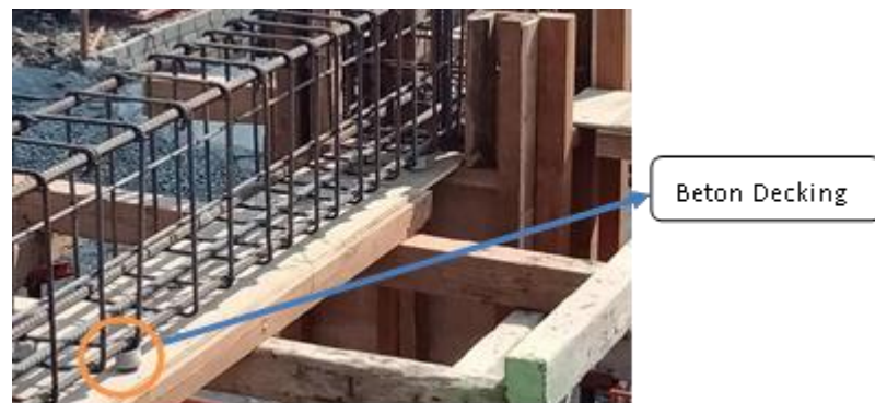
Gambar 3. 38 penulangan balok (Sumber): Dokumentasi Lapangan 2023
