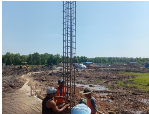
Gambar 3. 33 pemasangan tulangan kolom (Sumber): Dokumentasi Lapangan 2023
