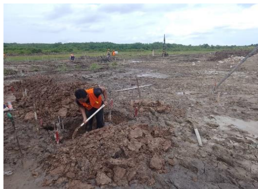
Gambar 3. 13 Pekerjaan Galian (Sumber): Dokumentasi Lapangan 2023
