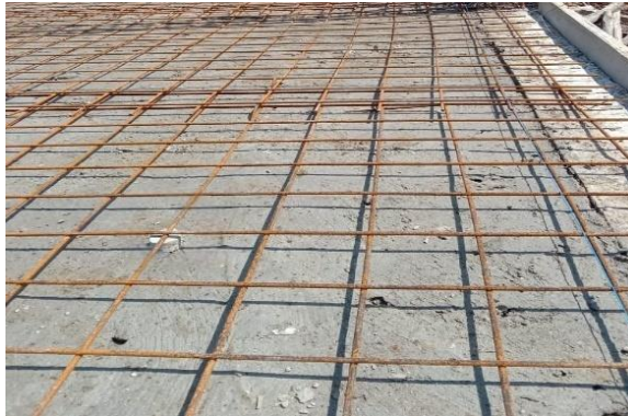
Gambar 3. 30 Pemasangan Wire Mash (Sumber): Dokumentasi Lapangan 2023
