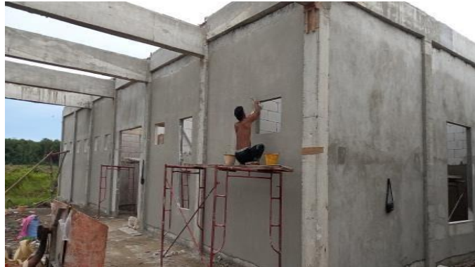
Gambar 3. 45 acian (Sumber): Dokumentasi Lapangan 2023
