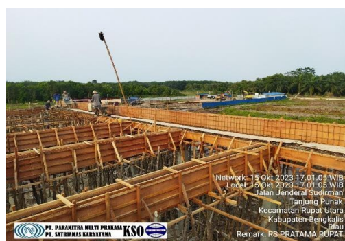
Gambar 3. 39 pemasangan bekisting balok (Sumber): Dokumentasi Lapangan 2023
