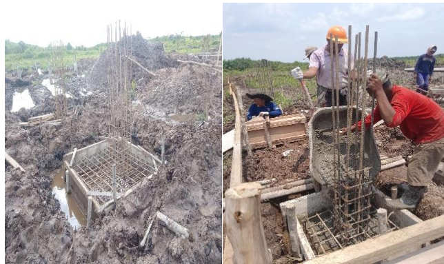
Gambar 3. 18 Hasil Pemasangan Bekisting dan Pengecoran (Sumber): Dokumentasi Lapangan 2023
