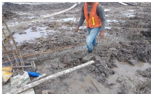
Gambar 3. 24 pemasangan tulangan sloof (Sumber): Dokumentasi Lapangan 2023
