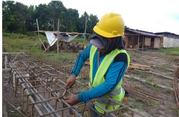
Gambar 3. 32 perakitan tulangan kolom (Sumber): Dokumentasi Lapangan 2023
