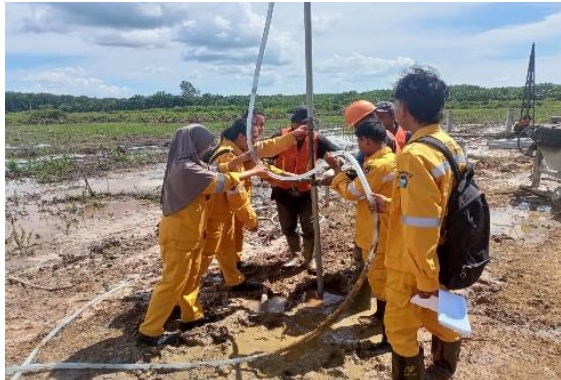
Gambar 3. 9 Proses Pengeboran (Sumber): Dokumentasi Lapangan 2023
