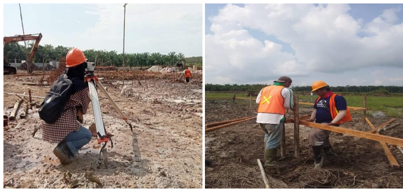
Gambar 3. 4 Pengukuran dan pemasangan bouwplank (Sumber): Dokumentasi Lapangan 2023
