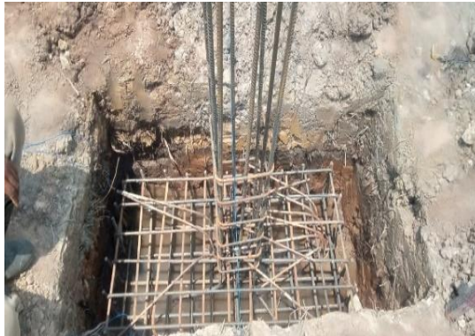
Gambar 3. 16 Tulangan Pile Cap didalam galian (Sumber): Dokumentasi Lapangan 2023
