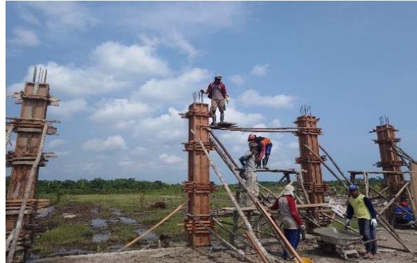
Gambar 3. 36 pengecoran kolom (Sumber): Dokumentasi Lapangan 2023
