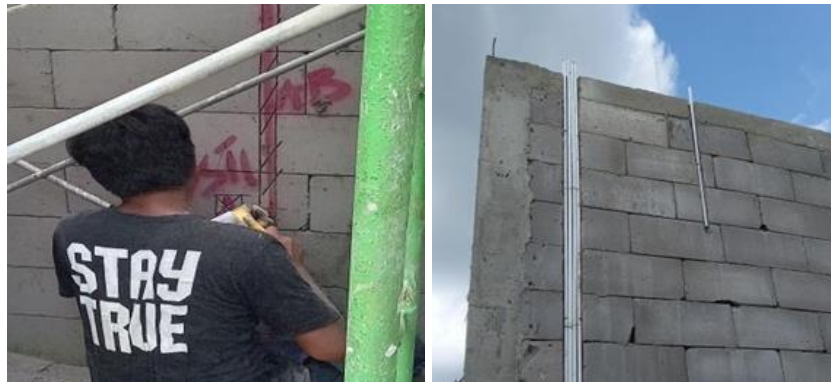
Gambar 3. 48 pembobokan dinding untuk listrik (Sumber): Dokumentasi Lapangan 2023
