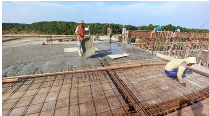
Gambar 3. 42 pengecoran plat lantai (Sumber): Dokumentasi Lapangan 2023
