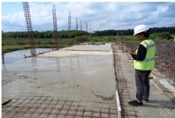
Gambar 3. 31 Pengecoran Lantai (Sumber): Dokumentasi Lapangan 2023
