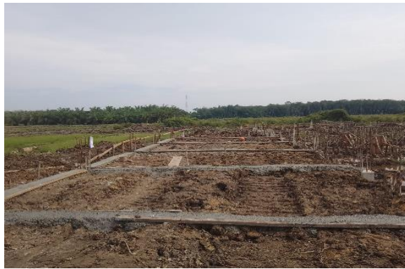
Gambar 3. 22 Lantai Dasar Sloof (Sumber): Dokumentasi Lapangan 2023
