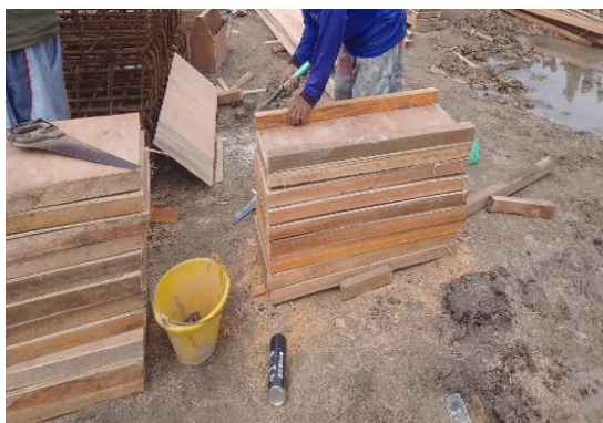
Gambar 3. 17 Proses pembuatan bekisting (Sumber): Dokumentasi Lapangan 2023
