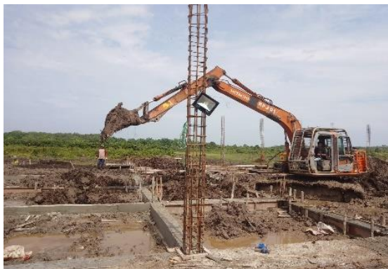
Gambar 3. 27 proses pemasatan tanah (Sumber): Dokumentasi Lapangan 2023
