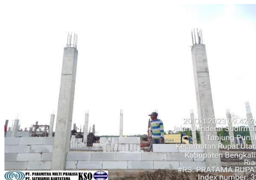
Gambar 3. 37 Pemasangan Dinding (Sumber): Dokumentasi Lapangan 2023
