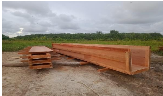
Gambar 3. 35 bekisting kolom (Sumber): Dokumentasi Lapangan 2023
