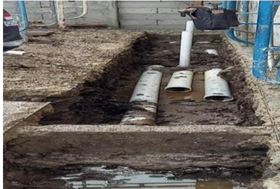
Gambar 3. 47 galian Pipa Air bersih (Sumber): Dokumentasi Lapangan 2023
