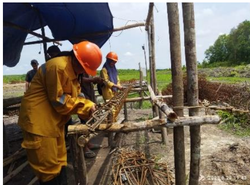
Gambar 3. 7 Perakitan Tulangan Strauss Pile (Sumber): Dokumentasi Lapangan 2023
