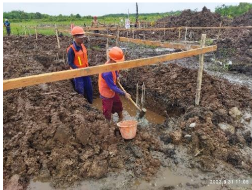
Gambar 3. 14 pembobokan kepala strauss pile (Sumber): Dokumentasi Lapangan 2023
