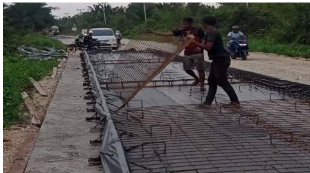
Gambar 3. 14 Pekerjaan Pembesian Rigid (sumber : Dokumentasi Lapangan, Kerja Praktek 2023)
