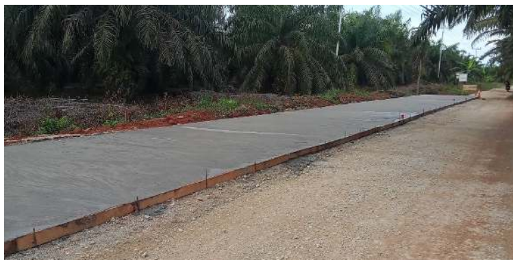
Gambar 4. 26 Hasil Pengecoran LC (Sumber: Dokumentasi Lapangan 2023)
