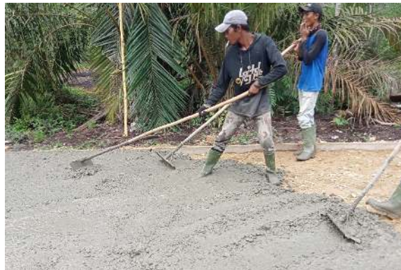
Gambar 4. 23 Meratakan beton pengecoran LC (Sumber: Dokumentasi Lapangan 2023)
