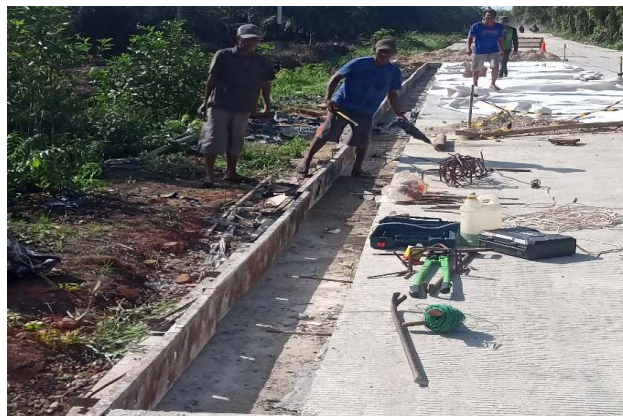
Gambar 3. 26 Pemasangan Bekisting Sumber: Dokumentasi Lapangan 2023
