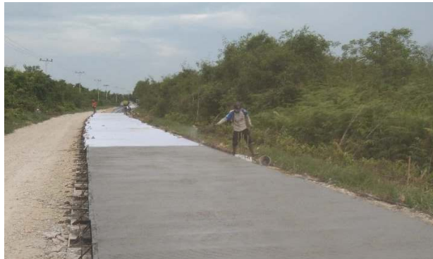
Gambar 3. 22 Pekerjaan Curing Compound (sumber : Dokumentasi Lapangan, Kerja Praktek 2023)
