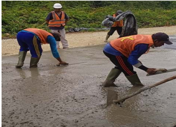
Gambar 4. 24 Finishing/Meratakan permukaan beton LC (Sumber: Dokumentasi Lapangan 2023)
