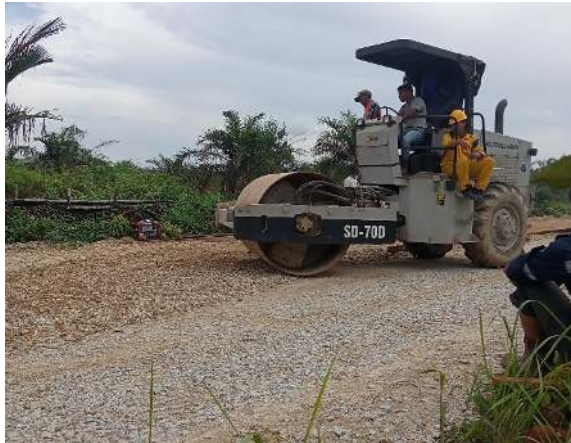
Gambar 3. 2 Pemadatan agregat base B (sumber : Dokumentasi Lapangan, Kerja Praktek 2023)
