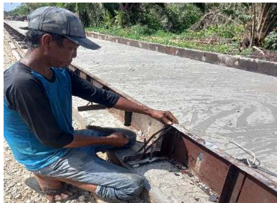
Gambar 3. 12 Pengikatan Besi Penahan Bekisting Rigid (sumber : Dokumentasi Lapangan, Kerja Praktek 2023)
