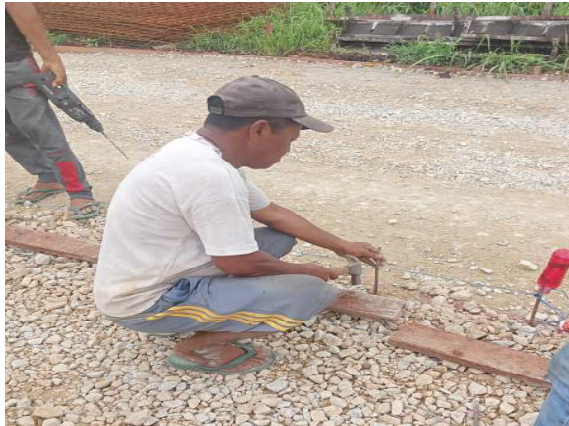
Gambar 4. 7 Pemasangan Besi Penahan Bekisting LC ( Lean Concrete ) (Sumber: Dokumentasi Lapangan 2023)
