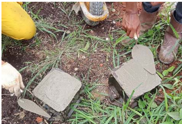
Gambar 4. 21 Perataan permukaan Sampel beton Kubus (Sumber: Dokumentasi Lapangan 2023)
