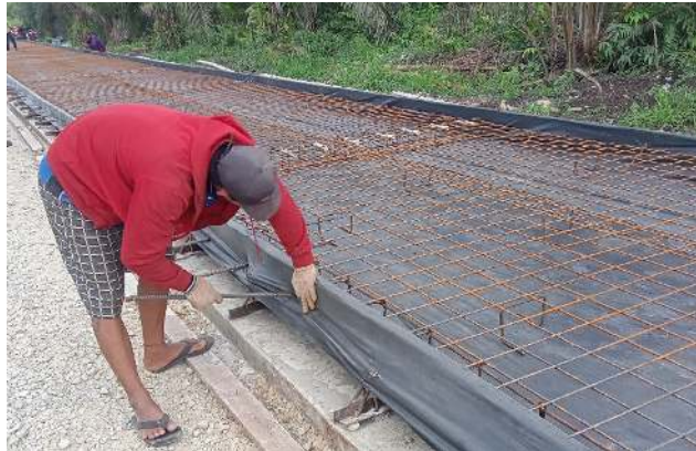
Gambar 3. 15 Pemasangan Tie Bar (sumber : Dokumentasi Lapangan, Kerja Praktek 2023)
