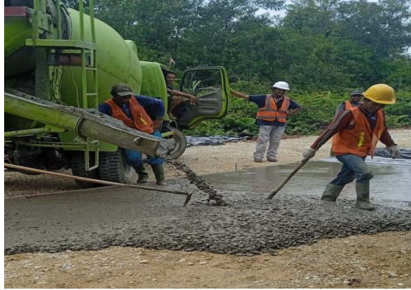
Gambar 4. 22 Penuangan beton pengecoran LC (Sumber: Dokumentasi Lapangan 2023)
