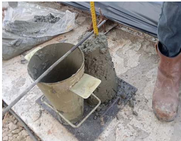
Gambar 3. 34 Penujian Slump Test Sumber: Dokumentasi Lapangan 2023
