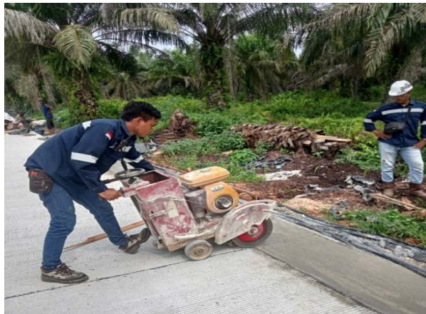
Gambar 3. 24 Pekerjaan Cutting (sumber : Dokumentasi Lapangan, Kerja Praktek 2023)
