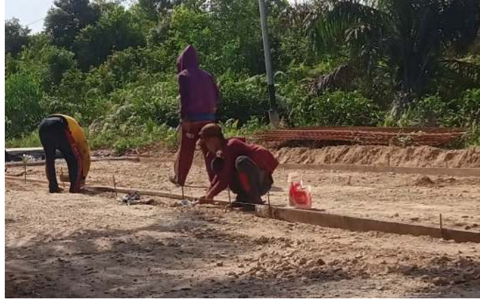
Gambar 4. 8 Pemasangan Bekisting LC ( Lean Concrete ) (Sumber: Dokumentasi Lapangan 2023)
