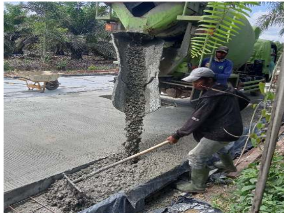
Gambar 3. 30 Penuangan Beton Sumber: Dokumentasi Lapangan 2023
