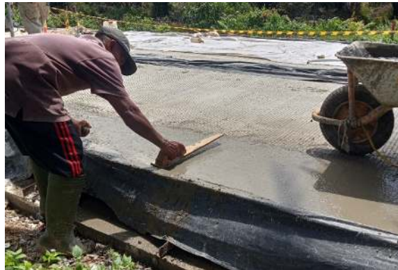
Gambar 3. 32 Proses Perataan Beton Atau Finishing Sumber: Dokumentasi Lapangan
