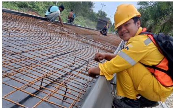
Gambar 3. 16 Pengikatan Besi Tulangan (sumber : Dokumentasi Lapangan, Kerja Praktek 2023)
