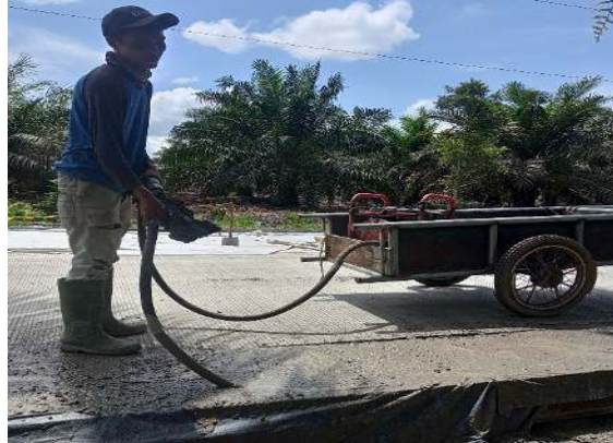
Gambar 3. 31 Pepadatan Beton Menggunakan Vibrator Sumber: Dokumentasi Lapangan 2023
