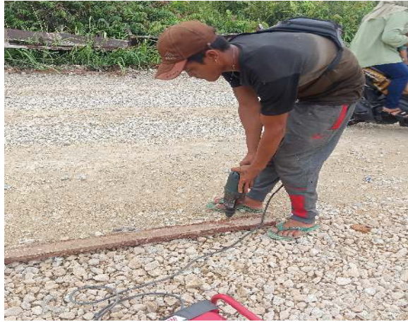
Gambar 4. 6 Pengeboran Untuk Pemasangan Besi Penahan Bekisting LC ( Lean Concrete ) (Sumber: Dokumentasi Lapangan 2023)
