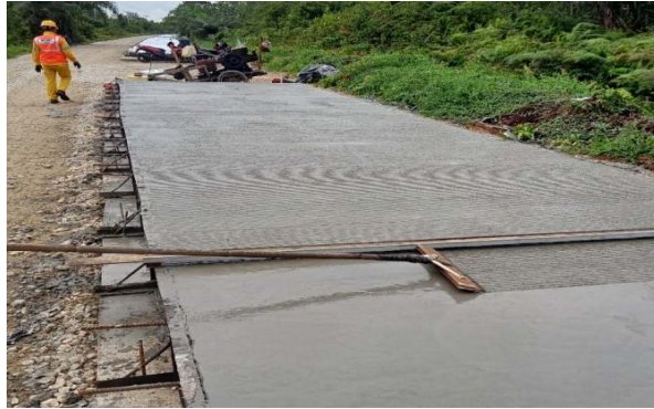
Gambar 3. 21 Pekerjaan Grooving (sumber : Dokumentasi Lapangan, Kerja Praktek 2023)
