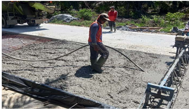
Gambar 3. 18 Pemadatan Beton Menggunakan Vibrator (sumber : Dokumentasi Lapangan, Kerja Praktek 2023)
