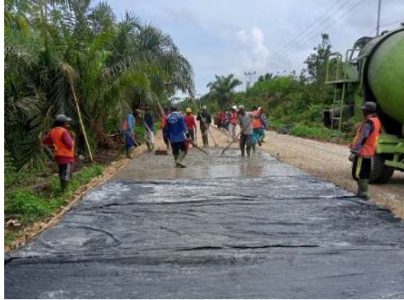
Gambar 3. 9 Pengecoran LC (sumber : Dokumentasi Lapangan, Kerja Praktek 2023)
