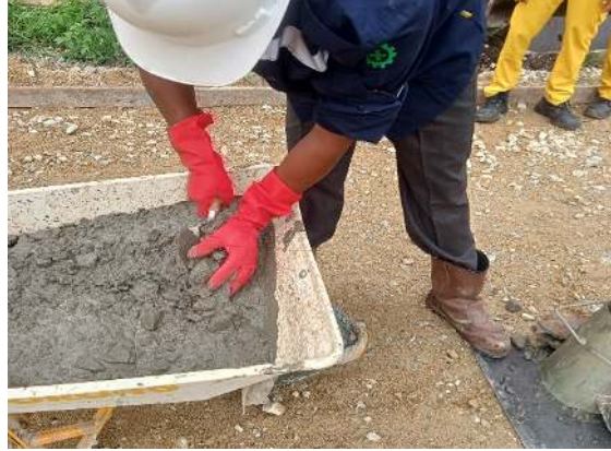
Gambar 4. 12 Pengambilan sampel uji slump (Sumber: Dokumentasi Lapangan 2023)
