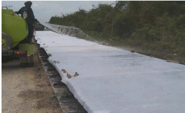
Gambar 3. 23 Pekerjaan Perawatan Beton curing (sumber : Dokumentasi Lapangan, Kerja Praktek 2023)
