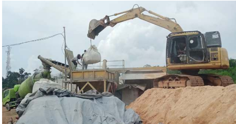
Gambar 4. 10 Persiapan Beton Ready Mix (Sumber: Dokumentasi Lapangan 2023)
