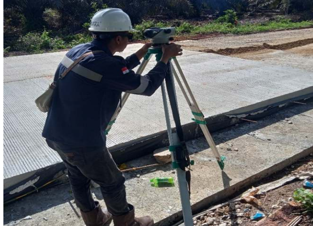
Gambar 4. 9 Pengecekan Elevasi Bekisting LC (Sumber: Dokumentasi Lapangan 2023)
