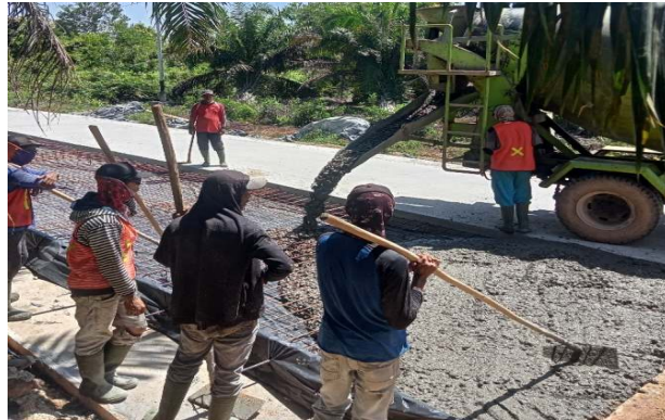
Gambar 3. 17 Pengecoran Rigid (sumber : Dokumentasi Lapangan, Kerja Praktek 2023)
