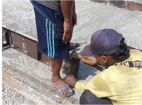
Gambar 3. 11 Pemasangan Besi Penahan Bekisting Rigid (sumber : Dokumentasi Lapangan, Kerja Praktek 2023)
