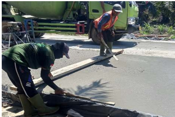
Gambar 3. 20 Finishing (sumber : Dokumentasi Lapangan, Kerja Praktek 2023)
