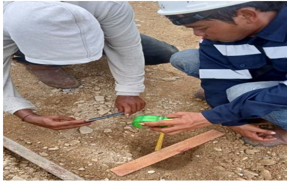
Gambar 3. 4 Pengukuran Test Pit Base B (sumber : Dokumentasi Lapangan, Kerja Praktek 2023)
