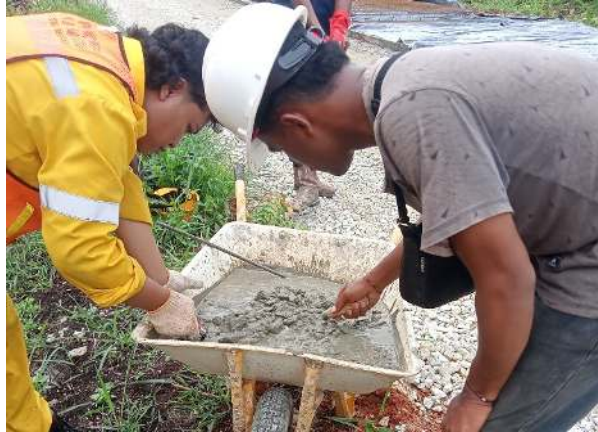
Gambar 4. 18 Pengambilan Sampel beton Kubus (Sumber: Dokumentasi Lapangan 2023)
