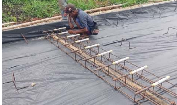
Gambar 3. 13 Pemasangan Tulangan Dowel & Dudukan Wiremesh (sumber : Dokumentasi Lapangan, Kerja Praktek 2023)
