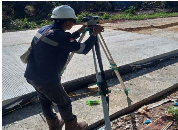
Gambar 3. 8 Pegecekan Bekisting LC (sumber : Dokumentasi Lapangan, Kerja Praktek 2023)
