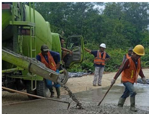
Gambar 4. 11 Mobilisasi Beton (Sumber: Dokumentasi Lapangan 2023)
