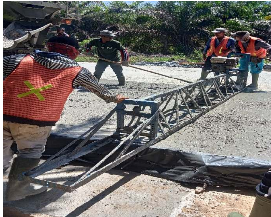
Gambar 2. 11 Truss Screeder Dynamic (Sumber: Dokumentasi Lapangan 2023)
