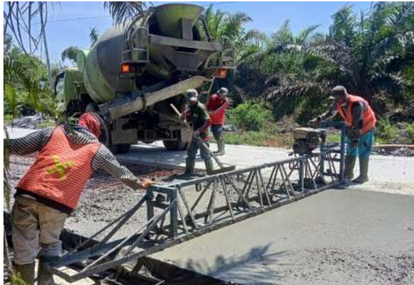
Gambar 3. 19 Meratakan Permukaan Beton (sumber : Dokumentasi Lapangan, Kerja Praktek 2023)
