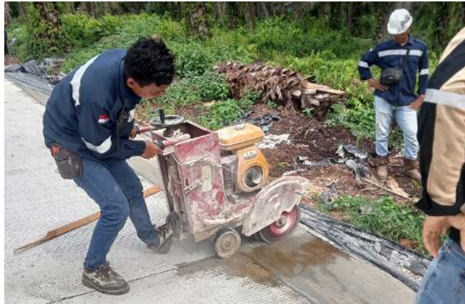
Gambar 3. 33 Cutting Bahu Jalan Sumber: Dokumentasi Lapangan 2023
