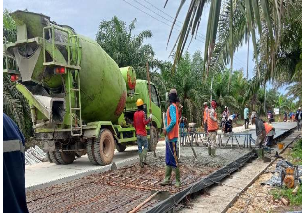
Gambar 2. 8 Truck Mixer (Sumber: Dokumentasi Lapangan 2023)
