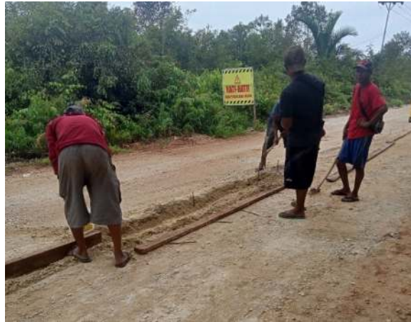
Gambar 3. 7 Pemasangan Bekisting LC (sumber : Dokumentasi Lapangan, Kerja Praktek 2023)
