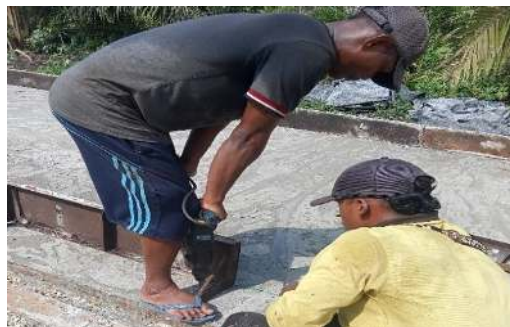
Gambar 3. 10 Pengeboran LC untuk Pemasangan Besi Penahan Bekisting Rigid (sumber : Dokumentasi Lapangan, Kerja Praktek 2023)
