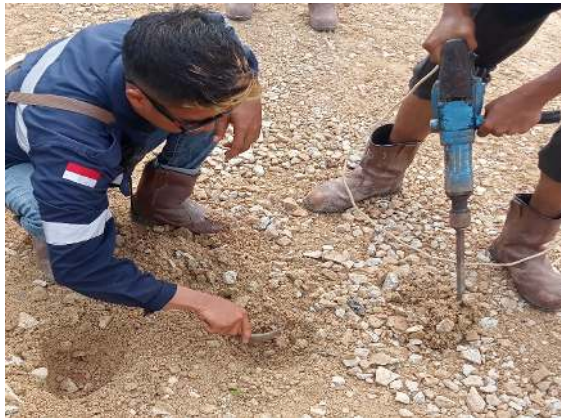
Gambar 3. 3 Penggalan lubang Test Pit Base B (sumber : Dokumentasi Lapangan, Kerja Praktek 2023)
