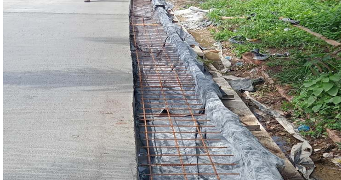
Gambar 3. 27 Pemasangan Plastik dan Pembesian Sumber: Dokumentasi Lapangan 2023
