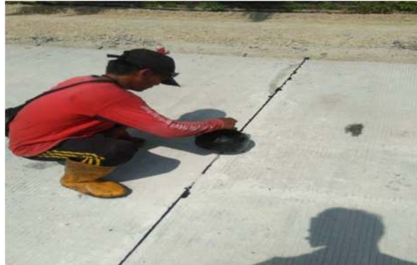
Gambar 3. 25 Pekerjaan Joint Sealent (sumber : Dokumentasi Lapangan, Kerja Praktek 2023)
