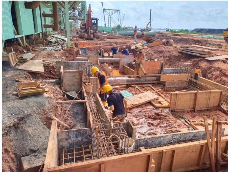
Gambar 3.20 Pemasangan Support beskiting pondasi (Sumber: Dokumentasi lapangan 2023)
