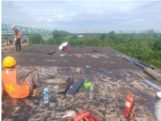
Gambar 3.3 Pengaplikasian Bahan Waterproofing Membrane Bakar
