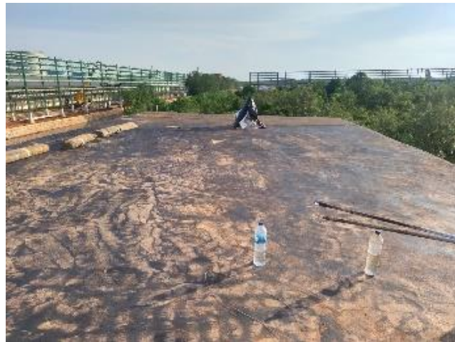
Gambar 3.2 Pengaplikasian Lapisan Coting
