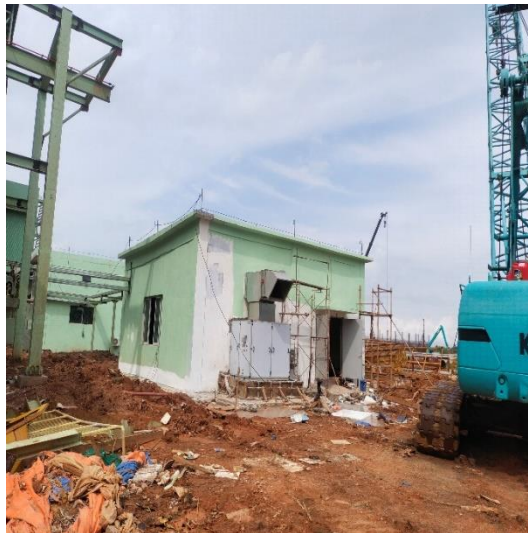
Gambar 2.21 .ID Fan High Voltage
