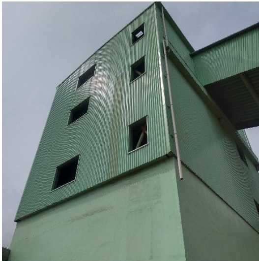
Gambar 2.11 Coal Crusher (Sumber: Dokumentasi Lapangan 2023)
