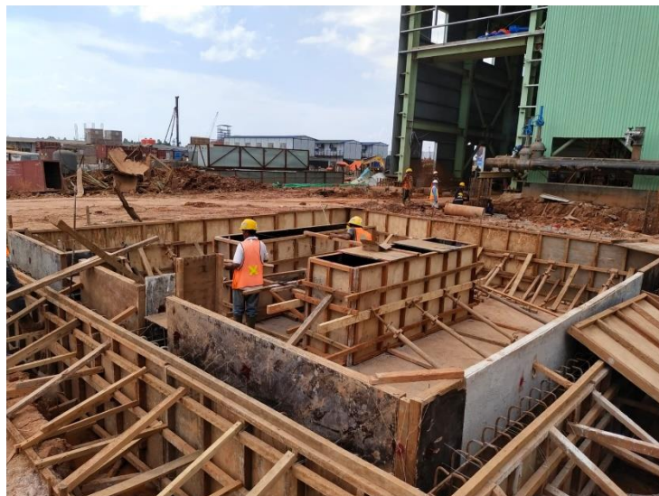
Gambar 3.15 Pemasangan Support beskiting pondasi (Sumber: Dokumentasi lapangan 2023)
