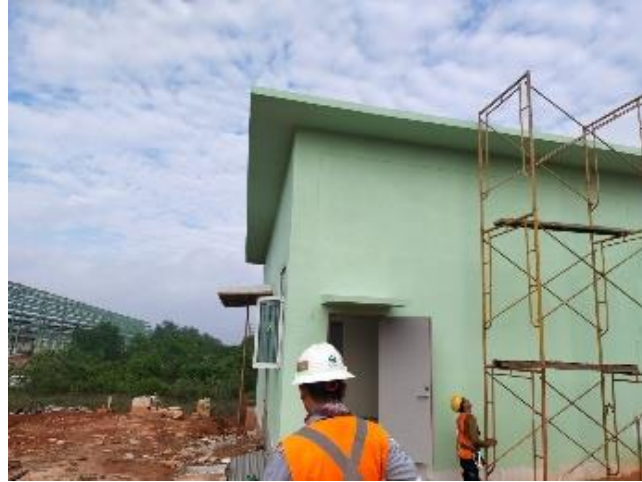
Gambar 3.1 Persiapan Pemasangan Scaffolding Frame
