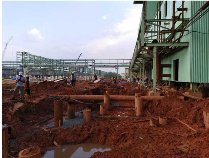
Gambar 3.19 Pouring concrete lantai kerja slag silo
