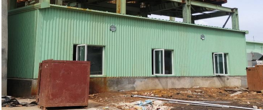
Gambar 2.8 Cems Room (Sumber: Dokumentasi Lapangan 2023)
