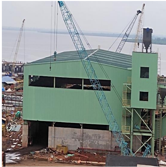
Gambar 2.12 Coal Shed (Sumber: Dokumentasi Lapangan 2023)
