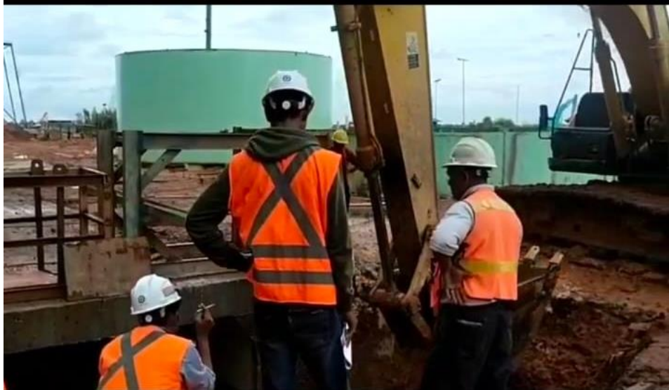
Gambar 3.11 Galian Water pipe china (Sumber: Dokumentasi lapangan 2023)
