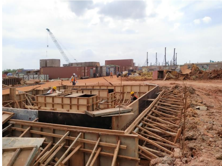
Gambar 3.14 Pemasangan Support beskiting pondasi (Sumber: Dokumentasi lapangan 2023)
