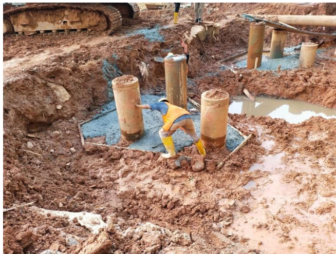
Gambar 3.18 Pouring concrete lantai kerja slag silo
