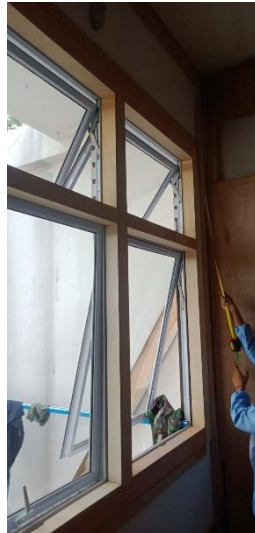
Gambar : 3.15 Pekerjaan pemasangan jendela sesudah (Sumber : Dokumentasi Pribadi 2023)
