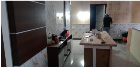
Gambar : 3.12 Pekerjaan pemasangan HPL sebelum (Sumber : Dokumentasi Pribadi 2023)
