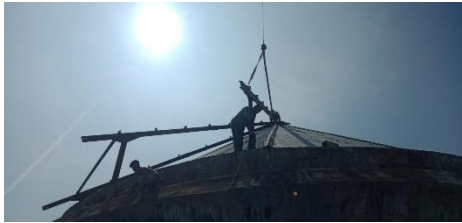
Gambar : 3.17 pekerjaan pemasangan rangka atap (Sumber : Dokumentasi Pribadi 2023)
