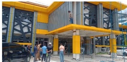
Gambar : 3.11 Pekerjaan pemasangan ACP sesudah (Sumber : Dokumentasi Pribadi 2023)
