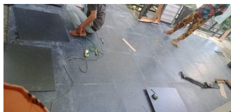
Gambar : 3.16 survey pekerjaan pemasangan keramik (Sumber : Dokumentasi Pribadi 2023)
