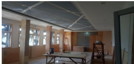
Gambar : 3.9 Pekerjaan pemasangan plafon sesudah (Sumber : Dokumentasi Pribadi 2023)
