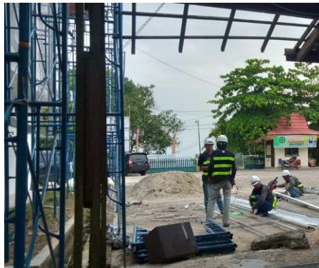
Gambar : 3.10 Pekerjaan pemasangan ACP sebelum (Sumber : Dokumentasi Pribadi 2023)
