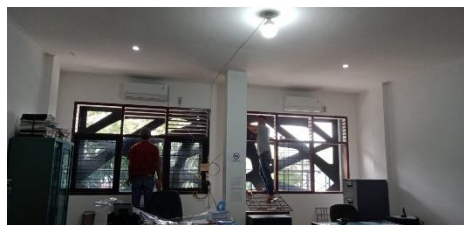
Gambar : 3.14 Pekerjaan pemasangan jendela sebelum (Sumber : Dokumentasi Pribadi 2023)
