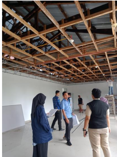
Gambar : 3.8 Pekerjaan pemasangan plafon sebelum (Sumber : Dokumentasi Pribadi 2023)
