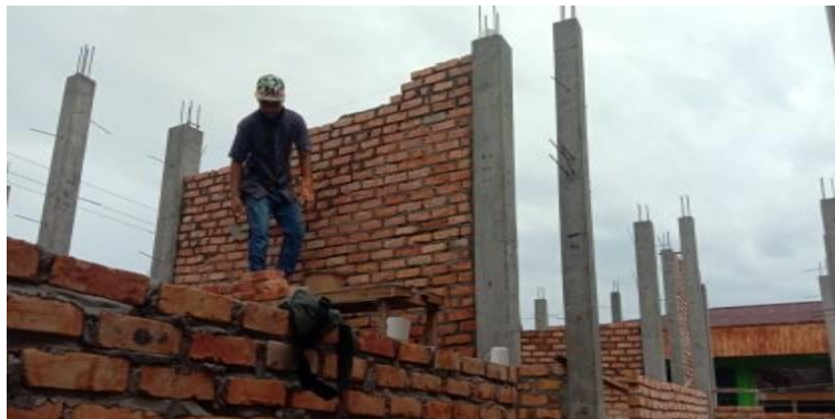
Gambar 3.5 Pemasangan Dinding Bata Proyek Baznas Sumber : Dokumentasi pribadi di lokasi proyek 2023
