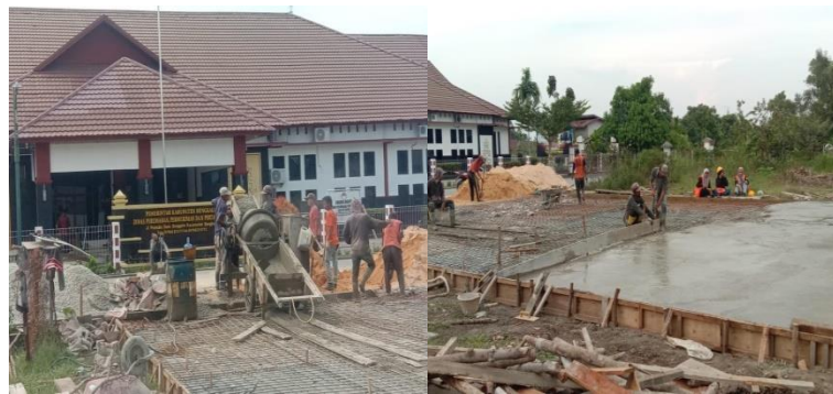
Gambar 3.64 Pengecoran Jalan Bangunan Proyek Workshop Sumber : Dokumentasi pribadi di lokasi proyek 2023
