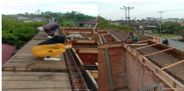
Gambar 3.13 Tulangan dan Bekisting Talang Beton Sumber : Dokumentasi pribadi di lokasi proyek 2023
