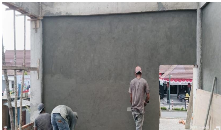
Gambar 3.39 Acian Dinding Proyek Workshop Sumber : Dokumentasi pribadi di lokasi proyek 2023
