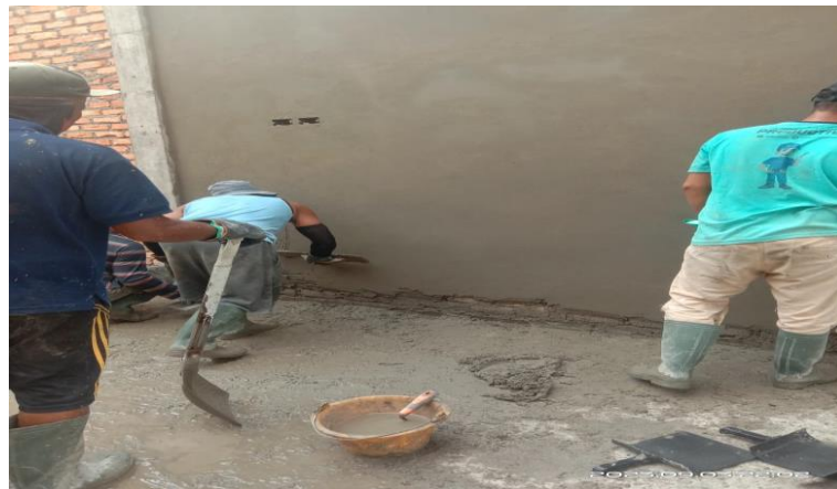
Gambar 3.36 Plesteran Dinding Proyek Baznas Sumber : Dokumentasi pribadi di lokasi proyek 2023
