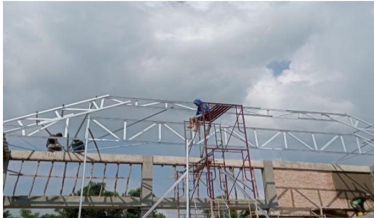
Gambar 3.29 Pemasangan Kuda-kuda Proyek Workshop Sumber : Dokumentasi pribadi di lokasi proyek 2023
