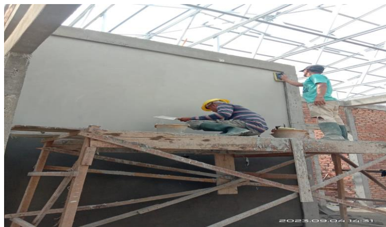
Gambar 3.37 Acian Dinding Proyek Baznas Sumber : Dokumentasi pribadi di lokasi proyek 2023
