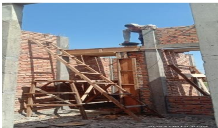
Gambar 3.9 Pengecoran Balok Latei Proyek Baznas Sumber : Dokumentasi pribadi di lokasi proyek 2023
