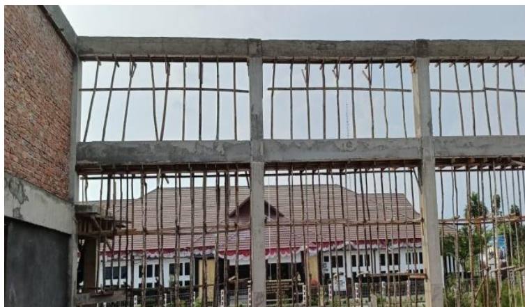
Gambar 3.17 Hasil Cor Balok Proyek Workshop Sumber : Dokumentasi pribadi di lokasi proyek 2023
