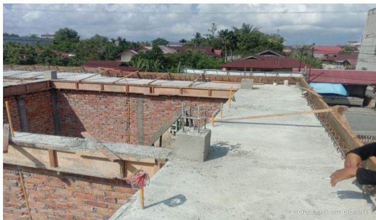
Gambar 3.19 Pembukaan Bekisting Kolom Balok Penyangga Atap Sumber : Dokumentasi pribadi di lokasi proyek 2023
