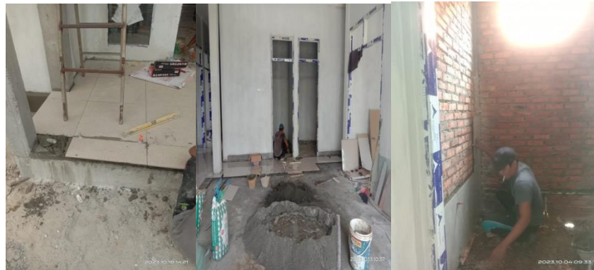
Gambar 3.51 Pasangan Keramik Proyek Baznas Sumber : Dokumentasi pribadi di lokasi proyek 2023
