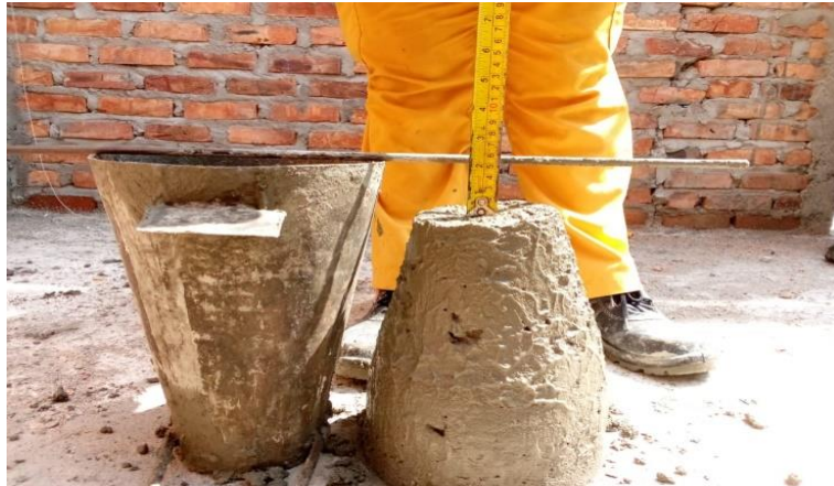
Gambar 3.32 Pengujian Slump Proyek Baznas Sumber : Dokumentasi pribadi di lokasi proyek 2023
