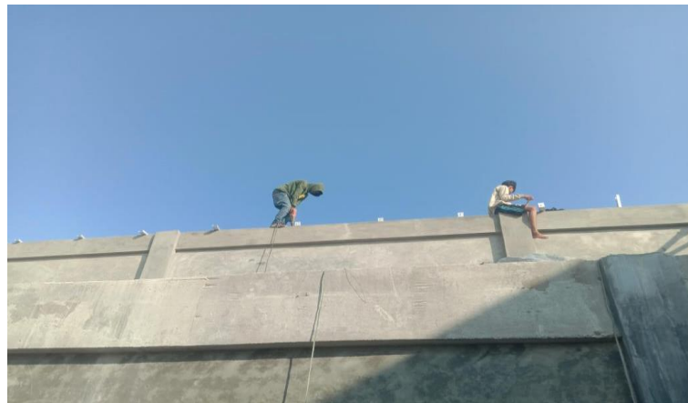
Gambar 3.28 Pemasangan Bracket Pengunci Kuda-kuda Proyek Workshop Sumber : Dokumentasi pribadi di lokasi proyek 2023
