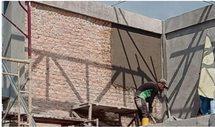
Gambar 3.38 Plesteran Dinding Proyek Workshop Sumber : Dokumentasi pribadi di lokasi proyek 2023
