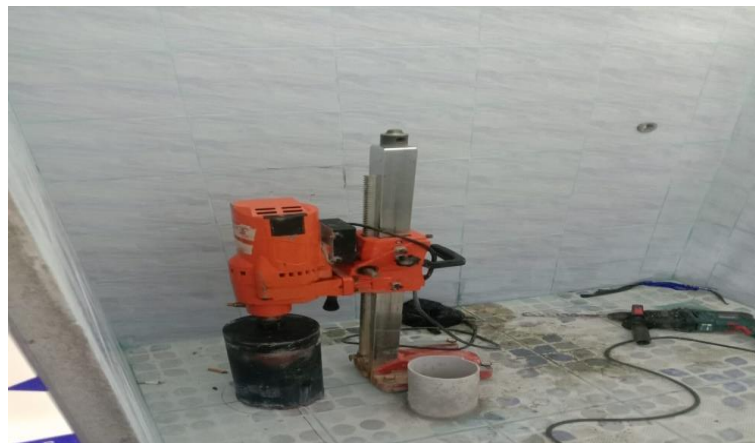
Gambar 3.55 Pemasangan Alat ke Titik Bor Sumber : Dokumentasi pribadi di lokasi proyek 2023
