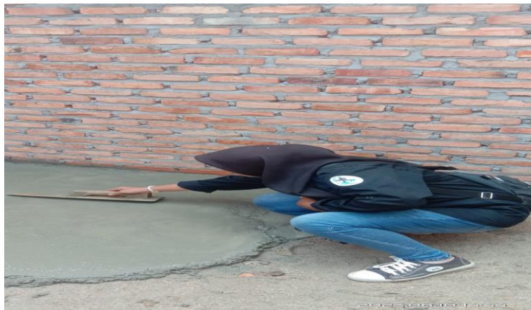
Gambar 3.24 Pengecoran Lantai Kerja Proyek Baznas Sumber : Dokumentasi pribadi di lokasi proyek 2023
