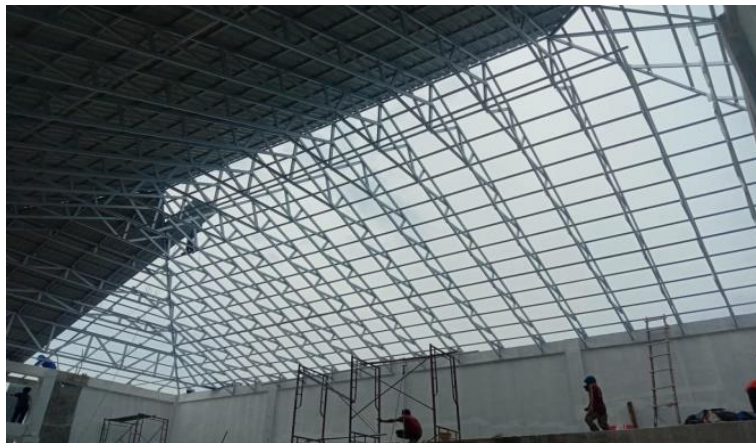
Gambar 3.30 Pemasangan Atap Seng Proyek Workshop Sumber : Dokumentasi pribadi di lokasi proyek 2023
