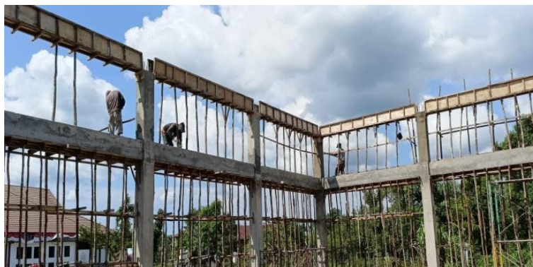
Gambar 3. 15 Bekisting Balok Proyek Workshop Sumber : Dokumentasi pribadi di lokasi proyek 2023
