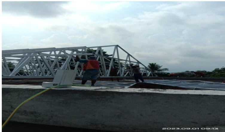
Gambar 3.26 Pemasangan Kuda-kuda Proyek Baznas Sumber : Dokumentasi pribadi di lokasi proyek 2023
