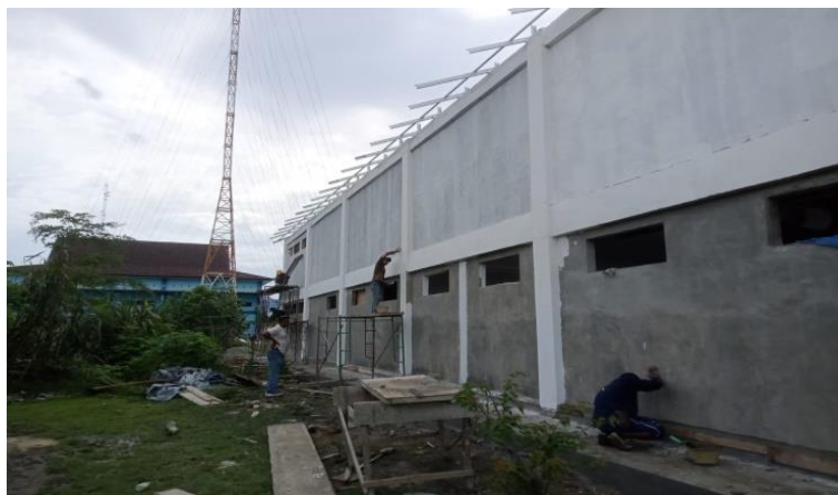
Gambar 3.57 Pengecatan Dasar dan Plamir Sumber : Dokumentasi pribadi di lokasi proyek 2023
