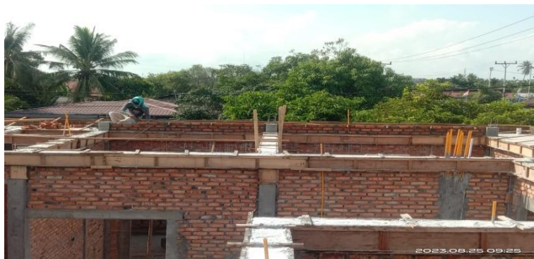
Gambar 3.20 Pemasangan Batu Bata Penyangga Atap Sumber : Dokumentasi pribadi di lokasi proyek 2023
