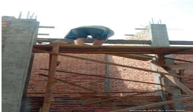
Gambar 3.10 Pembongkaran Balok Latei Proyek Baznas Sumber : Dokumentasi pribadi di lokasi proyek 2023
