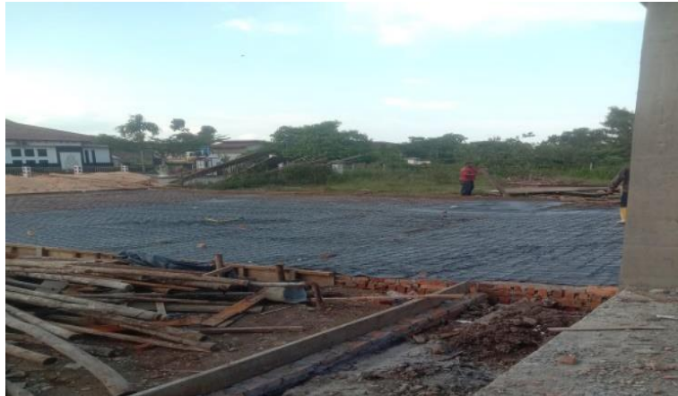
Gambar 3.63 Pemasangan Wiremesh Jalan Bangunan Proyek Workshop Sumber : Dokumentasi pribadi di lokasi proyek 2023
