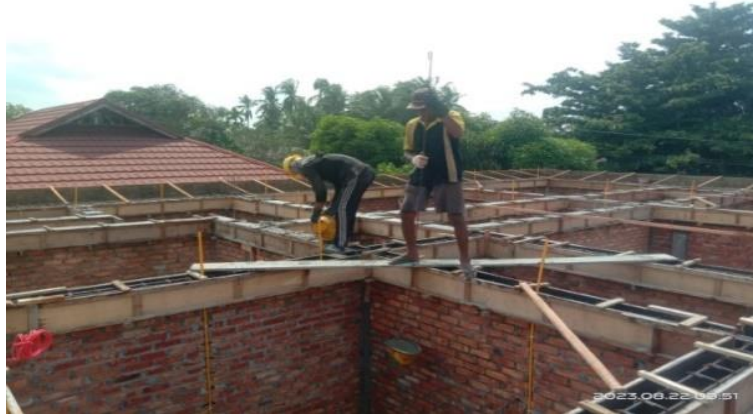
Gambar 3.14 Pengecoran balok dan talang beton Sumber : Dokumentasi pribadi di lokasi proyek 2023
