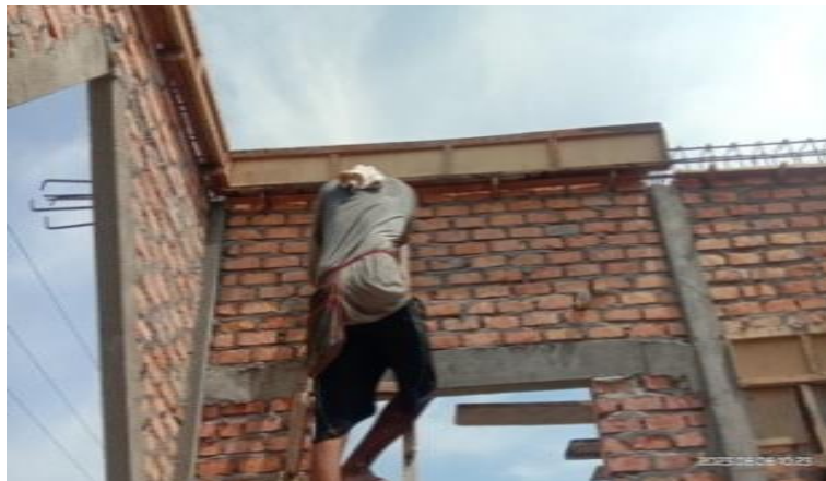
Gambar 3.12 Bekisting Balok Proyek Baznas Sumber : Dokumentasi pribadi di lokasi proyek 2023
