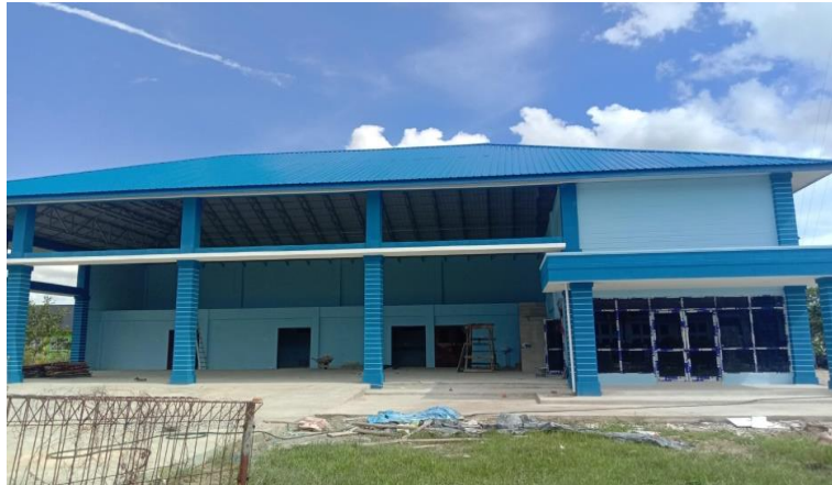
Gambar 3.66 Pembersihan Bangunan Proyek Workshop Sumber : Dokumentasi pribadi di lokasi proyek 2023
