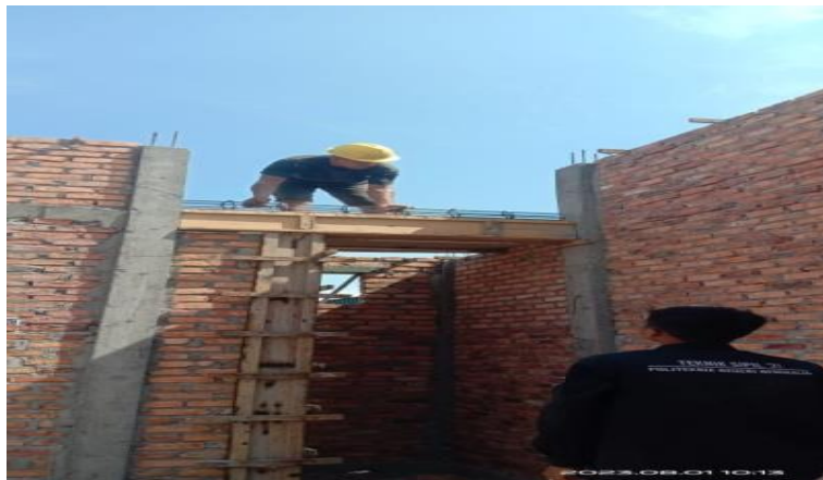
Gambar 3.8 Bekisting Balok Latei Proyek Basnas Sumber : Dokumentasi pribadi di lokasi proyek 2023
