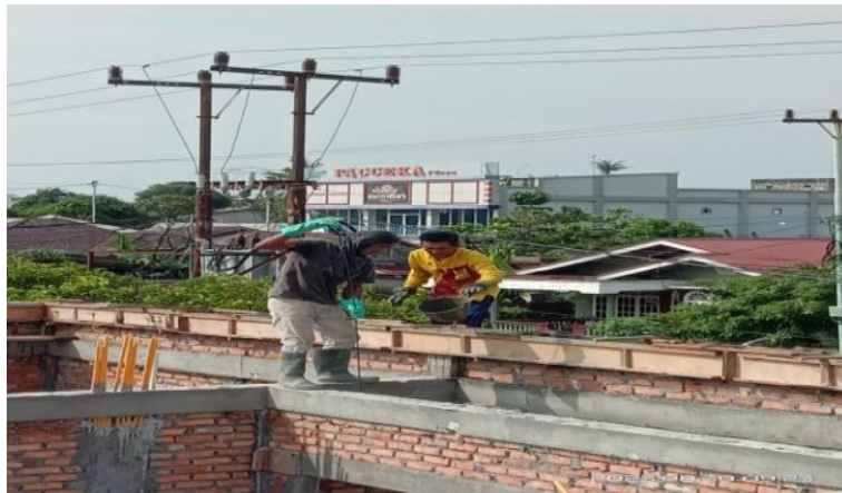
Gambar 3.22 Pengecoran Balok Penyangga Atap Sumber : Dokumentasi pribadi di lokasi proyek 2023
