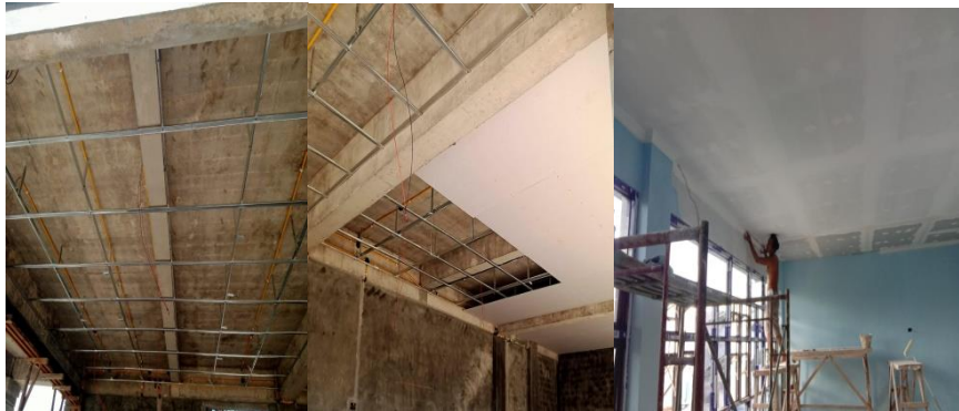
Gambar 3.50 Pekerjaan Plafond Proyek Workshop Sumber : Dokumentasi pribadi di lokasi proyek 2023
