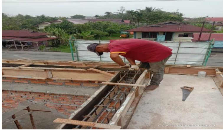
Gambar 3.21 Pemasangan Bekisting dan Tulangan Balok Penyangga Atap Sumber : Dokumentasi pribadi di lokasi proyek 2023
