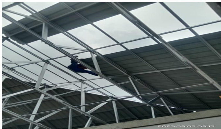
Gambar 3.27 Pemasangan Atap Seng Proyek Baznas Sumber : Dokumentasi pribadi di lokasi proyek 2023
