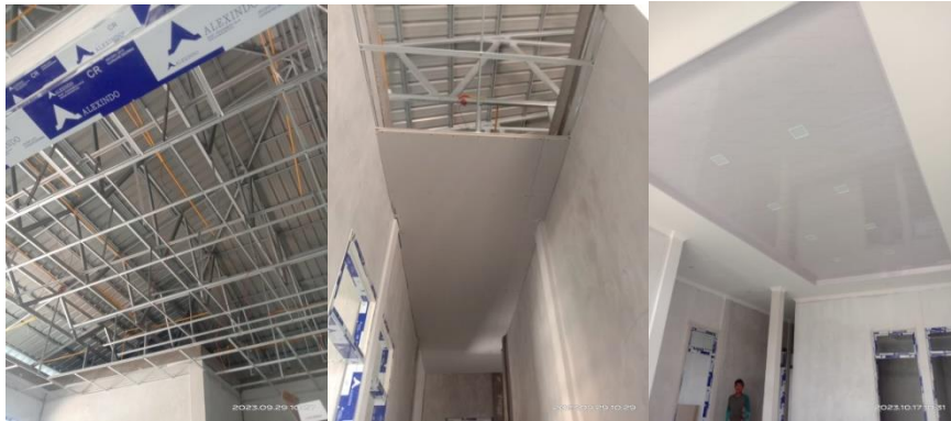
Gambar 3.49 Pekerjaan Plafond Proyek Baznas Sumber : Dokumentasi pribadi di lokasi proyek 2023
