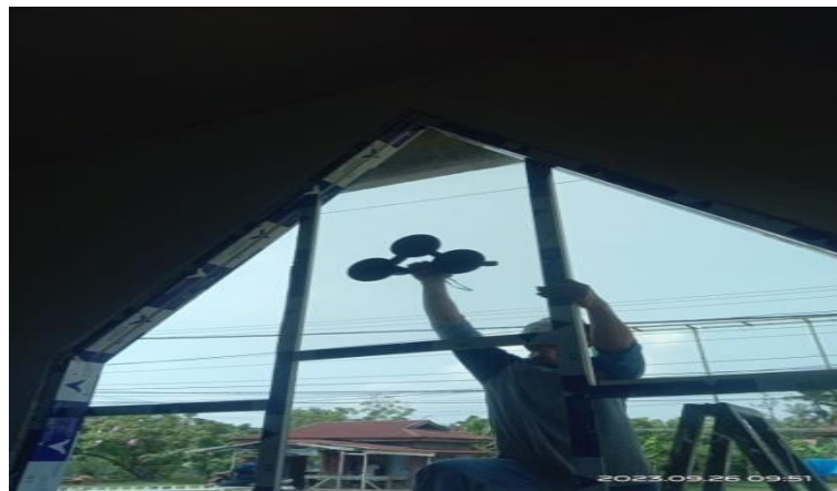
Gambar 3.46 Pemasangan Kaca Proyek Baznas Sumber : Dokumentasi pribadi di lokasi proyek 2023
