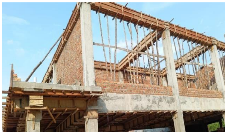
Gambar 3.16 Pengecoran Balok Proyek Workshop Sumber : Dokumentasi pribadi di lokasi proyek 2023
