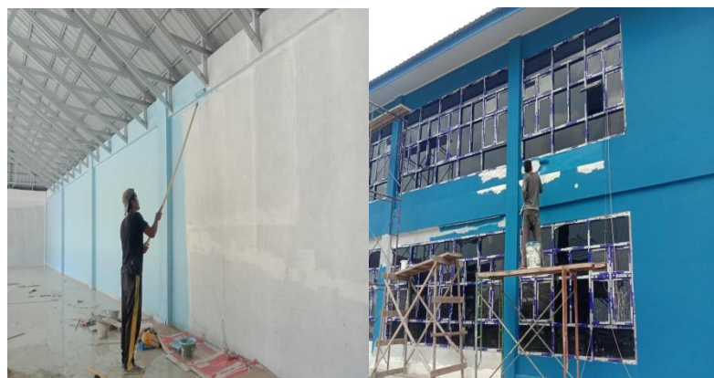
Gambar 3.58 Pengecatan Sumber : Dokumentasi pribadi di lokasi proyek 2023
