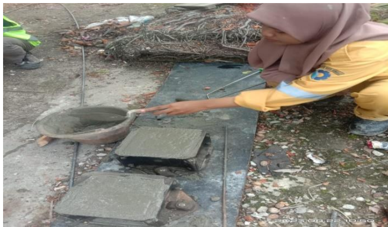
Gambar 3.33 Pengecoran Kubus Proyek Baznas Sumber : Dokumentasi pribadi di lokasi proyek 2023
