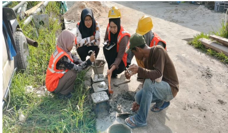
Gambar 3.35 Pengecoran Kubus Proyek Workshop Sumber : Dokumentasi pribadi di lokasi proyek 2023
