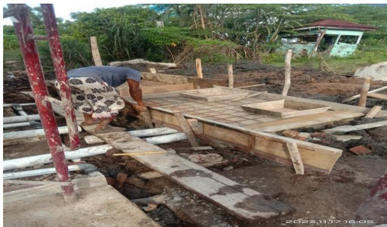
Gambar 3.65 Sumur Resapan Septictank Bangunan Proyek Workshop Sumber : Dokumentasi pribadi di lokasi proyek 2023
