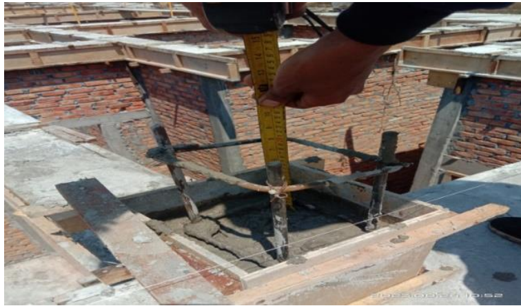
Gambar 3.18 Pengecoran Kolom Balok Penyangga Atap Sumber : Dokumentasi pribadi di lokasi proyek 2023
