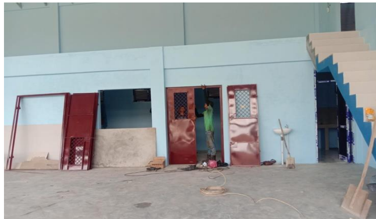
Gambar 3.48 Pemasangan Pintu Pelat Proyek Workshop Sumber : Dokumentasi pribadi di lokasi proyek 2023
