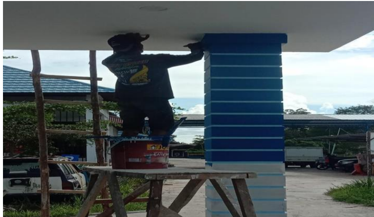
Gambar 3.59 Pengecatan Relief Kolom Sumber : Dokumentasi pribadi di lokasi proyek 2023
