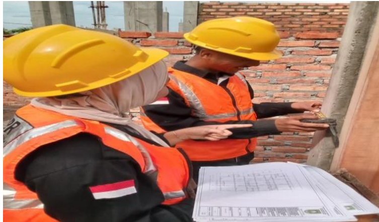
Gambar 3.4 Pemahaman Gambar Lapangan Proyek Baznas Sumber : Dokumentasi pribadi di lokasi proyek 2023
