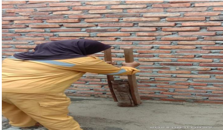
Gambar 3.23 Urugan Pasir Tebal 5 cm Sumber : Dokumentasi pribadi di lokasi proyek 2023
