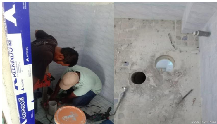
Gambar 3.56 Pengeboran dan Hasil Coring Slab Sumber : Dokumentasi pribadi di lokasi proyek 2023
