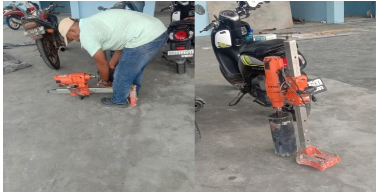
Gambar 3.54 Perakitan Alat Coring Slab Sumber : Dokumentasi pribadi di lokasi proyek 2023
