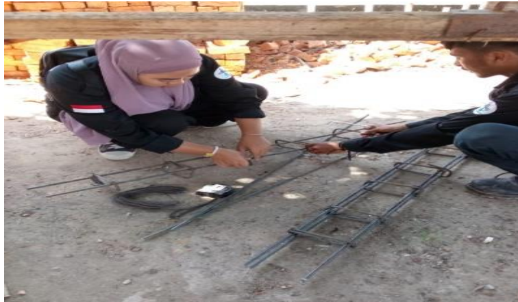
Gambar 3.7 Tulangan Balok Latei Proyek Baznas Sumber : Dokumentasi pribadi di lokasi proyek 2023
