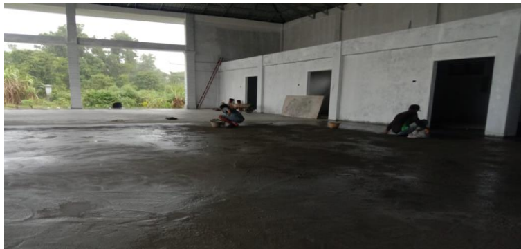
Gambar 3.40 Plesteran Lantai Beton Proyek Workshop Sumber : Dokumentasi pribadi di lokasi proyek 2023
