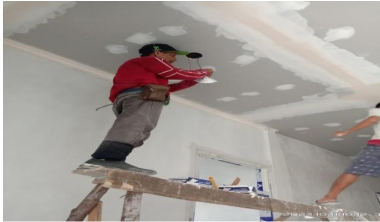
Gambar 3.43 Pemasangan Lampu Proyek Baznas Sumber : Dokumentasi pribadi di lokasi proyek 2023
