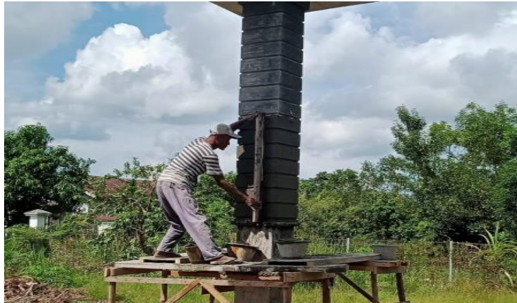
Gambar 3.41 Relief Kolom Proyek Workshop Sumber : Dokumentasi pribadi di lokasi proyek 2023
