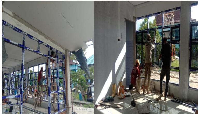
Gambar 3.47 Pemasangan Kusen dan Kaca Proyek Workshop Sumber : Dokumentasi pribadi di lokasi proyek 2023
