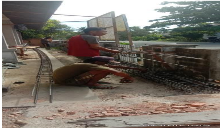
Gambar 3.11 Pengikatan Tulangan Balok Proyek Baznas Sumber : Dokumentasi pribadi di lokasi proyek 2023
