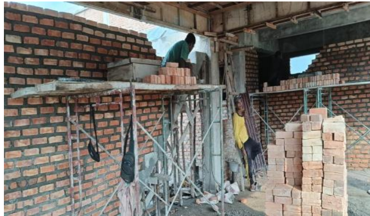
Gambar 3.6 Pemasangan Dinding Bata Proyek Workshop Sumber : Dokumentasi pribadi di lokasi proyek 2023
