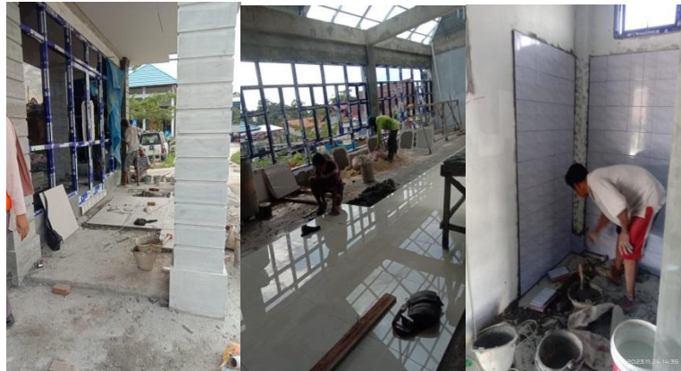
Gambar 3.52 Pasangan Keramik Proyek Workshop Sumber : Dokumentasi pribadi di lokasi proyek 2023
