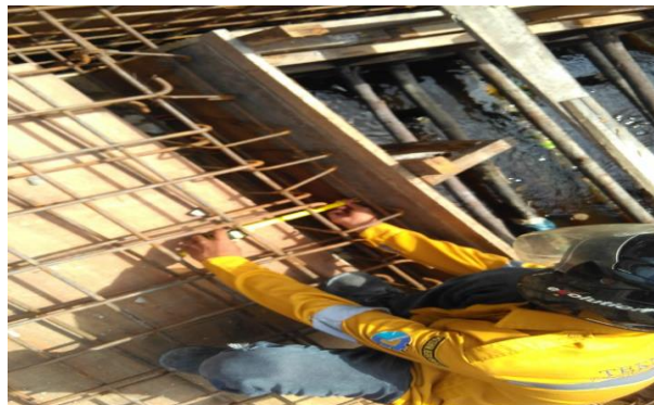
Gambar 3.6. Pemasangan Tulangan Plat Lantai Box Culvert (sumber : lapangan proyek)
