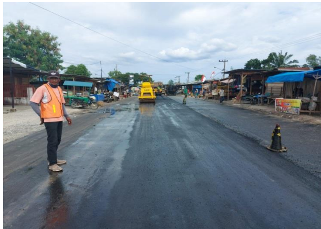
Gambar 3.14. Pekerjaan Ac- Bc
