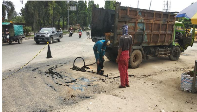
Gambar 3.12. Pekerjaan Prime Coat (sumber : Lapangan proyek ( Kerja praktek 2020)
