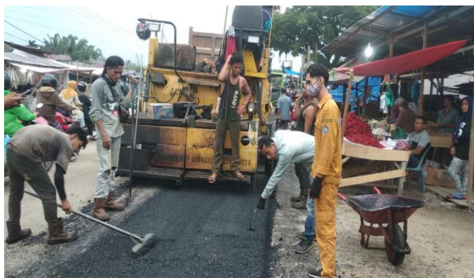
Gambar 3.15. Pekerjaan Ac- Wc
