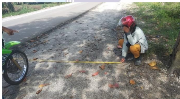
Gambar 3.3. Pengukuran Lebar Base
