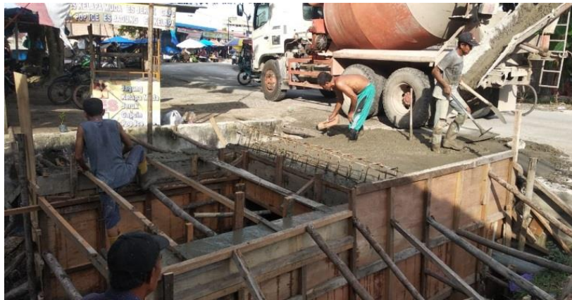
Gambar 3.7. Pengecoran Box Culvert
