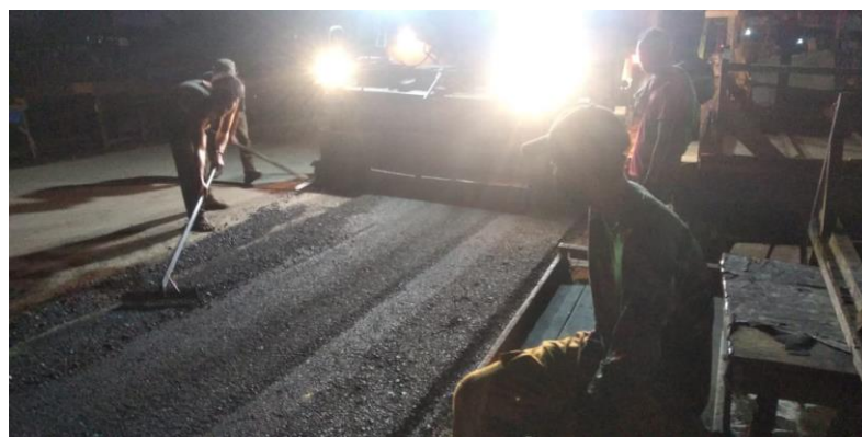
Gambar 3.13. Pekerjaan Ac- Bc (sumber : Lapangan proyek ( Kerja praktek 2020)
