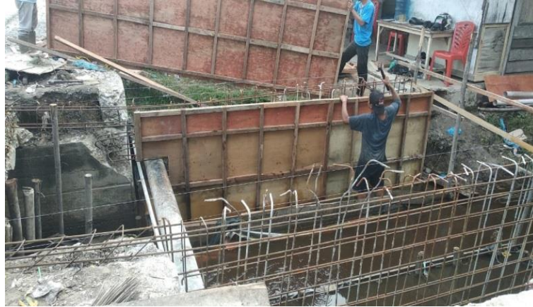
Gambar 3.5. Pemasangan Mall Dinding Box Culvert (sumber : Lapangan proyek ( Kerja praktek 2020)
