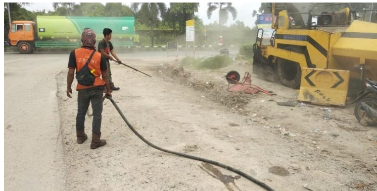
Gambar 3.11. Pekerjaan Compressor (sumber : Lapangan proyek ( Kerja praktek 2020)
