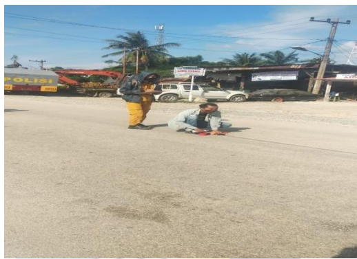
Gambar 3.2. Pengukuran Panjang Jalan
