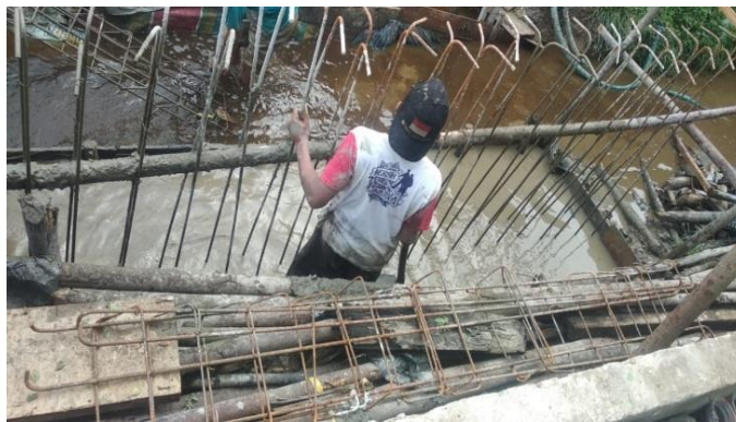
Gambar 3.4. Pemasangan Tulangan Dinding Box Culvert (sumber : Lapangan proyek ( Kerja praktek 2020)
