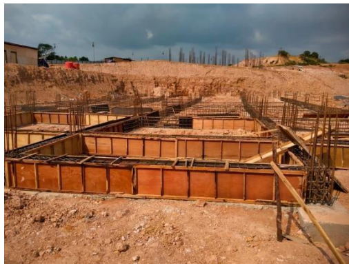
Gambar 3. 5 Bekisting Balok Sloof (Sumber : Dokumentasi Lapangan 2023 )
