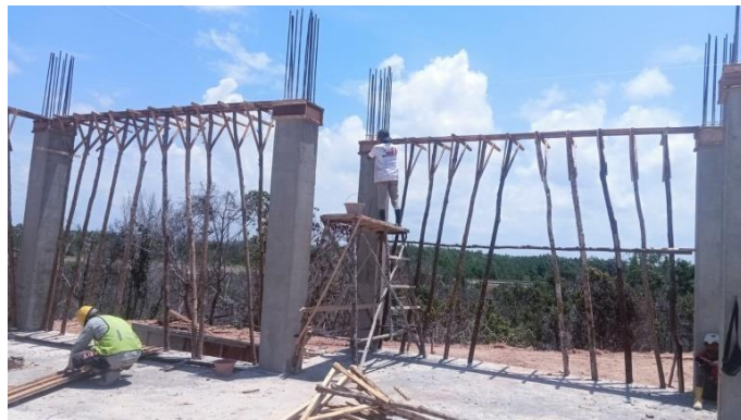
Gambar 3. 10 Perancah Balok
