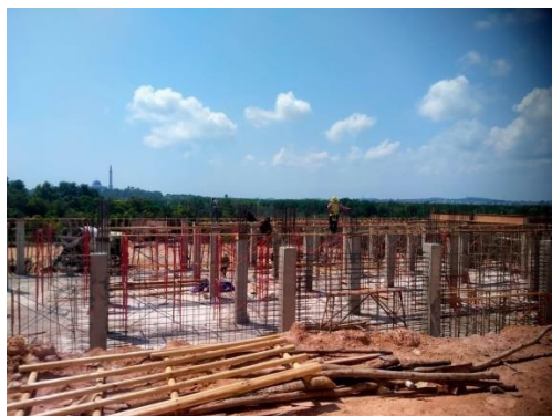
Gambar 3. 11 Pemasangan Perancah Balok (Sumber : Dokumentasi Lapangan 2023 )
