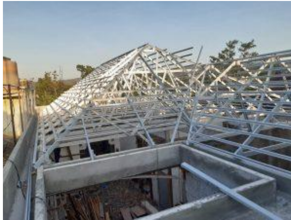
4 Gambar 3. 13 Rangka Atap Baja Ringan (Sumber : Dokumentasi Lapangan 2023)
