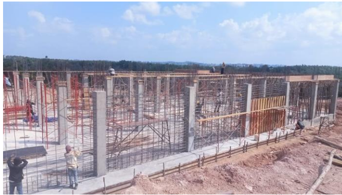
6 Gambar 3. 15 Pembesian Dinding Geser (Sumber : Dokumentasi Lapangan 2023)
