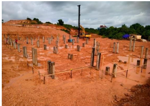
Gambar 3. 2 Pengecekan Tiang Pancang
