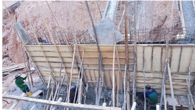
5 Gambar 3. 14 Pengecoran DPT
