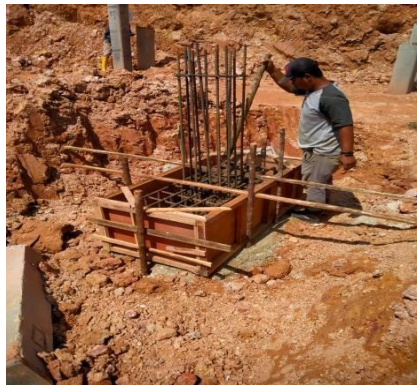
Gambar 3. 3 Pembesian Pile Cap
