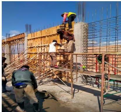
3 Gambar 3. 16 Pengecoran Dinding Geser (Sumber : Dokumentasi Lapangan 2023)
