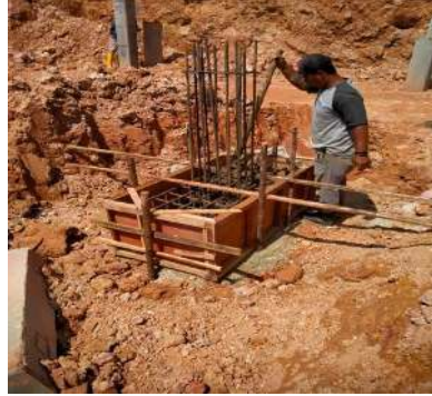
Gambar 3.3 Pengecoran Pile Cap ( Sumber : Dokumentasi Lapangan 2023 )
