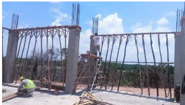
Gambar 3.10 Pemasangan Bekisting Balok
