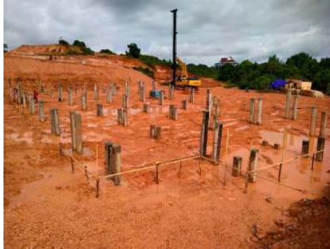
Gambar 3. 2 Proses Pamancangan ( Sumber : Dokumentasi Lapangan 2023 )
