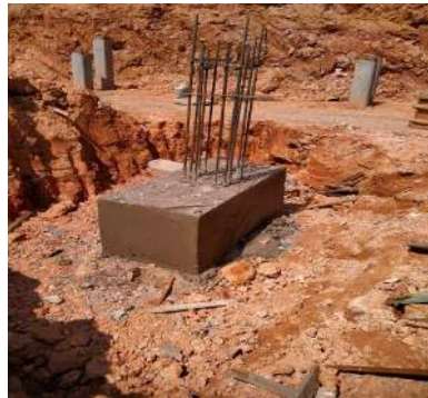
Gambar 3.4 Kolom Pedestal Yang Sudah Selesai ( Sumber : Dokumentasi Lapangan 2023 )
