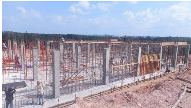
Gambar 3.15 Pengecoran Dinding Geser ( Sumber : Dokumentasi Lapangan 2023 )
