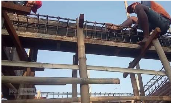
Gambar 3.12 Pembesian Ring Balok
