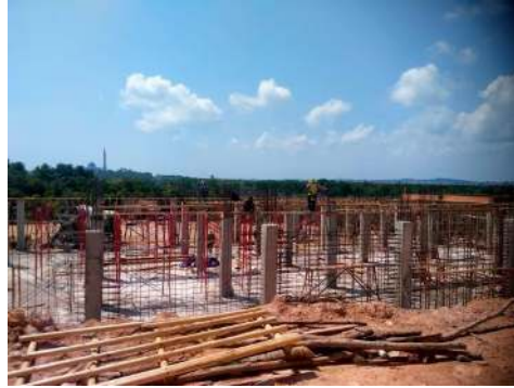
Gambar 3.11 Pemasangan Perancah Balok ( Sumber : Dokumentasi Lapangan 2023 )
