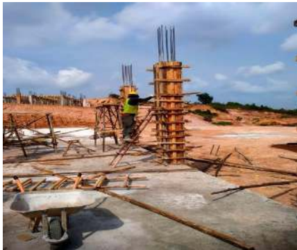
Gambar 3.8 Pembongkaran Bekisting Kolom ( Sumber : Dokumentasi Lapangan 2023 )
