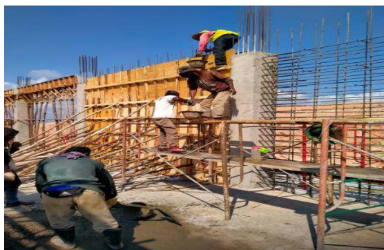
Gambar 3.16 Pembukaan Bekisting Dinding Geser ( Sumber : Dokumentasi Lapangan 2023 )
