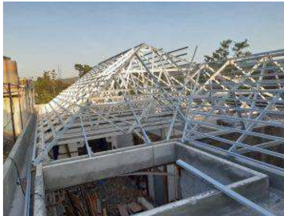
Gambar 3.13 Pemasangan Rangka Atap ( Sumber : Dokumentasi Lapangan 2023 )
