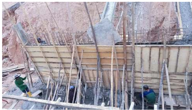
Gambar 3.14 Pemasangan Bekisting DPT ( Sumber : Dokumentasi Lapangan 2023 )
