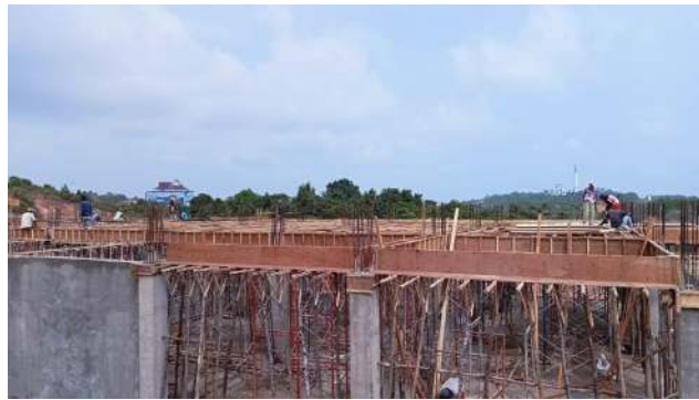
Gambar 3.7 Pengecoran Plat Lantai ( Sumber : Dokumentasi Lapangan 2023 )
