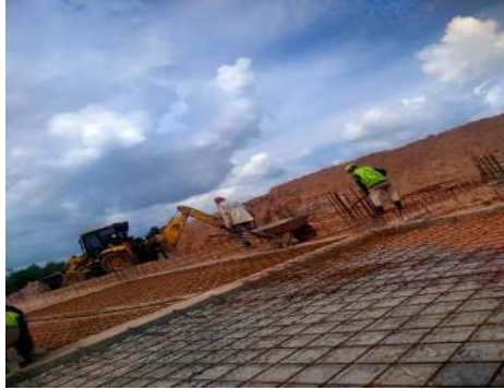
Gambar 3.6 Pemasangan Tulangan Plat Lantai ( Sumber : Dokumentasi Lapangan 2023 )
