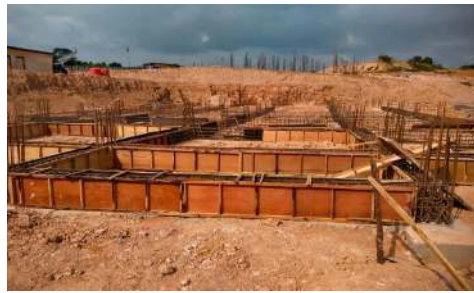
Gambar 3.5 Kolom Pedestal Yang Sudah Selesai
