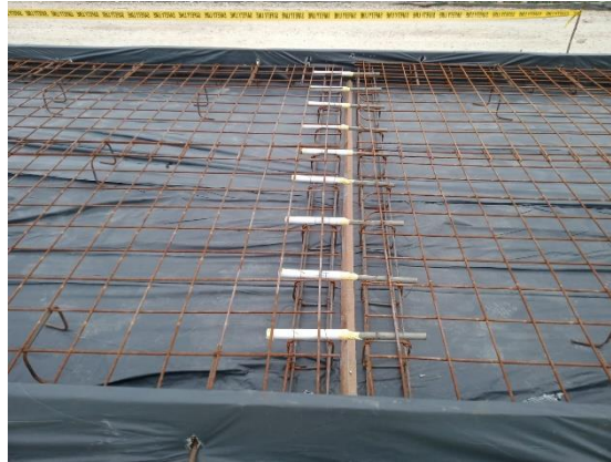
Gambar 3.11 Pemasangan Dowel (Sumber : Dokumentasi Lapangan)
