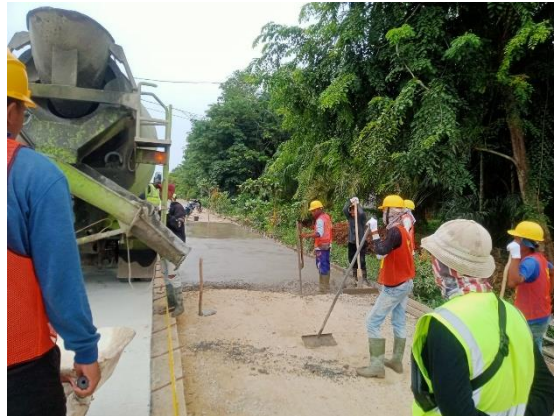
Gambar 3.6 Pengecoran Lc (Sumber : Dokumentasi Lapangan)
