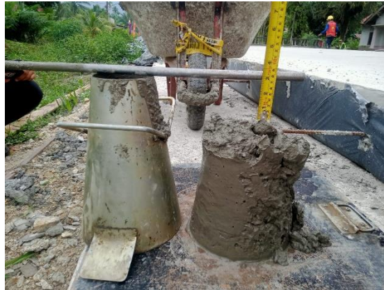
Gambar 3.24 pengujian slump (Sumber : Dokumentasi Lapangan)
