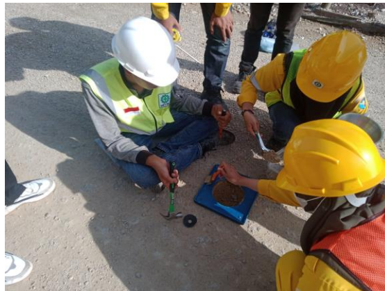
Gambar 3.2 Pengujian Sandcone (Sumber : Dokumentasi Lapangan)
