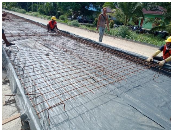
Gambar 3.12 Pemasangan Besi Wiremesh (Sumber : Dokumentasi Lapangan)
