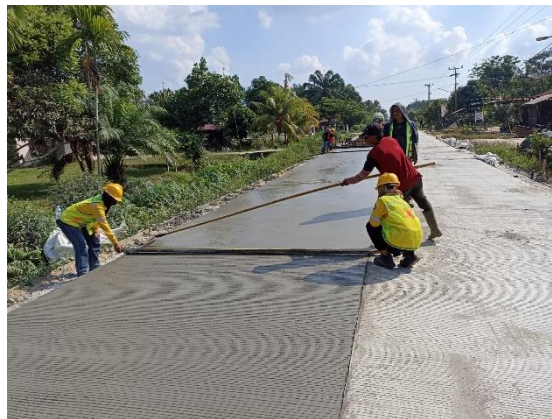
Gambar 3.15 Pekerjaan Grooving (Sumber : Dokumentasi Lapangan)
