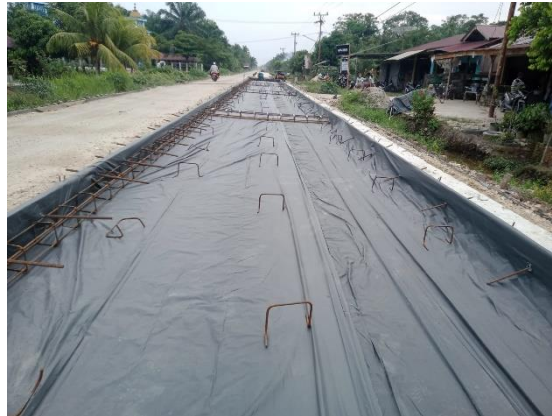
Gambar 4.3 Pekerjaan Pemasangan Dududkan Wiremesh (Sumber : Dokumentasi Lapangan)
