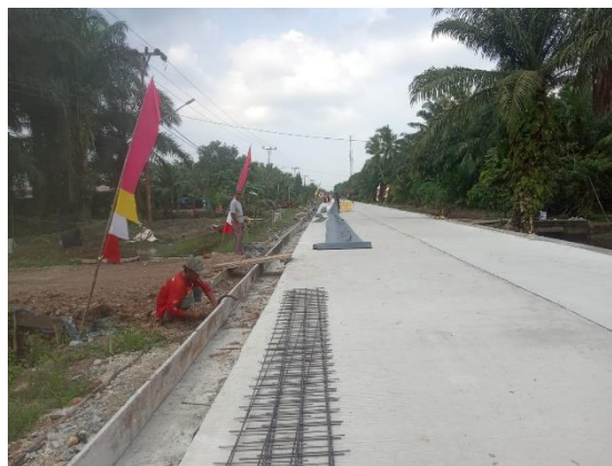
Gambar 3.21 Pekerjaan Pemasangan Bekisting (Sumber : Dokumentasi Lapangan)
