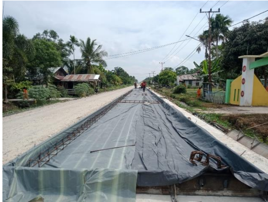
Gambar 3.8 Pemasangan Plastik Alas (Sumber : Dokumentasi Lapangan)
