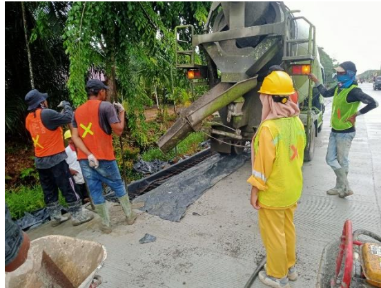
Gambar 3.23 Pekerjaan Pengecoran (Sumber : Dokumentasi Lapangan)
