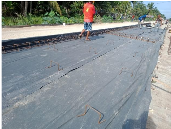
Gambar 3.9 Pemasangan Besi Dudukan (Sumber : Dokumentasi Lapangan)
