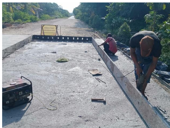
Gambar 3.7 Pemasangan Bekisting Rigid (Sumber : Dokumentasi Lapangan)
