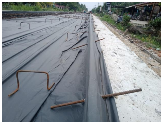
Gambar 4.1 Pekerjaan Pemasangan Angkur Bahu Jalan (Sumber : Dokumentasi Lapangan)
