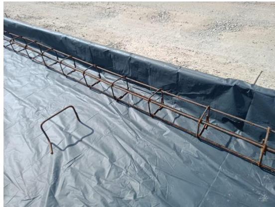
Gambar 4.2 Pekerjaan Pemasangan Tulangan Bangku (Sumber : Dokumentasi Lapangan)
