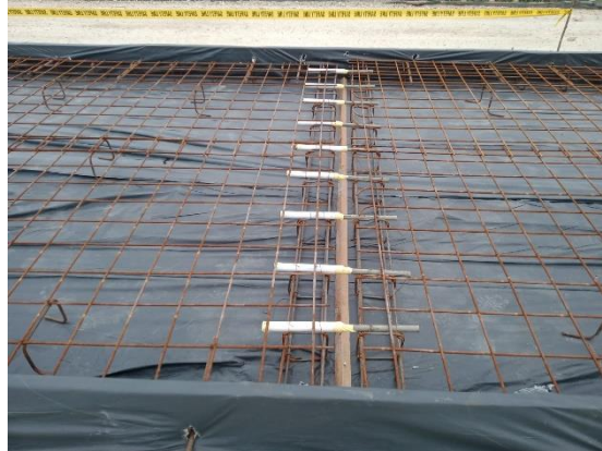
Gambar 4.6 Pekerjaan Pemasangan dowel (Sumber : Dokumentasi Lapangan)
