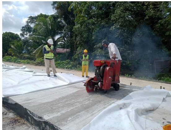
Gambar 3.19 Pekerjaan Cutting (Sumber : Dokumentasi Lapangan)
