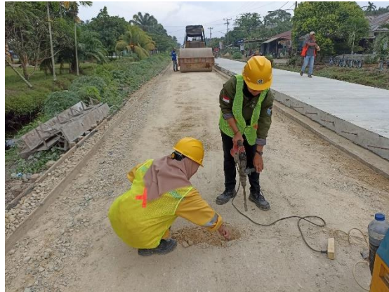
Gambar 3.3 Penge-core-an Base B (Sumber : Dokumentasi Lapangan)
