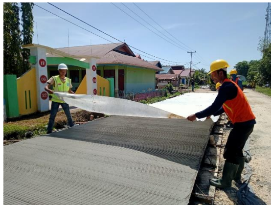
Gambar 3.17 Menutup Permukaan Beton dengan Geotex (Sumber : Dokumentasi Lapangan)
