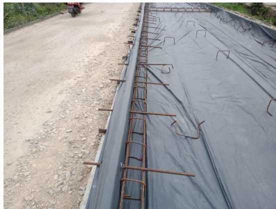
Gambar 4.5 Pekerjaan Pemasangan Tie Bar (Sumber : Dokumentasi Lapangan)
