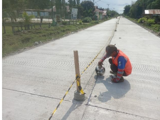
Gambar 3.20 Pekerjaan Joint Sealant (Sumber : Dokumentasi Lapangan)
