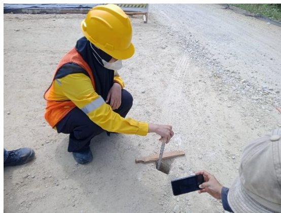
Gambar 3.4 Mengukur Kedalaman Penge-core-an (Sumber : Dokumentasi Lapangan)
