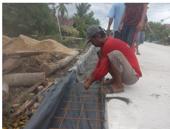
Gambar 3.22 Pekerjaan Pemasangan Tualangan (Sumber : Dokumentasi Lapangan)
