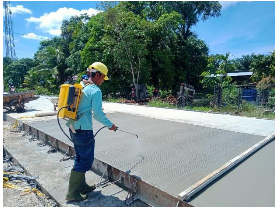
Gambar 3.16 Pekerjaan curing compound (Sumber : Dokumentasi Lapangan)
