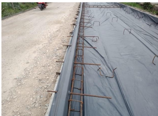
Gambar 3.10 Pemasangan Tul Bangku Dan Tie Bar (Sumber : Dokumentasi Lapangan)
