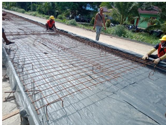
Gambar 4.4 Pekerjaan Pemasangan wiremesh (Sumber : Dokumentasi Lapangan)
