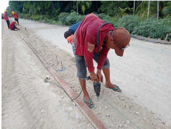
Gambar 3.5 Pemasangan Bekisting Lc (Sumber : Dokumentasi Lapangan)
