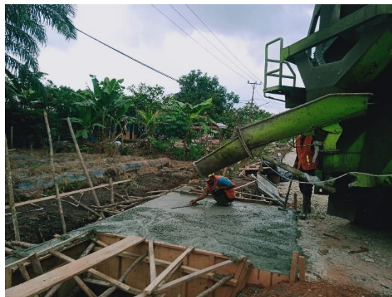
Gambar 3.1 pekerjaan box culvert (Sumber : Dokumentasi Lapangan)
