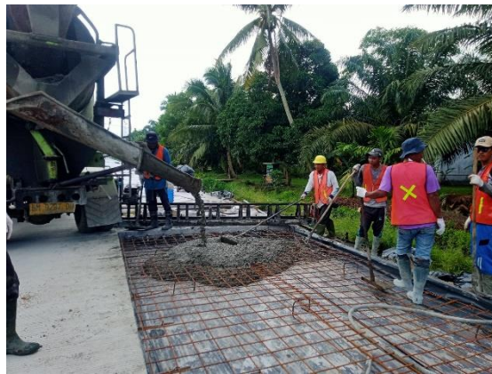
Gambar 3.13 Pengecoran Rigid (Sumber : Dokumentasi Lapangan)
