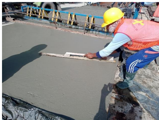
Gambar 3.14 Diratakan Menggunakan Ruskam (Sumber : Dokumentasi Lapangan)
