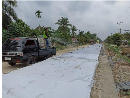
Gambar 3.18 Pekerjaan Penyiraman Beton (Sumber : Dokumentasi Lapangan)
