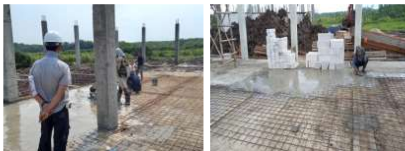
Gambar 3.14 17 Pengecoran lantai
