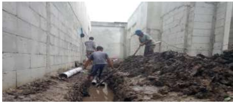
Gambar 3.14 22 Pekerjaan pembobokan untuk jalur pipa air kotor
