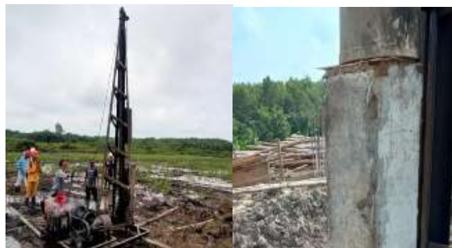
Gambar 3 7 Pemencangan TiangPancang
