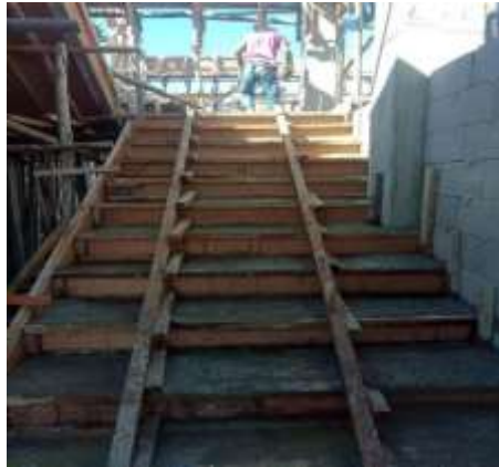
Gambar 3.14 6 Pekerjaan Pengecoran Tangga
