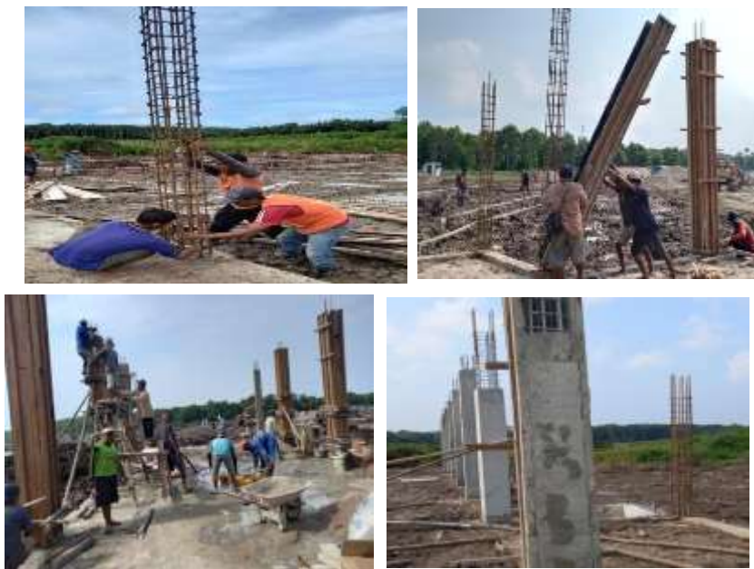
Gambar 3.14 5 Proses Pekerjaan kolom
