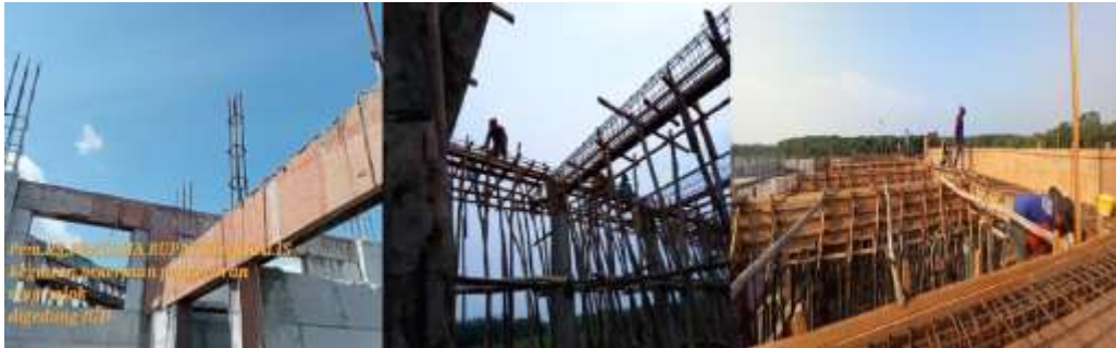
Gambar 3.14 8 Pekerjaan ring balok ( Sumber : Dokumentasi Pribadi 2023)
