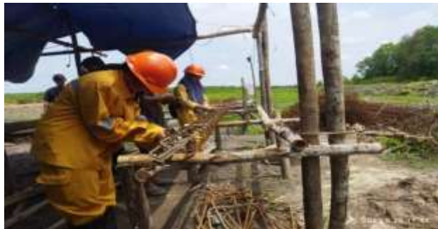
Gambar 3 1 Perakitan tulangan straupile
