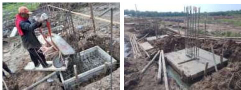
Gambar 3.14 2 Pengecoran Pilecape
