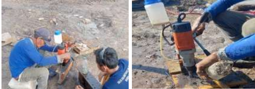
Gambar 3.14 11 pekerjaan pengeboran lobang untuk sambungan baut
