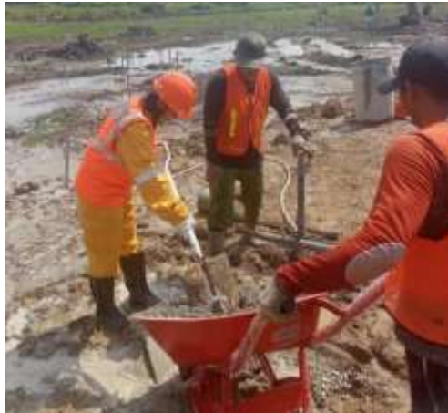
Gambar 3 4 Pengecoran Strausspile
