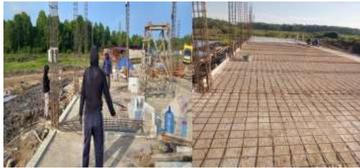
Gambar 3.14 15 Pemasangan besi warmes
