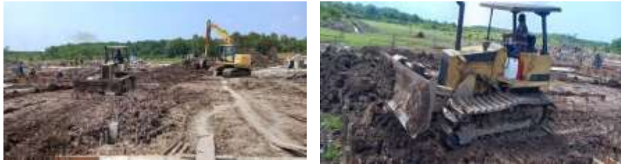
Gambar 3.3 Proses Perataan Jalan
