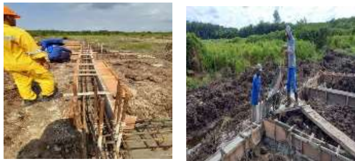
Gambar 3.14 4 Proses Pekerjaan Balok Sloof
