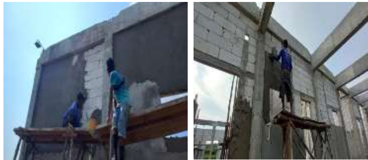
Gambar 3.14 20 Pekerjaan plasteran dinding
