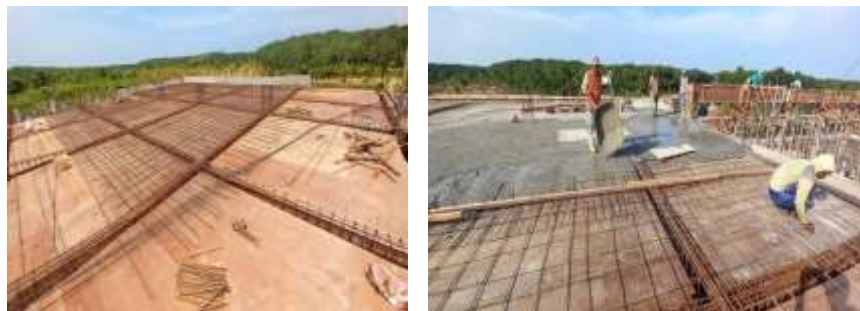
Gambar 3.14 7 Pekerjaan perakitan tulangan & pengecoran plat lantai
