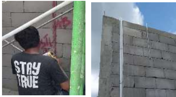
Gambar 3.14 24 Pekerjaan pembobokan & pemasangan pipa listrik
