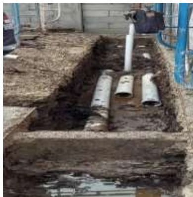
Gambar 3.14 23 Pekerjaan pemasangan pipa air kotor & air bersih
