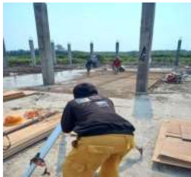
Gambar 3.14 16 survey top cor elv. Lantai
