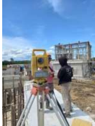
Gambar 3.14 9 Survey as pada ring balok
