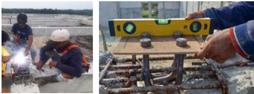
Gambar 3.14 10 Perakitan dan Pemasangan angkur
