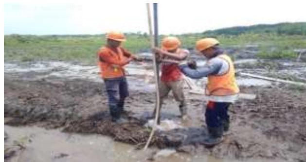
Gambar 3 3 Pengeboran Tanah
