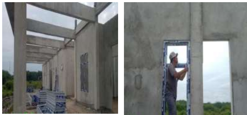
Gambar 3.14 19 Pekerjaan pemasangan kusen.
