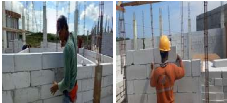
Gambar 3.14 18 Pemasangan bata
