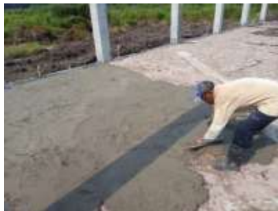
Gambar 3.14 14 Pengecoran untuk lantai kerja
