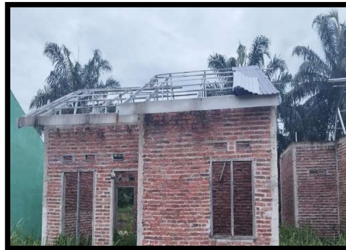
Gambar 3.8 Pekerjaan Rangka Atap
