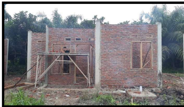
Gambar 3.6 Pemasangan Bata
