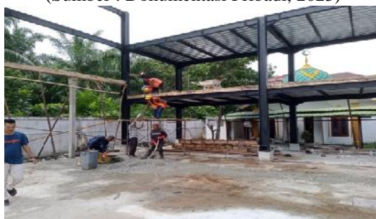
Gambar 3.22 Pengecoran plat lantai tingkat 2 (Sumber : Dokumentasi Pribadi, 2023)
