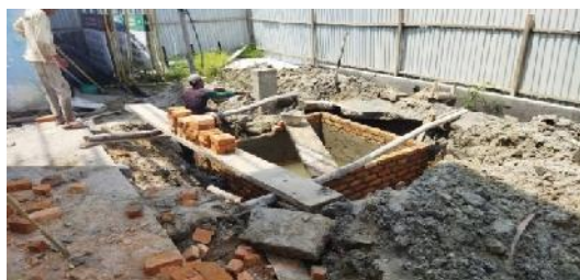
Gambar 3.41 Pembuatan Septic Tank (Sumber : Dokumentasi Pribadi, 2023)
