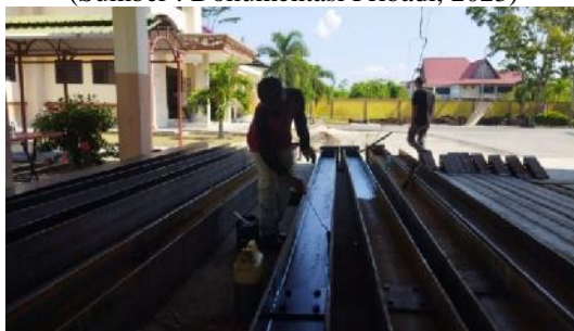
Gambar 3.6 Pengecatan H Beam (Sumber : Dokumentasi Pribadi, 2023)
