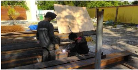
Gambar 3.4 Pengelasan pada H Bem (Sumber : Dokumentasi Pribadi, 2023)
