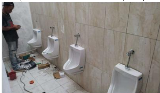
Gambar 3.44 Pemasangan urinoir (Sumber : Dokumentasi Pribadi, 2023)
