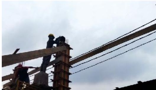
Gambar 3.12 Pengecoran Kolom (Sumber : Dokumentasi Pribadi, 2023)
