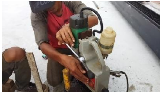
Gambar 3.14 Pembuatan lubang baut pada Besi WF (Sumber : Dokumentasi Pribadi, 2023)
