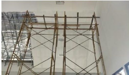
Gambar 3.39 Pemasangan lampu (Sumber : Dokumentasi Pribadi, 2023)
