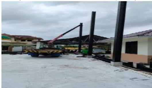
Gambar 3.9 Pemasangan kolom H Beam (Sumber : Dokumentasi Pribadi, 2023)
