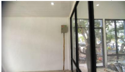
Gambar 3.40 Pemasangan Box Panel (Sumber : Dokumentasi Pribadi, 2023)
