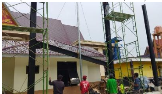
Gambar 3.16 Pemasangan balok Besi WF (Sumber : Dokumentasi Pribadi, 2023)
