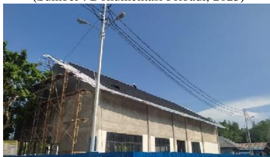
Gambar 3.35 Pemasangan penutup atap (Sumber : Dokumentasi Pribadi, 2023)
