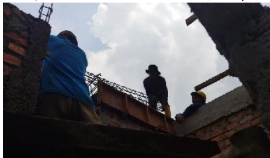
Gambar 3.18 Pemasangan bekisting dan tulangan balok (Sumber : Dokumentasi Pribadi, 2023)
