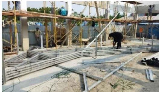
Gambar 3.33 Fabrikasi kuda-kuda atap (Sumber : Dokumentasi Pribadi, 2023)
