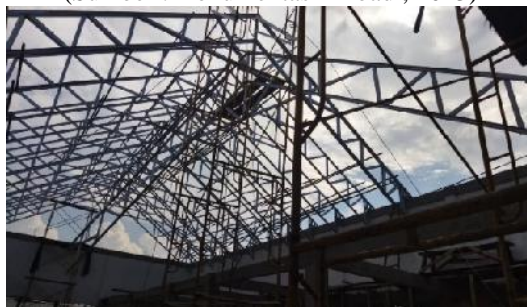
Gambar 3.34 Pemasangan kuda-kuda (Sumber : Dokumentasi Pribadi, 2023)
