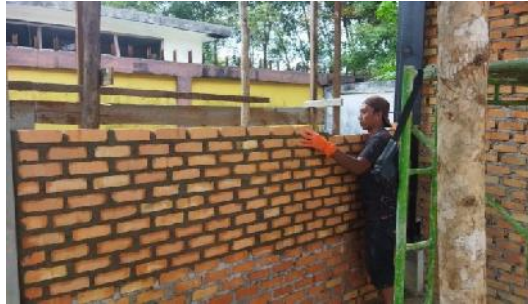
Gambar 3.23 Pemasangan dinding bata (Sumber : Dokumentasi Pribadi, 2023)
