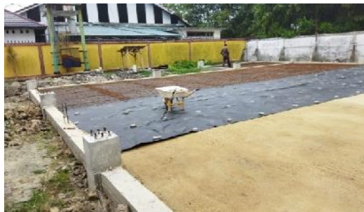
Gambar 3.20 Penulangan plat lantai (Sumber : Dokumentasi Pribadi, 2023)
