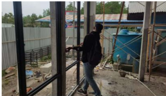
Gambar 3.51 Pengukuran kusen jendela (Sumber : Dokumentasi Pribadi, 2023)
