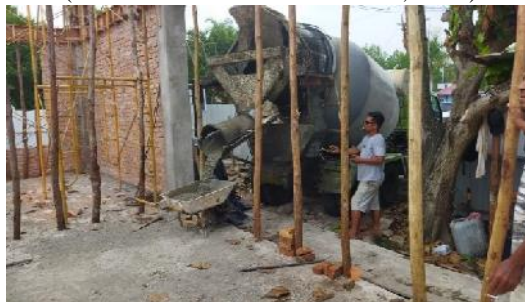
Gambar 3.11 Concrete Truck Mixer (Sumber : Dokumentasi Pribadi, 2023)
