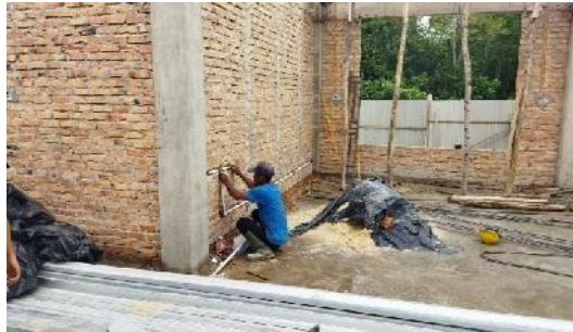
Gambar 3.42 Instalasi pipa (Sumber : Dokumentasi Pribadi, 2023)
