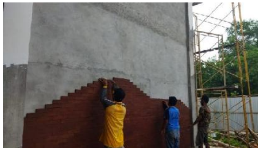
Gambar 3.47 Pemasangan batu Teracota (Sumber : Dokumentasi Pribadi, 2023)
