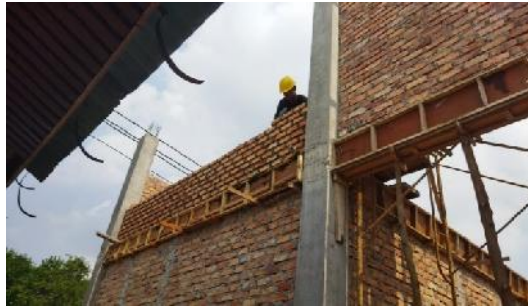
Gambar 3.26 Pemasangan bata (Sumber : Dokumentasi Pribadi, 2023)
