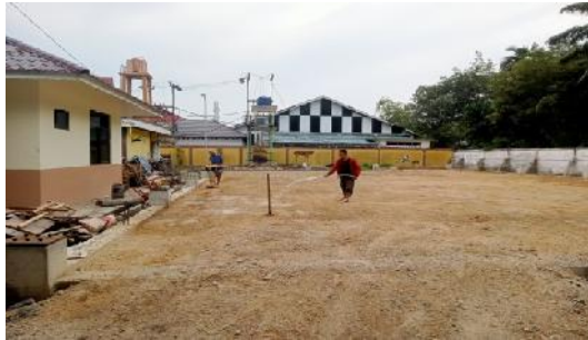
Gambar 3.2 Pematatan menggunakan stamper kuda (Sumber : Dokumentasi Pribadi, 2023)
