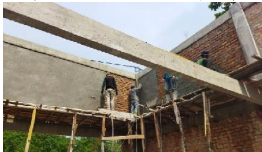
Gambar 3.27 Plasteran dinding (Sumber : Dokumentasi Pribadi, 2023)
