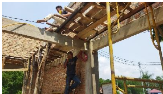
Gambar 3.37 Pemasangan kabel (Sumber : Dokumentasi Pribadi, 2023)
