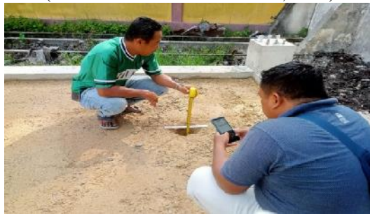
Gambar 3.50 Pengukuran tebal tanah urugan (Sumber : Dokumentasi Pribadi, 2023)
