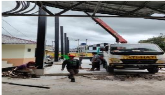
Gambar 3.8 Mobile Crane (Sumber : Dokumentasi Pribadi, 2023)
