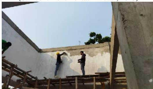
Gambar 3.28 Plamir dinding (Sumber : Dokumentasi Pribadi, 2023)
