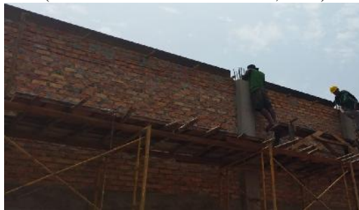
Gambar 3.19 pengecoran balok (Sumber : Dokumentasi Pribadi, 2023)
