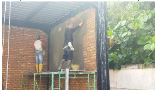
Gambar 3.24 Plasteran dinding bata (Sumber : Dokumentasi Pribadi, 2023)
