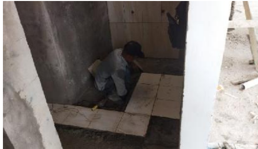
Gambar 3.46 Pemasangan keramik toilet (Sumber : Dokumentasi Pribadi, 2023)
