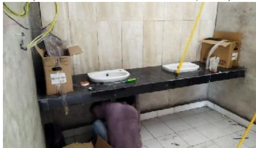
Gambar 3.43 Pemasangan westafel (Sumber : Dokumentasi Pribadi, 2023)
