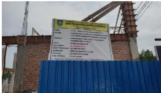
Gambar 2.5 Papan Proyek Ruang Tunggu Roro (Sumber : Dokumentasi Pribadi, 2023)
