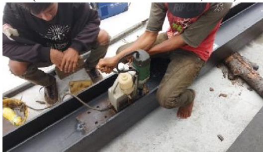
Gambar 3.5 Pembuatan lubang baut pada H Beam (Sumber : Dokumentasi Pribadi, 2023)
