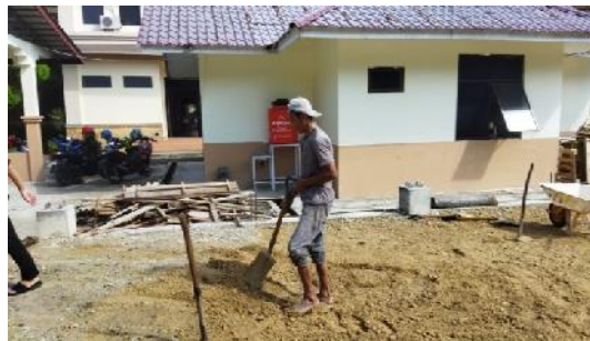
Gambar 3.1 Pengurugan tanah (Sumber : Dokumentasi Pribadi, 2023)
