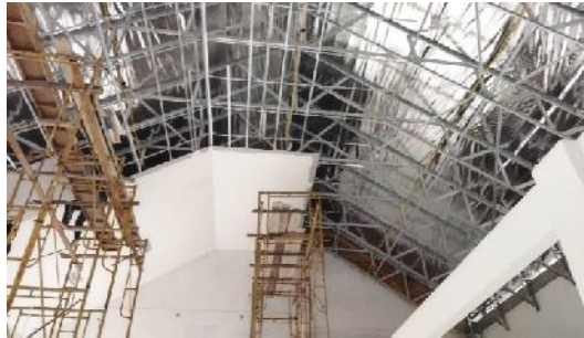
Gambar 3.36 Pemasangan plafond (Sumber : Dokumentasi Pribadi, 2023)
