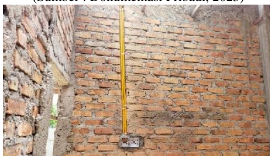
Gambar 3.38 Pemasangan stop kontak (Sumber : Dokumentasi Pribadi, 2023)
