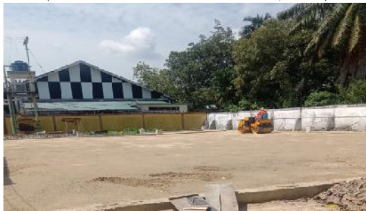
Gambar 3.3 Pematatan menggunakan Baby Roller (Sumber : Dokumentasi Pribadi, 2023)
