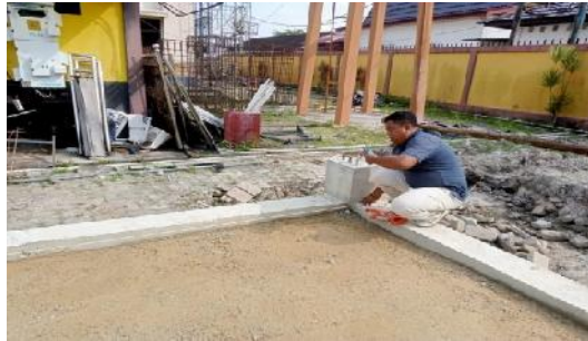
Gambar 3.49 Pengukuran jarak kolom pedestal (Sumber : Dokumentasi Pribadi, 2023)
