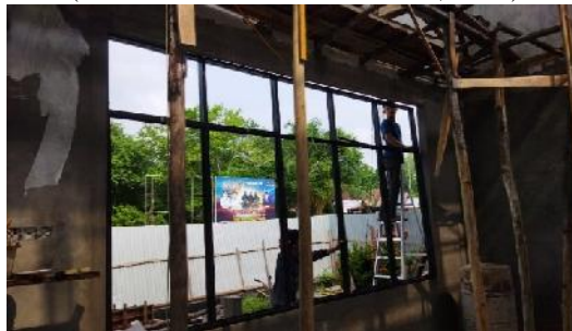
Gambar 3.30 Pemasangan kusen aluminium (Sumber : Dokumentasi Pribadi, 2023)
