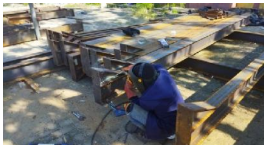
Gambar 3.13 Pengelasan pada Besi WF (Sumber : Dokumentasi Pribadi, 2023)
