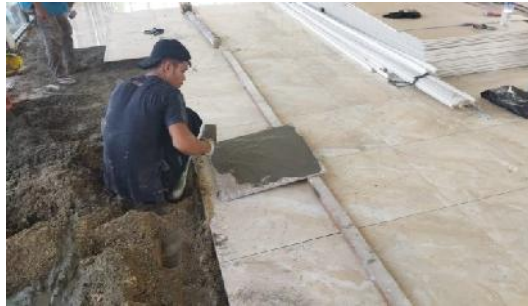
Gambar 3.45 Pemasangan granite ruangan utama (Sumber : Dokumentasi Pribadi, 2023)
