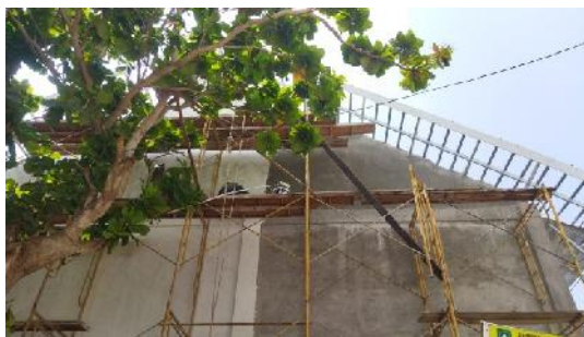
Gambar 3.48 Pengecatan (Sumber : Dokumentasi Pribadi, 2023)
