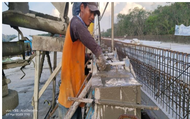
Gambar 4. 6 Pembongkaran Bekisting
