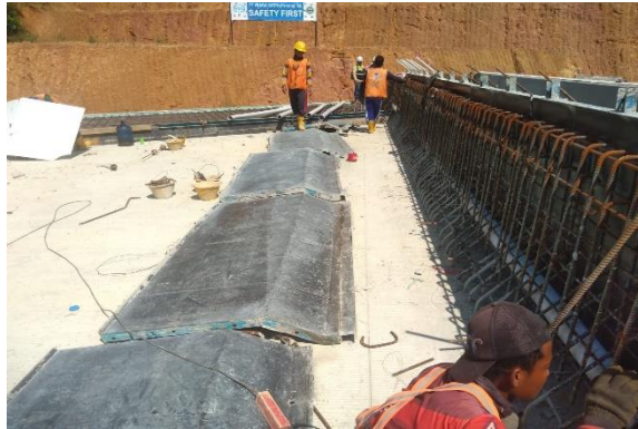
Gambar 4. 2 Pemasangan Bekisting
