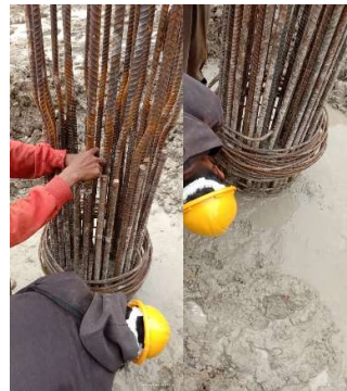
Gambar 3.58 Pekerjaan pemasangan tulangan sengkang Sumber: Dokumentasi lapangan, 2023
