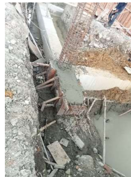
Gambar 3.53 Pekerjaan meratakan permukaan sloof
