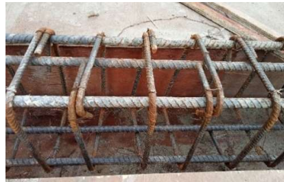
Gambar 3.78 Pekerjaan Pembesian Balok Sumber: Dokumentasi lapangan, 2023
