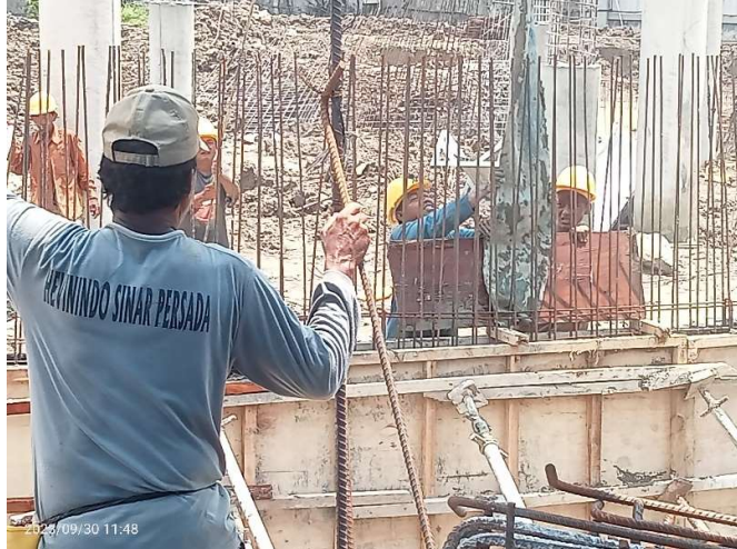
Gambar 3.51 Penuangan beton concrete f'c 25 Mpa ke bekisting sloof Sumber: Dokumentasi lapangan, 2023
