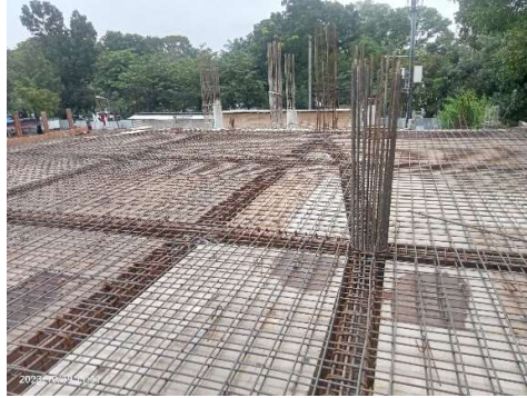
Gambar 3.80 Pekerjaan Pembesian Plat lantai Sumber: Dokumentasi lapangan, 2023
