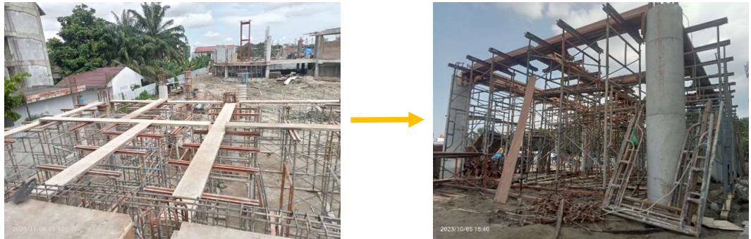
Gambar 3.73 Pekerjaan bekisting balok Sumber: Dokumentasi lapangan, 2023
