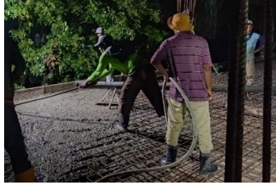
Gambar 3.83 Pekerjaan pengecoran balok & plat lantai Sumber: Dokumentasi lapangan, 2023
