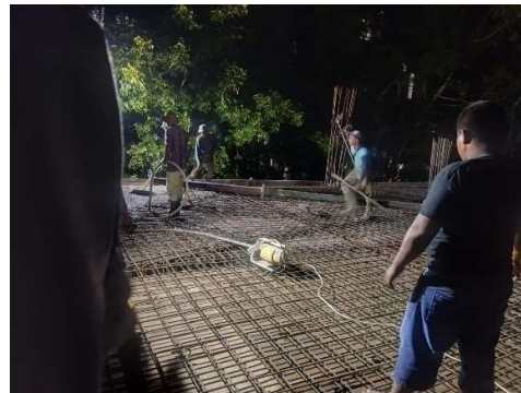
Gambar 3.84 Pekerjaan pengecoran balok & plat lantai Sumber: Dokumentasi lapangan, 2023
