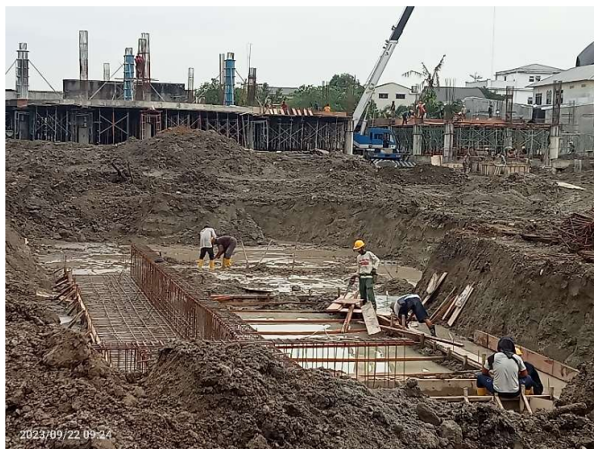
Gambar 3.34 Pemasangan bekisting tapak Sumber: Dokumentasi lapangan, 2023
