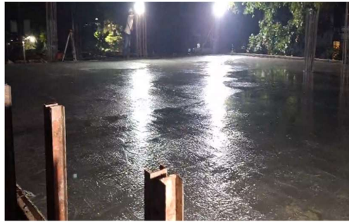
Gambar 3.85 Pekerjaan pengecoran balok & plat lantai Sumber: Dokumentasi lapangan, 2023
