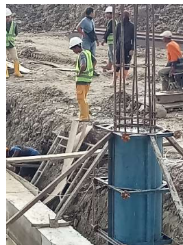
Gambar 3.68 Pekerjaan pengecoran kolom Sumber: Dokumentasi lapangan, 2023
