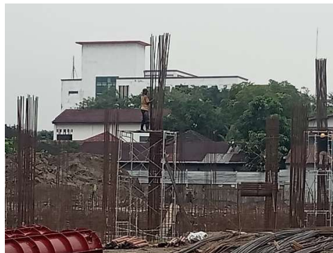
Gambar 3.59 Pemasangan tulangan sengkang +4m Sumber: Dokumentasi lapangan, 2023
