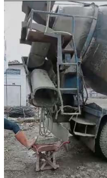
Gambar 3.10 Pengambilan sample uji slump dari truck mixer Sumber; Dokumentasi Lapangan,2023
