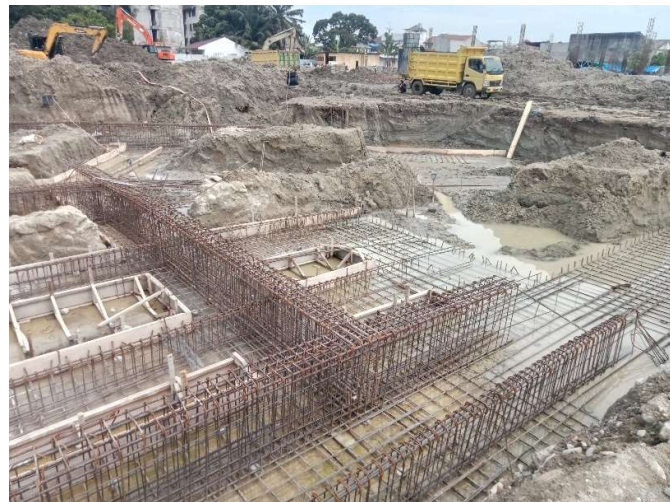
Gambar 3.45 Pekerjaan penulangan sloof Sumber: Dokumentasi lapangan, 2023
