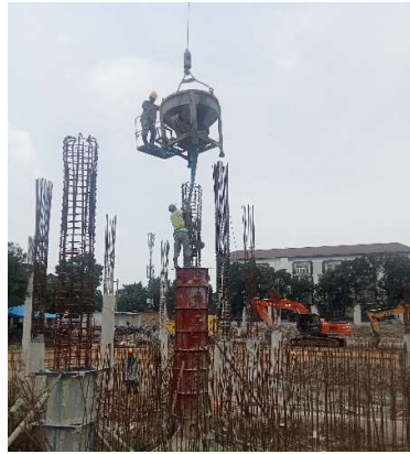
Gambar 3.65 Penuangan beton concrete ke dalam bucket cor Sumber: Dokumentasi lapangan, 2023
