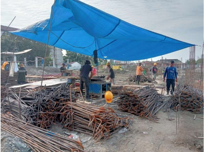
Gambar 3.76 Pekerjaan Pembesian Balok Sumber: Dokumentasi lapangan, 2023
