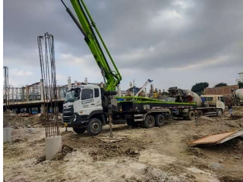
Gambar 3.81 Memposisikan concrete pump Sumber: Dokumentasi lapangan, 2023
