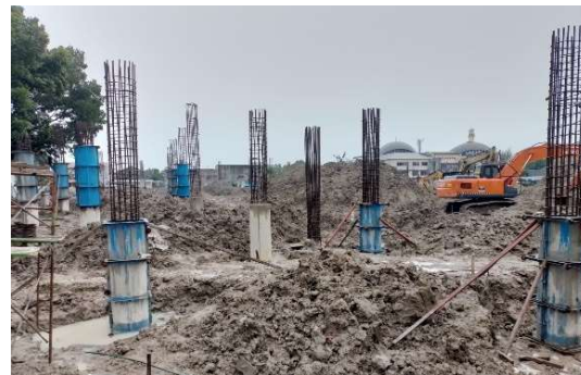
Gambar 3.63 Pemasangan bekisting kolom Sumber: Dokumentasi lapangan, 2023
