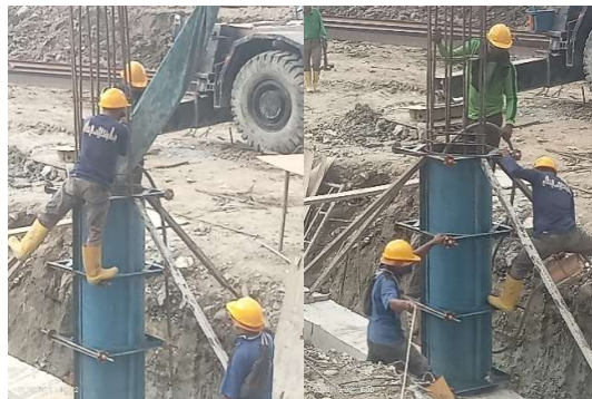
Gambar 3.66 Pekerjaan pengecoran kolom Sumber: Dokumentasi lapangan, 2023
