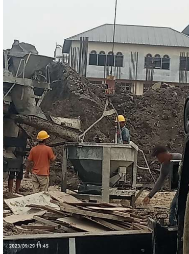
Gambar 3.50 Penuangan beton concrete f'c 25 mpa Sumber: Dokumentasi lapangan, 2023
