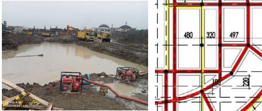
Gambar 3.86 Kondisi galian pondasi pada zona B Sumber; Dokumentasi Lapangan,2023
