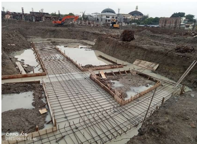
Gambar 3.35 Pekerjaan penulangan tapak
