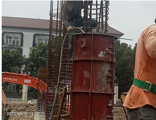
Gambar 3.67 Pekerjaan pengecoran dan vibrator beton concrete f'c 25 Sumber: Dokumentasi lapangan, 2023
