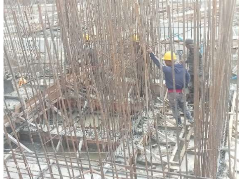
Gambar 3.54 Pekerjaan pengecoran sloof Sumber: Dokumentasi lapangan, 2023
