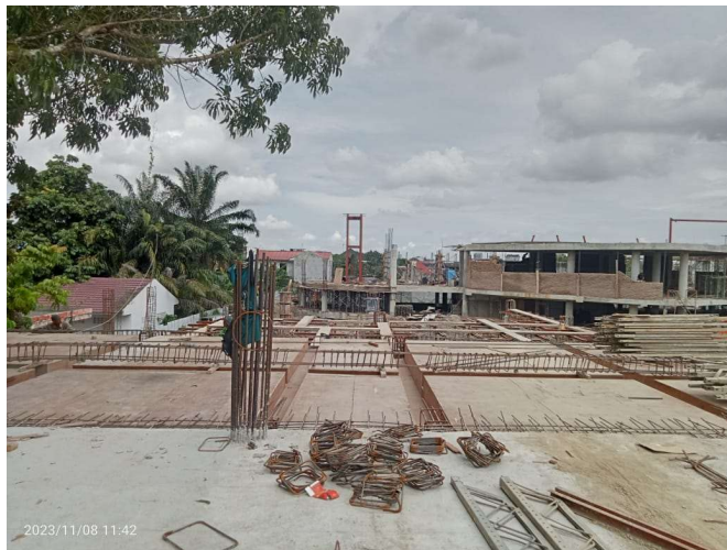
Gambar 3.79 Pekerjaan Pembesian Plat lantai Sumber: Dokumentasi lapangan, 2023
