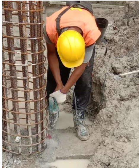
Gambar 3.60 Pengeboran tumpuan bekisting Sumber: Dokumentasi lapangan, 2023
