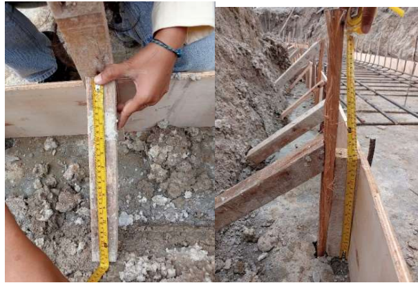
Gambar 3.33 Pemasangan bekisting tapak Sumber: Dokumentasi lapangan, 2023
