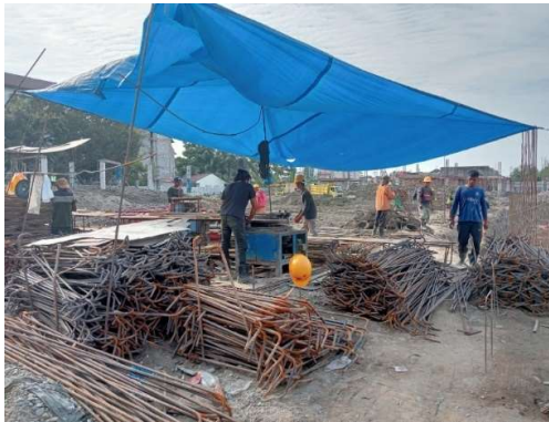
Gambar 3.46 Pabrikasi tulangan Sumber: Dokumentasi lapangan, 2023
