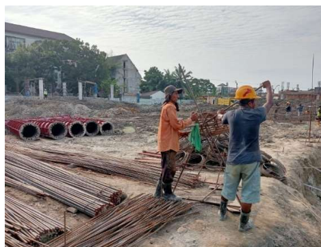
Gambar 3.57 Pekerjaan pembekokkan tulangan Sengkok kolom
