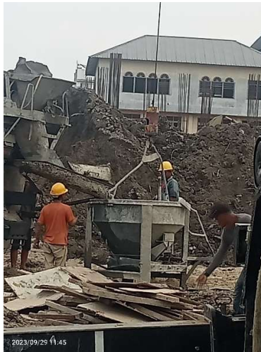
Gambar 3.48 Penuangan beton concrete f'c 25 Sumber: Dokumentasi lapangan, 2023
