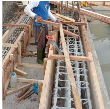
Gambar 3.50 Pemasangan bekisting sloof Sumber: Dokumentasi lapangan, 2023
