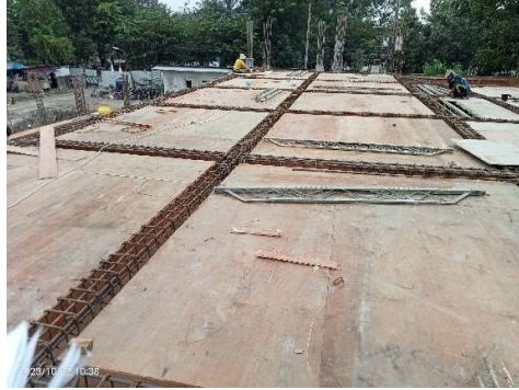
Gambar 3.77 Pekerjaan Pembesian Balok Sumber: Dokumentasi lapangan, 2023
