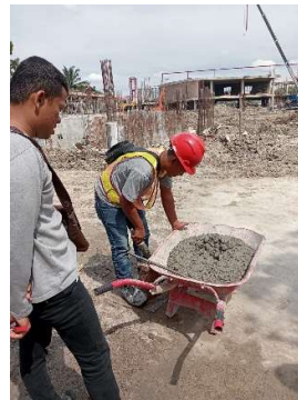
Gambar 3.11 Penuangan beton concrete ke dalam kerucut Sumber; Dokumentasi Lapangan,2023
