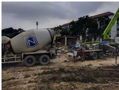
Gambar 3.82 Pemindahan beton concrete Sumber: Dokumentasi lapangan, 2023
