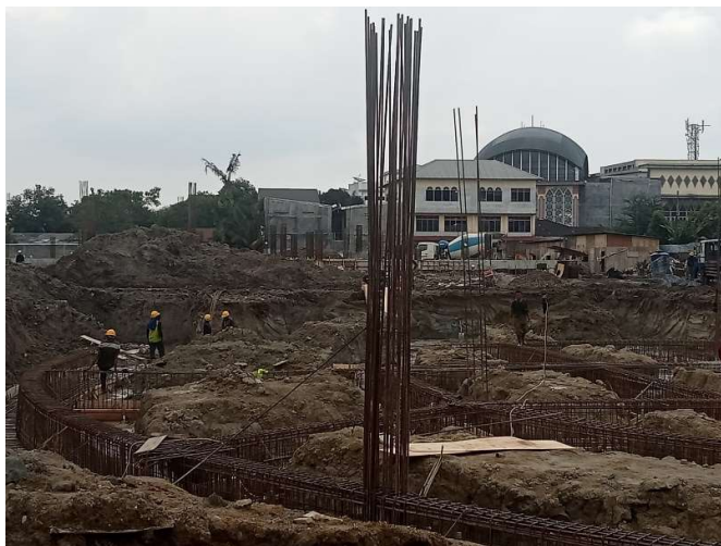
Gambar 3.47 Pekerjaan penulangan sloof Sumber: Dokumentasi lapangan, 2023
