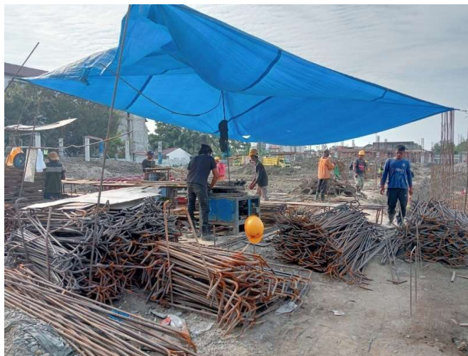
Gambar 3.39 Proses pabrikasi tulangan Sumber; PT. Karya-Agha, 2023
