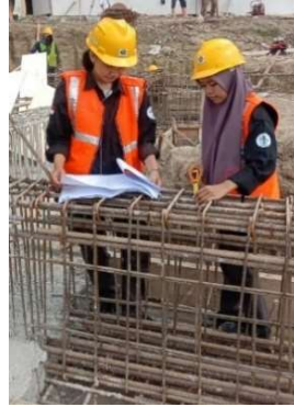
Gambar 3.44 Pengecekan tulangan sloof Sumber: Dokumentasi lapangan, 2023
