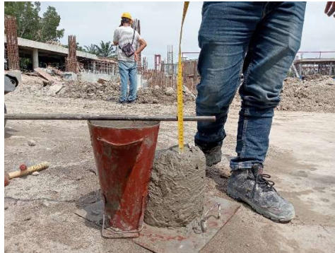
Gambar 3.14 Pengukuran tinggi jatuh sample slump Sumber; Dokumentasi Lapangan,2023
