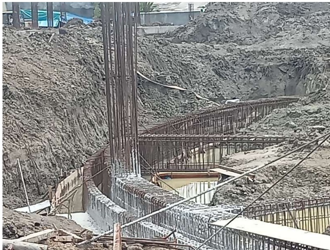
Gambar 3.45 Pekerjaan pengecoran tapak yang sudah kering Sumber: Dokumentasi lapangan, 2023
