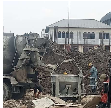
Gambar 3.64 Penuangan beton concrete ke dalam bucket cor Sumber: Dokumentasi lapangan, 2023
