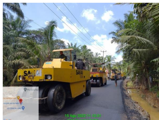
Gambar 3.16:Pekerjaan Pemadatan Akhir Aspal AC-WC Menggunakan Pneumatic Tire Roller Sumber : Dokumentasi lapangan, 2023
