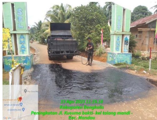
Gambar 3.13: Pekerjaan Prime Coat Sumber : Dokumentasi lapangan, 2023
