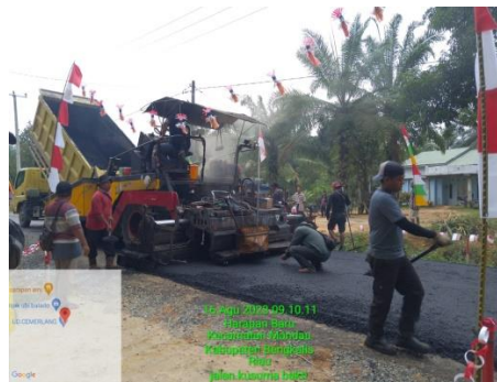
Gambar 4.2 : Penuangan lapisan AC-WC kebak mekanis Asphalt finisher Sumber : Dokumentasi lapangan, 2023
