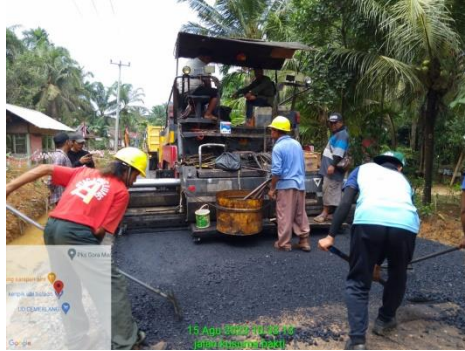
Gambar 4.5 : Pemerataan lapisan AC-WC menggunakan cheker Sumber : Dokumentasi lapangan, 2020
