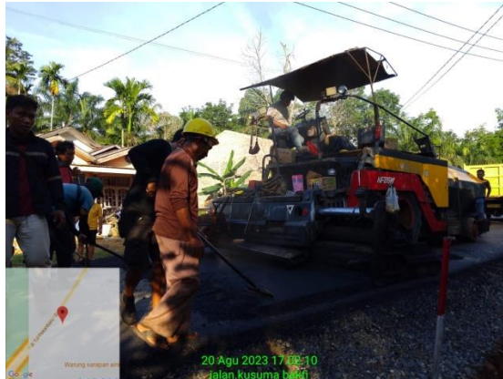
Gambar 3.14 : Pekerjaan Penghamparan Aspal AC-WC Sumber : Dokumentasi lapangan, 2023
