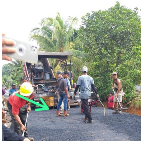
Gambar 4.4 : Pengecekan gembur hamparan AC-WC Sumber : Dokumentasi lapangan, 2023
