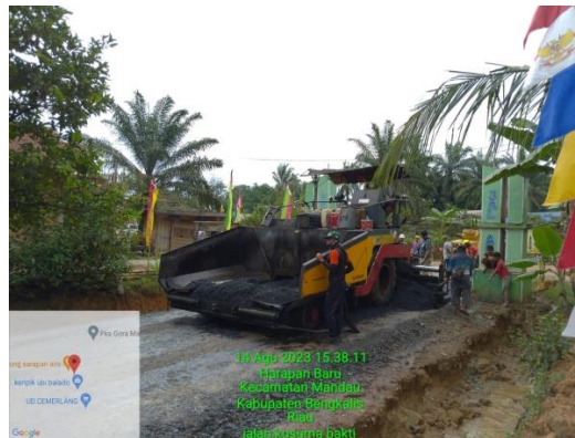
Gambar 3.9: asphalt pinisher Sumber : Dokumentasi lapangan, 2023
