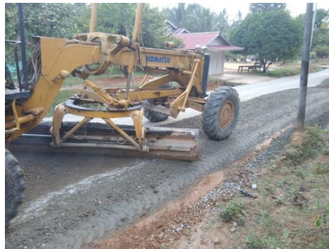
Gambar 3.12 : Pekerjaan Agregat Kelas A Sumber : Dokumentasi lapangan, 2023
