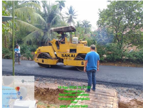
Gambar 4.6 : Pekerjaan Pemadatan Awal AC-WC Menggunakan Tandem Roller Sumber : Dokumentasi lapangan, 2020
