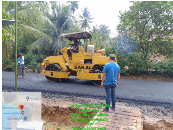
Gambar 3.15 : Pekerjaan Pemadatan Awal AC-WC Menggunakan Tandem Roller Sumber : Dokumentasi lapangan, 2023
