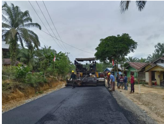
Gambar 4.3 : Penghamparan lapisan AC-WC menggunakan Asphalt finisher Sumber : Dokumentasi lapangan, 2023
