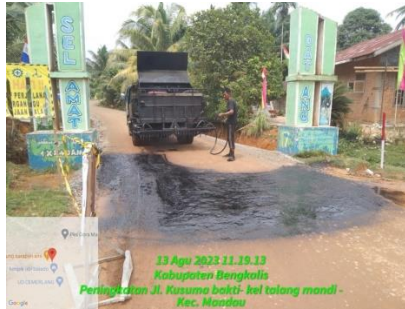
Gambar 4.1 : Pekerjaan Prime Coat Sumber : Dokumentasi lapangan, 2023
