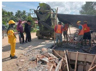
Gambar 3. 15 Pengecoran *Box Culvert*
