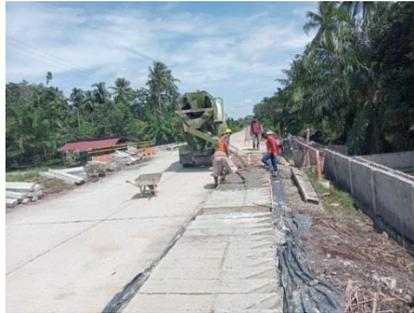
Gambar 3. 7 Pengecoran Balok Sisip
