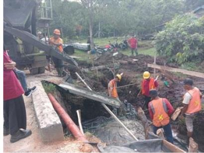
Gambar 3. 13 Pengecoran Lantai Kerja
