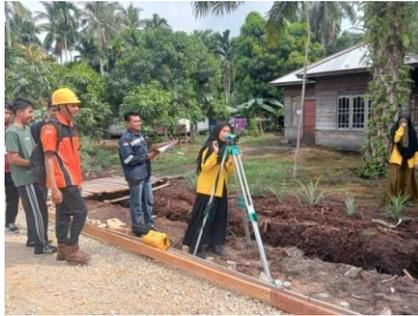
Gambar 3. 19 Pengukuran *Waterpass*
