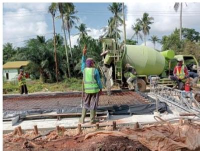
Gambar 3. 25 Pengecoran Rigid
