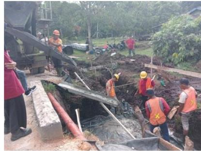
Gambar 4. 7 Pengecoran Lantai Kerja
