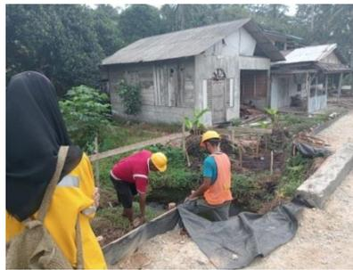
Gambar 4. 2 Pembuatan Tanda atau Patok
