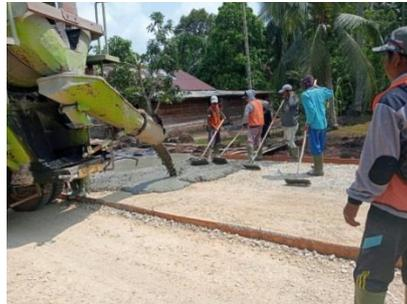
Gambar 3. 23 Pengecoran *LC*
