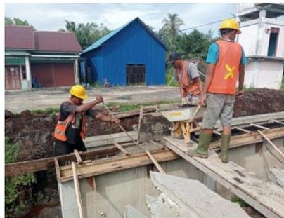
Gambar 3. 6 Pengecoran Balok Penutup
