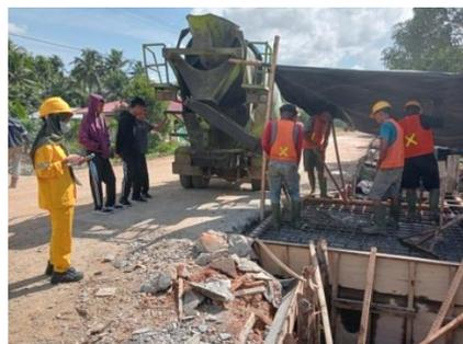
Gambar 4. 9 Pengecoran *Box Culvert*
