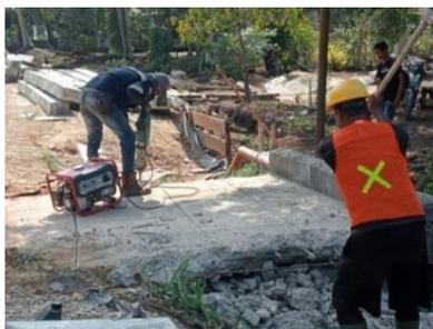
Gambar 3. 31 Proses Penghancuran Jembatan *Ekisting*
