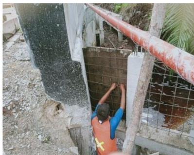
Gambar 3. 4 Pemasangan *Bekisting* Turap
