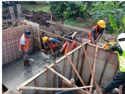
Gambar 3. 14 Pengecoran Plat Lantai
