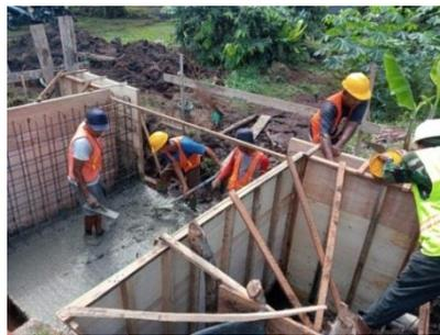
Gambar 4. 8 Pengecoran Plat Lantai
