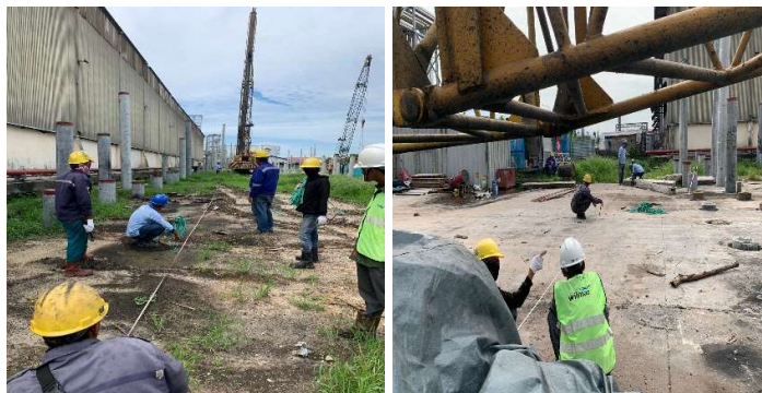
Gambar 3.5 Kegiatan Pengukuran Stake Out Sumber : Dokumentasi Pribadi
