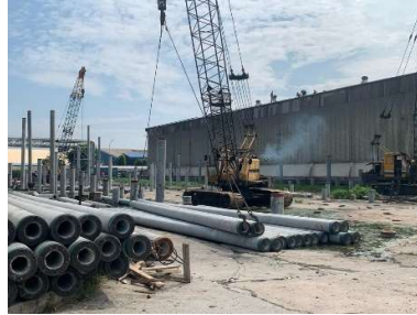
Gambar 3.7 Penempatan crane dan spun pile
