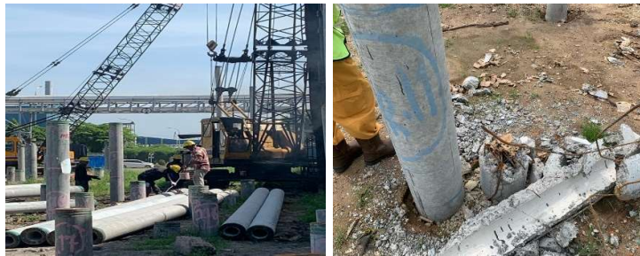
Gambar 3.18 Tiang Pancang Sisipan Sumber : Dokumentasi Pribadi
