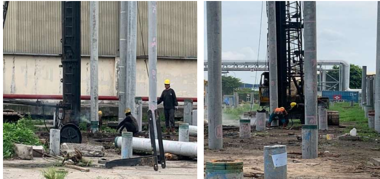
Gambar 3.16 Kegiatan Penyambungan Tiang Pancang
