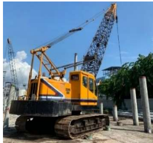
Gambar 3.22 Crane Crawler Sumber :Dokumentasi Pribadi
