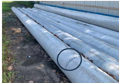
Gambar 3.10 Penentuan titik angkat Sumber : Dokumentasi Pribadi
