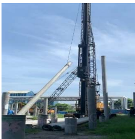
Gambar 3.13 Kegiatan Pengangkatan Tiang Pancang
