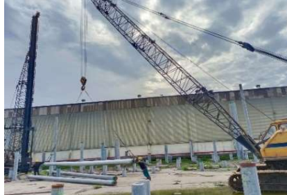
Gambar 3.9 Kegiatan Mobilisasi Lifting Spun Pile Sumber : Dokumentasi Pribadi
