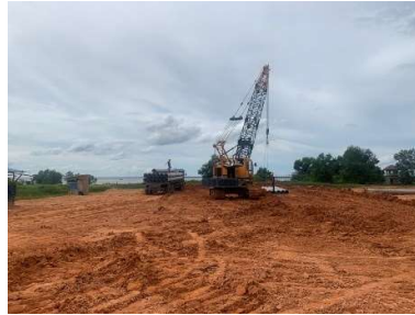
Gambar 3.2 Kegiatan Penimbunan Tanah
