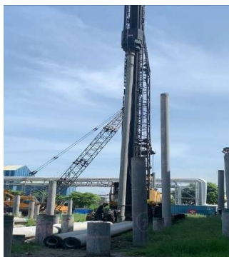
Gambar 3.14 Kegiatan Penyetelan Vertikal
