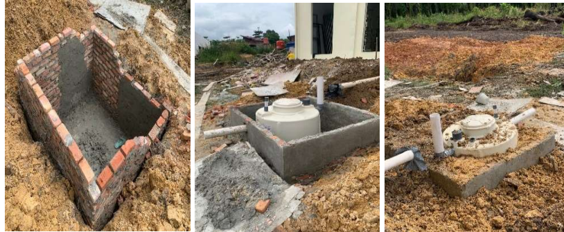
Gambar 3.34 Pekerjaan Septic Tank (Sumber : Dokumentasi Pribadi, 2023)
