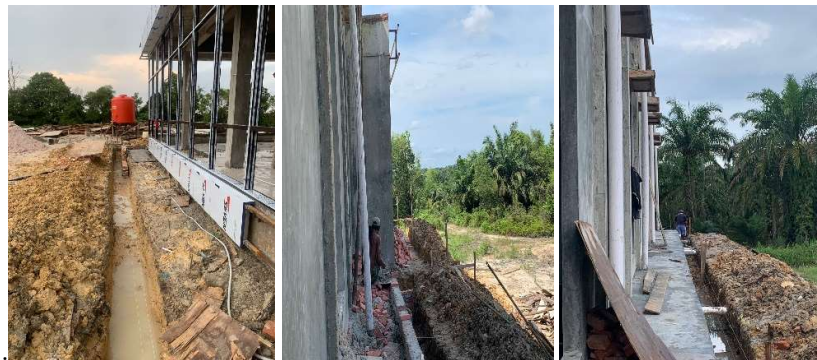
Gambar 3.27 Pekerjaan Rabat Keliling (Sumber : Dokumentasi Pribadi, 2023)
