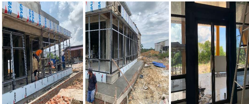
Gambar 3.29 Pekerjaan Pemasangan Kusen (Sumber : Dokumentasi Pribadi, 2023)
