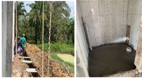
Gambar 3.24 Pekerjaan Pemasangan Sanitasi (Sumber : Dokumentasi Pribadi, 2023)
