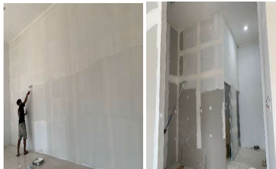
Gambar 3.33 Pekerjaan Pengecatan (Sumber : Dokumentasi Pribadi, 2023)
