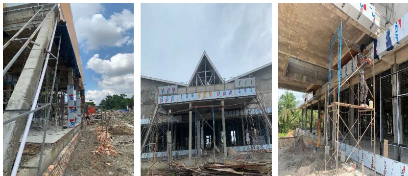
Gambar 3.19 Pekerjaan Pemasangan ACP Bangunan (Sumber : Dokumentasi Pribadi, 2023)
