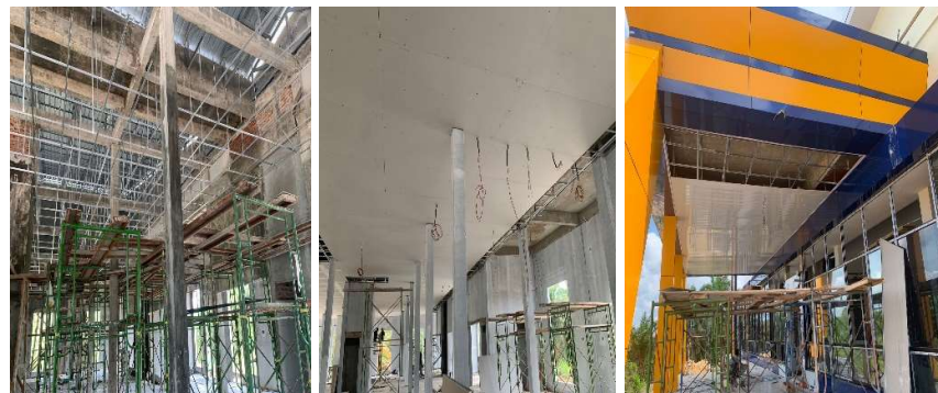
Gambar 3.15 Pekerjaan Pemasangan Plafon (Sumber : Dokumentasi Pribadi, 2023)
