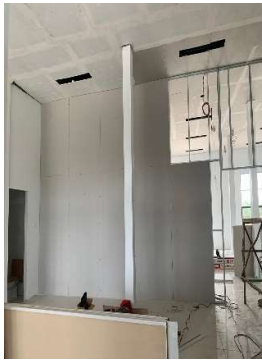
Gambar 3.10 Pemasangan dinding partisi (Sumber : Dokumentasi Pribadi, 2023)
