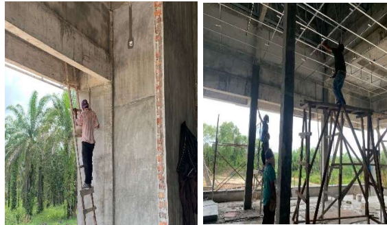
Gambar 3.22 Pekerjaan Pemasangan Instalasi Listrik (Sumber : Dokumentasi Pribadi, 2023)
