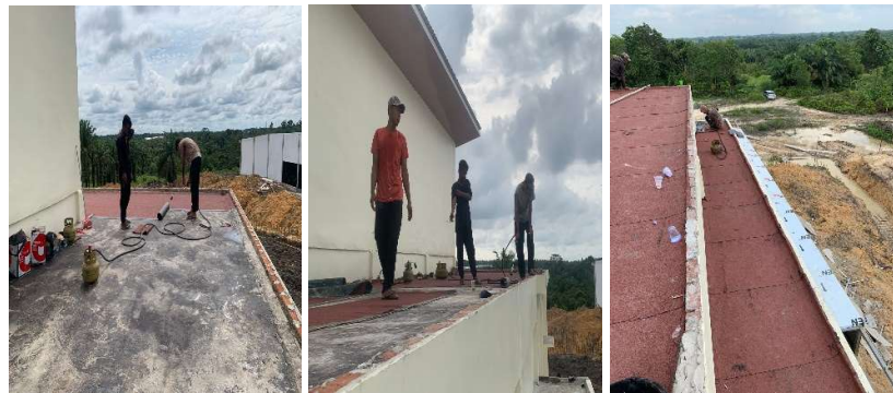
Gambar 3.20 Pekerjaan Pemasangan Waterproofing Membran (Sumber : Dokumentasi Pribadi, 2023)
