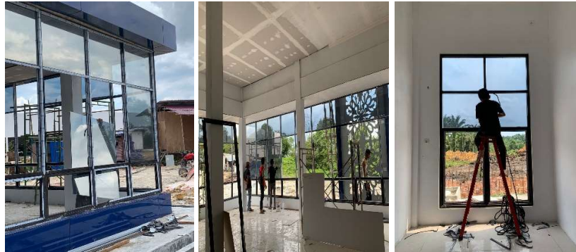
Gambar 3.32 Pekerjaan Pemasangan Kaca (Sumber : Dokumentasi Pribadi, 2023)
