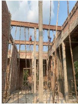
Gambar 3.3 Pemasangan bekisting balok (Sumber : Dokumentasi Pribadi, 2023)
