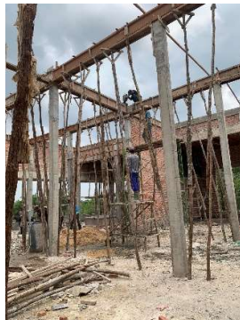
Gambar 3.4 Pemasangan tulangan balok (Sumber : Dokumentasi Pribadi, 2023)
