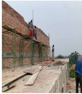
Gambar 3.7 Pemasangan batu bata non struktural (Sumber : Dokumentasi Pribadi, 2023)
