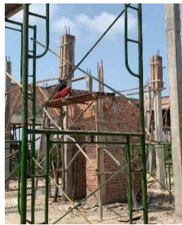
Gambar 3.8 Pemasangan batu bata struktural (Sumber : Dokumentasi Pribadi, 2023)
