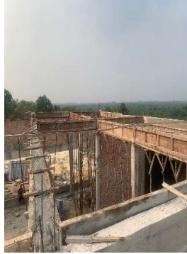
Gambar 3.5 Pengecoran balok (Sumber : Dokumentasi Pribadi, 2023)
