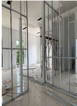
Gambar 3.9 Pemasangan kerangka dinding partisi (Sumber : Dokumentasi Pribadi, 2023)
