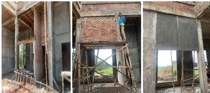
Gambar 3.6 Pekerjaan balok Latei (Sumber : Dokumentasi Pribadi, 2023)
