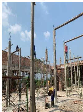
Gambar 3.2 Pekerjaan kolom (Sumber : Dokumentasi Pribadi, 2023)
