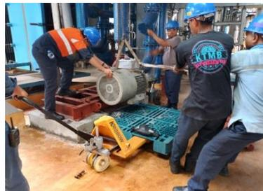
Gambar 2. 10 Pemasangan Motor Di Bd6
