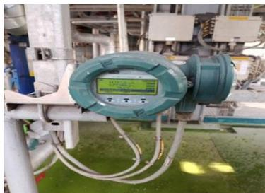
Gambar 2. 20 Cek Flow Rate Yang Error Tidak Terbaca Ketika Ada Aliran
