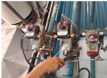
Gambar 2. 18 Memperbaiki Selenoid Dan Valve Yang Macet
