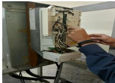
Gambar 2. 15 Ganti Papan Pcb Boar Vfd Yang Tidak Berfungsi
