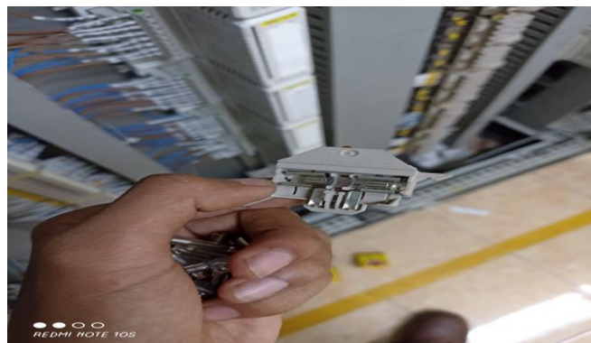
Gambar 2. 7 Mengganti fuse yang terputus
