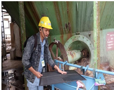
Gambar 2. 13 Pembersihan filter ac
