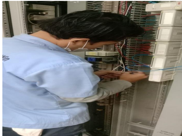
Gambar 2. 8 Menambah kabel indikasi
