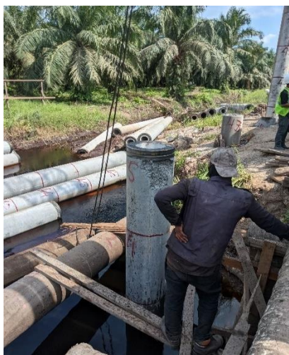
Gambar 4.10 Pengecekan Tiang Pancang ( Sumber : Dokumentasi Lapangan )
