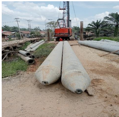
Gambar 4.25 Tiang Pancang Bagian Bawah ( Pensil ) ( Sumber : Dokumentasi Lapangan )
