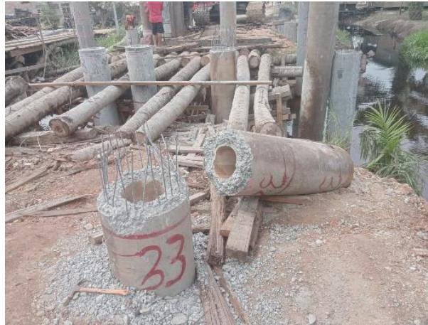
Gambar 3.4 Pemotongan Tiang Pancang ( Sumber : Dokumentasi Lapangan )
