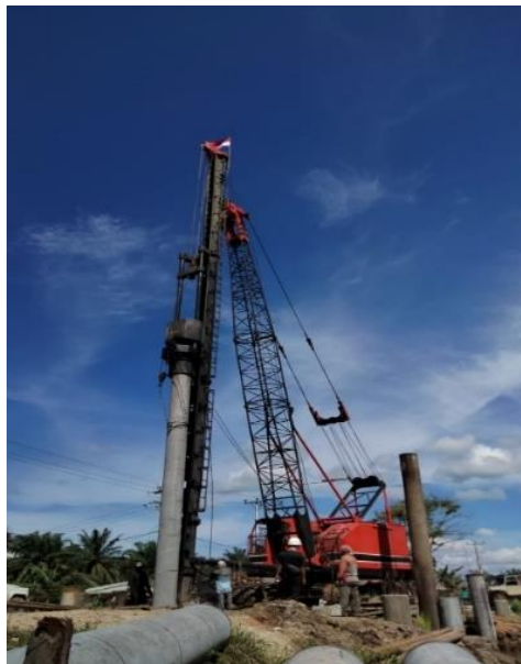
Gambar 3.1 Pemancangan Tiang Pancang ( Sumber : Dokumentasi Lapangan )
