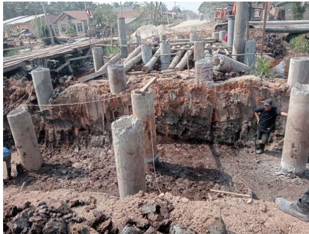
Gambar 3.7 Pondasi yang selesai Digali ( Sumber : Dokumentasi Lapangan )
