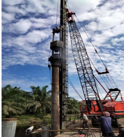
Gambar 4.7 Proses Pemukulan Tiang Pancang ( Sumber : Dokumentasi Lapangan )
