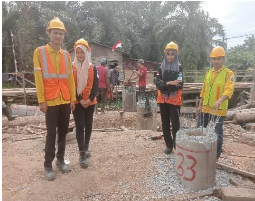
Gambar 4.20 Menggunakan Safety Saat Kerja Praktek ( Sumber : Dokumentasi Lapangan )
