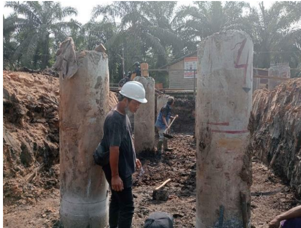
Gambar 3.6 Pemantauan didalam Lokasi Galian ( Sumber : Dokumentasi Lapangan )
