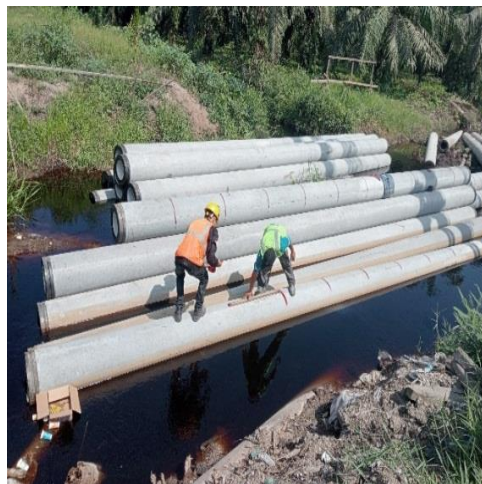
Gambar 4.26 Tiang Pancang Bagian Sambunngan ( Sumber : Dokumentasi Lapangan )
