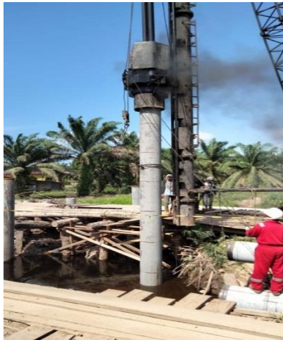
Gambar 4.9 Proses Pemancangan Lanjutan ( Sumber : Dokumentasi Lapangan )
