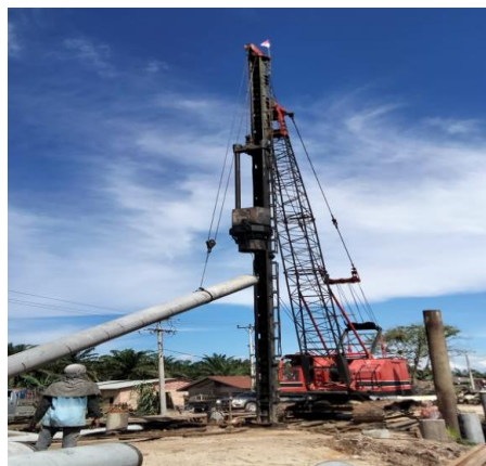
Gambar 4.4 Proses Pengangkatan Tiang Pancang Ke Diesel Hammer ( Sumber : Dokumentasi Lapangan )
