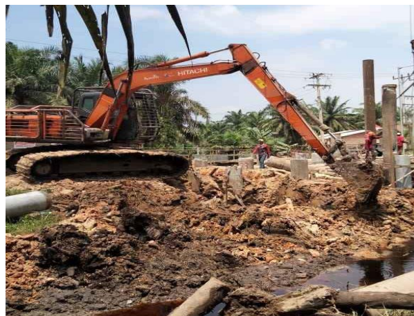
Gambar 3.5 Alat Berat Excavator ( Sumber : Dokumentasi Lapangan )
