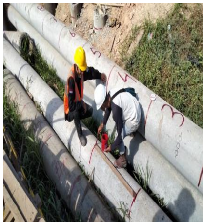
Gambar 4.8 Proses Pemberian Tanda Ukuran Tiang Pancang ( Sumber : Dokumentasi Lapangan )
