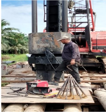
Gambar 4.5 Pengecekan Hammer Diesel ( Sumber : Dokumentasi Lapangan )
