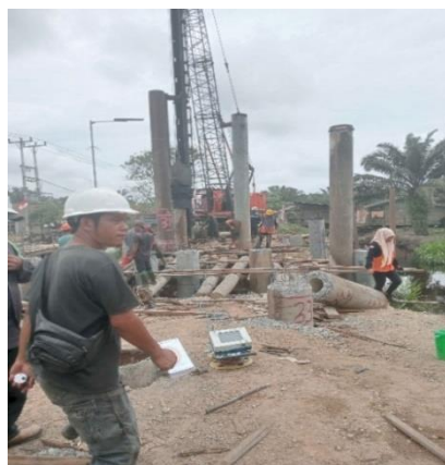
Gambar 4.12 PDA Test ( Sumber : Dokumentasi Lapangan )
