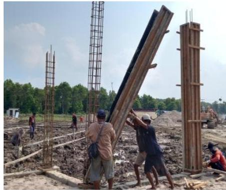
*Gambar 3.29 Proses pemasangan bekisting kolom
