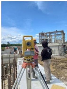
*Gambar 3.37 Pembedikan perletakkan anker baja
