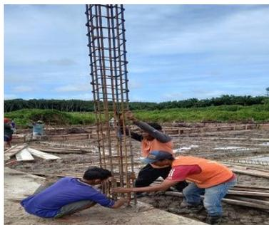
*Gambar 3.28 Proses pemasangan penulangan kolom*
