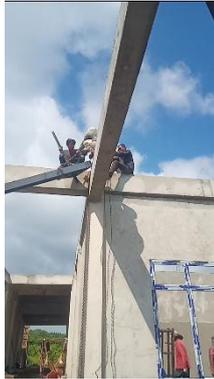
*Gambar 3.41 Pekerjaan erection rangka baja
