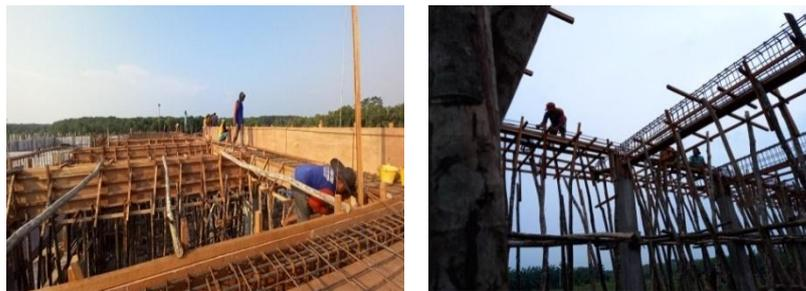
*Gambar 3.31 Pekerjaan ring balok
