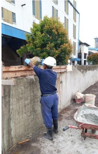
*Gambar 3.8 Pengecoran Balok Wall Controll
