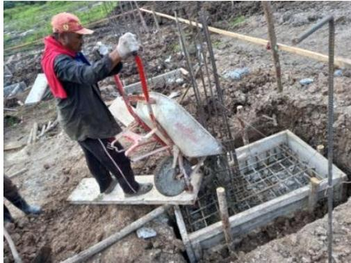
*Gambar 3.26 Pengecoran pondasi pile cap
