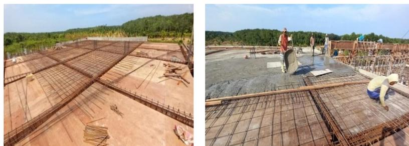
*Gambar 3.32 Pekerjaan perakitan tulangan & pengecoran plat lantai
