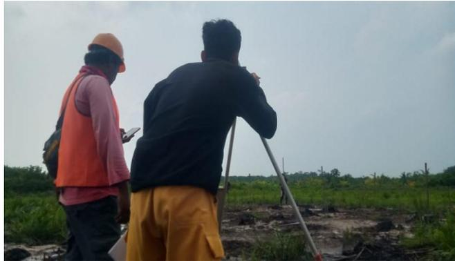
*Gambar 3.13 Survey Pemasangan Bouwplank
