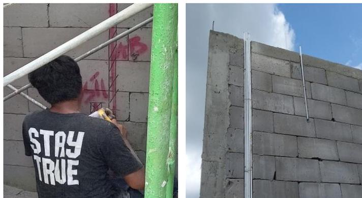
*Gambar 3.48 Pekerjaan pembobokan & pemasangan pipa listrik
