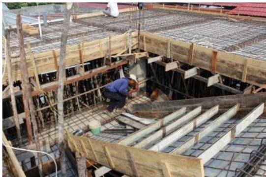
*Gambar 3.35 Pekerjaan perakitan tulangan & bekisting tangga*
