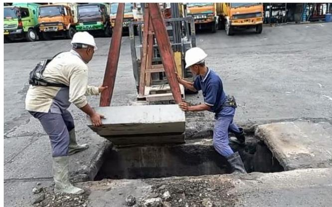
*Gambar 3.9 Pemasangan Penutup Drainase
