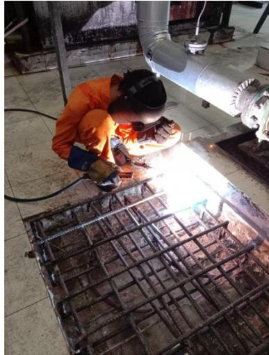
*Gambar 3.5 Pengelasan Sambungan Pondasi Nemo Pump
