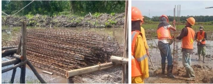
*Gambar 3.18 Pemasangan Penulangan Strouss Pile
