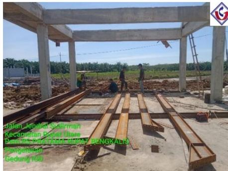
*Gambar 3.39 Pekerjaan pengelasan sambungan baja
