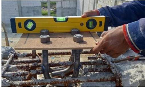
*Gambar 3.38 Pekerjaan koreksi pemasangan anker
