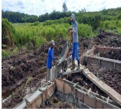
*Gambar 3.27 Proses pekerjaan balok sloof*
