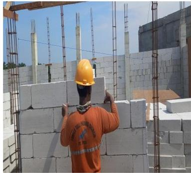
*Gambar 3.42 Pekerjaan pemasangan dinding bata*
