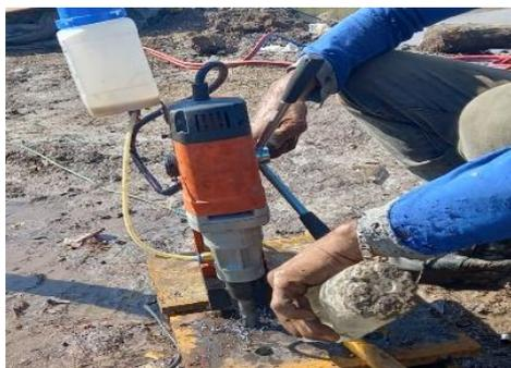
*Gambar 3.40 Pekerjaan pembuatan sambungan baut pengikat
