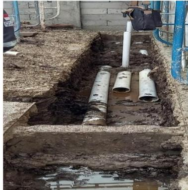
*Gambar 3.7 Pekerjaan pemasangan pipa saluran air
