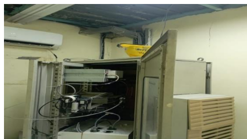
Gambar 2. 7 Pengecekan gas analizer 02
