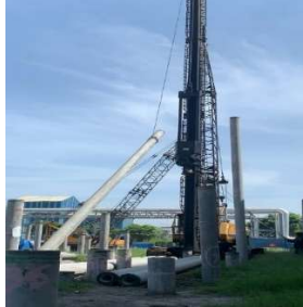
Gambar 3.13 Kegiatan Pengangkatan Tiang Pancang Sumber : Dokumentasi Pribadi
