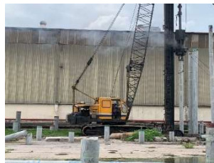
Gambar 3.20 Desel Hammer Sumber : Dokumentasi Pribadi
