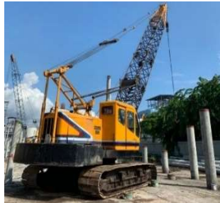
Gambar 3.22 Crane Crawler Sumber :Dokumentasi Pribadi
