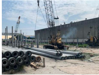
Gambar 3.7 Penempatan crane dan spun pile Sumber : Dokumentasi Pribadi
