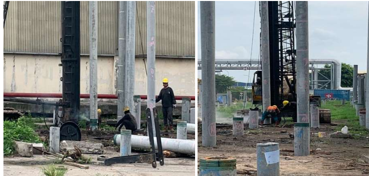
Gambar 3.16 Kegiatan Penyambungan Tiang Pancang Sumber : Dokumentasi Pribadi
