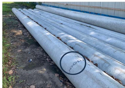
Gambar 3.10 Penentuan titik angkat
