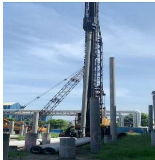
Gambar 3.14 Kegiatan Penyetelan Vertikal Sumber : Dokumentasi pribadi
