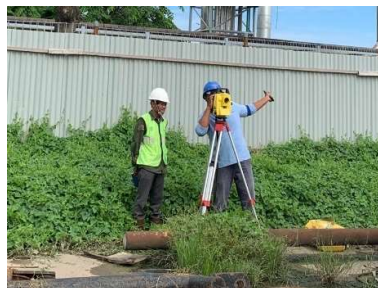
Gambar 3.4 Kegiatan Survey (pengukuran) Sumber : Dokumentasi Pribadi
