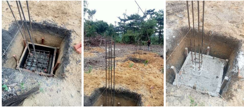
Gambar 3.2 Pekerjaan Pondasi (Sumber : Dokumentasi Pribadi, 2023)
