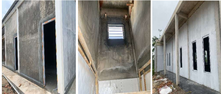
Gambar 3.35 Pekerjaan Pemasangan Kusen dan Ventilasi (Sumber : Dokumentasi Pribadi, 2023)
