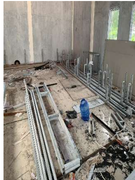
Gambar 3.27 Pekerjaan Pengelasan Kerangka ACP Bangunan (Sumber : Dokumentasi Pribadi, 2023)
