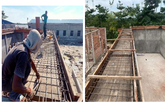
Gambar 3.17 Pemasangan tulangan balok (Sumber : Dokumentasi Pribadi, 2023)
