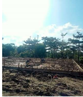
Gambar 3.9 Pekerjaan Plat Lantai (Sumber : Dokumentasi Pribadi, 2023)
