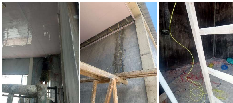
Gambar 3.28 Pekerjaan Pemasangan Instalasi Listrik (Sumber : Dokumentasi Pribadi, 2023)
