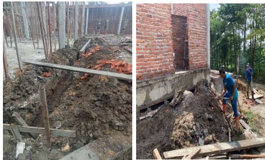
Gambar 3.30 Pekerjaan Sanitasi (Sumber : Dokumentasi Pribadi, 2023)
