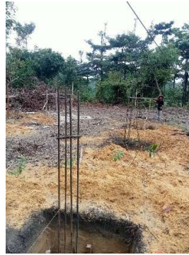
Gambar 3.1 Pekerjaan Penggalian Tanah (Sumber : Dokumentasi Pribadi, 2023)
