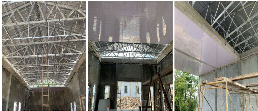
Gambar 3.24 Pekerjaan Pemasangan Plafon (Sumber : Dokumentasi Pribadi, 2023)
