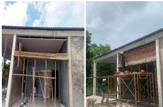
Gambar 3.20 Pekerjaan Balok Latei (Sumber : Dokumentasi Pribadi, 2023)
