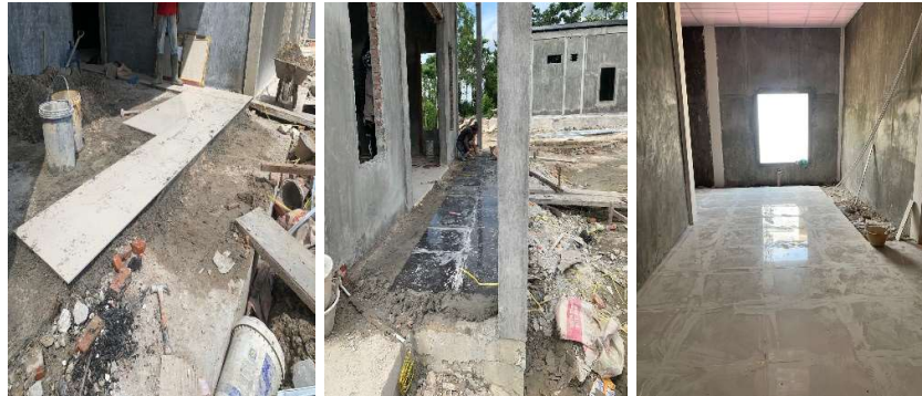
Gambar 3.25 Pekerjaan Pemasangan Lantai (Sumber : Dokumentasi Pribadi, 2023)
