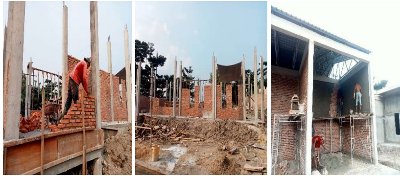
Gambar 3.21 Pemasangan \frac{1}{2} Batu Bata (Sumber : Dokumentasi Pribadi, 2023)
