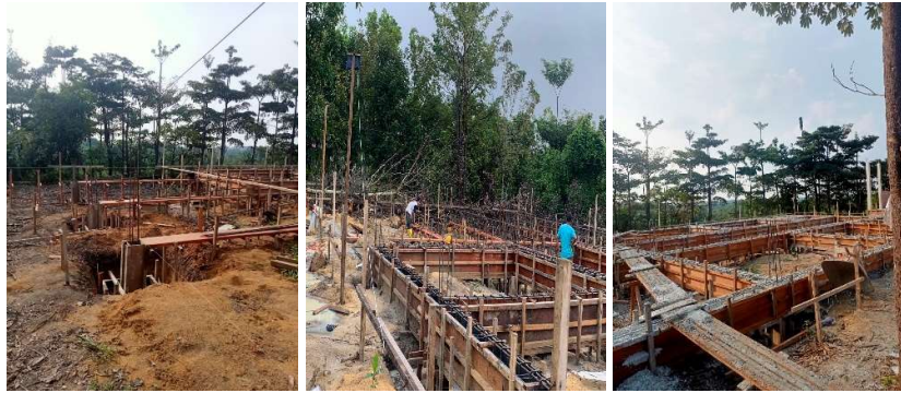
Gambar 3.6 Pekerjaan Sloof (Sumber : Dokumentasi Pribadi, 2023)
