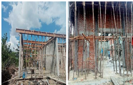
Gambar 3.19 Pengecoran balok (Sumber : Dokumentasi Pribadi, 2023)
