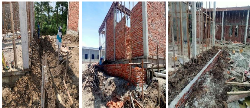
Gambar 3.34 Pekerjaan Rabat Keliling (Sumber : Dokumentasi Pribadi, 2023)
