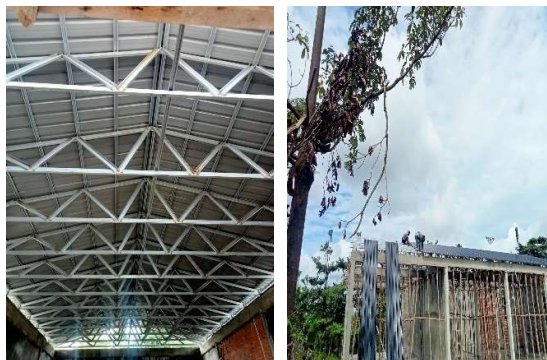
Gambar 3.22 Pekerjaan Pemasangan Atap (Sumber : Dokumentasi Pribadi, 2023)
