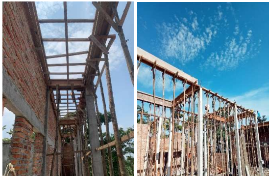
Gambar 3.16 Pemasangan bekisting balok (Sumber : Dokumentasi Pribadi, 2023)
