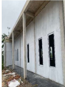
Gambar 3.38 Pekerjaan Pemasangan Kaca (Sumber : Dokumentasi Pribadi, 2023)
