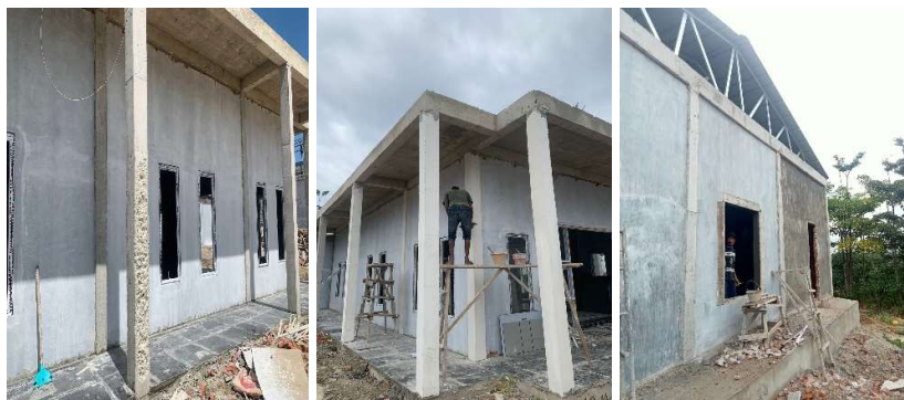
Gambar 3.39 Pekerjaan Pengecatan (Sumber : Dokumentasi Pribadi, 2023)
