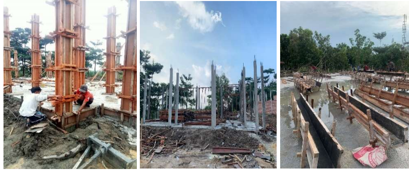
Gambar 3.12 Pekerjaan Kolom (Sumber : Dokumentasi Pribadi, 2023)
