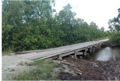
Gambar 1.1 Kondisi Jembatan Jalan Antara
