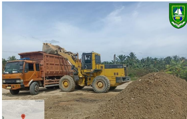
Gambar 4.3 Wheel Loader Sumber : Dokumentasi lapangan, 2023
