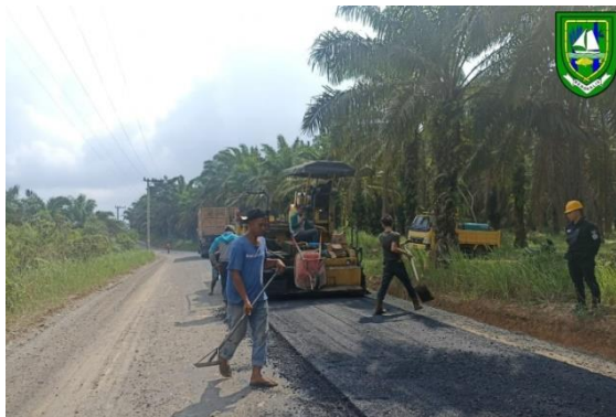
Gambar 3. 31 penghamparan AC-BC oleh Asphalt Finisher Sumber: Dokumentasi lapangan, 2023
