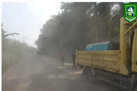
Gambar 3. 28 Pembersihan Base oleh air compressor Sumber : Dokumentasi lapangan, 2023
