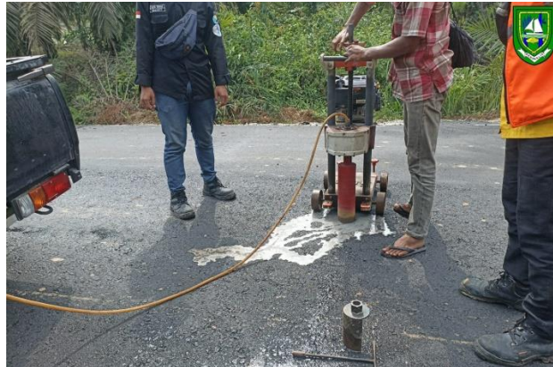
Gambar 3. 41 core drill AC-BC Sumber : Dokumentasi lapangan, 2023
