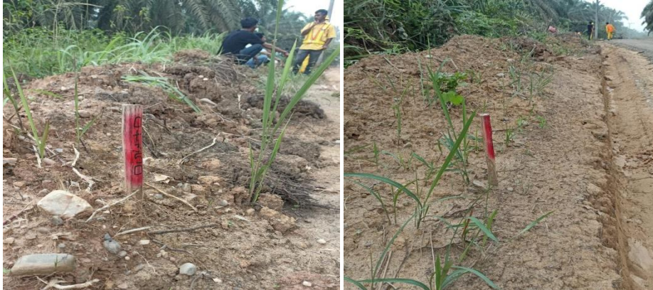
Gambar 3. 13 Pengukuran dan perletakan patok
