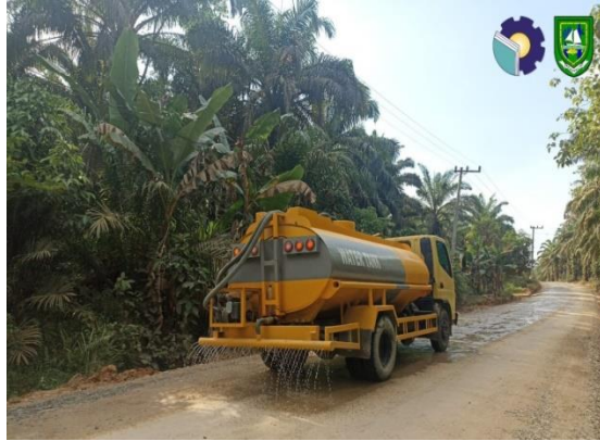
Gambar 3. 16 Penyiraman base B
