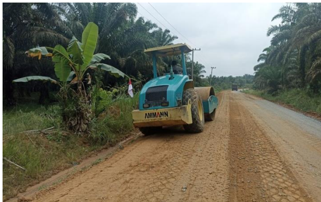
Gambar 3. 27 Pemadatan base S Sumber : Dokumentasi lapangan, 2023
