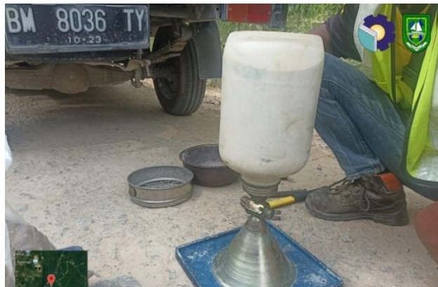
Gambar 3. 24 Pengujian Sandcone Sumber : Dokumentasi lapangan, 2023
