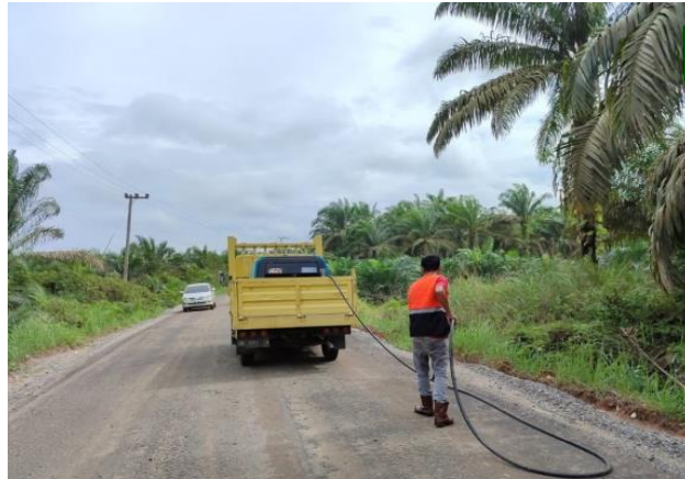
Gambar 3. 11 Air compressor Sumber : Dokumentasi lapangan,2023
