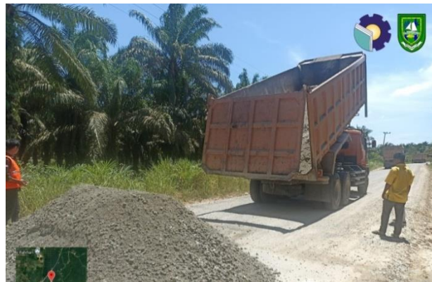
Gambar 3. 19 Penumpukan base A oleh Dump Truck Sumber : Dokumentasi lapangan, 2023
