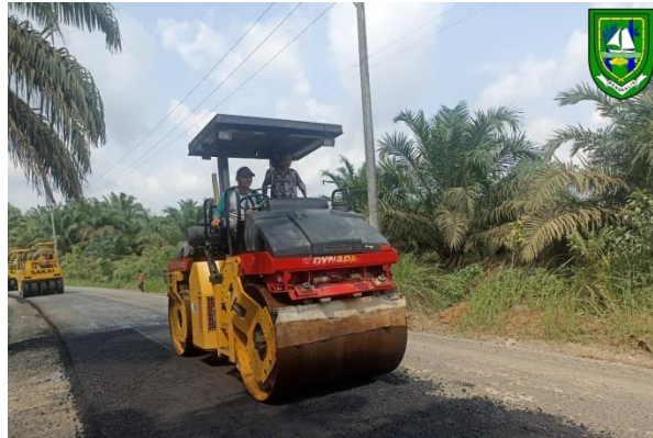
Gambar 3. 32 penggilasan AC-BC oleh Tandem Roller Sumber : Dokumentasi lapangan, 2023
