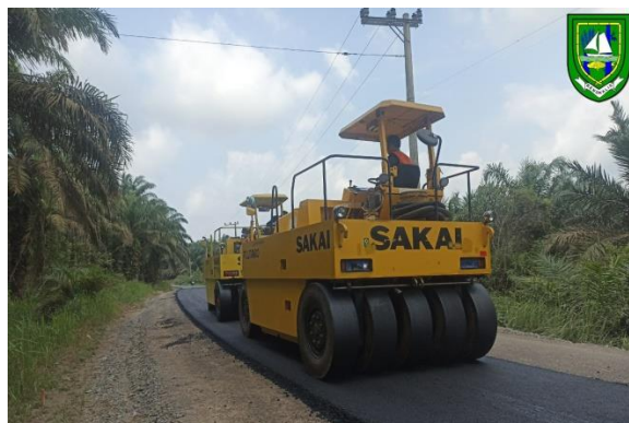
Gambar 3. 33 pemadatan AC-BC oleh PTR Sumber : Dokumentasi lapangan, 2023
