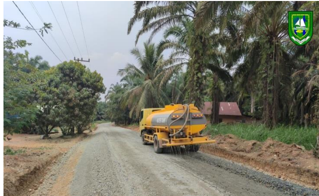
Gambar 3. 21 Penyiraman base A (Sumber : Dokumentasi lapangan, Kerja praktek2023)
