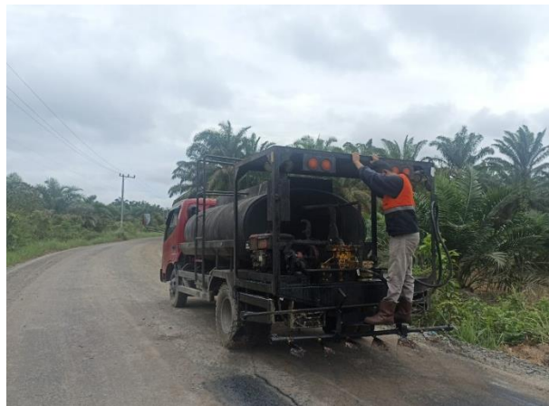
Gambar 3. 10 Asphalt Distributor Sumber : Dokumentasi lapangan, 2023
