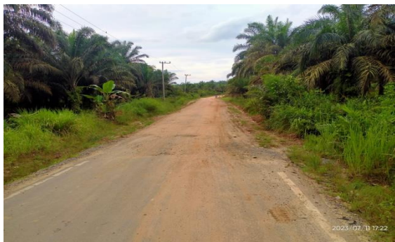
Gambar 3. 1 Survey kondisi lapangan yang sudah dibersihkan Sumber : Dokumentasi lapangan, 2023
