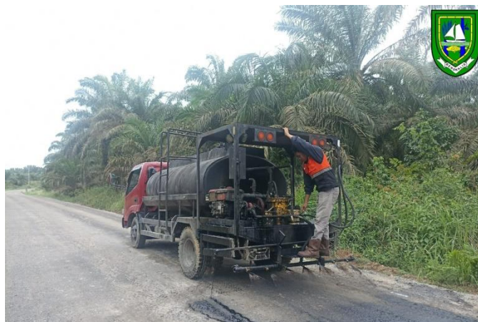
Gambar 4.8 Asphalt Distributor Sumber : Dokumentasi lapangan, 2023
