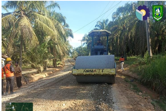
Gambar 3. 17 Pemadatan base B Sumber : Dokumentasi lapangan, 2023
