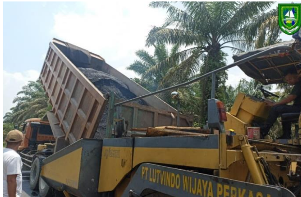
Gambar 3. 37 pengangkutan AC-WC oleh Dump Truck Sumber: Dokumentasi lapangan, 2023
