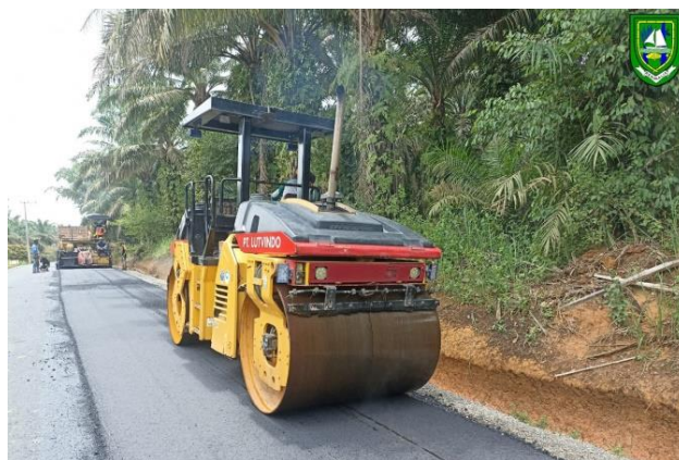
Gambar 3. 39 penggilasan AC-WC oleh Tandem Roller Sumber : Dokumentasi lapangan, 2023
