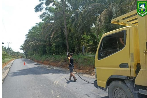
Gambar 3. 35 Pembersihan Debu oleh air compressor Sumber : Dokumentasi lapangan, 2023
