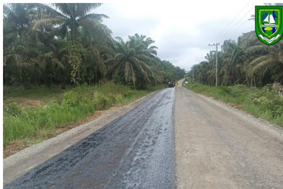
Gambar 3. 29 hasil prime coat Sumber : Dokumentasi lapangan, 2023
