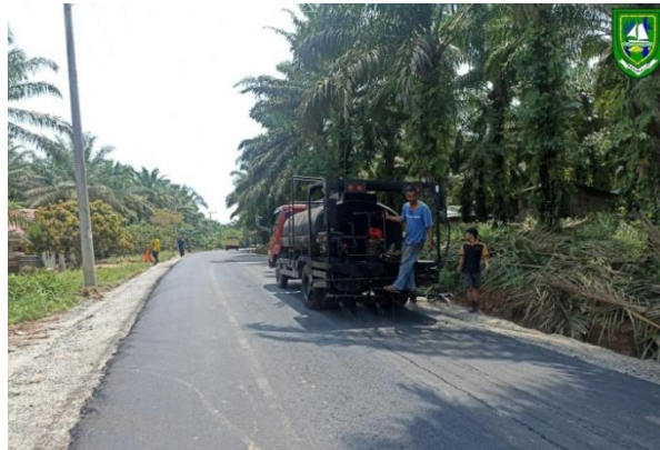
Gambar 3. 36 hasil prime coat Sumber : Dokumentasi lapangan, 2023
