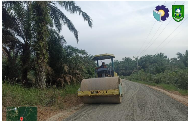
Gambar 3. 22 Pemadatan base A Sumber : Dokumentasi lapangan, 2023
