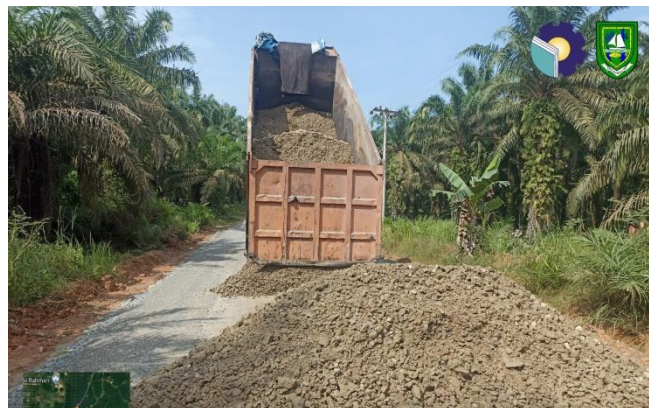
Gambar 3. 14 Penumpukan base B oleh Dump Truck Sumber : Dokumentasi lapangan, 2023
