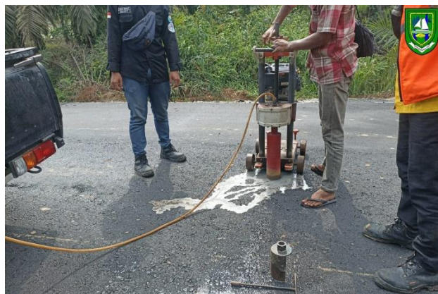
Gambar 3. 34 core drill AC-BC Sumber : Dokumentasi lapangan, 2023
