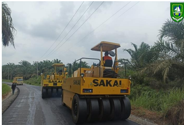
Gambar 3. 40 pemadatan AC-WC oleh PTR Sumber : Dokumentasi lapangan, 2023
