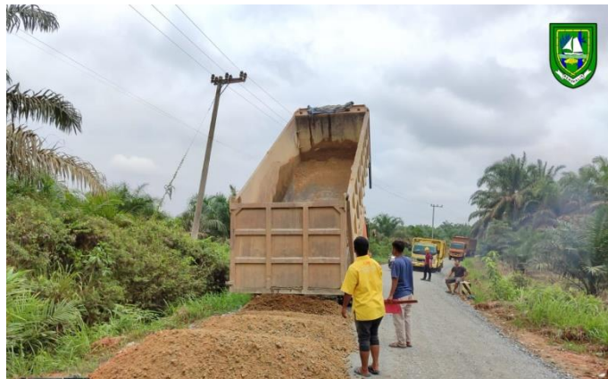
Gambar 3. 25 Penumpukan base kelas S Sumber : Dokumentasi lapangan, 2023
