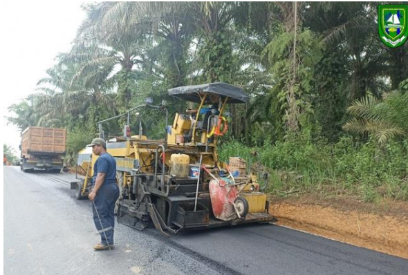
Gambar 3. 38 penghamparan AC-WC oleh Asphalt Finisher Sumber : Dokumentasi lapangan, 2023
