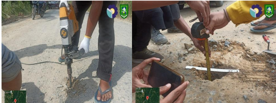
Gambar 3. 18 Pengujian Test pit Base B Sumber : Dokumentasi lapangan, 2023
