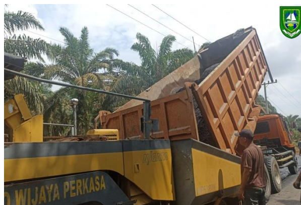
Gambar 3. 30 pengangkutan AC-BC oleh Dump Truck Sumber : Dokumentasi lapangan, 2023
