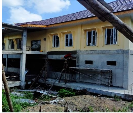
Gambar 3.49 proses plesteran dinding (sumber : dokumentasi lapangan 2023)
