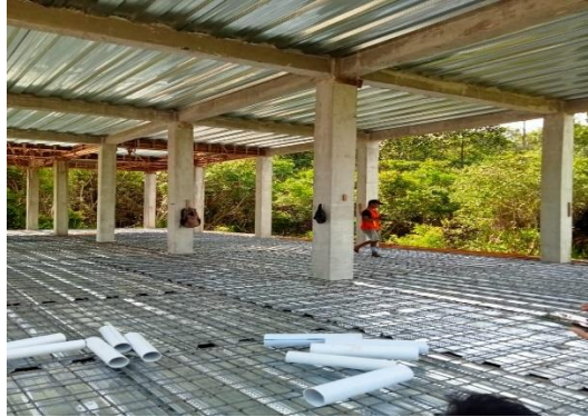
Gambar 3.47 proses pemasangan besi plat lantai (sumber : dokumentasi lapangan 2023)
