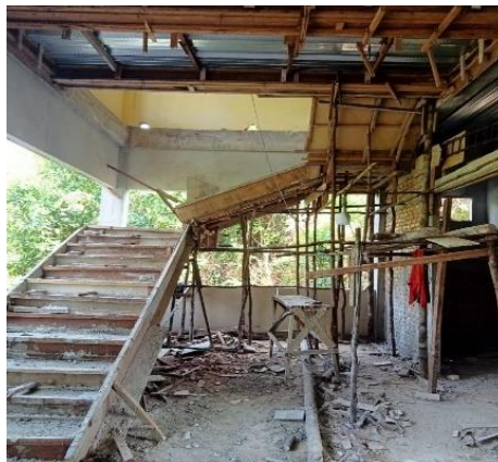
Gambar 3.50 proses pembuatan tangga (sumber : dokumentasi lapangan 2023)
