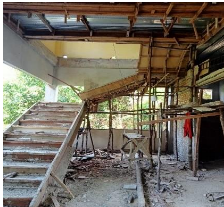
Gambar 3.50 proses pembuatan tangga (sumber : dokumentasi lapangan 2023)
