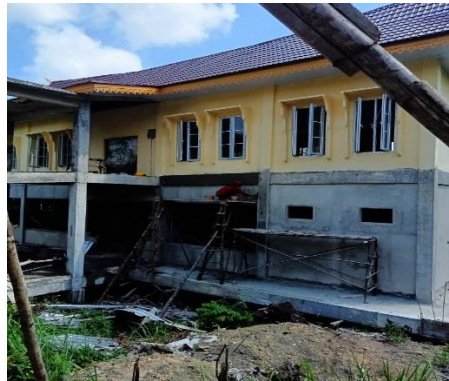
Gambar 3.49 proses plesteran dinding (sumber : dokumentasi lapangan 2023)
