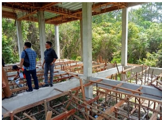
Gambar 3.46 proses pembuatan rangka plat lantai (sumber : dokumentasi lapangan 2023)
