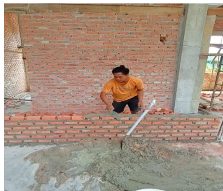
Gambar 3.48 proses pemasangan bata (sumber : dokumentasi lapangan 2023)
