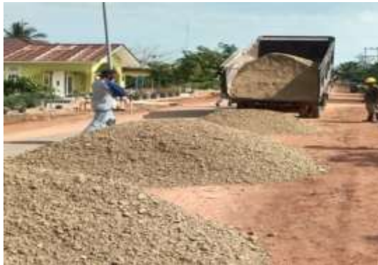
Gambar 3. 10 Proses penuangan Base Kelas B
