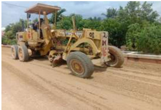
Gambar 3. 11 Penghamparan Base Kelas B Menggunakan Motor Grader
