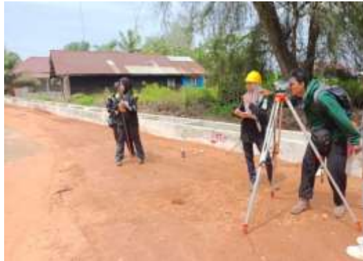
Gambar 3. 16 Pekerjaan pengukuran elevasi Sumber: Dokumentasi Lapangan
