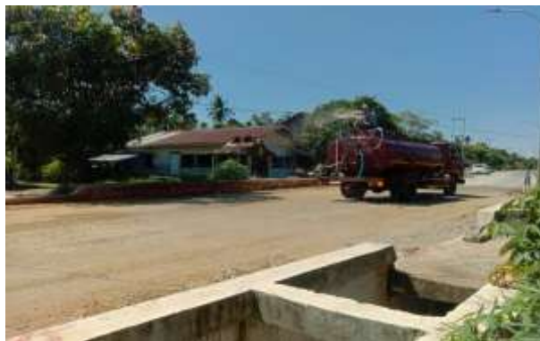
Gambar 3. 3 Water tank mobile Sumber: Dokumentasi Lapangan
