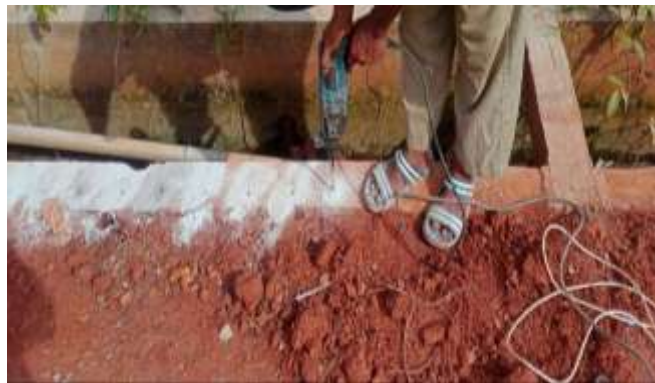
Gambar 3. 28 Proses pelubangan Sumber: Dokumentasi Lapangan
