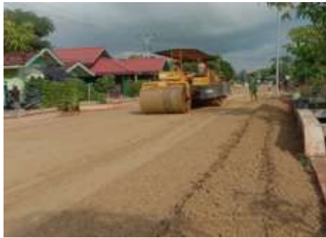
Gambar 4. 9 Pemadatan agregat kelas B Sumber: Dokumentasi Lapangan
