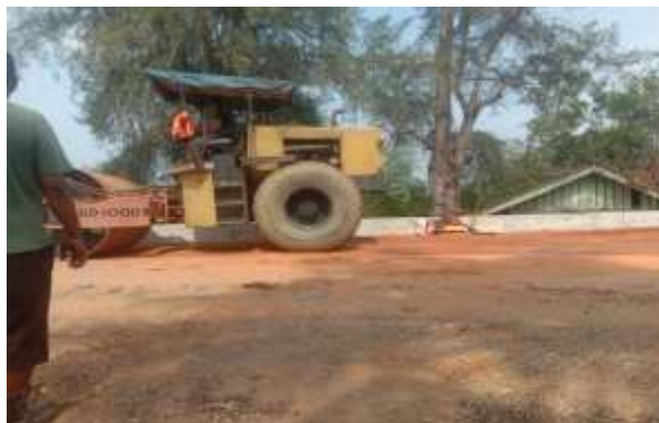
Gambar 3. 5 Tandem roller Sumber: Dokumentasi Lapangan
