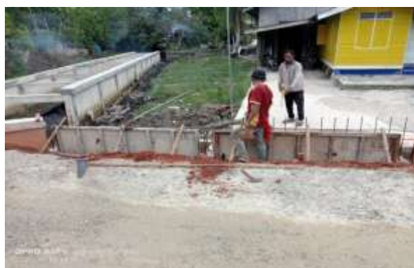
Gambar 3. 30 Pekerjaan pemasangan bekisting Sumber: Dokumentasi Lapangan
