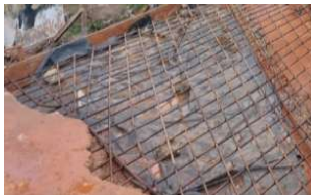
Gambar 3. 35 Pekerjaan pemasangan besi penutup
