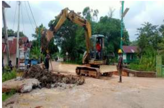
Gambar 3. 4 Excavator Sumber: Dokumentasi Lapangan
