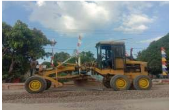
Gambar 3. 18 Pekerjaan penghamparan agregat kelas A Sumber: Dokumentasi Lapangan
