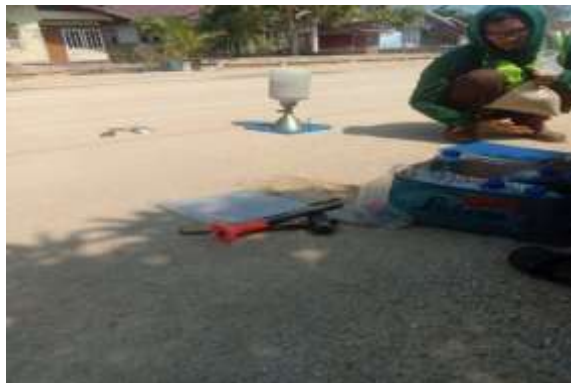
Gambar 3. 15 Pengujian sand cone Sumber: Dokumentasi Lapangan
