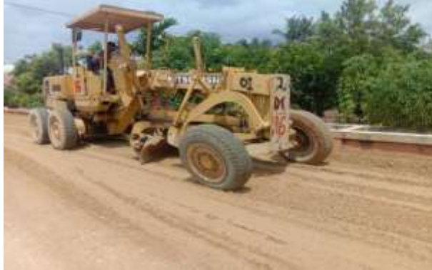
Gambar 4. 3 Perataan base B oleh alat berat Motor Grader Sumber: Dokumentasi Lapangan
