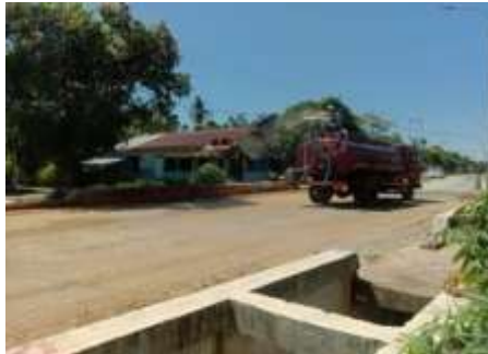
Gambar 4. 10 Penyiraman base B Sumber: Dokumentasi Lapangan
