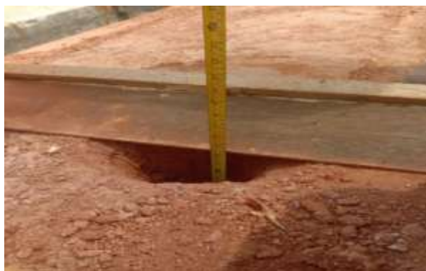
Gambar 3. 24 pekerjaan core Sumber: Dokumentasi Lapangan
