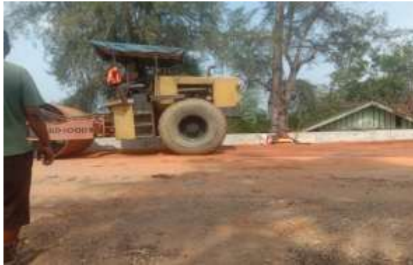
Gambar 3. 22 Pekerjaan pemadatan tanah
