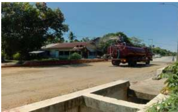
Gambar 3. 13 Penyiraman Base Kelas B Menggunakan water tank mobile Sumber: Dokumentasi Lapangan
