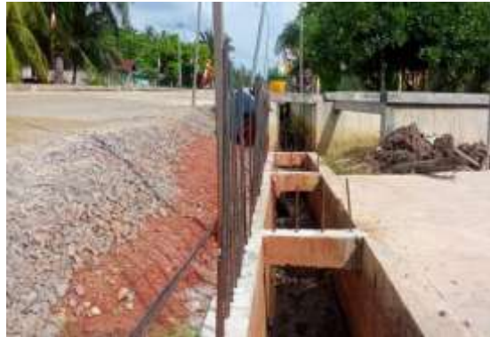
Gambar 3. 29 Pekerjaan pemasangan besi Sumber: Dokumentasi Lapangan
