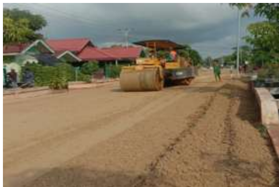
Gambar 4. 4 Pemasatan base B oleh alat berat Tandem Roller Sumber: Dokumentasi Lapangan
