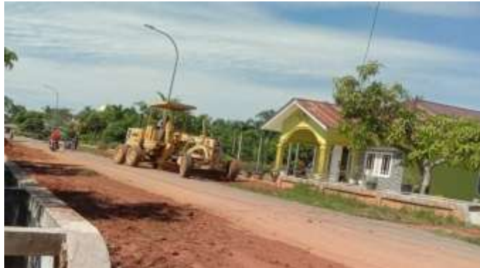
Gambar 3. 8 Proses pelebaran bahu jalan
