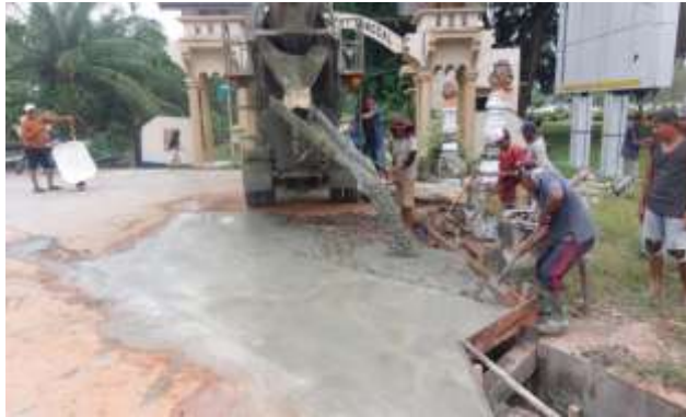
Gambar 3. 36 Pekerjaan pengecoran balok penutup Sumber: Dokumentasi Lapangan
