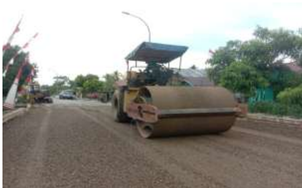
Gambar 3. 19 Pekerjaan pemadatan agregat kelas A Sumber: Dokumentasi Lapangan
