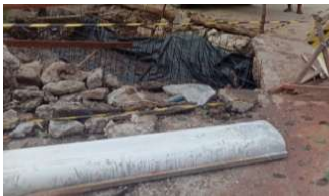
Gambar 3. 33 Pekerjaan pemasangan besi
