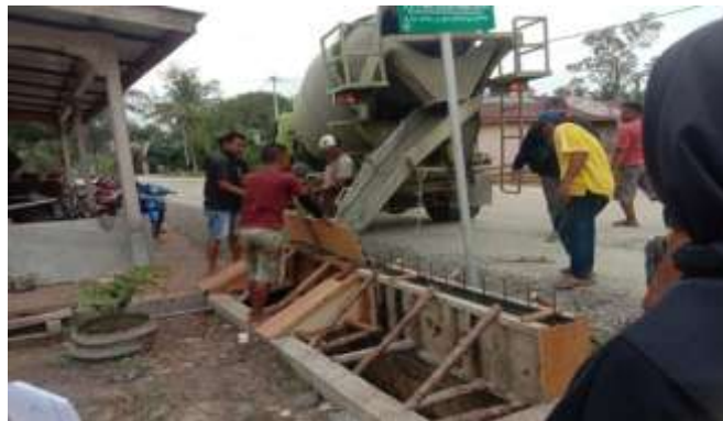
Gambar 3. 31 pekerjaan pengecoran
