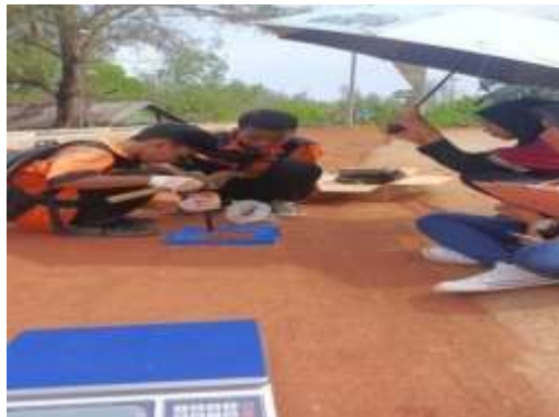
Gambar 3. 25 pekerjaan sand cone Sumber: Dokumentasi Lapangan
