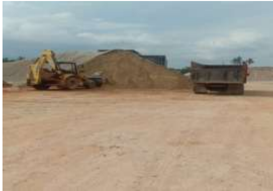
Gambar 3. 9 Proses pengambilan Base Kelas B
