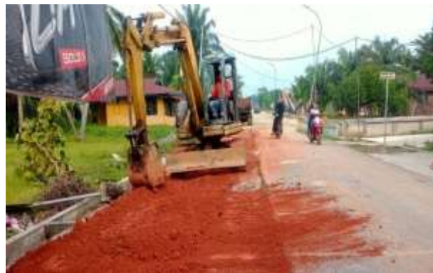
Gambar 3. 21 Pekerjaan penghamparan tanah Sumber: Dokumentasi Lapangan
