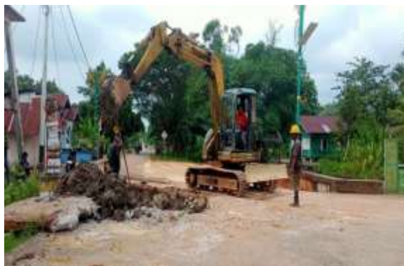
Gambar 3. 32 Pekerjaan penggalian saluran drainase
