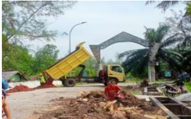
Gambar 3. 20 Pekerjaan penimbunan tanah Sumber: Dokumentasi Lapangan
