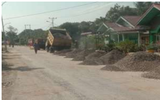
Gambar 3. 17 Pekerjaan penuangan agregat kelas A Sumber: Dokumentasi Lapangan
