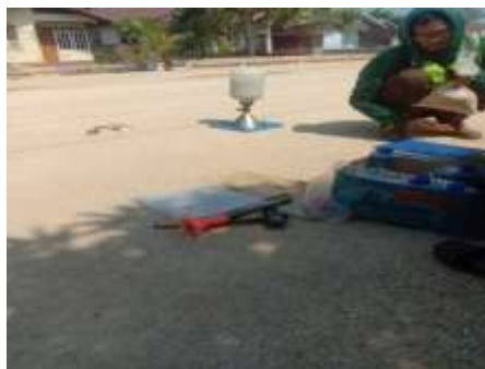
Gambar 4. 12 Sand cone base B Sumber: Dokumentasi Lapangan
