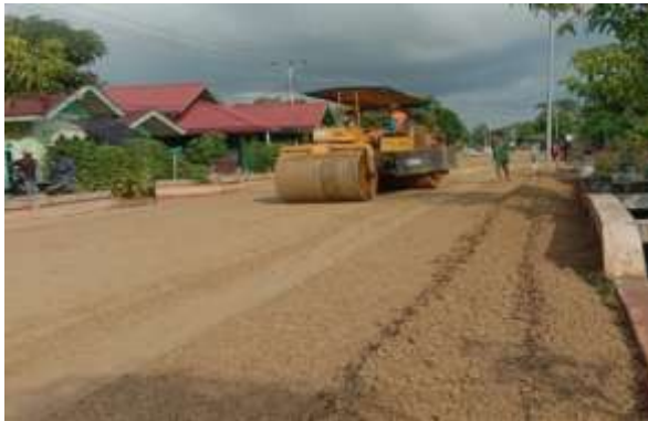
Gambar 3. 12 Pemadatan Base Kelas B Menggunakan Vibrator Roller Sumber: Dokumentasi Lapangan
