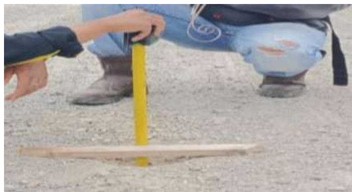
Gambar 3. 26 Pekerjaan core base Sumber: Dokumentasi Lapangan
