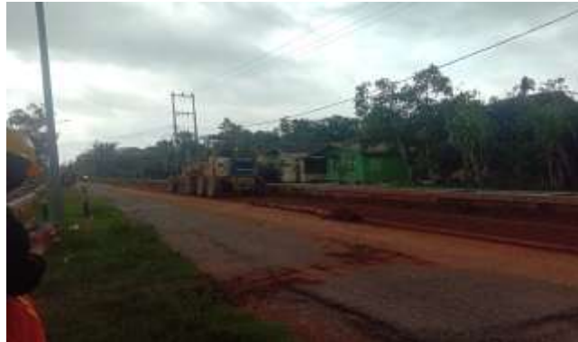
Gambar 3. 7 Proses pembersihan lahan jalan
