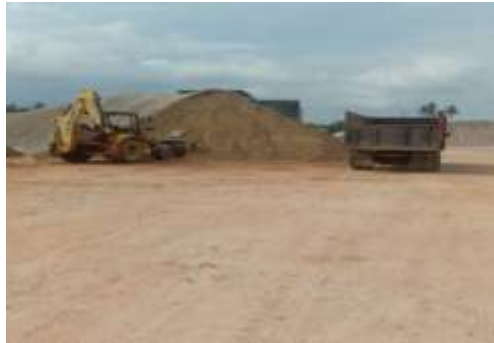
Gambar 4. 7 Proses pengambilan base B Sumber: Dokumentasi Lapangan
