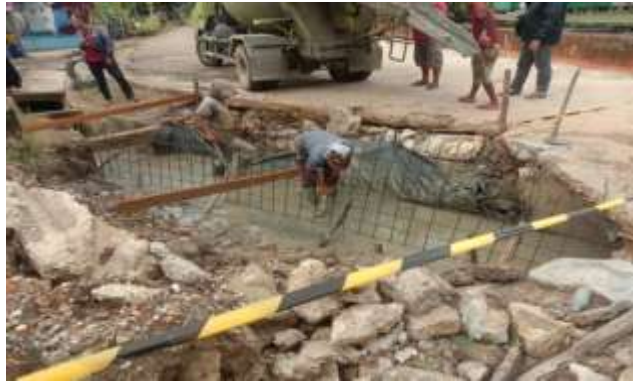
Gambar 3. 34 Pekerjaan pengecoran lantai
