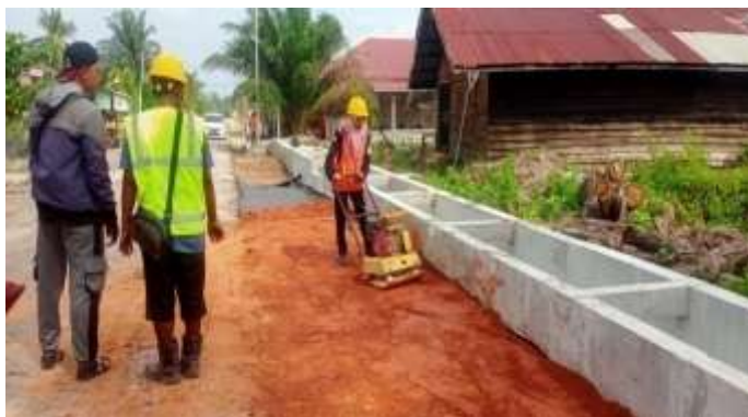
Gambar 3. 23 Pekerjaan pemadatan
