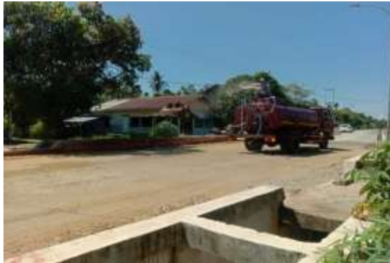
Gambar 4. 5 Proses penyiraman Sumber: Dokumentasi Lapangan
