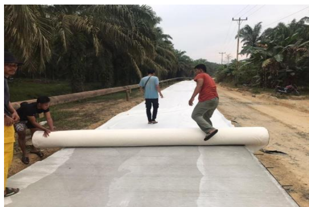
Gambar 3.15 Pemasangan Geotextile Non Woven Sumber : Dokumentasi lapangan 2023
