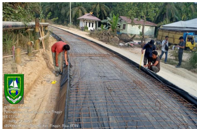
Gambar 3.11 Opname Ketebalan Rigid.
