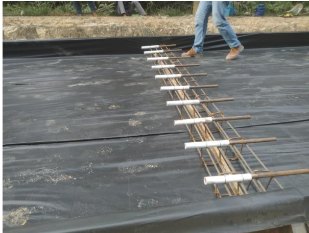
Gambar 4.1 Pemasangan Tulangan Bangku Dowel Sumber : Dokumentasi lapangan 2023
