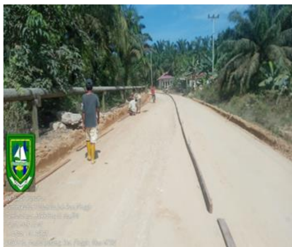
Gambar 3.6 Pemasangan Bekisting Lean Concrete Sumber : Dokumentasi lapangan 2023
