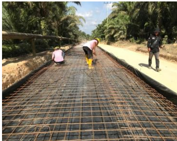
Gambar 3.10 Pemasangan Tulangan Rigid.
