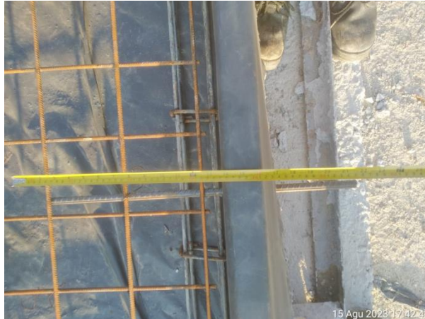
Gambar 4.7 Pemasangan Besi Tie-Bar Sumber : Dokumentasi lapangan 2023
