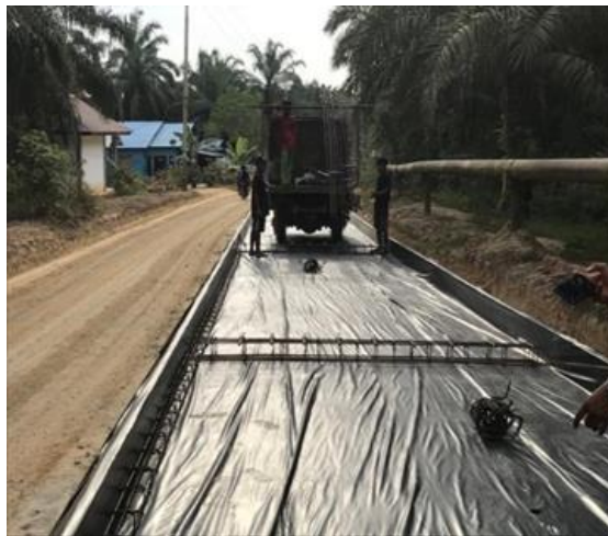
Gambar 3.9 Pemasangan Bekisting Rigid. Sumber : Dokumentasi lapangan 2023
