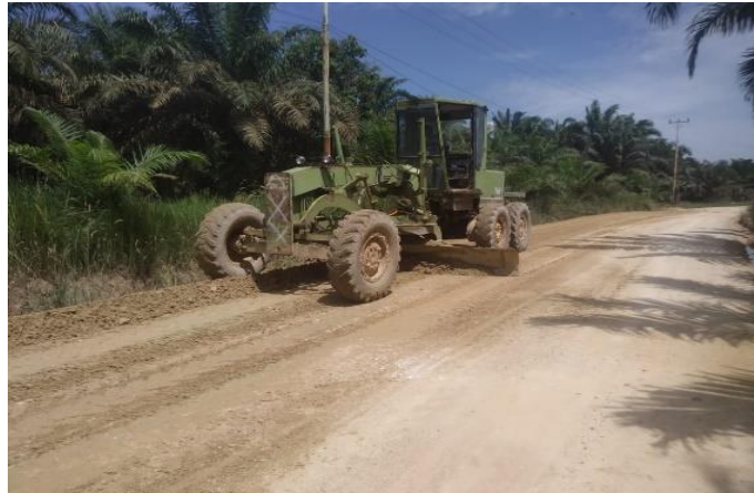
Gambar 3.2 Penghamparan agregat kelas B Sumber : Dokumentasi lapangan , 2023
