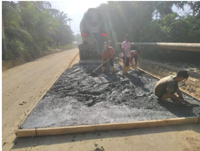
Gambar 3.8 Penghamparan dan Perataan Beton Lc Sumber : Dokumentasi lapangan 2023
