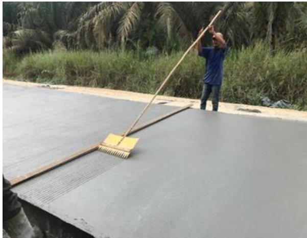
Gambar 3.14 Pembuatan Alur Grooving Sumber : Dokumentasi lapangan 2023
