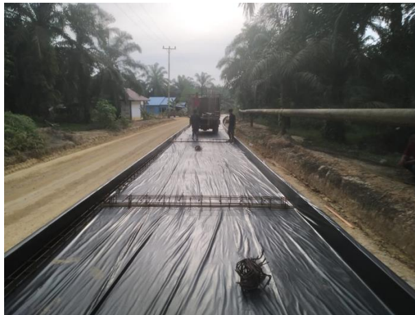
Gambar 4.2 Pemasangan Tulangan Bangku Tie-Bar Sumber : Dokumentasi lapangan 2023
