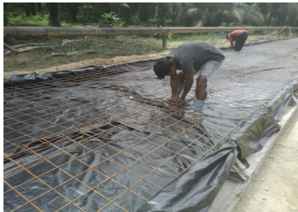
Gambar 4.5 Pengikatan Tulangan Wiremesh Sumber : Dokumentasi lapangan 2023
