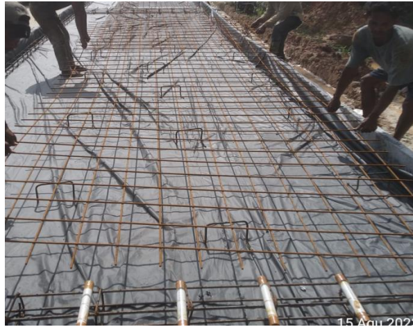
Gambar 4.4 Pemasangan Tulangan Wiremesh Sumber : Dokumentasi lapangan 2023
