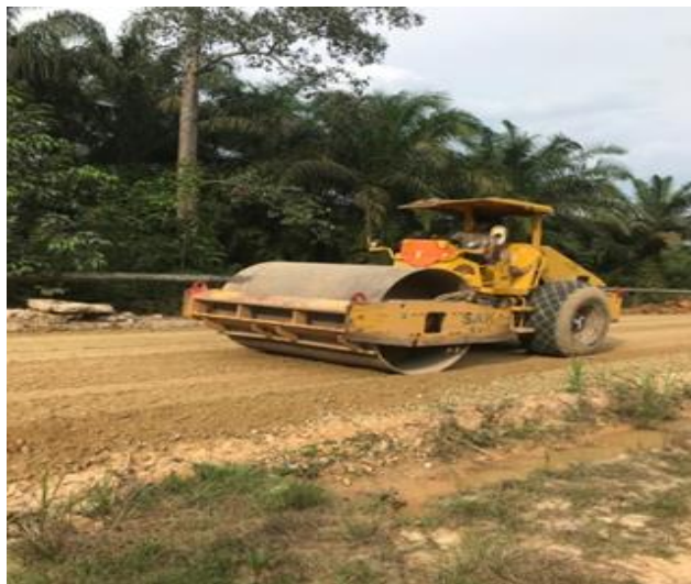
Gambar 3.3 Pemadatan agregat kelas B Sumber : Dokumentasi lapangan 2023
