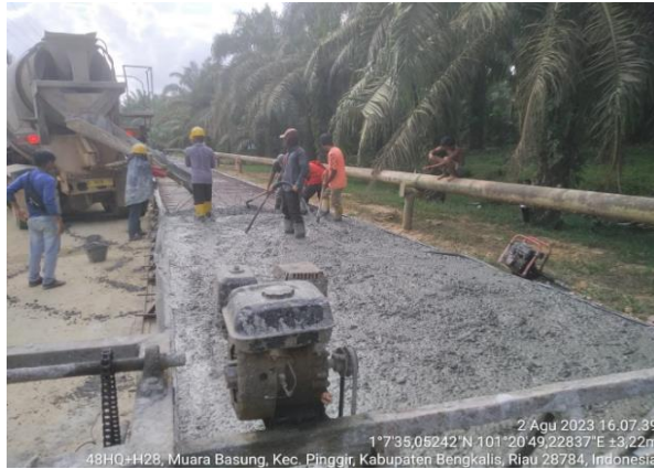
Gambar 3.13 Penuangan dan Perataan Beton Segar Sumber : Dokumentasi lapangan 2023
