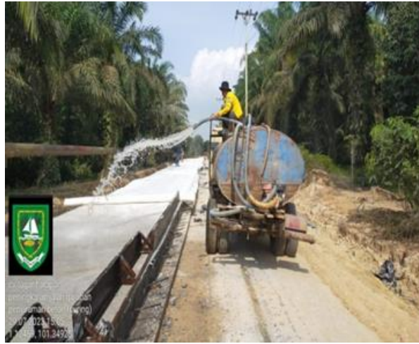
Gambar 3.17 Penyiraman Beton Sumber : Dokumentasi lapangan 2023
