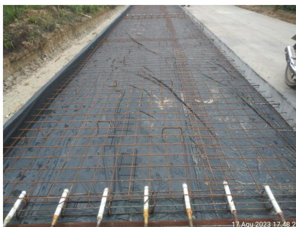
Gambar 4.6 Finising Pemesian Sumber : Dokumentasi lapangan 2023
