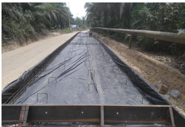
Gambar 4.3 Pemasangan Dudukan wiremesh Sumber : Dokumentasi lapangan 2023
