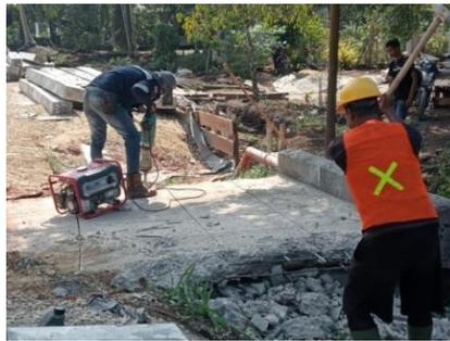
*Gambar 3. 28 Proses Penghancuran Jembatan Ekisting*
