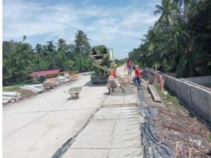
Gambar 3. 6 Pengecoran Balok Sisip
