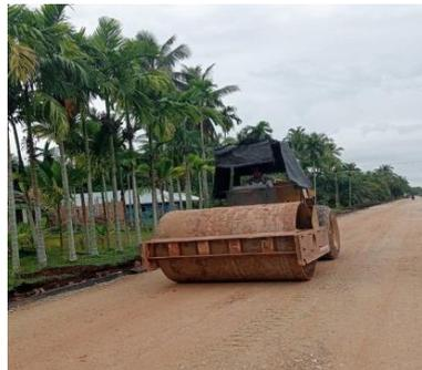
Gambar 3. 16 Pemasatan *vibro roller*.
