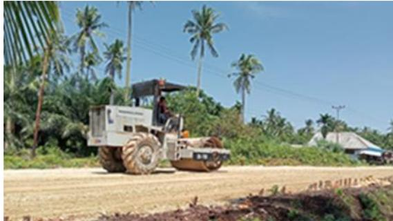
*Gambar 4. 9 Pematatan agregat kelas B*
