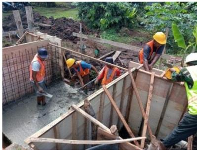
*Gambar 3. 13 Pengecoran Plat Lantai*
