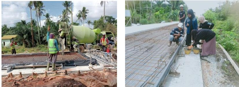
Gambar 3. 23 Pengecoran Rigid dan Slump Test
