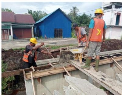
Gambar 3. 5 Pengecoran Balok Penutup
