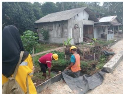
Gambar 3. 9 Pembuatan Tanda atau Patok
