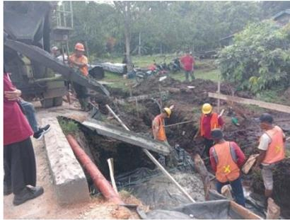
*Gambar 3. 12 Pengecoran Lantai Kerja*
