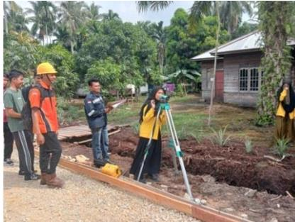
*Gambar 3. 17 Pengukuran Waterpass
