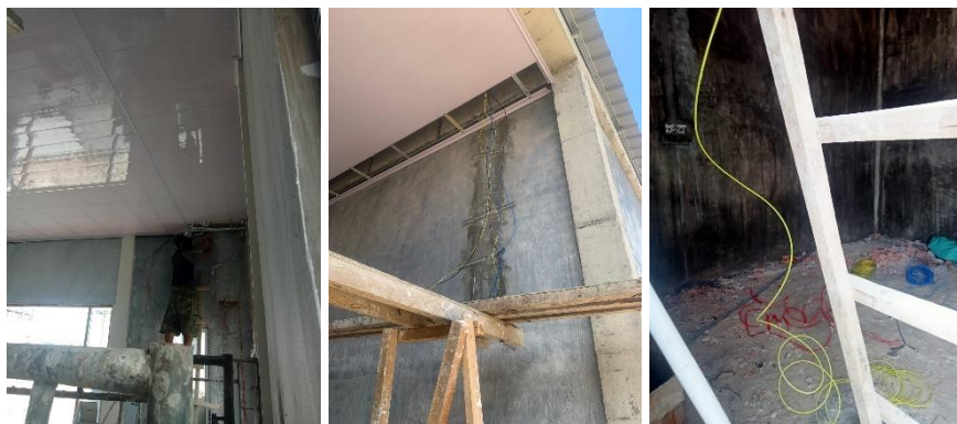
Gambar 3.28 Pekerjaan Pemasangan Instalasi Listrik (Sumber : Dokumentasi Pribadi, 2023)
