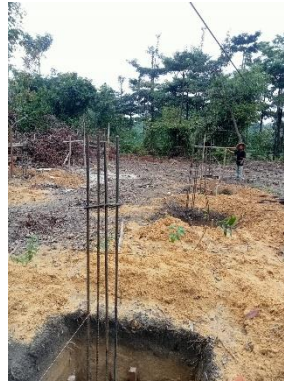
Gambar 3.1 Pekerjaan Penggalian Tanah (Sumber : Dokumentasi Pribadi, 2023)
