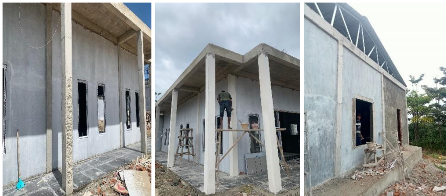
Gambar 3.39 Pekerjaan Pengecatan (Sumber : Dokumentasi Pribadi, 2023)
