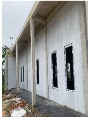
Gambar 3.38 Pekerjaan Pemasangan Kaca (Sumber : Dokumentasi Pribadi, 2023)
