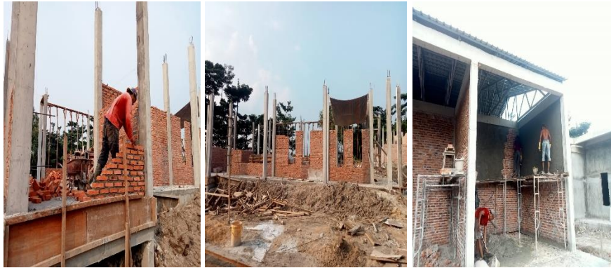
Gambar 3.21 Pemasangan ½ Batu Bata (Sumber : Dokumentasi Pribadi, 2023)
