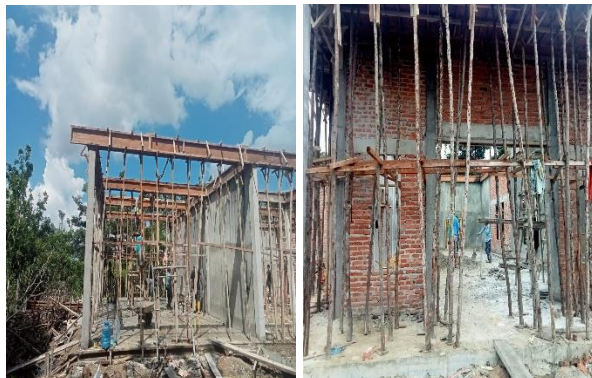
Gambar 3.19 Pengecoran balok (Sumber : Dokumentasi Pribadi, 2023)
