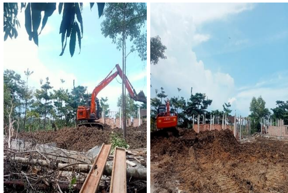
Gambar 3.4 Pekerjaan Urugan Tanah (Sumber : Dokumentasi Pribadi, 2023)
