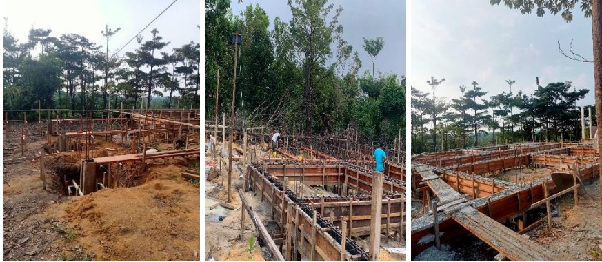
Gambar 3.6 Pekerjaan Sloof (Sumber : Dokumentasi Pribadi, 2023)
