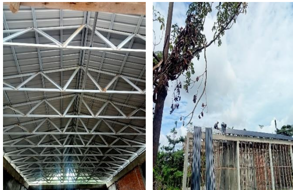
Gambar 3.22 Pekerjaan Pemasangan Atap (Sumber : Dokumentasi Pribadi, 2023)
