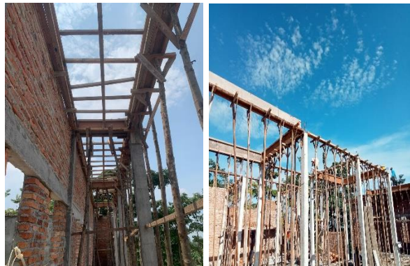
Gambar 3.16 Pemasangan bekisting balok (Sumber : Dokumentasi Pribadi, 2023)
