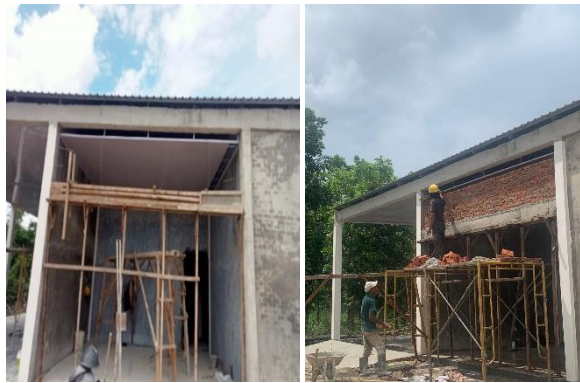
Gambar 3.20 Pekerjaan Balok Latei (Sumber : Dokumentasi Pribadi, 2023)
