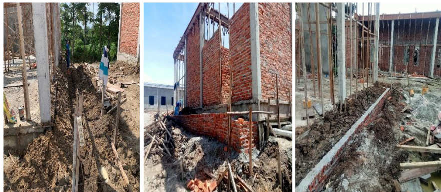
Gambar 3.34 Pekerjaan Rabat Keliling (Sumber : Dokumentasi Pribadi, 2023)
