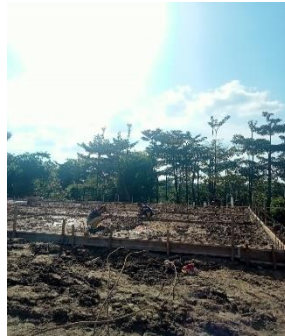
Gambar 3.9 Pekerjaan Plat Lantai (Sumber : Dokumentasi Pribadi, 2023)
