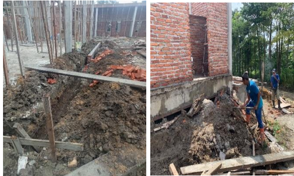
Gambar 3.30 Pekerjaan Sanitasi (Sumber : Dokumentasi Pribadi, 2023)
