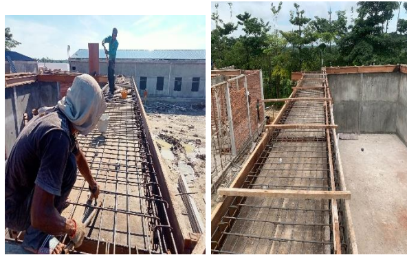
Gambar 3.17 Pemasangan tulangan balok (Sumber : Dokumentasi Pribadi, 2023)
