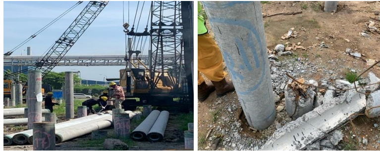
Gambar 3.18 Tiang Pancang Sisipan Sumber : Dokumentasi Pribadi
