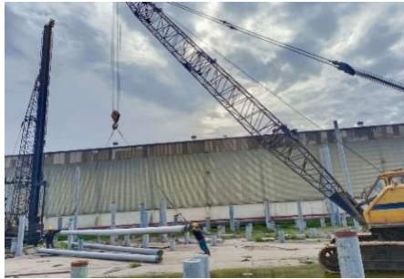
Gambar 3.9 Kegiatan Mobilisasi Lifting Spun Pile Sumber : Dokumentasi Pribadi
