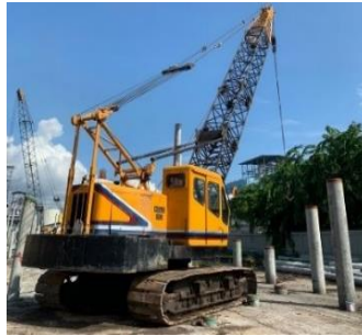
Gambar 3.22 Crane Crawler Sumber :Dokumentasi Pribadi
