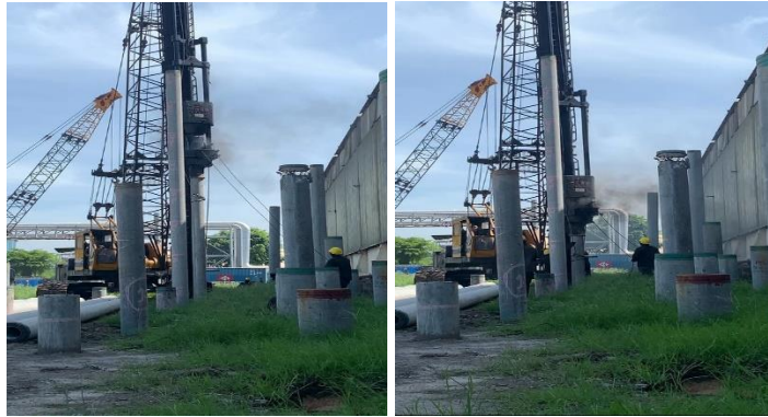
Gambar 3.15 Kegiatan Pemancangan Sumber : Dokumentasi pribadi
