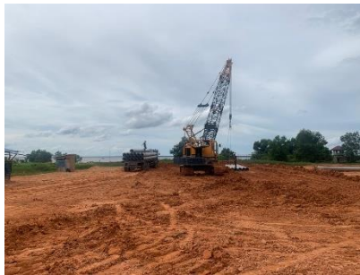
Gambar 3.2 Kegiatan Penimbunan Tanah Sumber : Dokumentasi Pribadi
