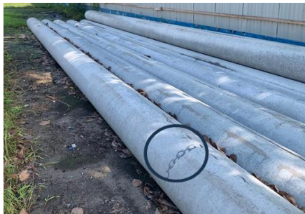
Gambar 3.10 Penentuan titik angkat Sumber : Dokumentasi Pribadi
