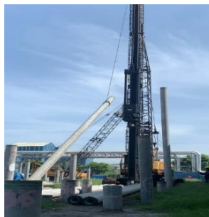
Gambar 3.13 Kegiatan Pengangkatan Tiang Pancang
