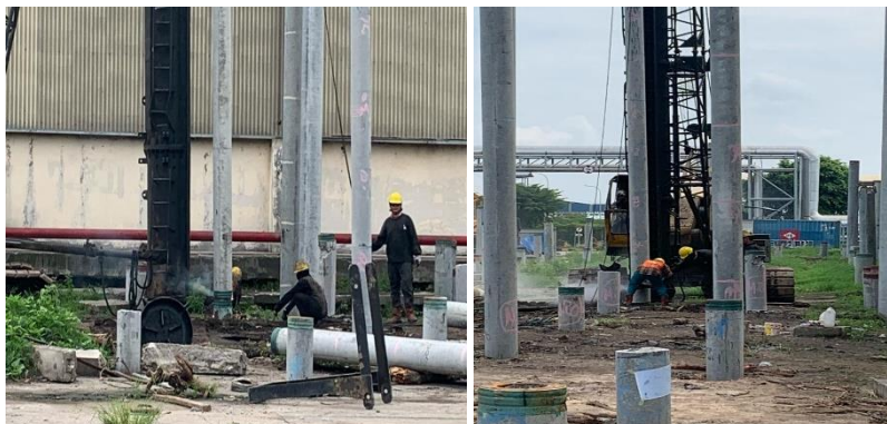
Gambar 3.16 Kegiatan Penyambungan Tiang Pancang Sumber : Dokumentasi Pribadi
