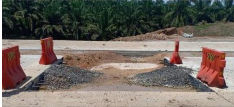
Gambar 3. 54 Contoh tranvesrse joint pada pekerjaan jalan
