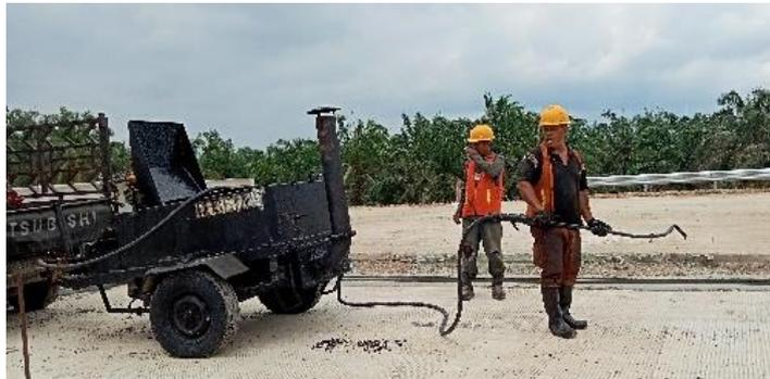
Gambar 3. 12 Mesin penyemprot tack coat
