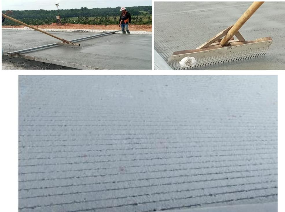
Gambar 3. 46 Slab beton yang sudah di grooving
