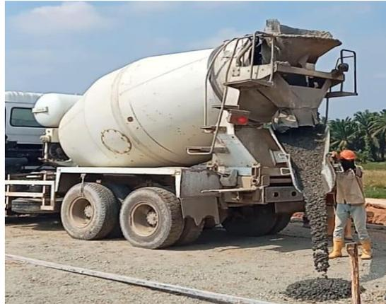
Gambar 3. 38 Proses penuangan campuran beton
