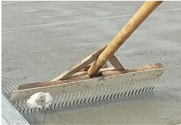
Gambar 3. 16 Source sikat pembentuk jalan beton
