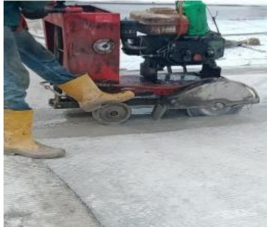
Gambar 3. 47 Pemotongan segmen beton
