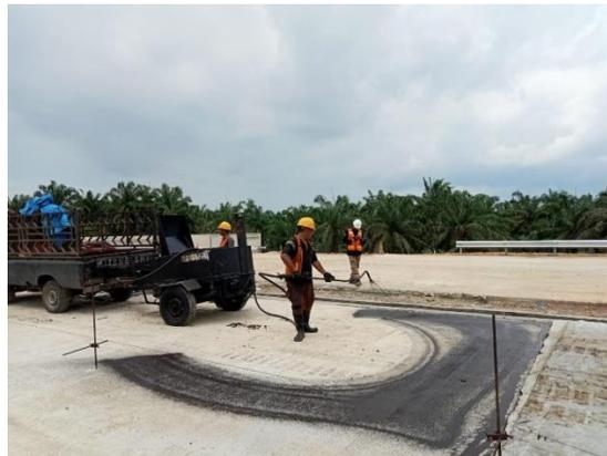
Gambar 4. 12 Pengujian take coat
