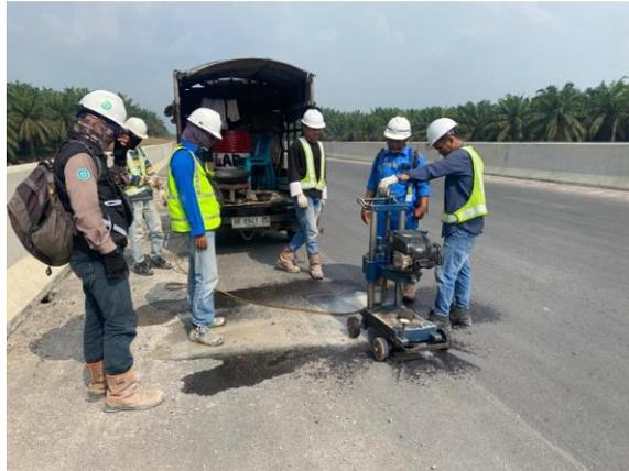
Gambar 4. 22 melakukan pengeboran inti aspal (core drill)
