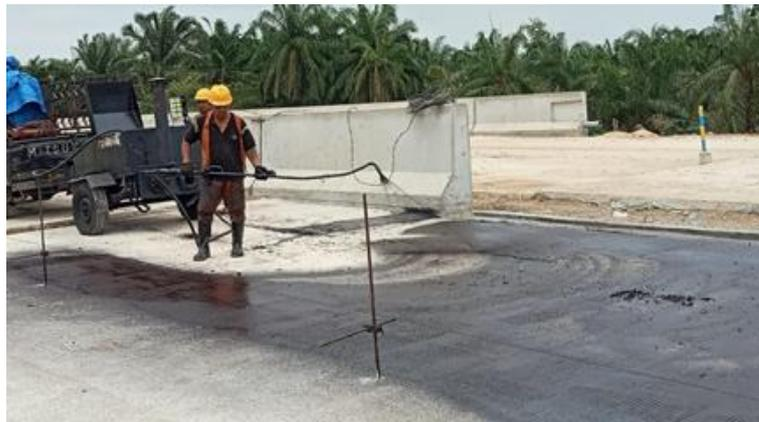
Gambar 4. 17 penyemprotan bitumen (aspal cair)
