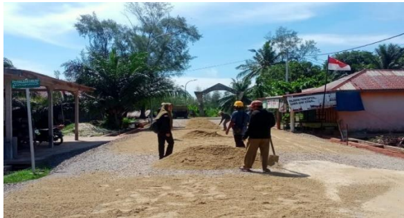
Gambar 3. 9 Pekerjaan Penghamparan Base Kelas B dengan cara manual Sumber : Dokumentasi Lapangan, 2023
