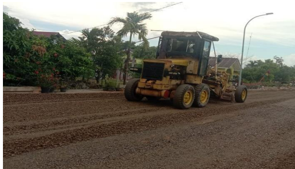
Gambar 3. 17 Pekerjaan Penghamparan Base Kelas A Menggunakan Motor Grader Sumber : Dokumentasi Lapangan, 2023
