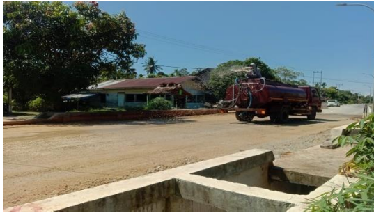
Gambar 3. 12 Pekerjaan Penyiraman Base Kelas B Menggunakan water tank 5000 liter Sumber : Dokumentasi Lapangan, 2023
