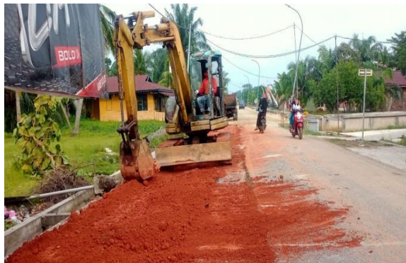
Gambar 3. 7 penghamparan dan perataan menggunakan alat excavator Sumber : Dokumentasi Lapangan, 2023
