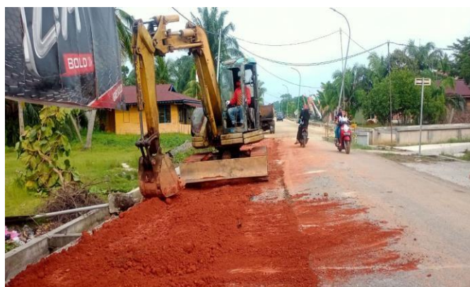
Gambar 3. 23 Pekerjaan Penghamparan dan pemadatan tanah timbunan menggunakan excavator Sumber : Dokumentasi Lapangan, 2023
