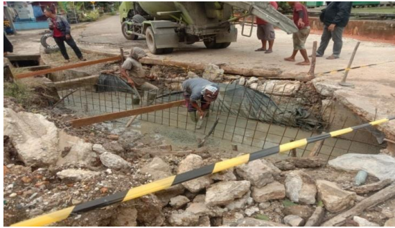
Gambar 3. 36 Pekerjaan pengecoran lantai box culvert
