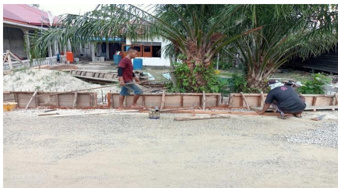
Gambar 3. 31 Pemasangan Bekisting drainase Sumber : Dokumentasi Lapangan, 2023
