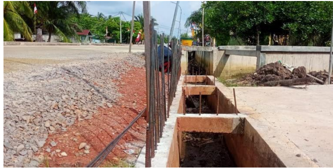
Gambar 3. 30 Pemasangan tulangan drainase Sumber : Dokumentasi Lapangan, 2023
