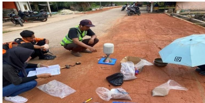
Gambar 3. 26 Pekerjaan sand cone tanah timbunan Sumber : Dokumentasi Lapangan, 2023
