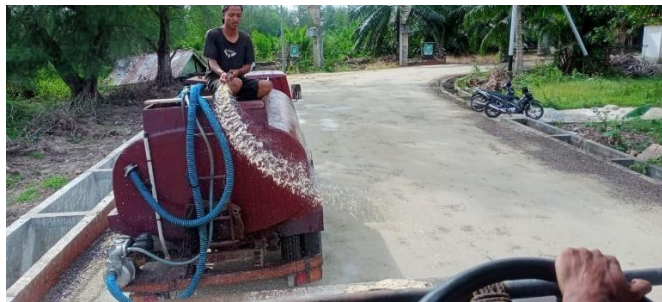
Gambar 3. 19 Pekerjaan Penyiraman Base Kelas A Menggunakan Water Tank
