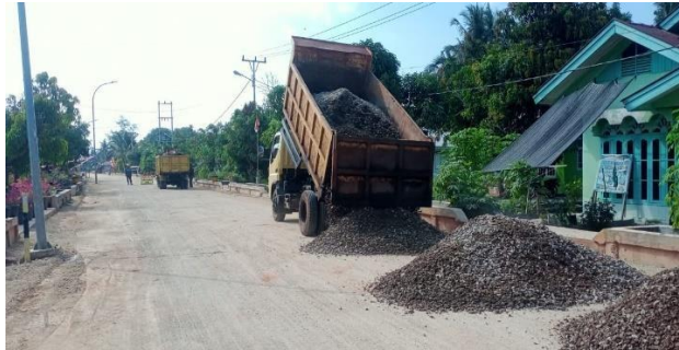
Gambar 3. 16 Pekerjaan Penghamparan Base Kelas A Sumber : Dokumentasi Lapangan, 2023
