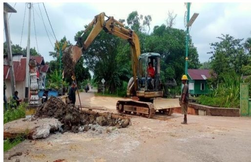
Gambar 3. 34 Pekerjaan Pembongkaran bekisting drainase
