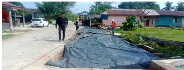
Gambar 3. 21 Pekerjaan Pemasangan Geotextile woven 250 Gr
