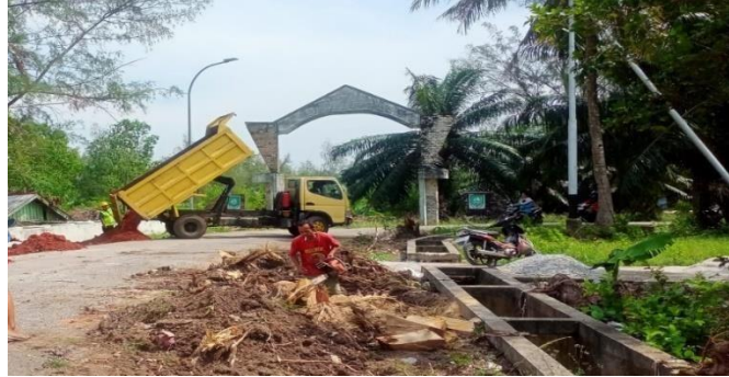
Gambar 3. 22 Pekerjaan Penghamparan tanah timbunan bauksit Sumber : Dokumentasi Lapangan, 2023
