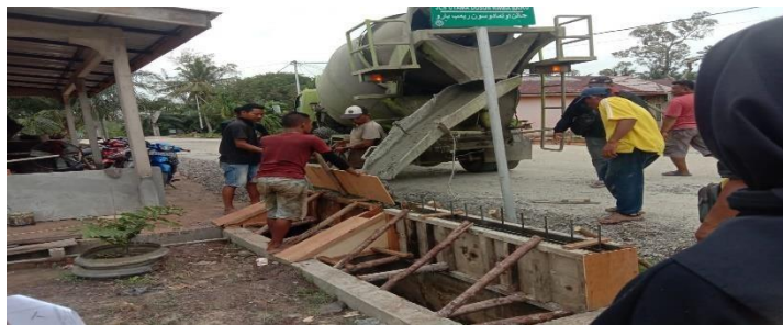
Gambar 3. 32 Peekerjaan Pengecoran dinding drainase Sumber : Dokumentasi Lapangan, 2023
