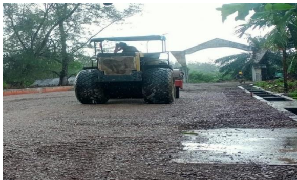
Gambar 3. 18 Pekerjaan Pemadatan Base Kelas A Menggunakan Vibrator Roller
