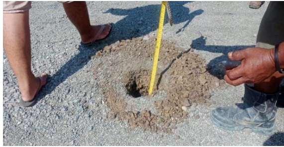
Gambar 3. 27 Pengujian Core Base A Sumber : Dokumentasi Lapangan, 2023
