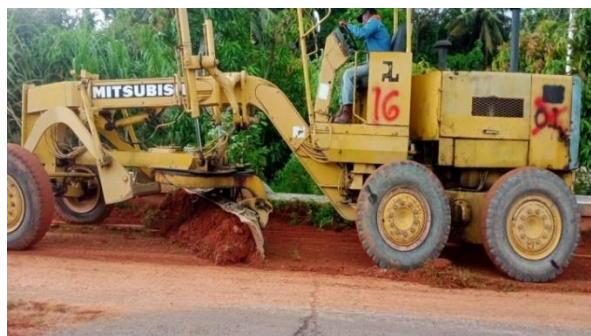
Gambar 3. 5 Pekerjaan pelebaran bahu jalan menggunakan alat Motor Grader Sumber : Dokumentasi Lapangan, 2023
