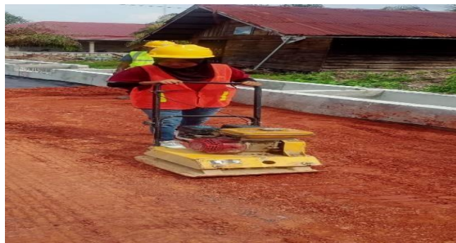
Gambar 3. 24 Pekerja pematatan tanah menggunakan Stamper Sumber : Dokumentasi Lapangan, 2023
