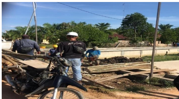
Gambar 3. 20 Pekerjaan pemasangan kayu gambangan
