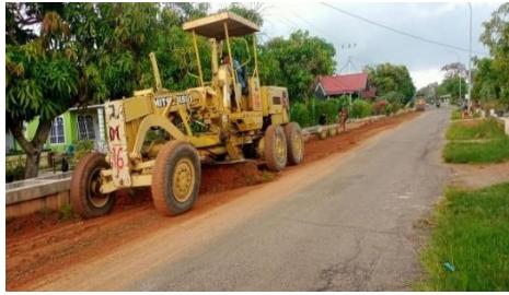
Gambar 3. 3 pembersihan dan pengupasan lahan dengan menggunakan Motor Grader Sumber : Dokumentasi Lapangan, 2023
