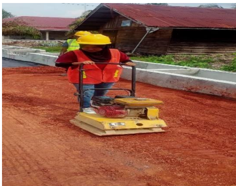
Gambar 3. 4 Pekerjaan pelebaran dan pemadatan bahu jalan menggunakan alat Stamper Sumber : Dokumentasi Lapangan, 2023
