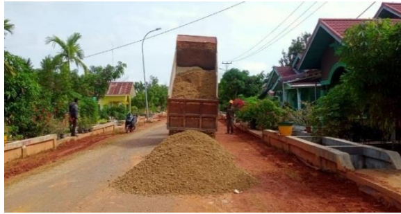
Gambar 3. 8 Pekerjaan Penghamparan Base Kelas B Sumber : Dokumentasi Lapangan, 2023
