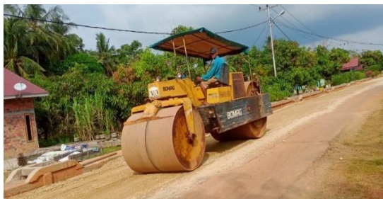
Gambar 3. 11 Pekerjaan Pemadatan Base Kelas B Menggunakan Tandem Roller
