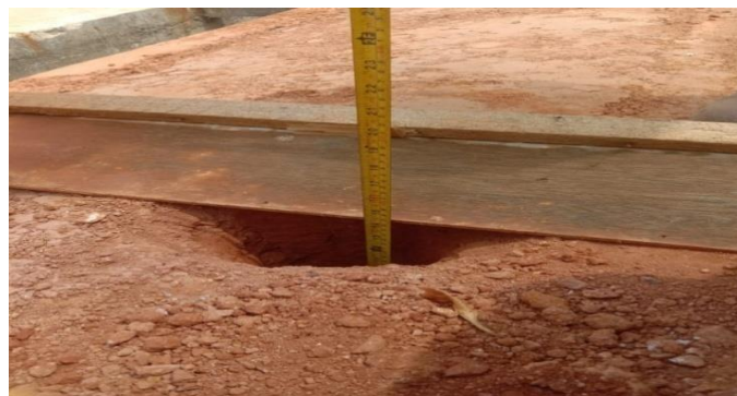
Gambar 3. 25 Pekerjaan core tanah timbunan Sumber : Dokumentasi Lapangan, 2023
