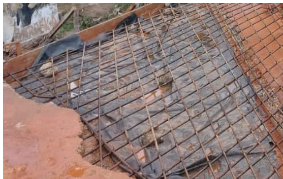
Gambar 3. 37 Pekerjaan pemasangan tulangan lantai atas box culvert
