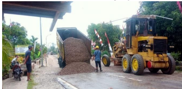
Gambar 3. 10 Pekerjaan Penghamparan Base Kelas B Menggunakan Motor Grader Sumber : Dokumentasi Lapangan, 2023
