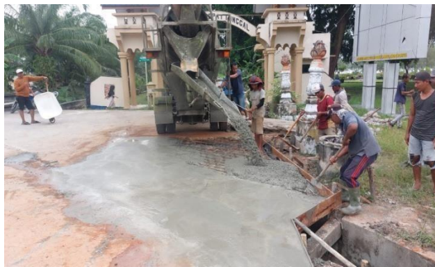
Gambar 3. 38 Pekerjaan pemasangan tulangan lantai atas box culvert
