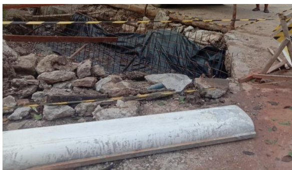
Gambar 3. 35 Pekerjaan pemasangan tulangan box culvert
