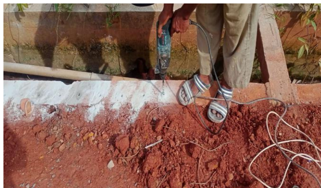
Gambar 3. 29 Pelubangan drainase menggunakan bor
